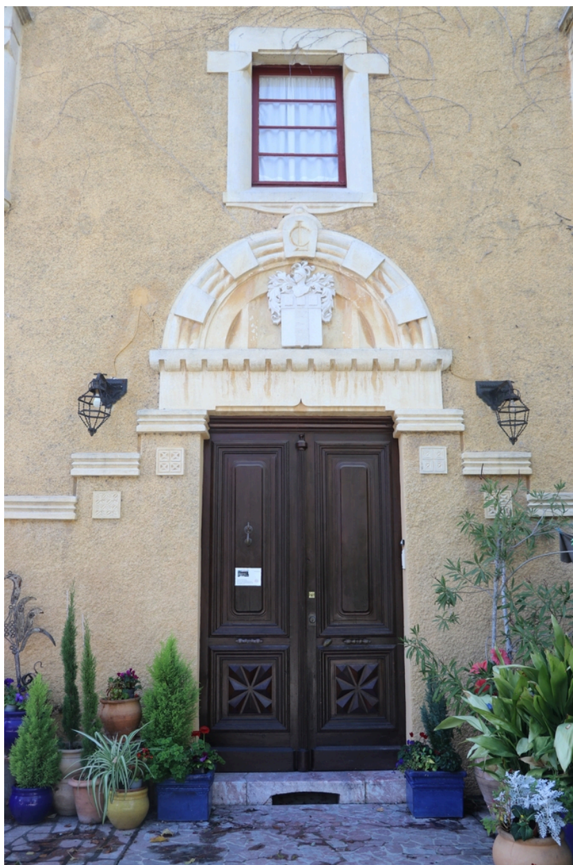
Villa Lafabrègue - Porte d'entrée est.
