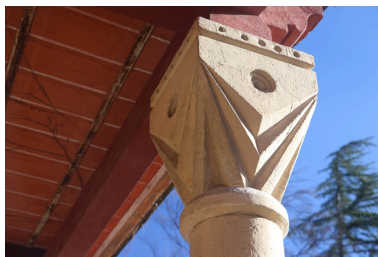
Villa Lafabrègue - Détail d'une colonne de maintien à chapiteau décoratif en béton. Phot. Léonie Deshayes IVR76_20216665329NUCA
