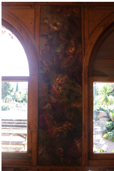
Villa Lafabrègue - Détail d'une boiserie peinte dans la salle à manger. Phot. Léonie Deshayes IVR76_20216665317NUCA
