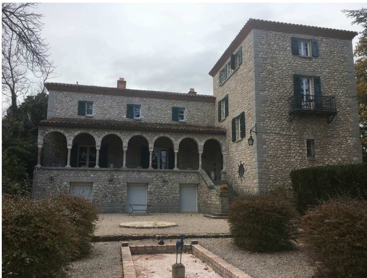
Maison Martin puis Château Las Closas puis Castell Rose - Vue d'ensemble Nord.
