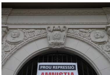
Château Valroch puis Université Catalane d'Été, École de Musique du Conflent et Centre d'accueil Pau Casals - Détail de l'agrafe avec monogramme de la famille CROS/MARTY au-dessus de l'entrée principale Nord. Phot. Léonie Deshayes IVR76_20226665547NUCA
