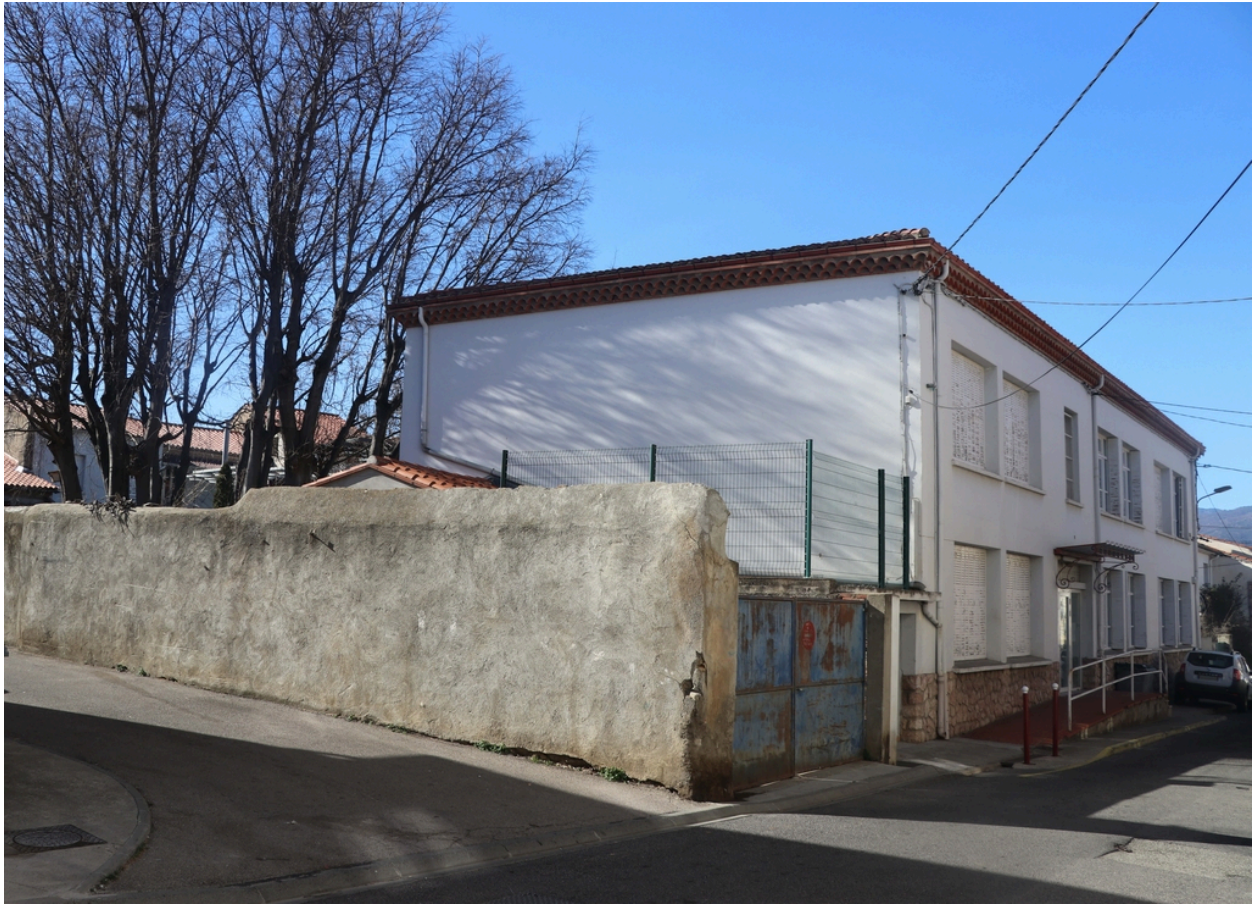
Ancienne maison de Lacroix puis pensionnat Saint-Joseph puis École catalane La Bressola puis médiathèque intercommunale - Vue Sud-Est de la médiathèque intercommunale depuis la rue de l'Agriculture.
