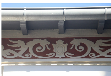
Château Valroch puis Université Catalane d'Été, École de Musique du Conflent et Centre d'accueil Pau Casals - Frise polychromée en enduit sculpté sur la corniche de la conciergerie. Phot. Léonie Deshayes IVR76_20226665590NUCA
