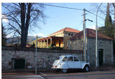
Villa Lafabrègue - Pavillon sud et villa en arrière-plan. Phot. Léonie Deshayes IVR76_20216665298NUCA
