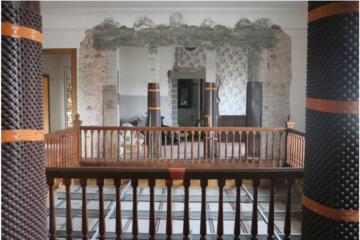
Château Valroch puis Université Catalane d'Été, École de Musique du Conflent et Centre d'accueil Pau Casals - Rambarde carrée à balustres en bois au premier étage du château.
