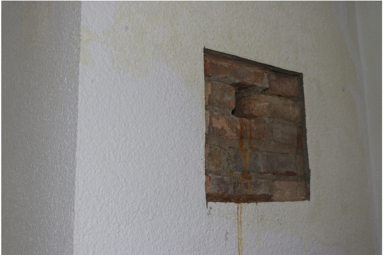
Ancienne maison de Lacroix puis pensionnat Saint-Joseph puis École catalane La Bressola puis médiathèque intercommunale - Maçonnerie d'origine en cayrous à l'intérieur de la chapelle du pensionnat.
