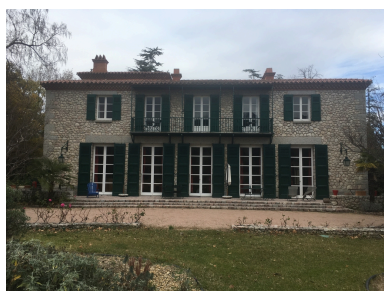
Maison Martin puis Château Las Closas puis Castell Rose - Façade Sud. Phot. Léonie Deshayes IVR76_20226665364NUCA
