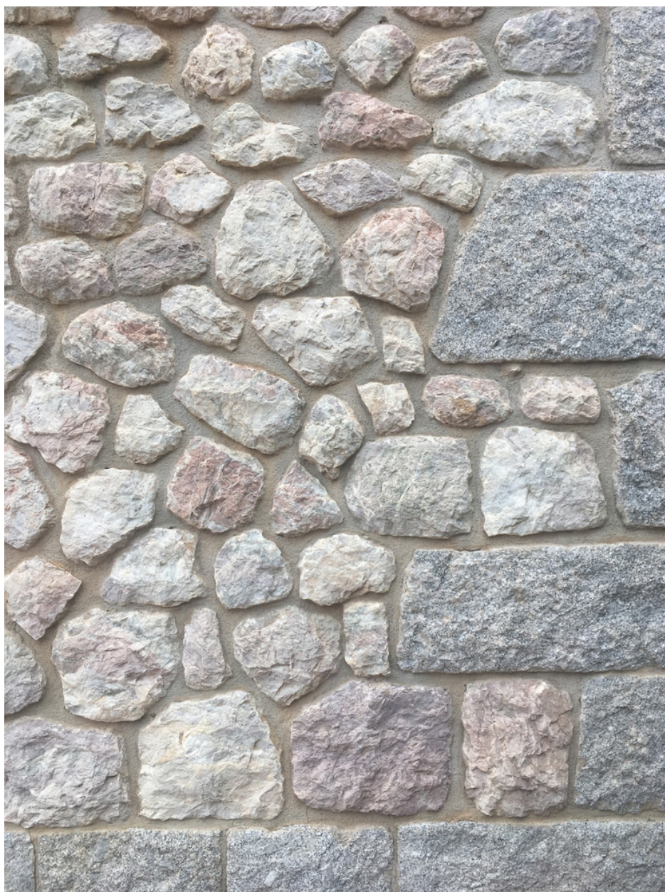
Maison Martin puis Château Las Closas puis Castell Rose - Détail de la maçonnerie Sud.
