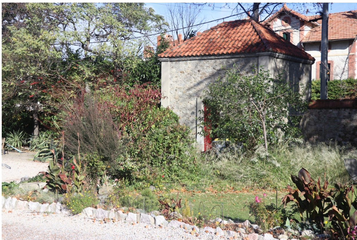
Villa Lafabrègue - Vue du pavillon sud depuis la propriété.
