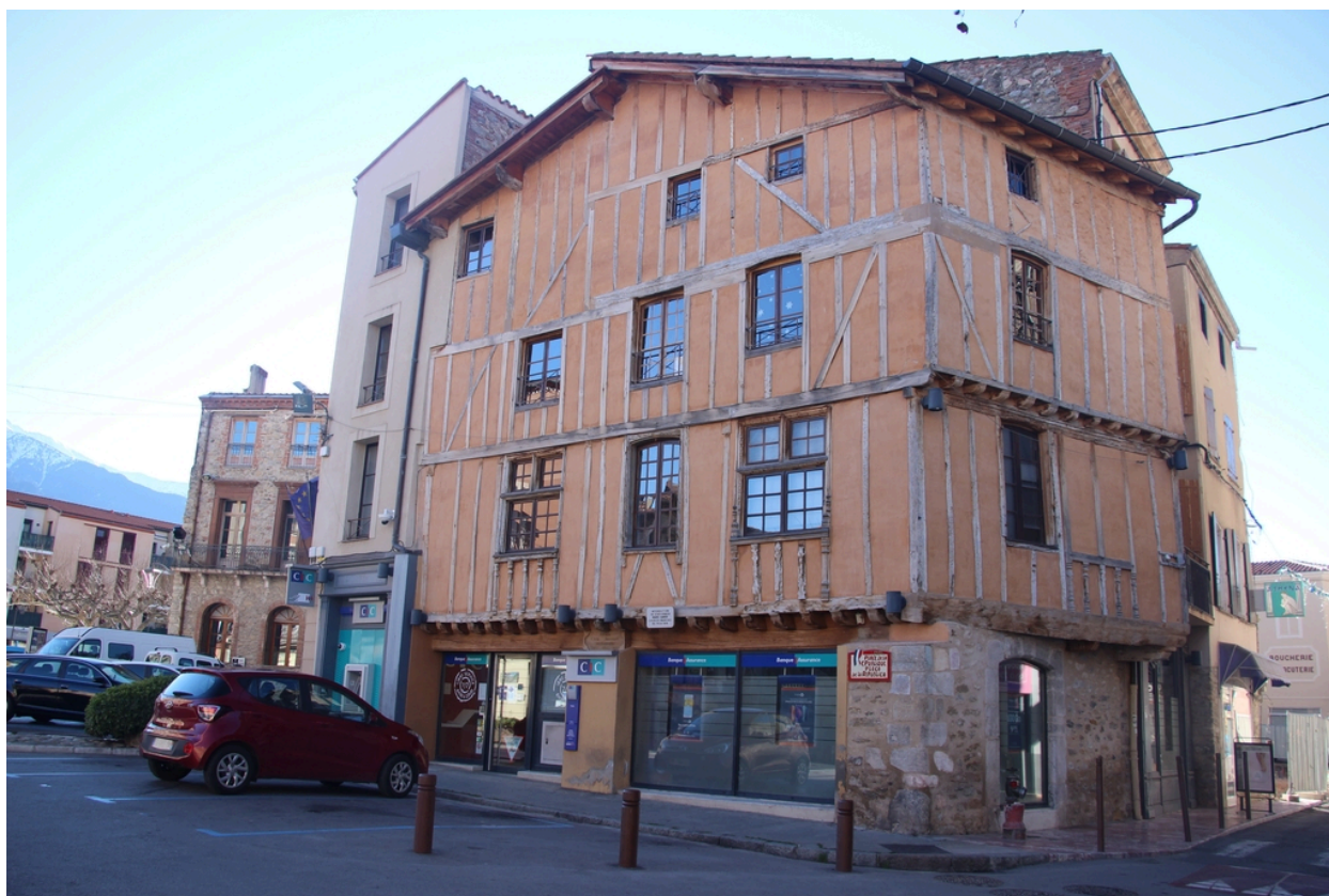
Maison Jourda (maison Jacomet) - Vue d'ensemble Nord-Est (1).
