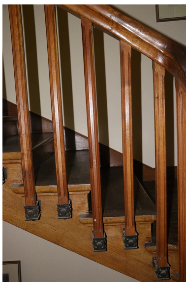
Villa Lafabrègue - Détail de l'escalier balancé avec montants en bois et plots en fer forgé. Phot. Léonie Deshayes IVR76_20216665326NUCA
