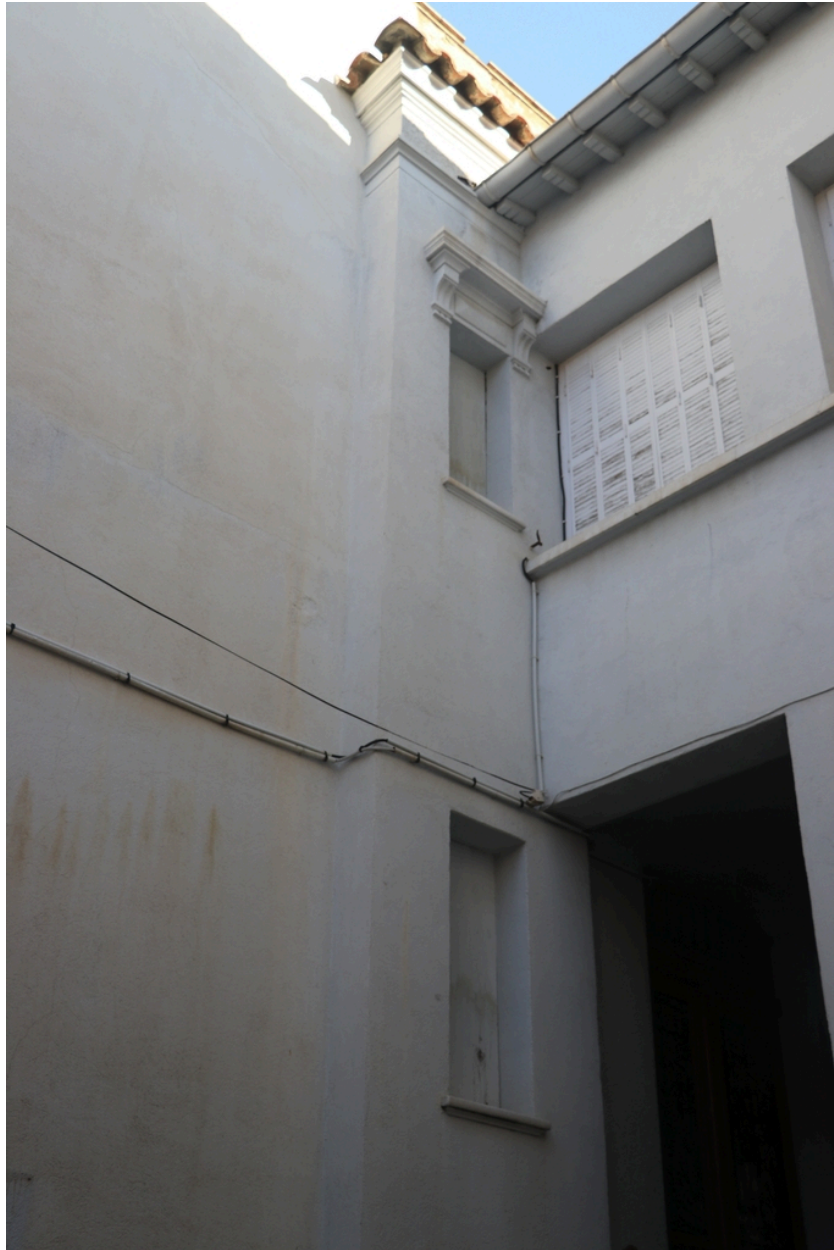
Ancienne maison de Lacroix puis pensionnat Saint-Joseph puis École catalane La Bressola puis médiathèque intercommunale - Ouvertures à l'angle des façades intérieures Sud-Ouest de la maison de Lacroix.
