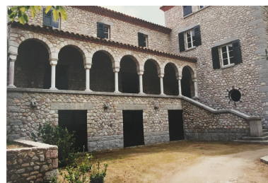
Maison Martin puis Château Las Closas puis Castell Rose - Angle Nord-Ouest de la maison Martin, Avril 1999. Autr. Léonie Deshayes IVR76_20226665348NUCA
