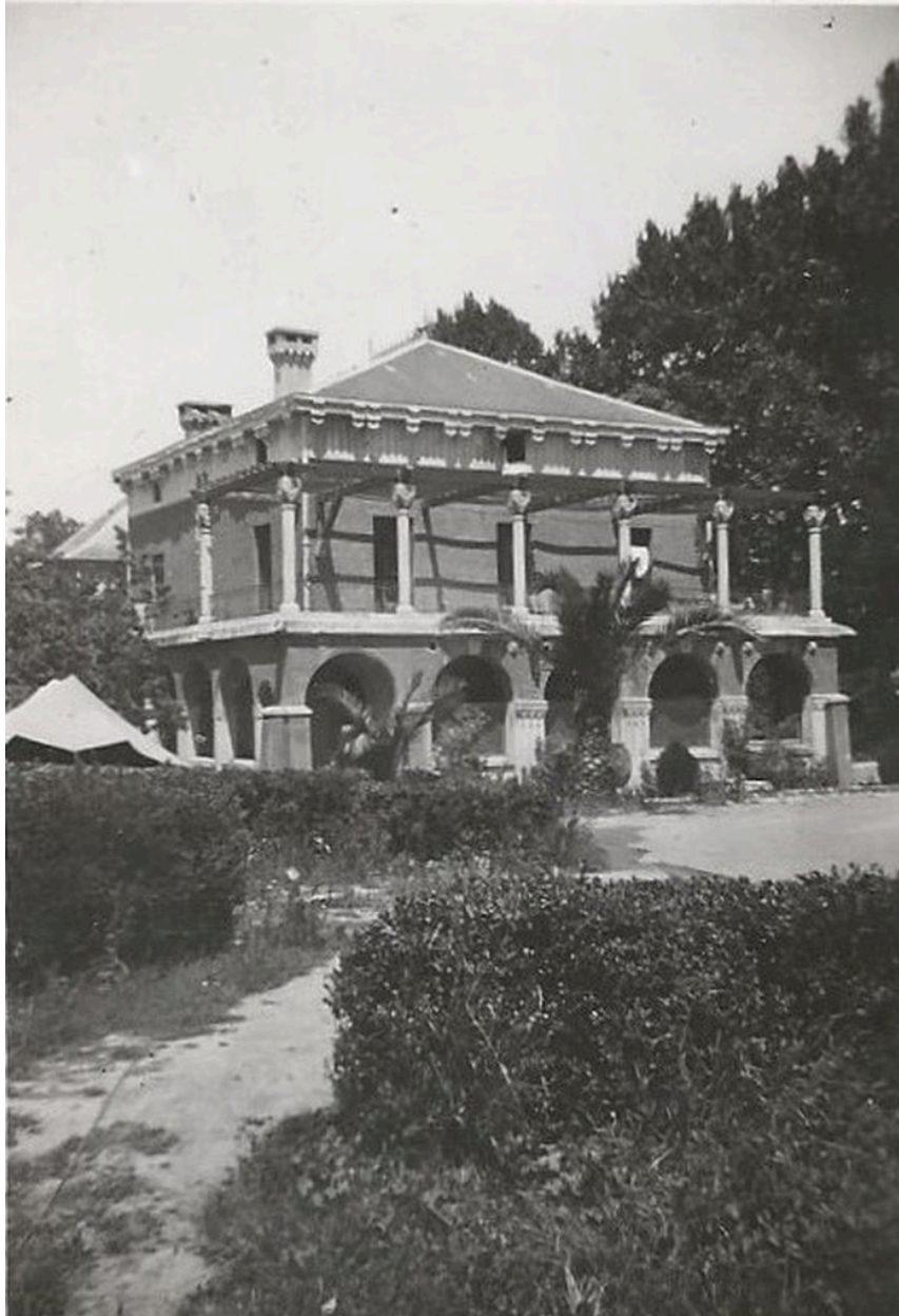
Villa Lafabrègue - Photographie de la villa sans le toit-terrasse de la pergola, 1946-1947.
