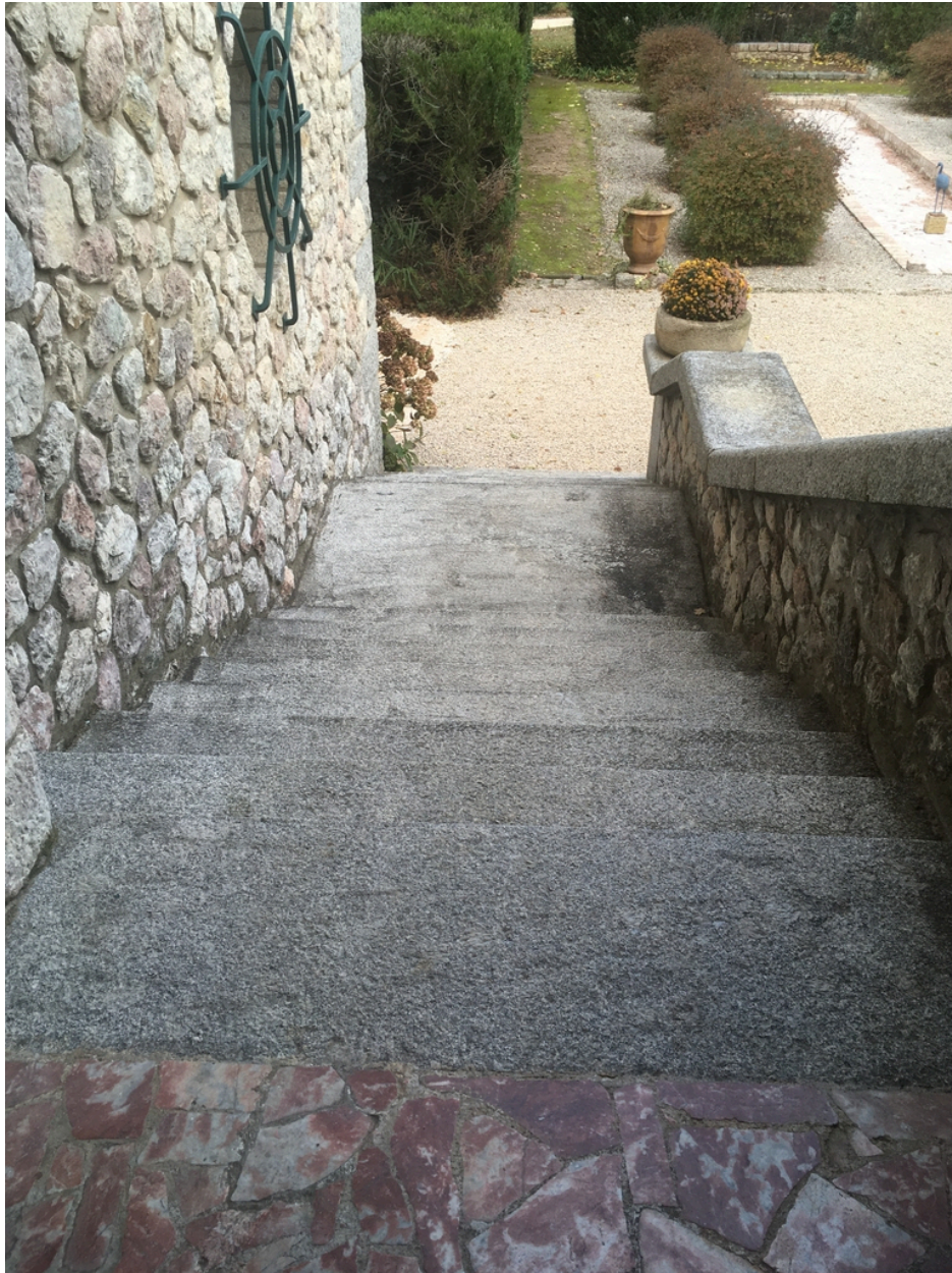
Maison Martin puis Château Las Closas puis Castell Rose - Escalier latéral d'accès au premier étage depuis la façade Nord.
