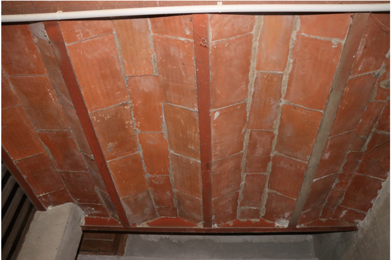
Château Valroch puis Université Catalane d'Été, École de Musique du Conflent et Centre d'accueil Pau Casals - Plancher à solives en fer et voûtains en briques pleines en sous-sol du château.
