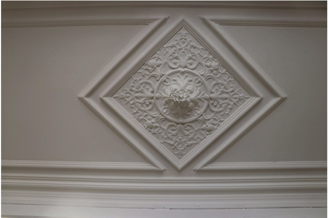
Ancienne maison de Lacroix puis pensionnat Saint-Joseph puis École catalane La Bressola puis médiathèque intercommunale - Plafond en staff au premier étage de la maison de Lacroix.
