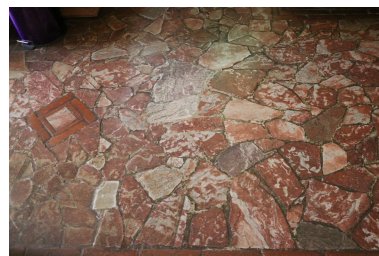
Villa Lafabrègue - Détail du sol en rez-de-chaussée avec dalles écarries en marbre rose et griotte. Phot. Léonie Deshayes IVR76_20216665315NUCA
