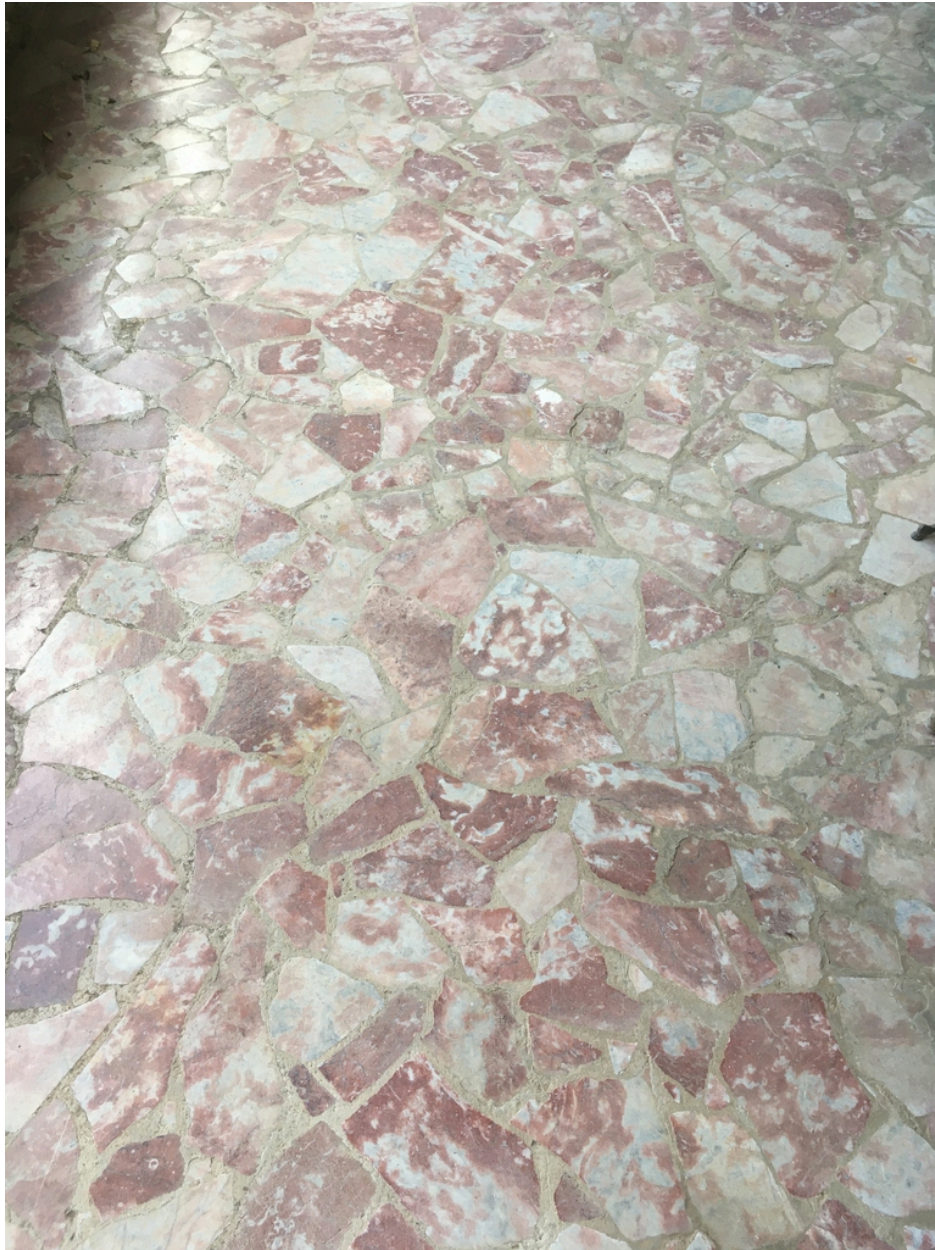
Maison Martin puis Château Las Closas puis Castell Rose - Dallage en marbre rose de la galerie du premier étage, façade Nord.
