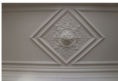
Ancienne maison de Lacroix puis pensionnat Saint-Joseph puis École catalane La Bressola puis médiathèque intercommunale - Plafond en staff au premier étage de la maison de Lacroix. Phot. Léonie Deshayes IVR76_20226665613NUCA
