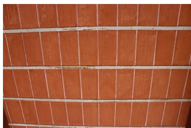
Villa Lafabrègue - Plancher en briques du toit-terrasse avec armature métallique. Phot. Léonie Deshayes IVR76_20216665331NUCA
