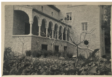
Maison Martin puis Château Las Closas puis Castell Rose - Vue Nord-Ouest, sans date. Autr. Léonie Deshayes IVR76_20226665344NUCA
