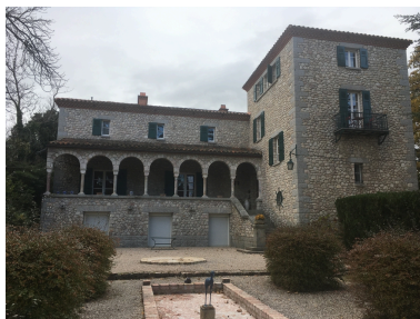
Maison Martin puis Château Las Closas puis Castell Rose - Vue d'ensemble Nord. Phot. Léonie Deshayes IVR76_20226665353NUCA
