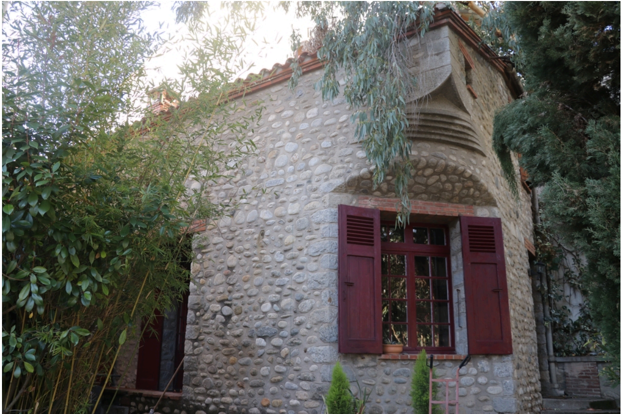
Villa Lafabrègue - Angle sud-est du gîte.
