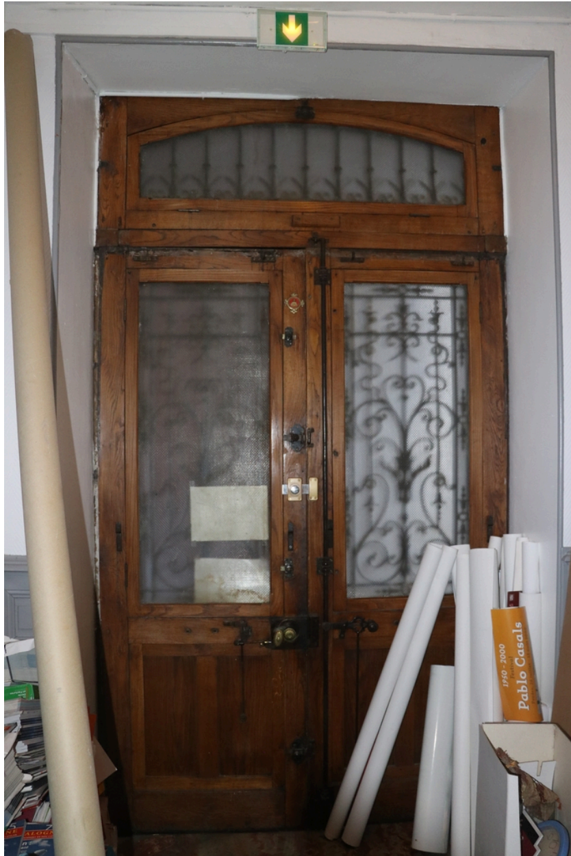
Ancienne maison de Lacroix puis pensionnat Saint-Joseph puis École catalane La Bressola puis médiathèque intercommunale - Porte d'accès au premier étage de la maison de Lacroix (2 b).
