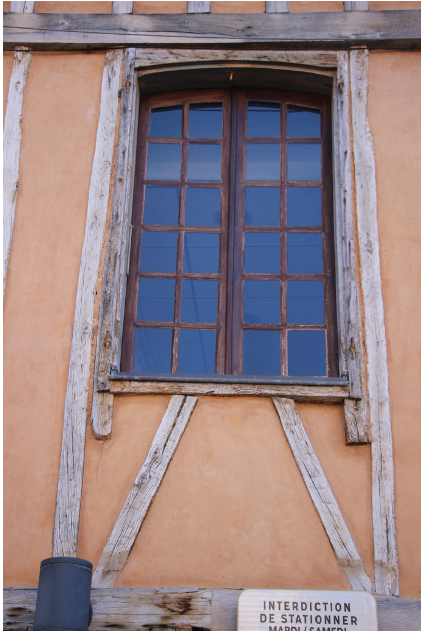
Maison Jourda (maison Jacomet) - Détail d'une baie vitrée à croisillons et chambranle bois à feuillure au premier étage (façade Est).
