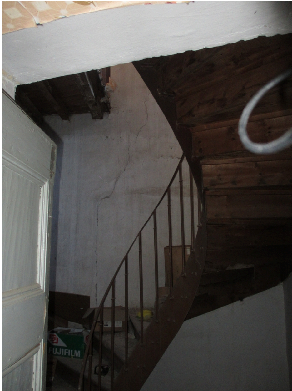
Maison Felip - Vue de l'escalier balancé intérieur (disparu), 20 Mai 2020.
