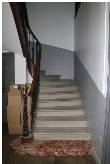
Ancienne maison de Lacroix puis pensionnat Saint-Joseph puis École catalane La Bressola puis médiathèque intercommunale - Escalier balancé au premier étage de la maison de Lacroix. Phot. Léonie Deshayes IVR76_20226665615NUCA
