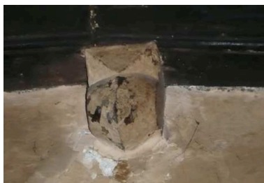
Maison Felip - Lambourde de plancher formée d'un corbeau en bois à tête de chat, 2011, p.23. Phot. Mimi TJOYAS, Autr. Léonie Deshayes
