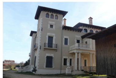
Château Valroch puis Université Catalane d'Été, École de Musique du Conflent et Centre d'accueil Pau Casals - Angle Nord-Ouest du château. Phot. Léonie Deshayes IVR76_20226665545NUCA
