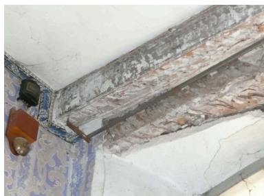
Maison Felip - Poutres moulurées au 1er étage, 2011, p.23. Phot. Mimi TJOYAS, Autr. Léonie Deshayes
