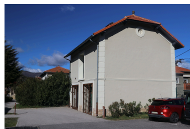
Château Valroch puis Université Catalane d'Été, École de Musique du Conflent et Centre d'accueil Pau Casals - Vue Sud-Ouest des écuries, actuelles salles de musique. Phot. Léonie Deshayes IVR76_20226665594NUCA
