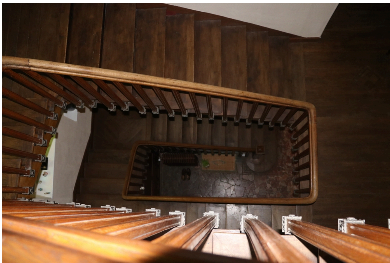
Villa Lafabrègue - Vue en plongée de l'escalier balancé depuis le dernier étage.
