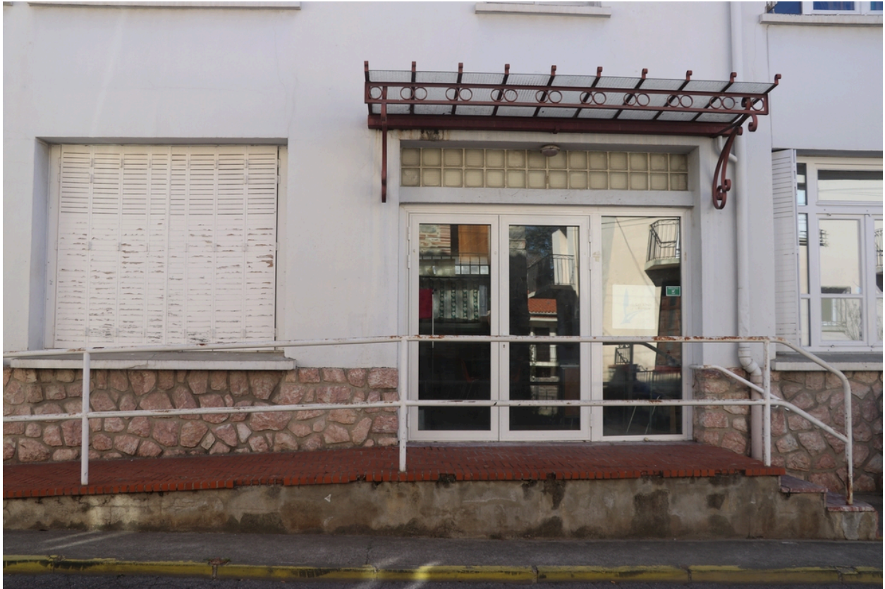
Ancienne maison de Lacroix puis pensionnat Saint-Joseph puis École catalane La Bressola puis médiathèque intercommunale - Entrée d'origine du pensionnat sur rue de l'Agriculture.
