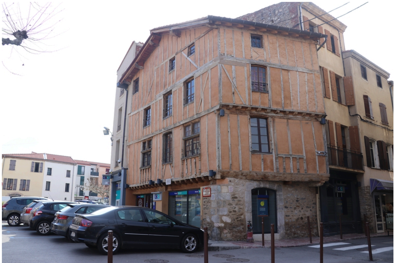
Maison Jourda (maison Jacomet) - Vue d'ensemble Nord-Est (2).
