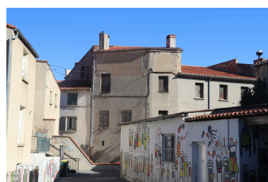
Ancienne maison de Lacroix puis pensionnat Saint-Joseph puis École catalane La Bressola puis médiathèque intercommunale - Façades Ouest de la maison de Lacroix depuis la Bressola. Phot. Léonie Deshayes IVR76_20226665629NUCA
