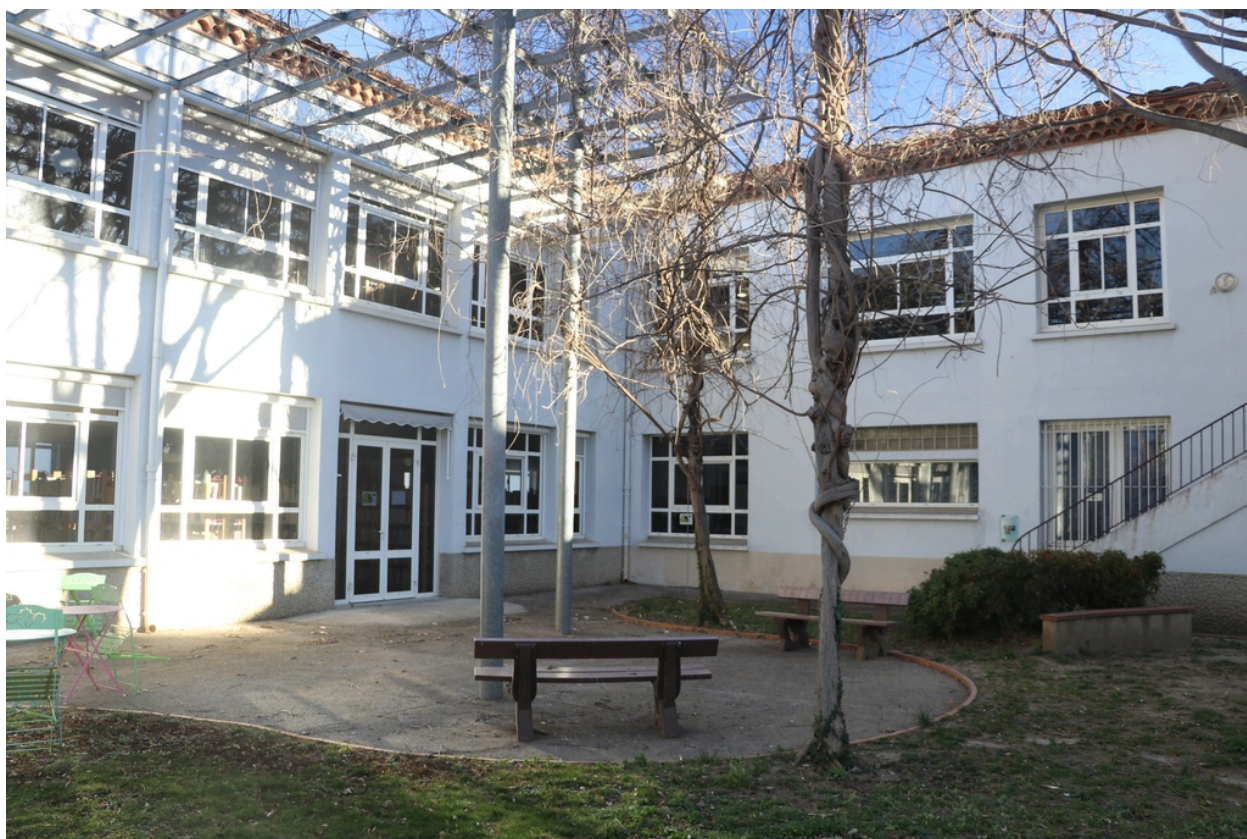
Ancienne maison de Lacroix puis pensionnat Saint-Joseph puis École catalane La Bressola puis médiathèque intercommunale - Angle Sud-Est de la médiathèque.
