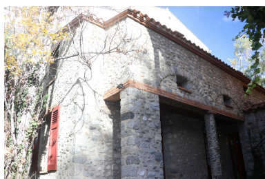
Villa Lafabrègue - Angle sud-ouest du gîte. Phot. Léonie Deshayes IVR76_20216665337NUCA
