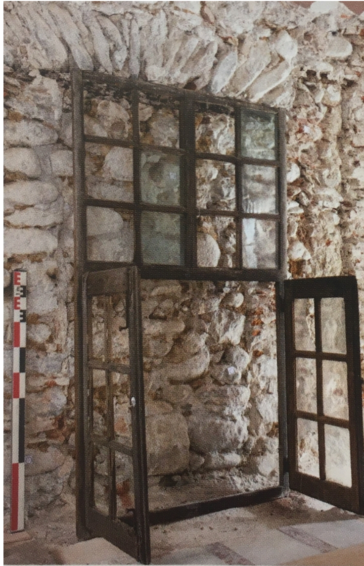
Figure 7 : Fenêtre croisée du XVIIIe siècle mis en scène devant un encadrement bouché (maison 7).
