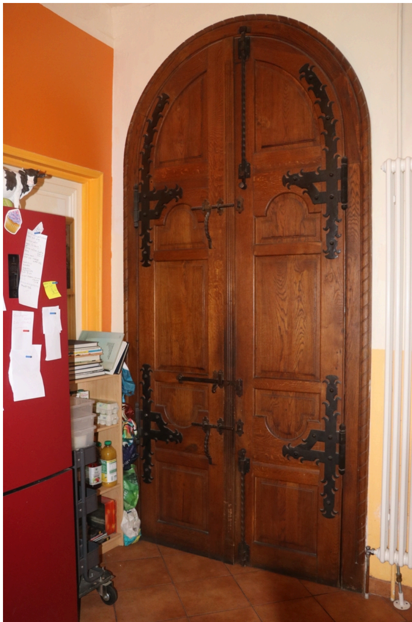
Villa Lafabrègue - Porte en bois de Bourgogne fermée entre le hall d'entrée et la cuisine.
