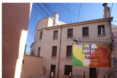
Ancienne maison de Lacroix puis pensionnat Saint-Joseph puis École catalane La Bressola puis médiathèque intercommunale - N°29 rue de l'Hospice. Phot. Léonie Deshayes IVR76_20226665600NUCA
