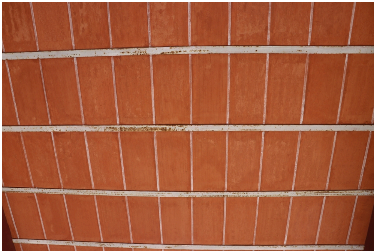
Villa Lafabrègue - Plancher en briques du toit-terrasse avec armature métallique.
