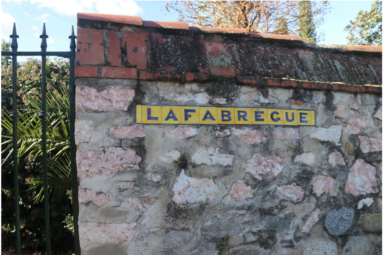
Villa Lafabrègue - Détail du mur de clôture avec nom de la villa matérialisé en carreaux de mosaïque.
