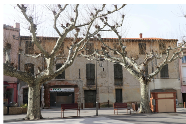
Maison Felip - Façade principale (Est), Place de la République. Phot. Léonie Deshayes IVR76_20216661793NUCA
