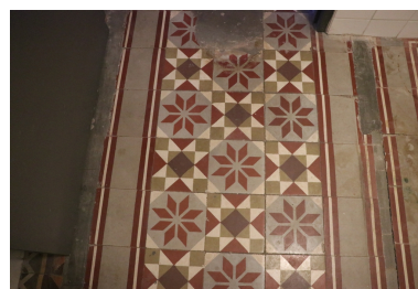
Château Valroch puis Université Catalane d'Été, École de Musique du Conflent et Centre d'accueil Pau Casals - Démarcation de l'ancien couloir de distribution des pièces du rez-de-chaussée de la conciergerie. Phot. Léonie Deshayes IVR76_20226665582NUCA
