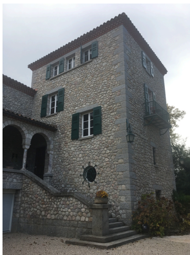
Maison Martin puis Château Las Closas puis Castell Rose - Angle Nord-Est du retour d'angle. Phot. Léonie Deshayes IVR76_20226665362NUCA
