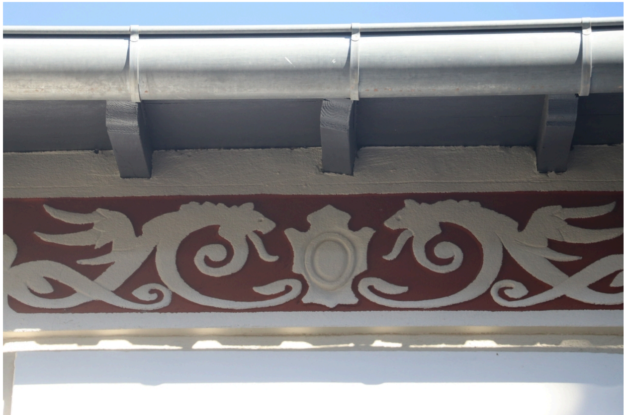
Château Valroch puis Université Catalane d'Été, École de Musique du Conflent et Centre d'accueil Pau Casals - Frise polychromée en enduit sculpté sur la corniche de la conciergerie.
