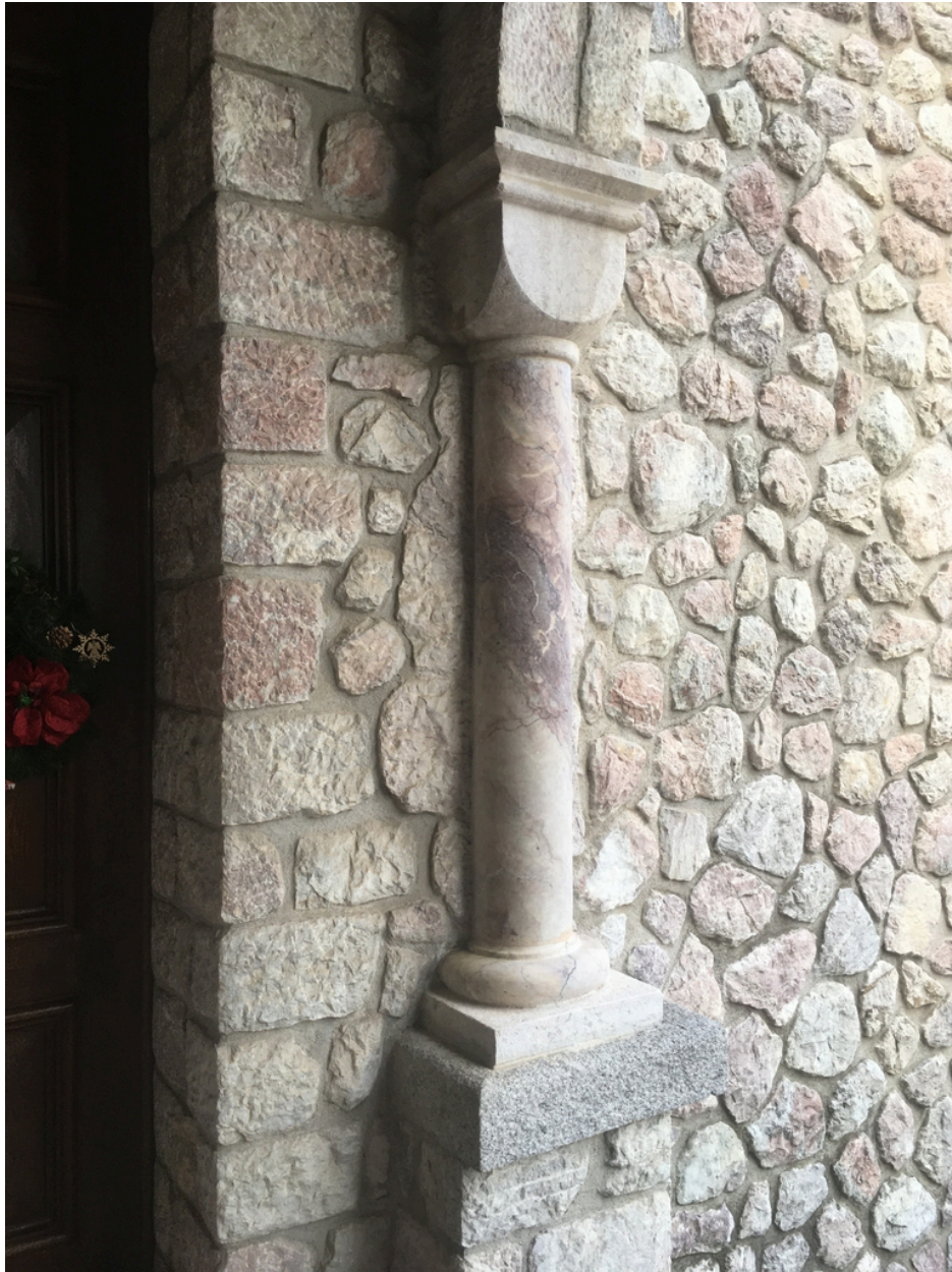
Maison Martin puis Château Las Closas puis Castell Rose - Détail d'un chapiteau en marbre rose de la galerie du premier étage, façade Nord.
