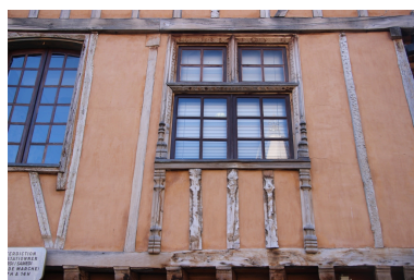
Maison Jourda (maison Jacomet) - Détail d'une fenêtre à meneau supérieur et potelets moulurés formant allège au premier étage (façade Est). Phot. Léonie Deshayes IVR76_20226665695NUCA
