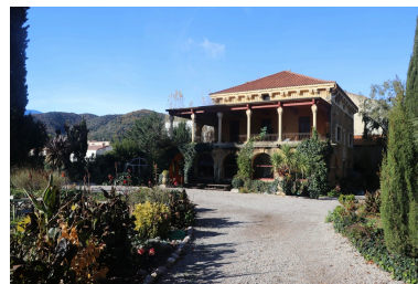
Villa Lafabrègue - Vue d'ensemble depuis le jardin d'agrément. Phot. Léonie Deshayes IVR76_20216665302NUCA
