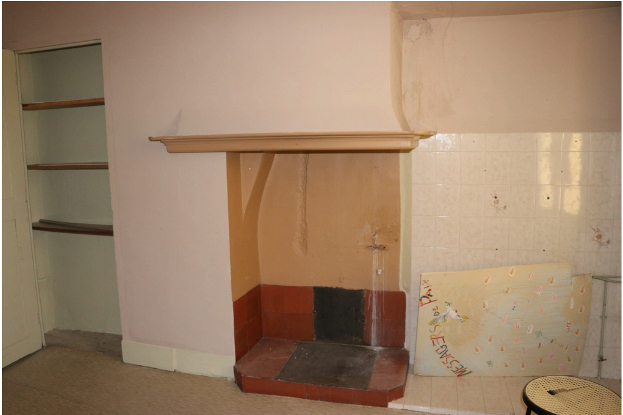
Ancienne maison de Lacroix puis pensionnat Saint-Joseph puis École catalane La Bressola puis médiathèque intercommunale - Cheminée moderne et placard intégré d'une chambre au second étage de la maison de Lacroix.
