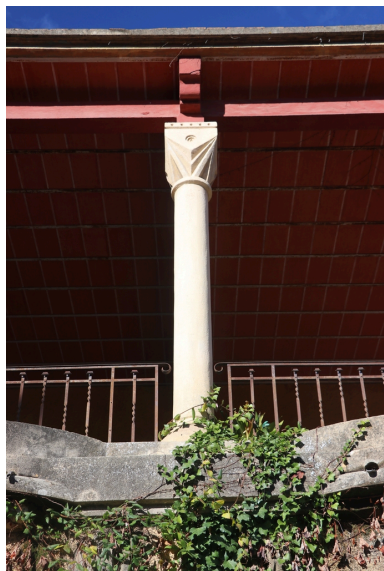
Villa Lafabrègue - Colonne de maintien en béton de la pergola. Phot. Léonie Deshayes IVR76_20216665328NUCA
