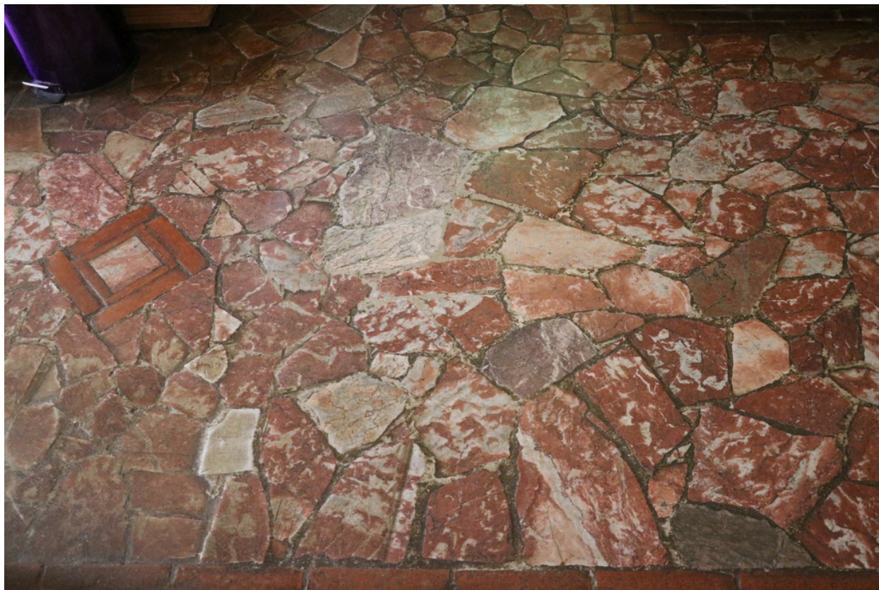
Villa Lafabrègue - Détail du sol en rez-de-chaussée avec dalles équarries en marbre rose et griotte.
