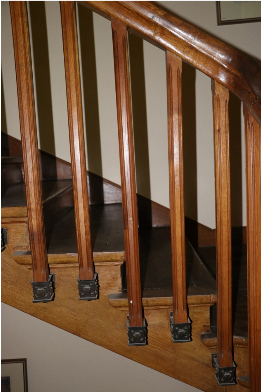
Villa Lafabrègue - Détail de l'escalier balancé avec montants en bois et plots en fer forgé.
