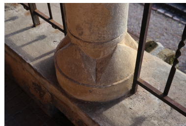
Villa Lafabrègue - Détail d'une base de colonne située au niveau de la pergola. Phot. Léonie Deshayes IVR76_20216665330NUCA
