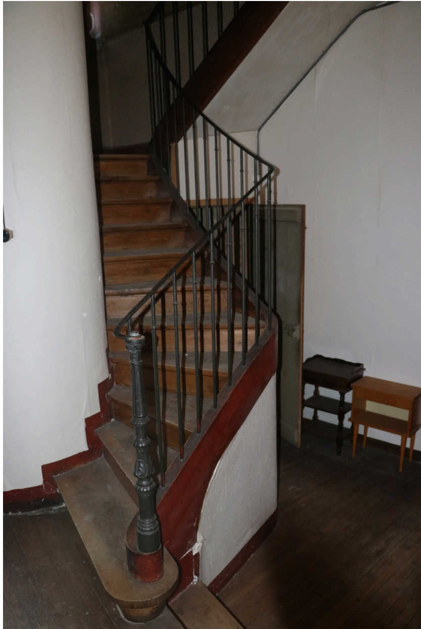
Ancienne maison de Lacroix puis pensionnat Saint-Joseph puis École catalane La Bressola puis médiathèque intercommunale - Escalier en quart tournant balancé au second étage de la maison de Lacroix.
