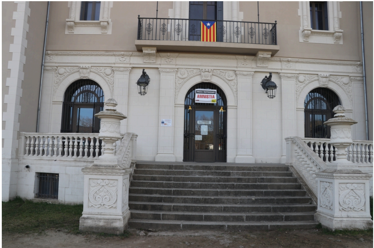
Château Valroch puis Université Catalane d'Été, École de Musique du Conflent et Centre d'accueil Pau Casals - Escalier d'apparat et rez-de-chaussée en façade Nord du château.
