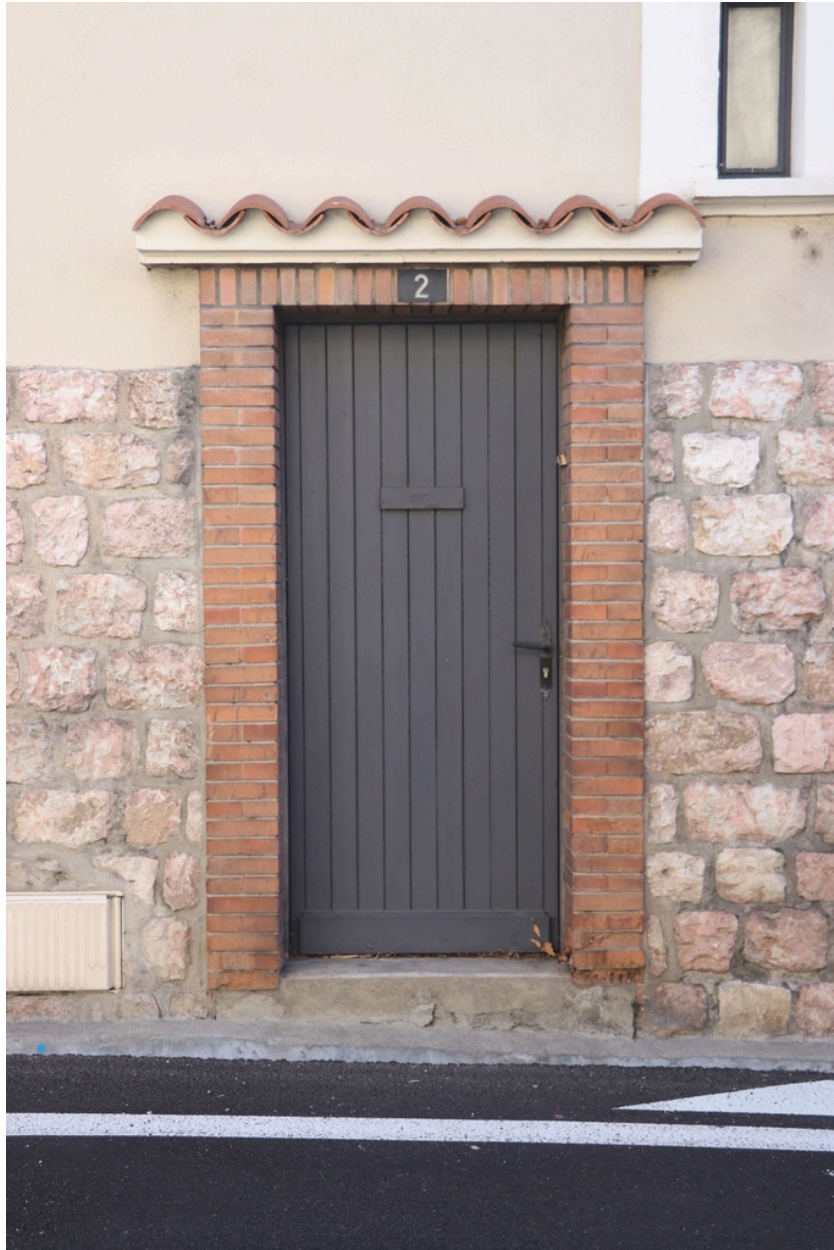
Château Valroch puis Université Catalane d'Été, École de Musique du Conflent et Centre d'accueil Pau Casals - Porte de secours Est en sous-sol de la conciergerie.
