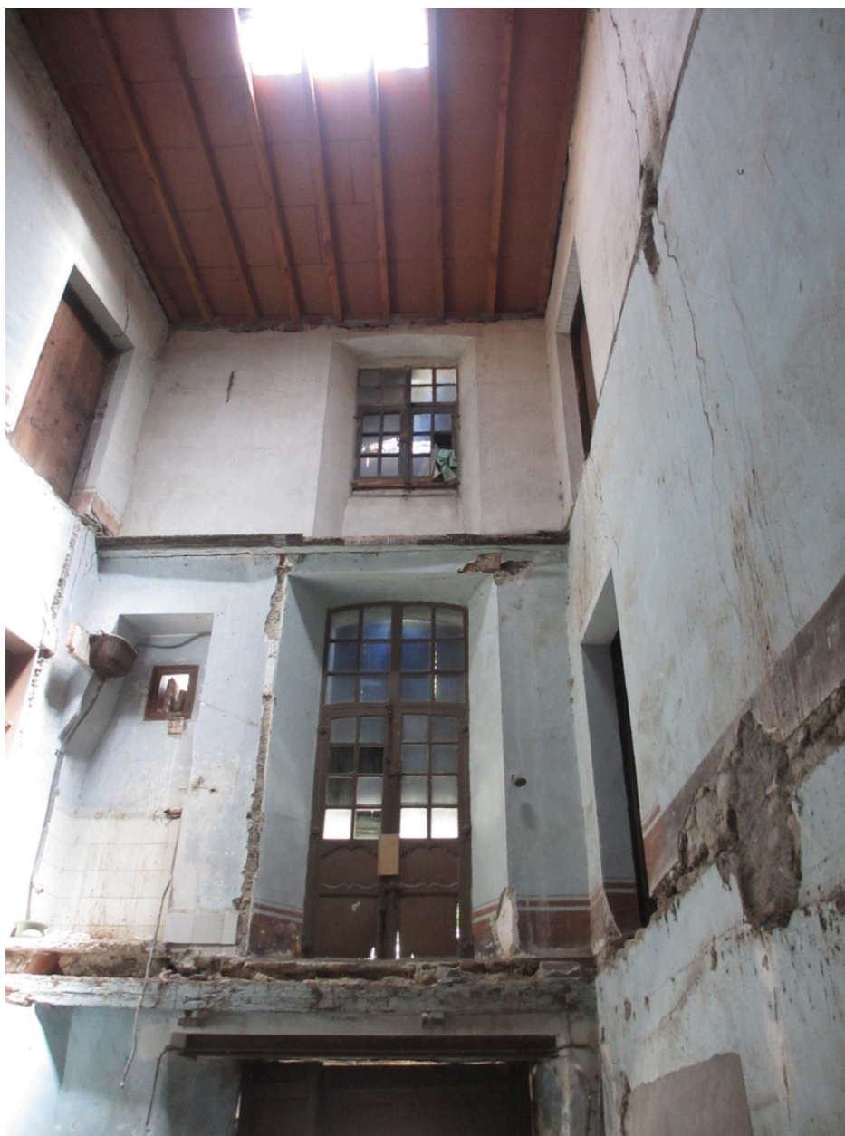
Maison Felip - Élévation intérieure avec puits de jour, 20 Mai 2020.
