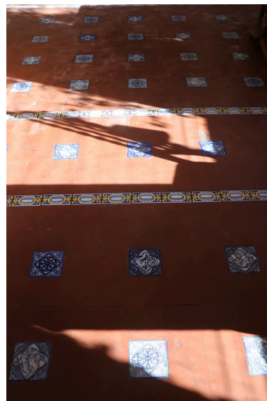
Villa Lafabrègue - Détail du sol à carreaux de briques rouge et de carreaux de ciment à motifs géométriques bleu dans la salle à manger. Phot. Léonie Deshayes IVR76_20216665318NUCA
