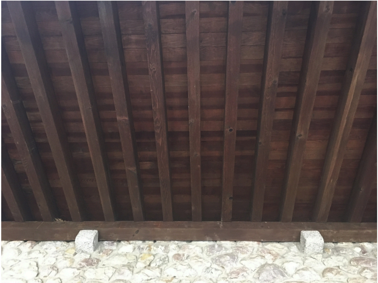
Maison Martin puis Château Las Closas puis Castell Rose - Toit en appentis, à voligeage, chevrons et lambourde muraille sur corbeaux taillés en granit de la galerie du premier étage, façade Nord.
