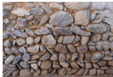
Maison Felip - Maçonnerie disposée en opus spicatum, soubassement de l'habitation cadastrée BE 95 (p). Phot. Léonie Deshayes IVR76_20216661803NUCA
