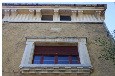
Villa Lafabrègue - Baie latérale droite en façade est (premier étage). Phot. Léonie Deshayes IVR76_20216665313NUCA
