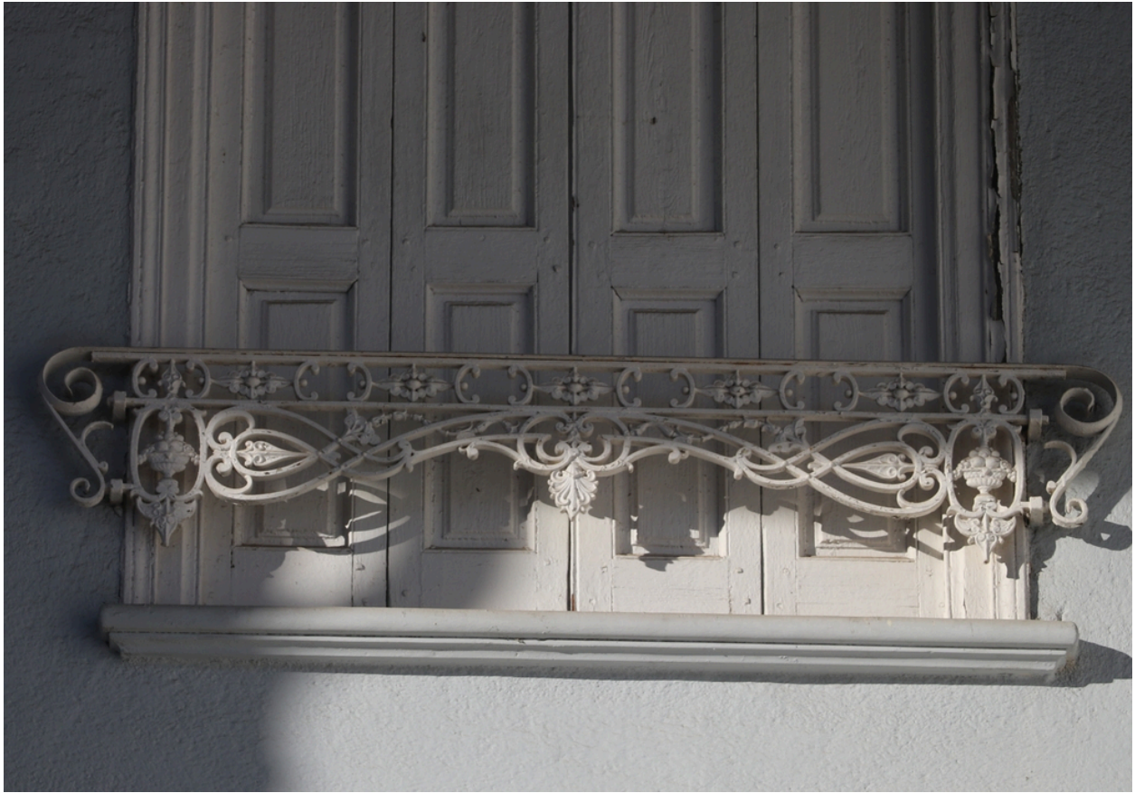
Ancienne maison de Lacroix puis pensionnat Saint-Joseph puis École catalane La Bressola puis médiathèque intercommunale - Baie au second niveau de la maison de Lacroix avec garde-corps ouvragé en fer peint.
