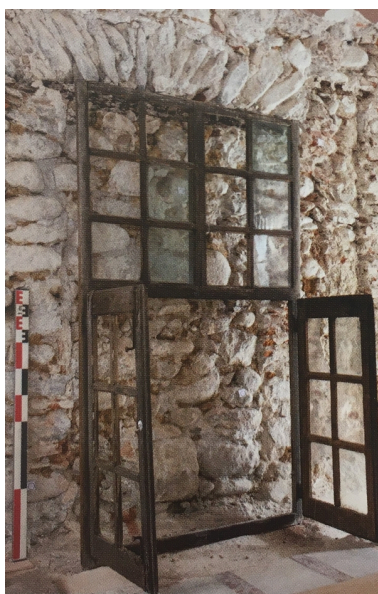
Figure 7 : Fenêtre croisée du XVIIIe siècle mise en scène devant un encadrement bouché (maison 7).
