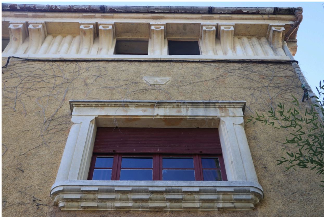
Villa Lafabrègue - Baie latérale droite en façade est (premier étage).
