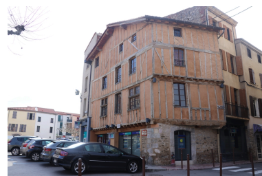
Maison Jourda (maison Jacomet) - Vue d'ensemble Nord-Est (2). Phot. Léonie Deshayes IVR76_20226665693NUCA
