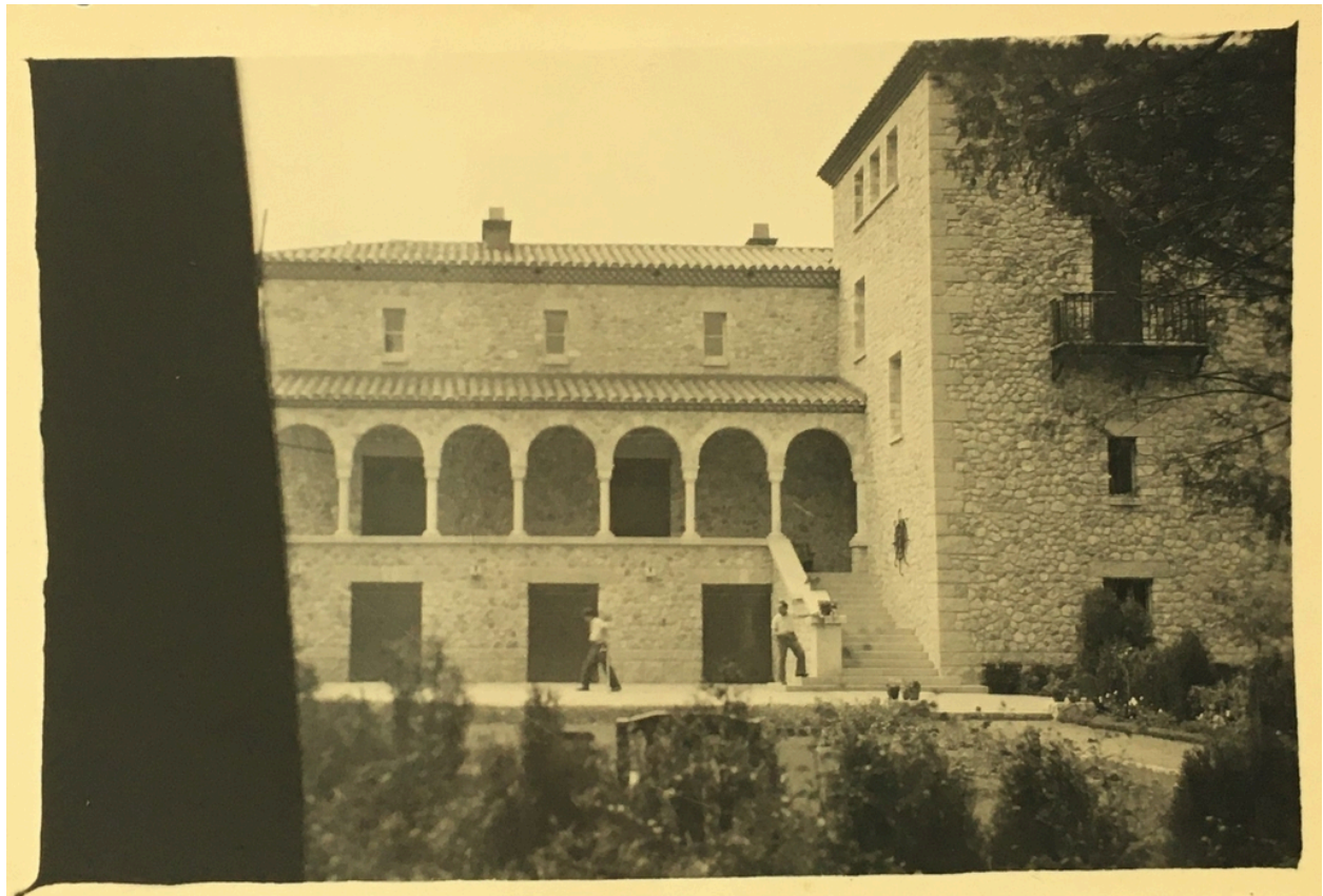
Maison Martin puis Château Las Closas puis Castell Rose - Vue Nord, Été 1948.
