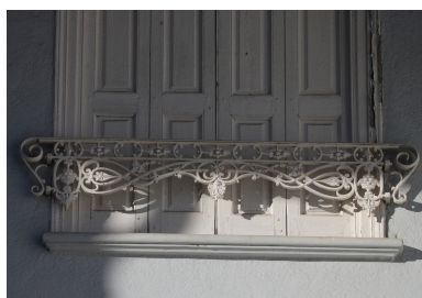
Ancienne maison de Lacroix puis pensionnat Saint-Joseph puis École catalane La Bressola puis médiathèque intercommunale - Baie au second niveau de la maison de Lacroix avec garde-corps ouvragé en fer peint. Phot. Léonie Deshayes IVR76_20226665624NUCA
