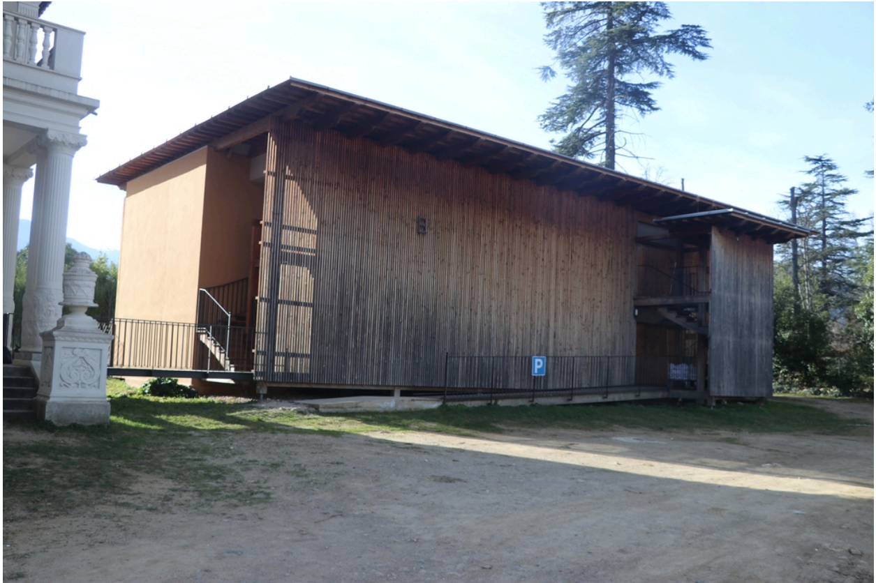
Château Valroch puis Université Catalane d'Été, École de Musique du Conflent et Centre d'accueil Pau Casals - Vue Nord-Est de l'extension occidentale du château.
