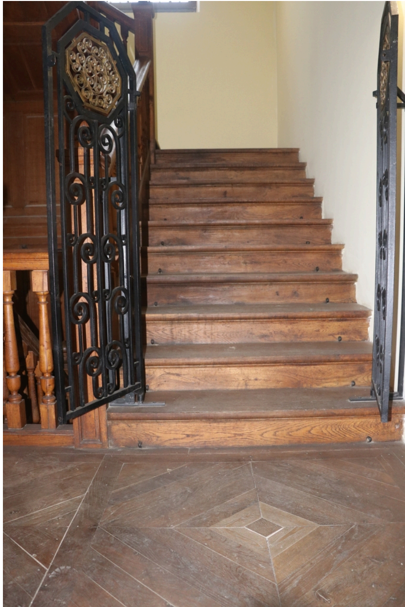
Château Valroch puis Université Catalane d'Été, École de Musique du Conflent et Centre d'accueil Pau Casals - Portillon en rez-de-chaussée de l'escalier du château.
