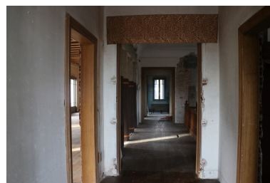
Château Valroch puis Université Catalane d'Été, École de Musique du Conflent et Centre d'accueil Pau Casals - Pièces au premier étage du château. Phot. Léonie Deshayes IVR76_20226665560NUCA
