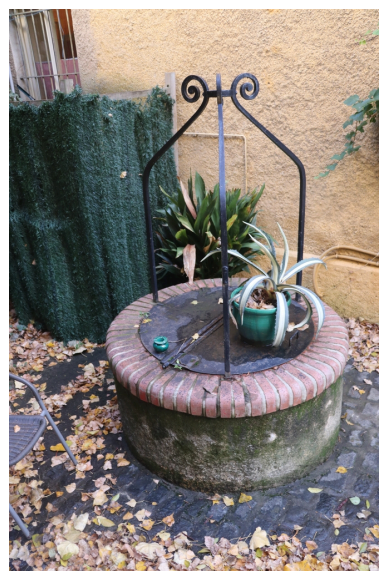
Villa Lafabrègue - Puits avec margelle en brique et soubassement en béton situé dans le jardin au sud du gîte. Phot. Léonie Deshayes IVR76_20216665339NUCA
