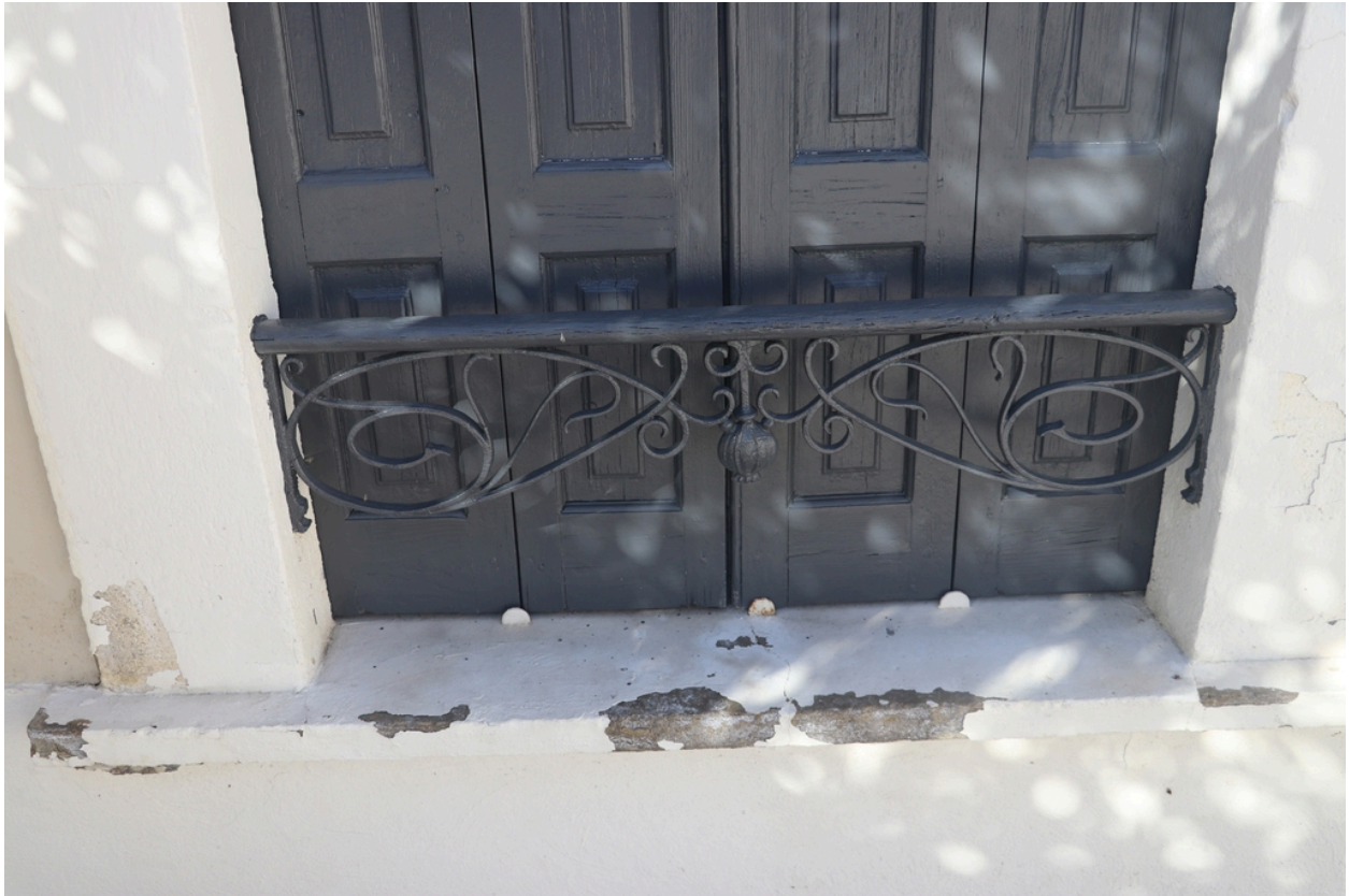
Château Valroch puis Université Catalane d'Été, École de Musique du Conflent et Centre d'accueil Pau Casals - Garde-corps en façade Sud de la conciergerie.
