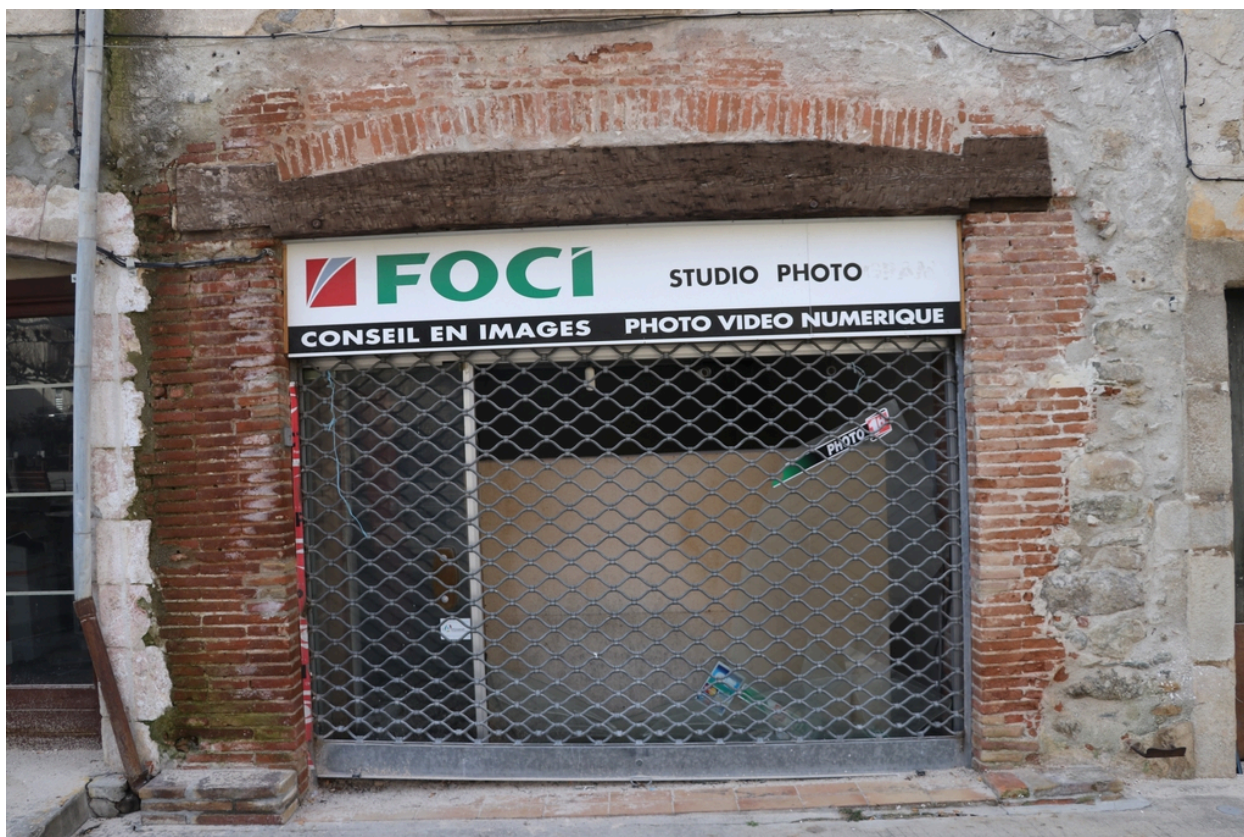
Maison Felip - Ouverture à encadrement en cayrous et linteau en bois, rez-de-chaussée, façade principale.
