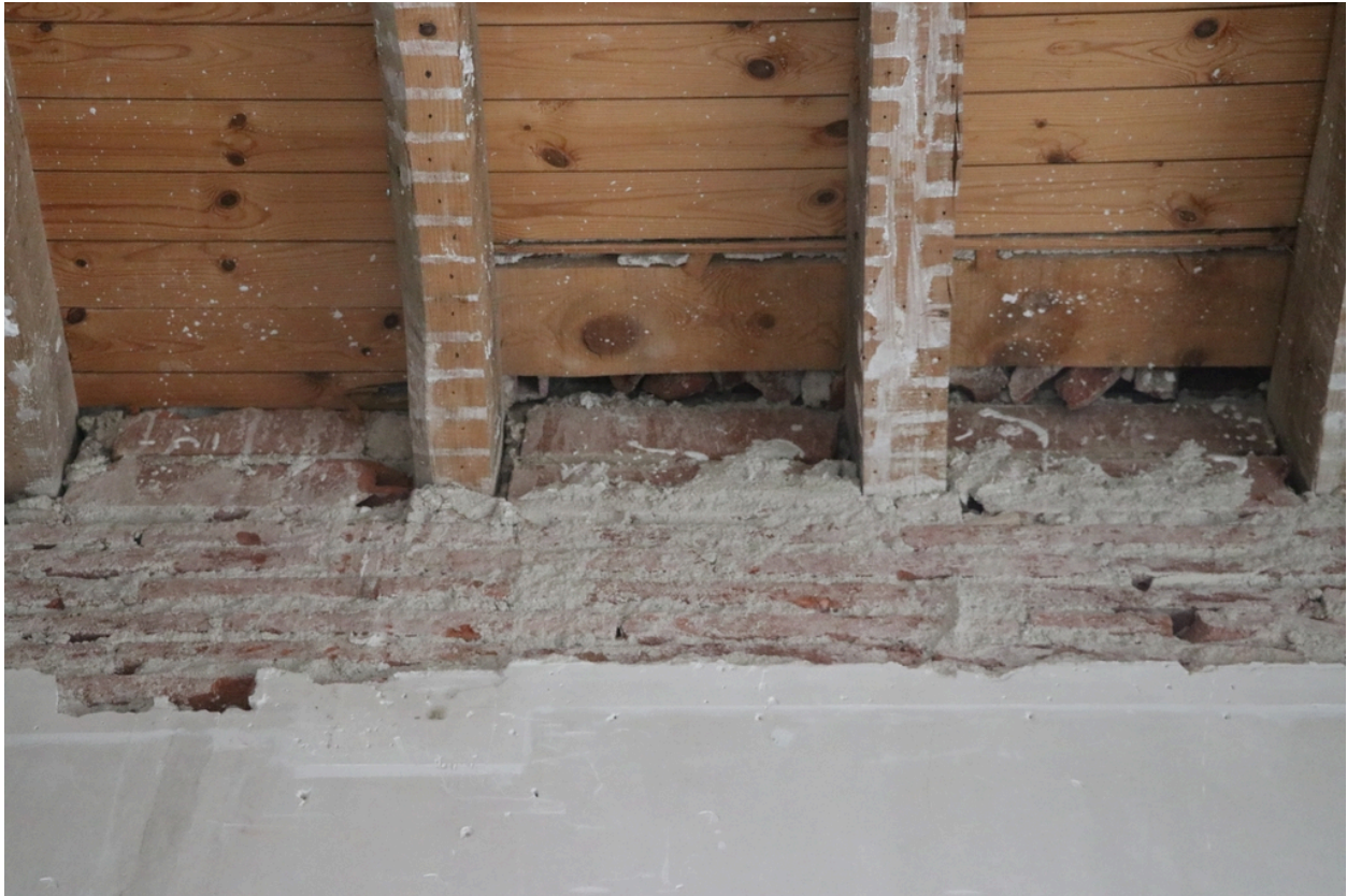
Château Valroch puis Université Catalane d'Été, École de Musique du Conflent et Centre d'accueil Pau Casals - Mur maçonné en cayrous au premier étage du château.
