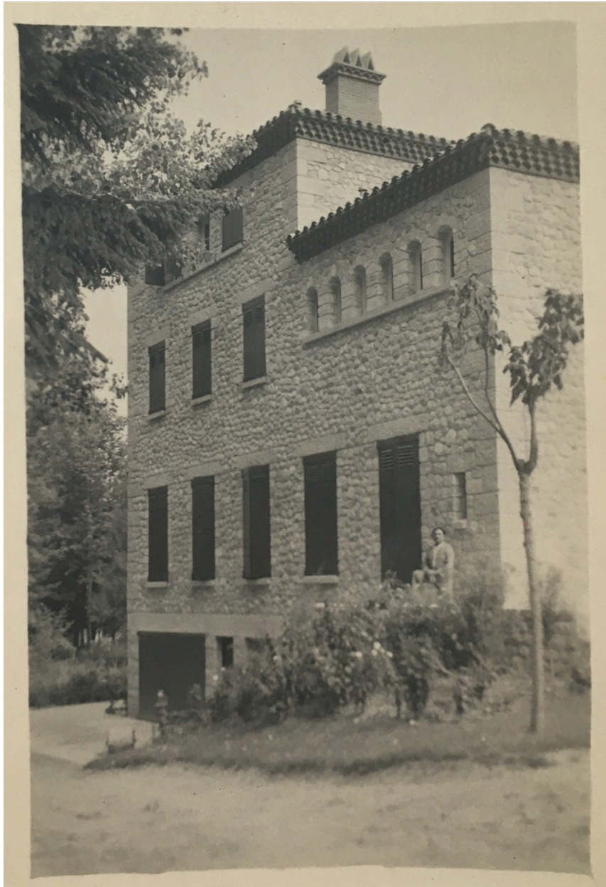
Maison Martin puis Château Las Closas puis Castell Rose - Angle Sud-Ouest, sans date.
