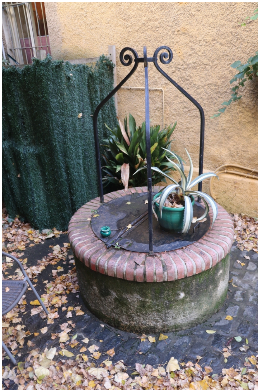
Villa Lafabrègue - Puits avec margelle en brique et soubassement en béton situé dans le jardin au sud du gîte.
