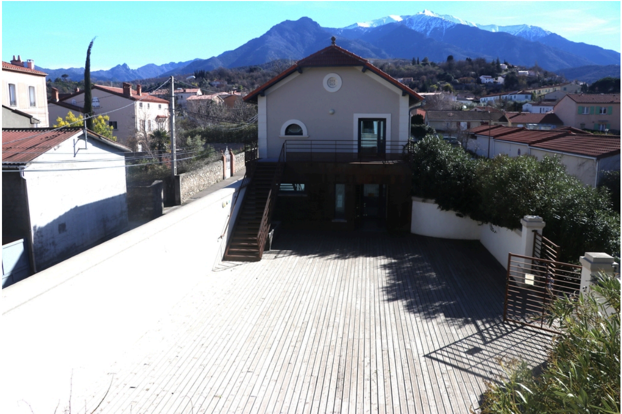
Château Valroch puis Université Catalane d'Été, École de Musique du Conflent et Centre d'accueil Pau Casals - Vue Nord des écuries et de la cour depuis la conciergerie.
