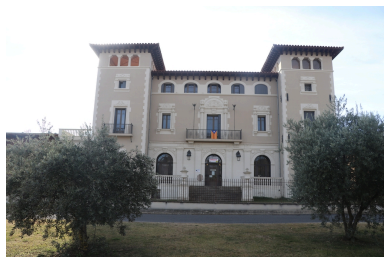
Château Valroch puis Université Catalane d'Été, École de Musique du Conflent et Centre d'accueil Pau Casals - Façade Nord du château. Phot. Léonie Deshayes IVR76_20226665543NUCA
