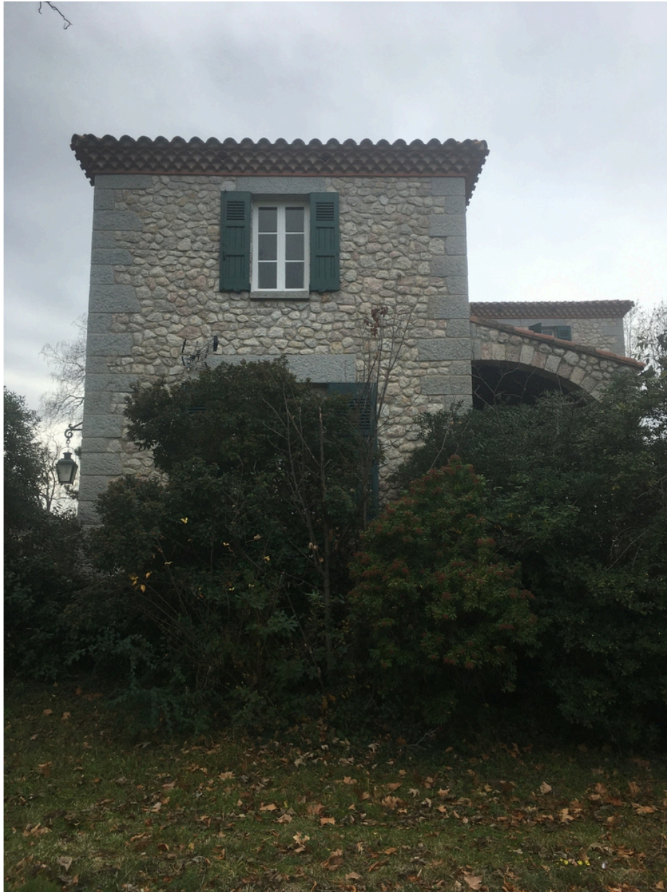
Maison Martin puis Château Las Closas puis Castell Rose - Façade Est.
