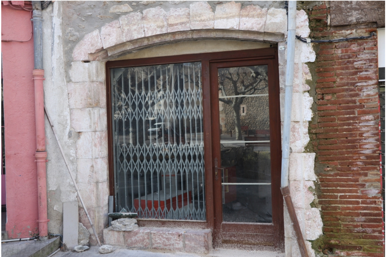
Maison Felip - Ouverture à arc en anse de panier et chanfreiné, rez-de-chaussée, façade principale.
