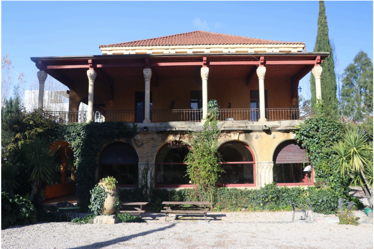
Villa Lafabrègue - Façade sud.
