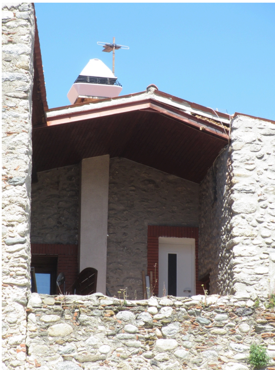
Maison Felip - Porte remaniée localisée au-dessus de l'escalier droit extérieur (façade Ouest), 20 Mai 2020.
