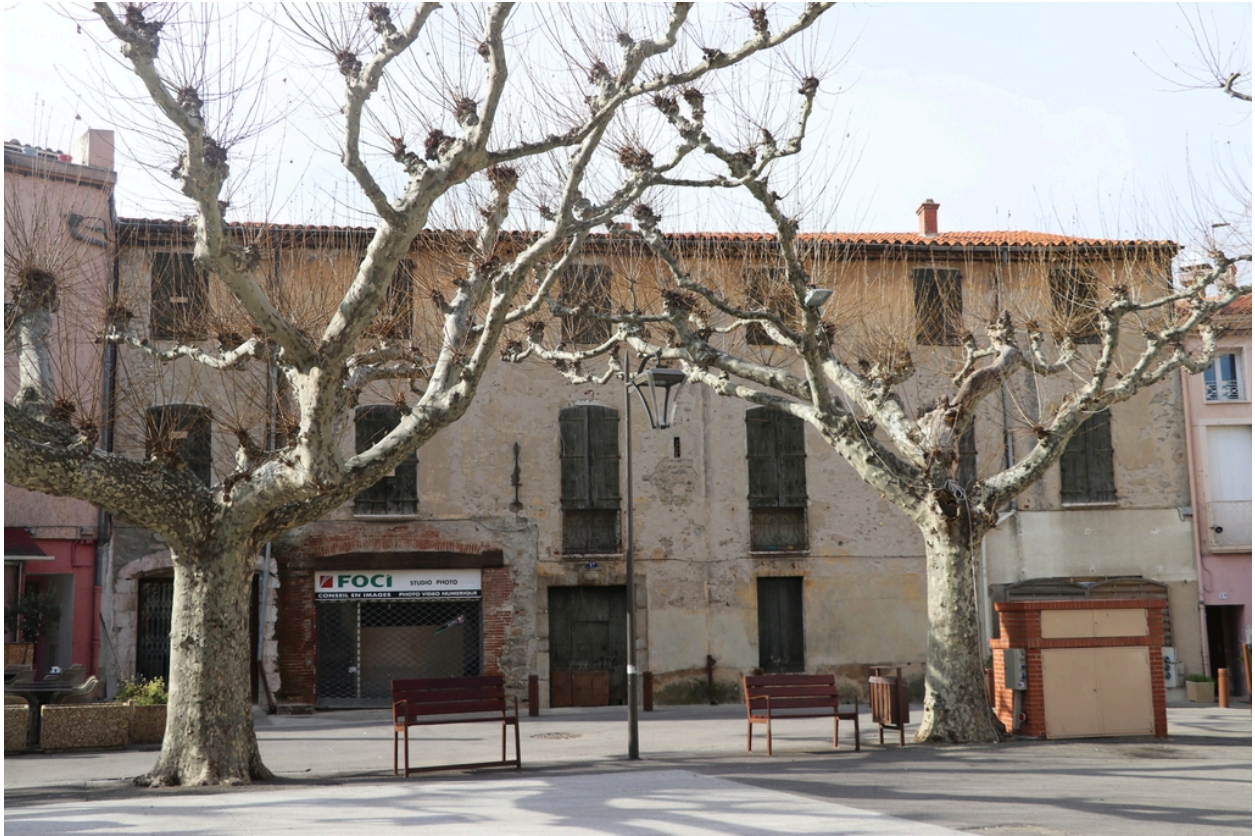
Maison Felip - Façade principale (Est), Place de la République.
