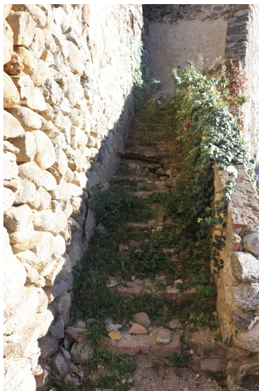
Maison Felip - Escalier droit extérieur, façade Ouest. Phot. Léonie Deshayes IVR76_20216661802NUCA
