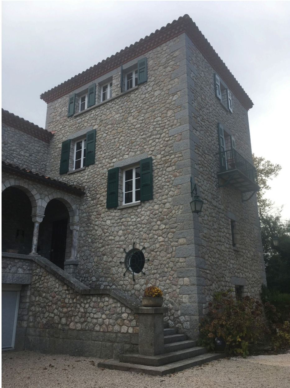
Maison Martin puis Château Las Closas puis Castell Rose - Angle Nord-Est du retour d'angle.
