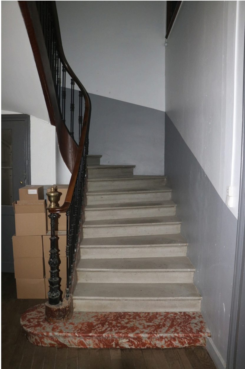
Ancienne maison de Lacroix puis pensionnat Saint-Joseph puis École catalane La Bressola puis médiathèque intercommunale - Escalier balancé au premier étage de la maison de Lacroix.
