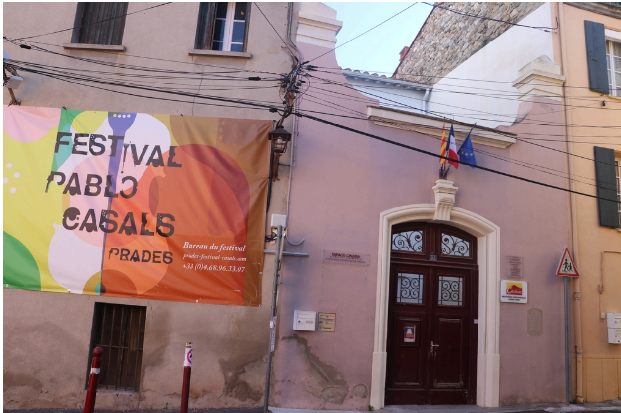
Ancienne maison de Lacroix puis pensionnat Saint-Joseph puis École catalane La Bressola puis médiathèque intercommunale - Entrée n°33 rue de l'Hospice.
