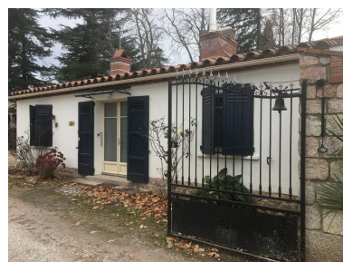
Maison Martin puis Château Las Closas puis Castell Rose - Ancienne maison de gardien à l'entrée de la propriété. Phot. Léonie Deshayes IVR76_20226665351NUCA
