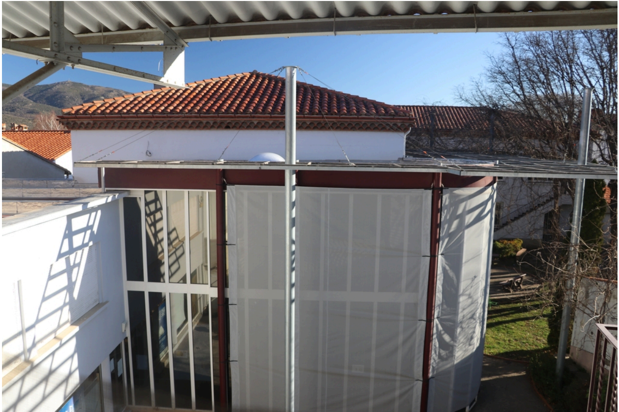
Ancienne maison de Lacroix puis pensionnat Saint-Joseph puis École catalane La Bressola puis médiathèque intercommunale - Toitures et escalier tournant de la médiathèque.
