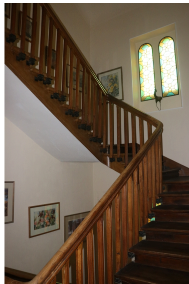
Villa Lafabrègue - Escalier balancé avec vitraux intermédiaires. Phot. Léonie Deshayes IVR76_20216665324NUCA
