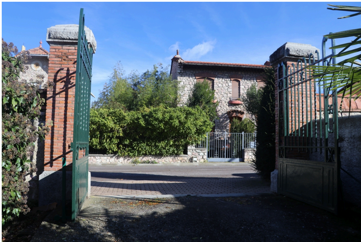
Villa Lafabrègue - Portail d'entrée actuel de la propriété.
