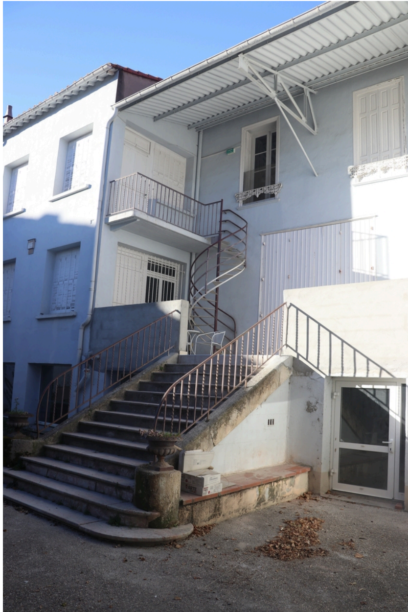
Ancienne maison de Lacroix puis pensionnat Saint-Joseph puis École catalane La Bressola puis médiathèque intercommunale - Façade Est de la maison de Lacroix.
