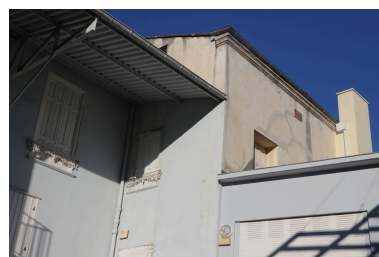
Ancienne maison de Lacroix puis pensionnat Saint-Joseph puis École catalane La Bressola puis médiathèque intercommunale - Corniche moulurée de la maison de Lacroix. Phot. Léonie Deshayes IVR76_20226665623NUCA
