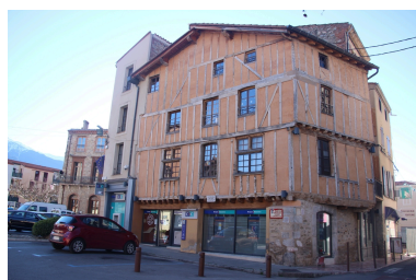
Maison Jourda (maison Jacomet) - Vue d'ensemble Nord-Est (1). Phot. Léonie Deshayes IVR76_20226665692NUCA
