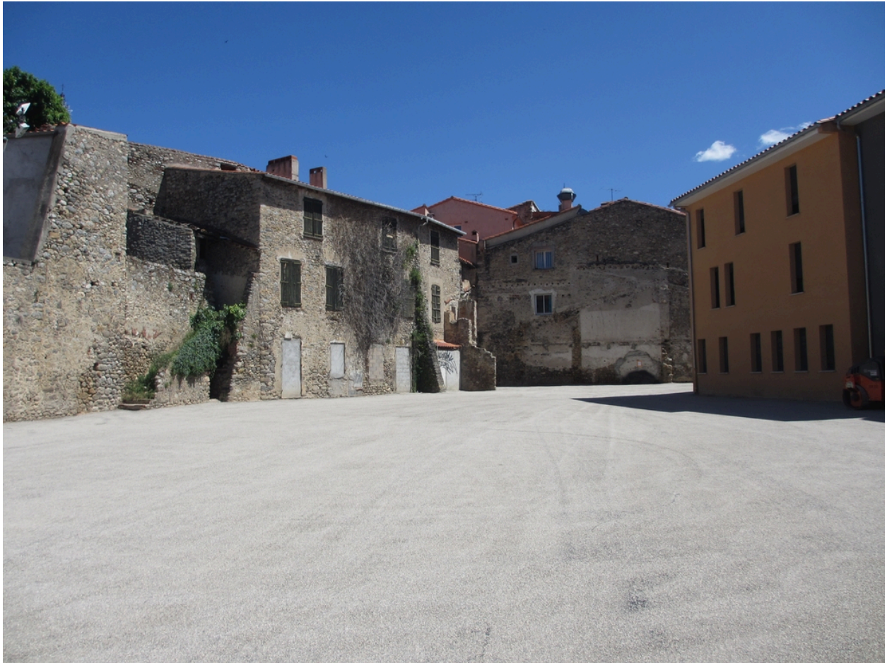
Maison Felip - Vue d'ensemble depuis la rue des Pyrénées, 20 Mai 2020.
