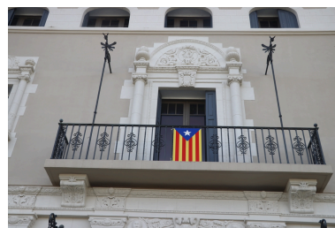
Château Valroch puis Université Catalane d'Été, École de Musique du Conflent et Centre d'accueil Pau Casals - Baie axiale au premier niveau de la façade Nord du château. Phot. Léonie Deshayes IVR76_20226665548NUCA
