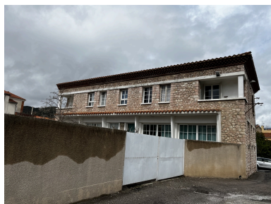
École maternelle, Écoles primaires de filles et de garçons, actuelles école maternelle Pasteur, écoles élémentaires Jean Petit et Jean Clerc - Façade Sud du bâtiment à maçonnerie en marbre rose de l'école élémentaire Jean Clerc. Phot. Léonie Deshayes IVR76_20226665782NUCA
