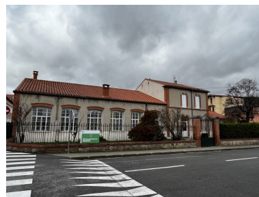
École maternelle, Écoles primaires de filles et de garçons, actuelles école maternelle Pasteur, écoles élémentaires Jean Petit et Jean Clerc - Façade Est du bâtiment principal de la maternelle.
