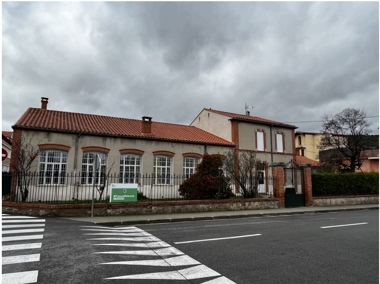
École maternelle, Écoles primaires de filles et de garçons, actuelles école maternelle Pasteur, écoles élémentaires Jean Petit et Jean Clerc - Façade Est du bâtiment principal de la maternelle.
