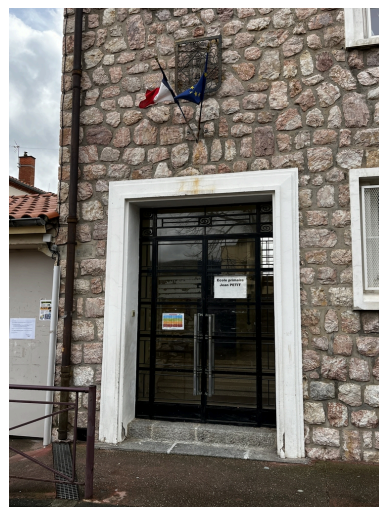
École maternelle, Écoles primaires de filles et de garçons, actuelles école maternelle Pasteur, écoles élémentaires Jean Petit et Jean Clerc - Entrée avec portail en fonte du bâtiment à maçonnerie en marbre rose de l'actuelle école élémentaire Jean Petit. Phot. Léonie Deshayes IVR76_20226665775NUCA
