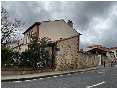
École maternelle, Écoles primaires de filles et de garçons, actuelles école maternelle Pasteur, écoles élémentaires Jean Petit et Jean Clerc - Vue Nord du bâtiment principal de la maternelle.
