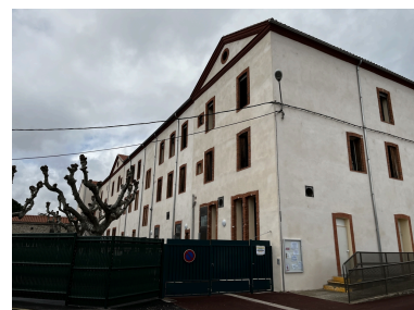
École supérieure des filles, puis Collège Moderne de Garçons dit « Pasteur » - Vue générale Sud-Est du bâtiment principal. Phot. Léonie Deshayes IVR76_20226665792NUCA
