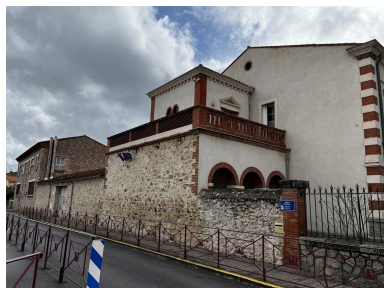
École maternelle, Écoles primaires de filles et de garçons, actuelles école maternelle Pasteur, écoles élémentaires Jean Petit et Jean Clerc - Pavillon Nord de l'école primaire de garçons. Phot. Léonie Deshayes IVR76_20226665779NUCA
