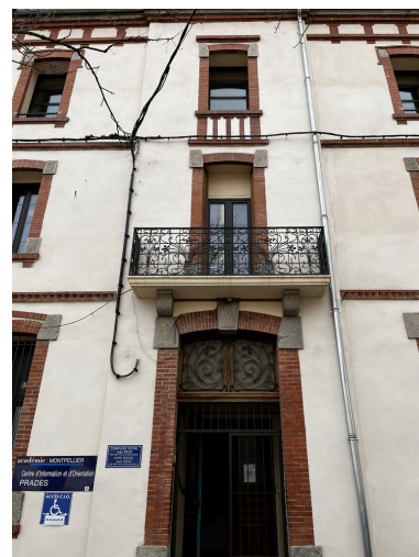
École supérieure des filles, puis Collège Moderne de Garçons dit « Pasteur » - Travée axiale en façade Nord du bâtiment principal. Phot. Léonie Deshayes IVR76_20226665795NUCA
