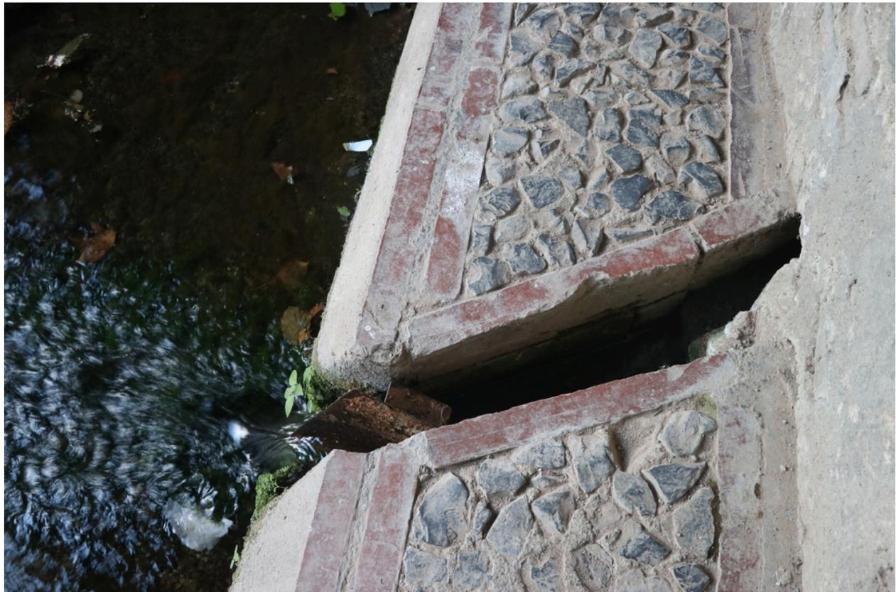
Lavoirs de la rue des Fabriques - Détail d'une canalisation avec vanne en fer.
