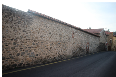
Presbytère 2° - Enceinte Nord. Phot. Léonie Deshayes IVR76_20226665409NUCA
