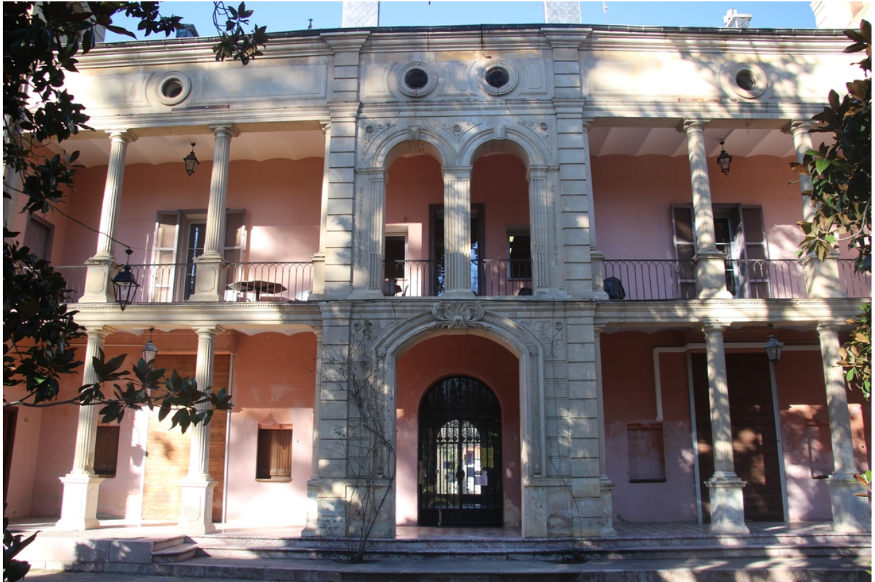
Château Pams puis Hôtel de ville - Façade Sud.
