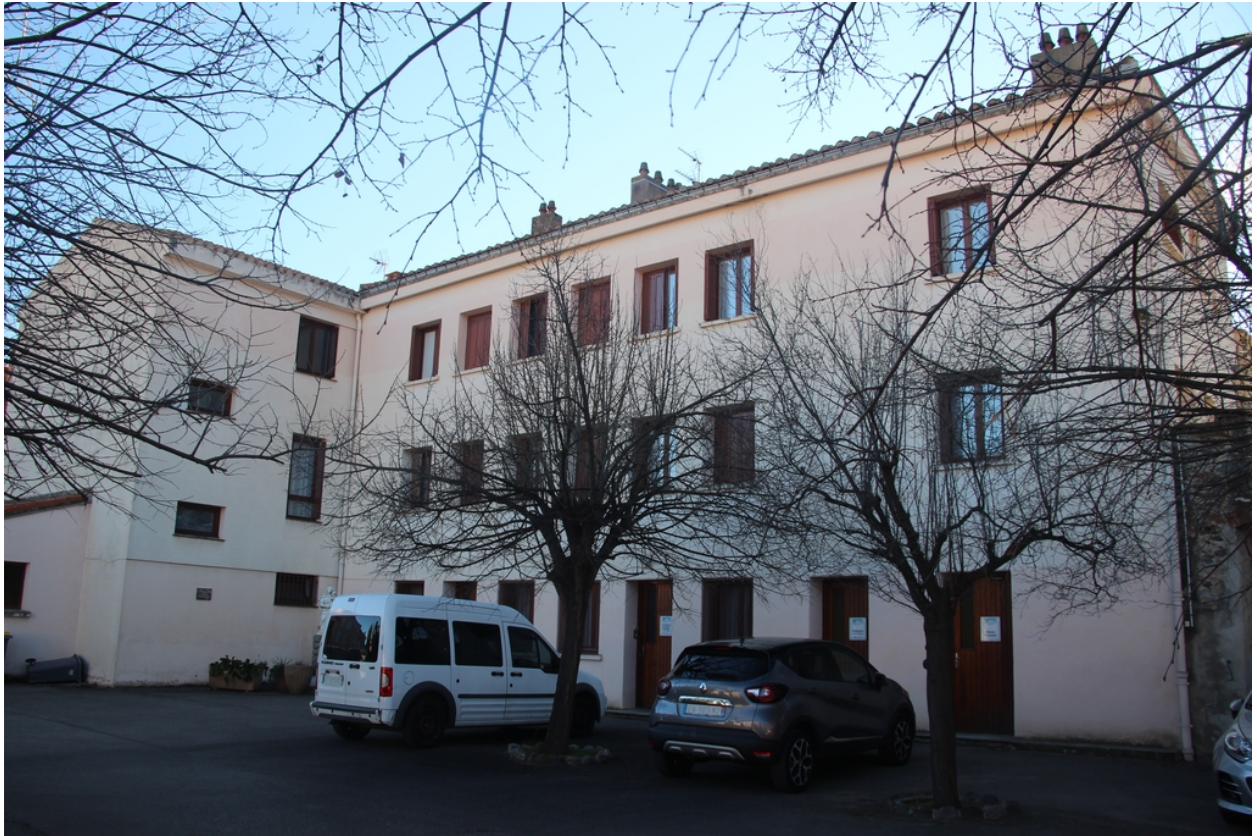
Presbytère 2° - Cour intérieure et angle Sud-Est des bâtiments cadastrés BA 35 et BA 223.
