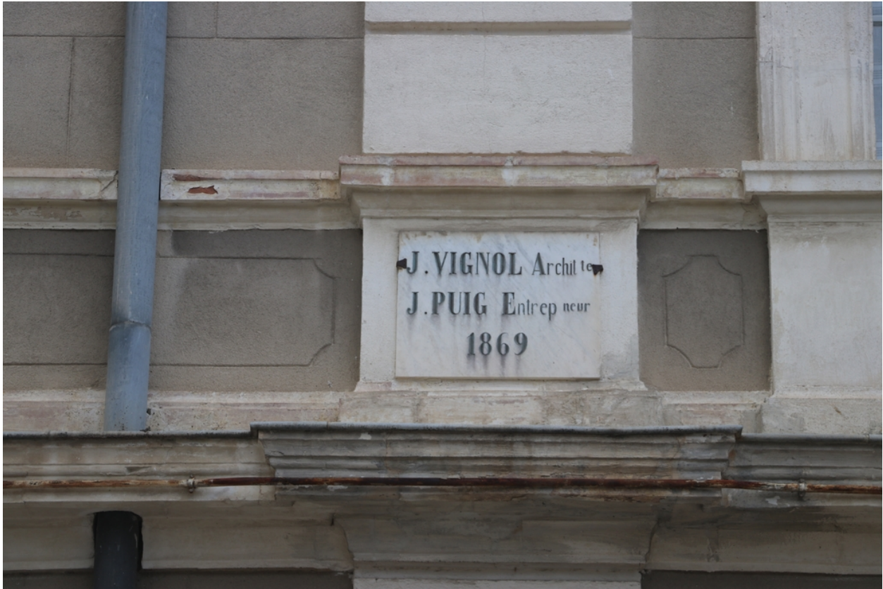
Sous-préfecture - Plaque en marbre mentionnant le nom des maîtres d'œuvre sur un piédroit au premier niveau de la façade Nord.
