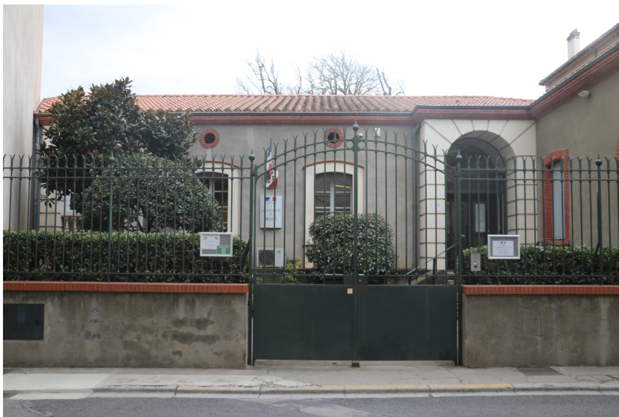
Sous-préfecture - Face Nord de l'extension orientale.
