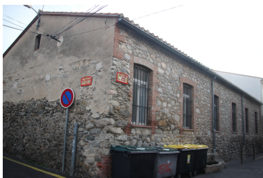
Presbytère 2° - Angle extérieur Nord-Ouest de la dépendance sur rue de l'Agriculture et rue des Aires. Phot. Léonie Deshayes IVR76_20226665418NUCA
