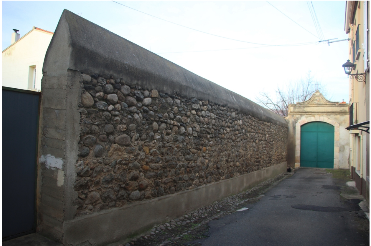
Presbytère 2° - Impasse Marceau avec portail d'accès.
