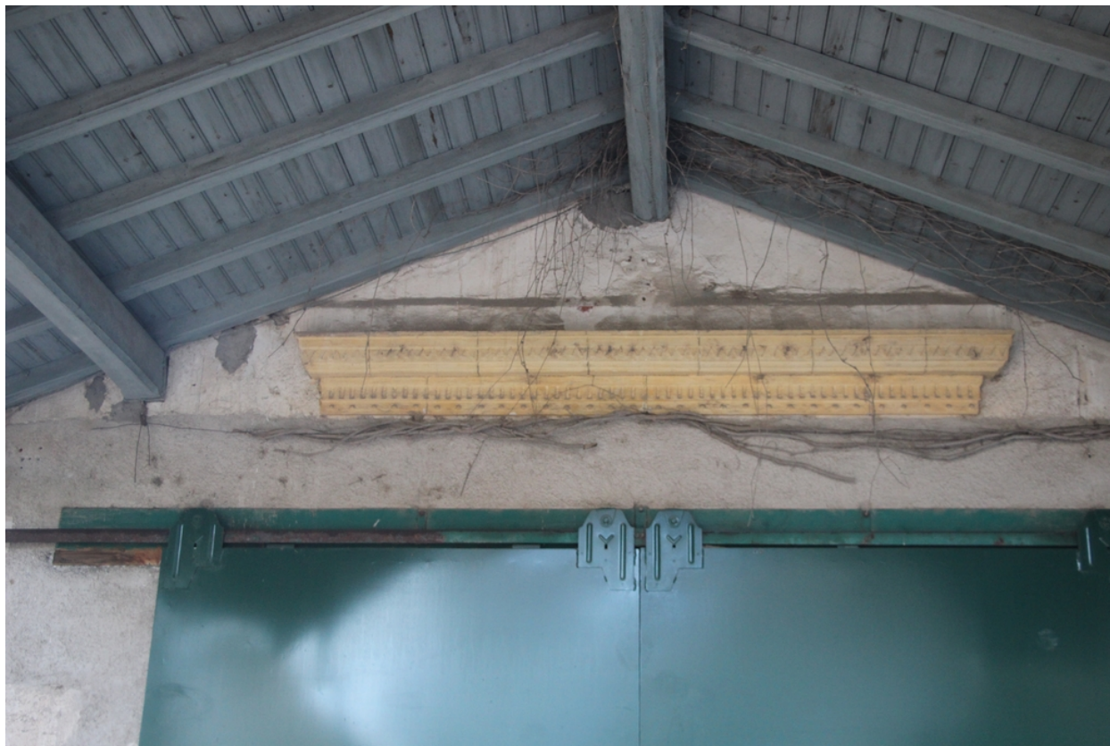
Château Pams puis Hôtel de ville - Corniche décorative des anciennes dépendances.
