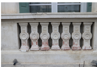
Sous-préfecture - Détail d'un garde-corps à balustres en terre cuite enduite en soubassement. Phot. Léonie Deshayes IVR76_20226665737NUCA
