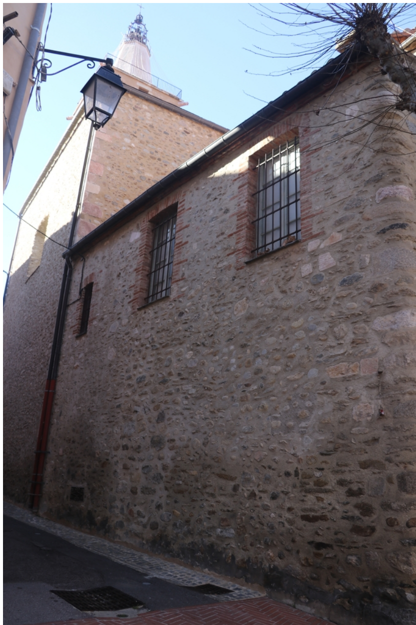
Église paroissiale Saint-Pierre - Façade Sud du Trésor.
