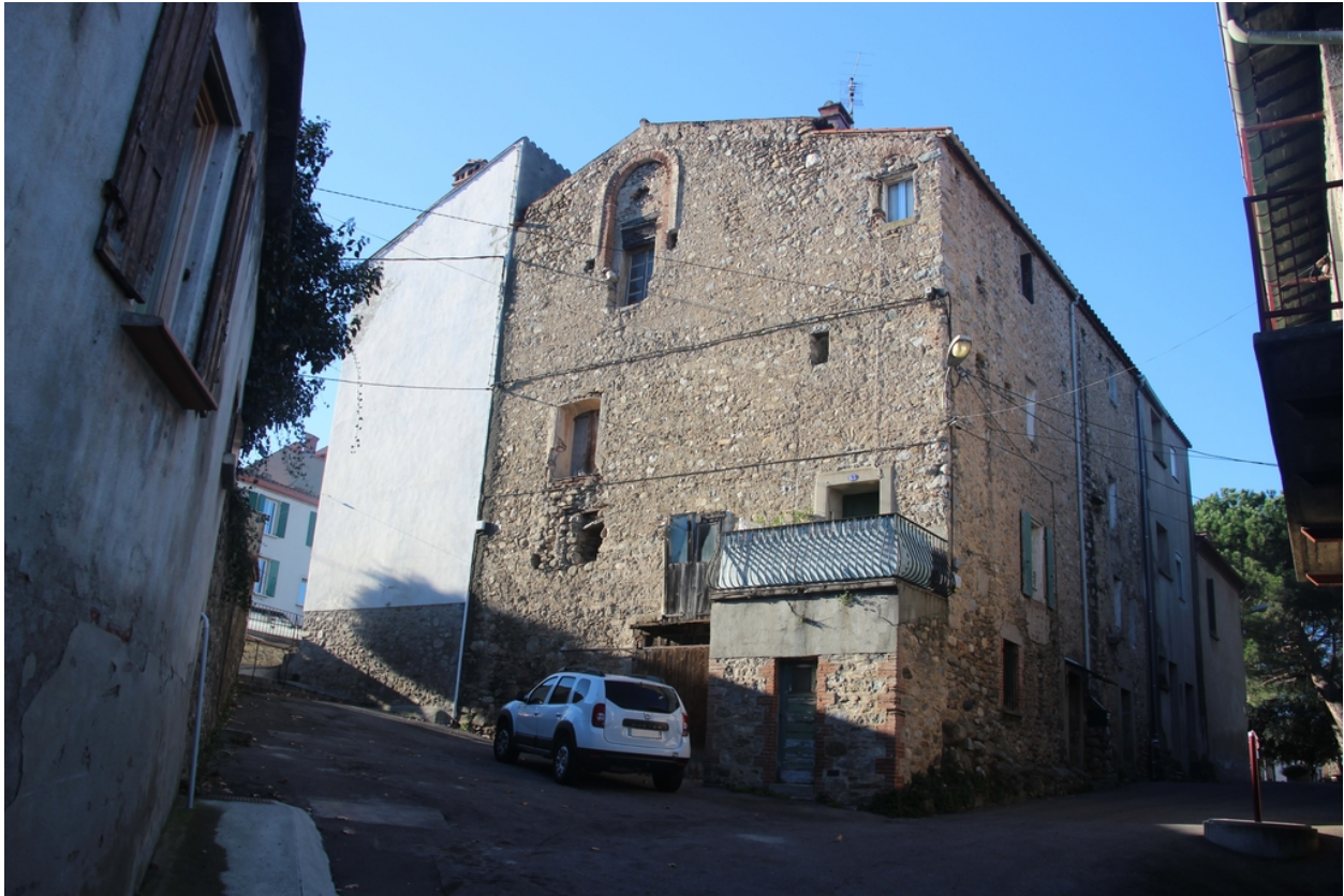
Église Saint-Côme et Saint-Damien puis maisons d'habitation - Vue d'ensemble Nord-Est depuis la rue de l'Abattoir.
