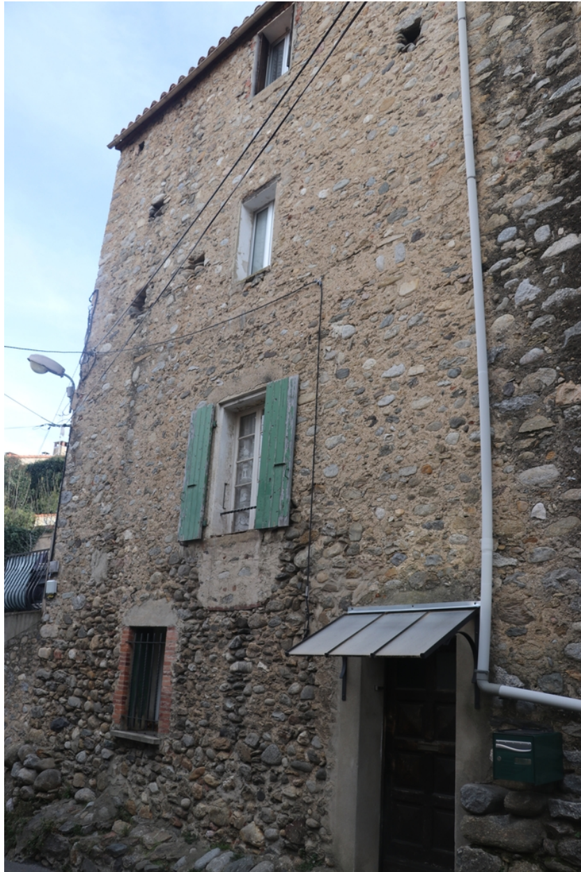
Église Saint-Côme et Saint-Damien puis maisons d'habitation - Façade Nord de l'habitation n°8 rue de l'Abattoir.
