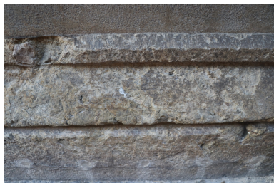
Palais de justice-Tribunal - Soubassement en pierre de taille piquée. Phot. Léonie Deshayes IVR76_20226665728NUCA
