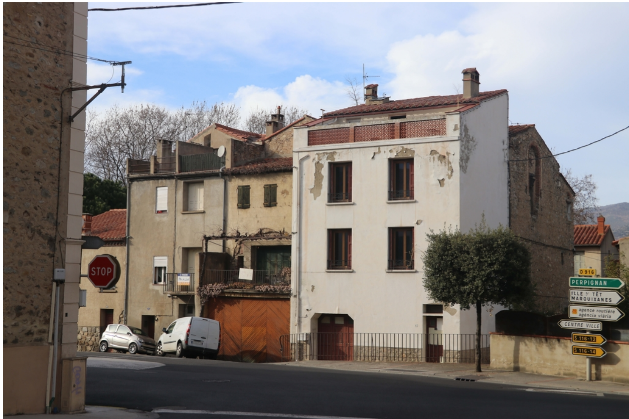
Église Saint-Côme et Saint-Damien puis maisons d'habitation - Vue d'ensemble de l'îlot depuis le boulevard de la Gare.
