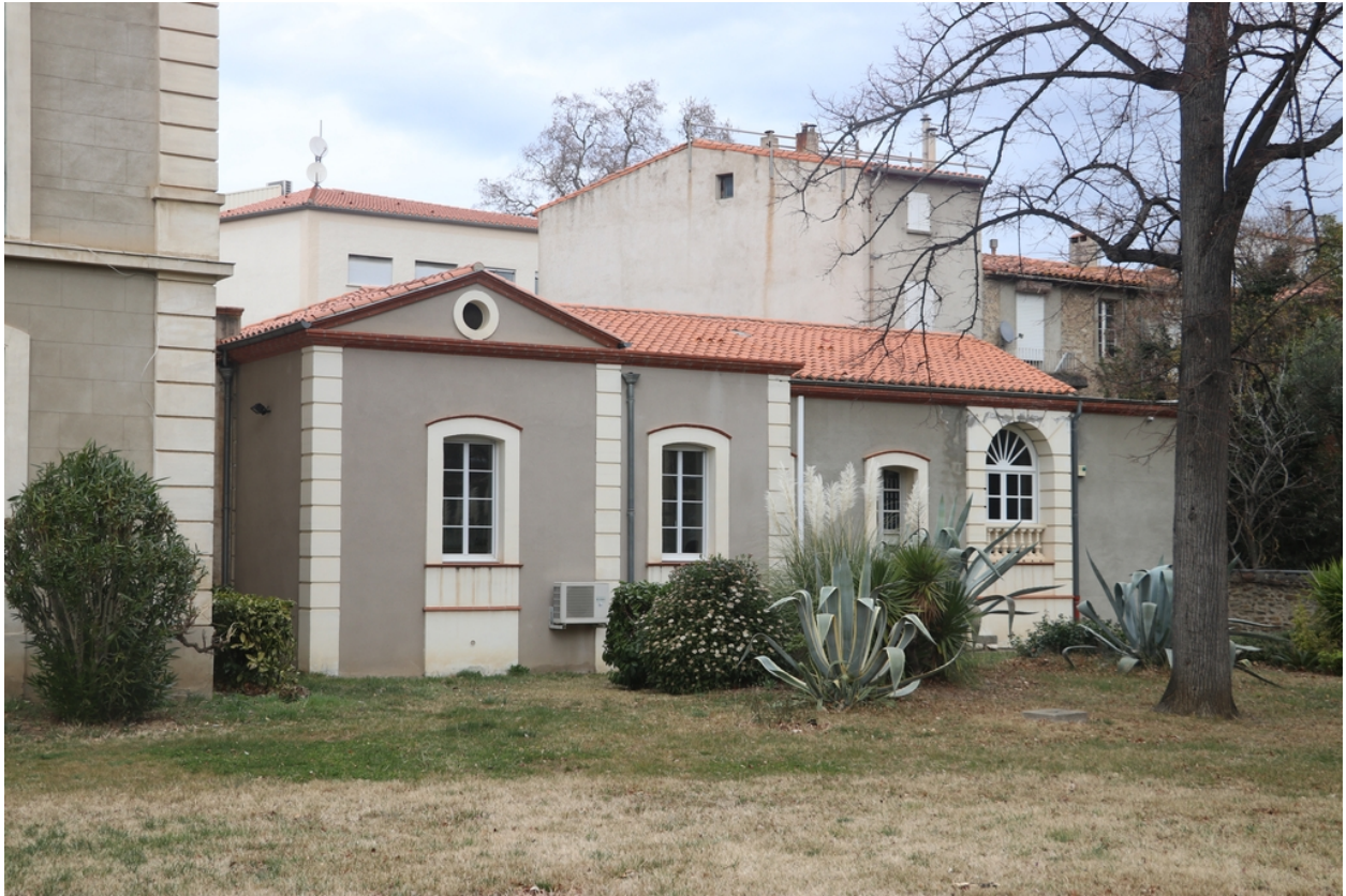
Sous-préfecture - Face méridionale de l'extension Est.
