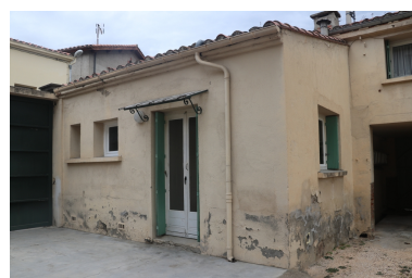
Sous-préfecture - Construction postérieure accolée à la façade occidentale du bâtiment latéral Ouest. Phot. Léonie Deshayes IVR76_20226665747NUCA
