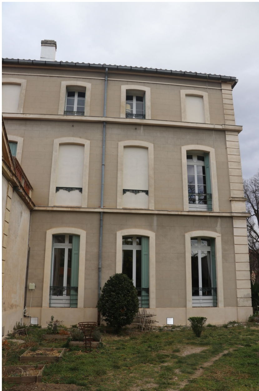
Sous-préfecture - Façade Ouest du corps de bâtiment principal.
