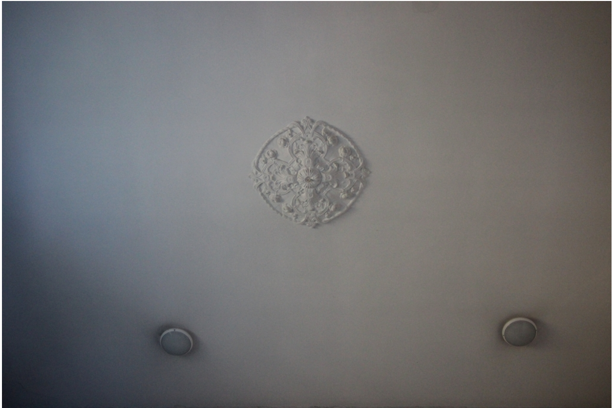
Château Pams puis Hôtel de ville - Moulure en staff de la cage d'escalier.
