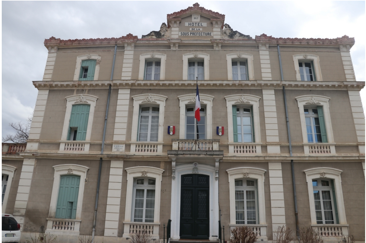
Sous-préfecture - Façade principale Nord du corps de bâtiment principal.
