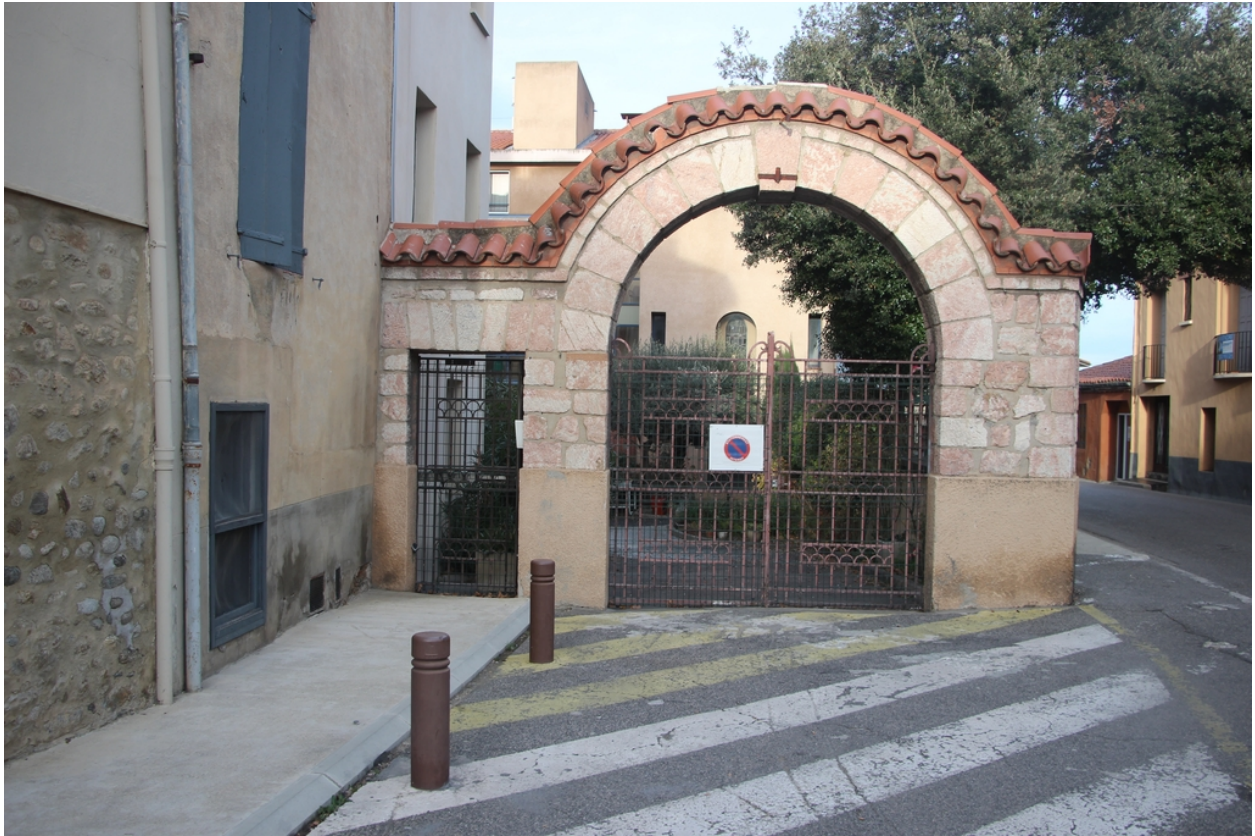
Hôpital-Hospice puis maison de retraite Guy Malé - Portail d'accès sur la rue de la Basse.
