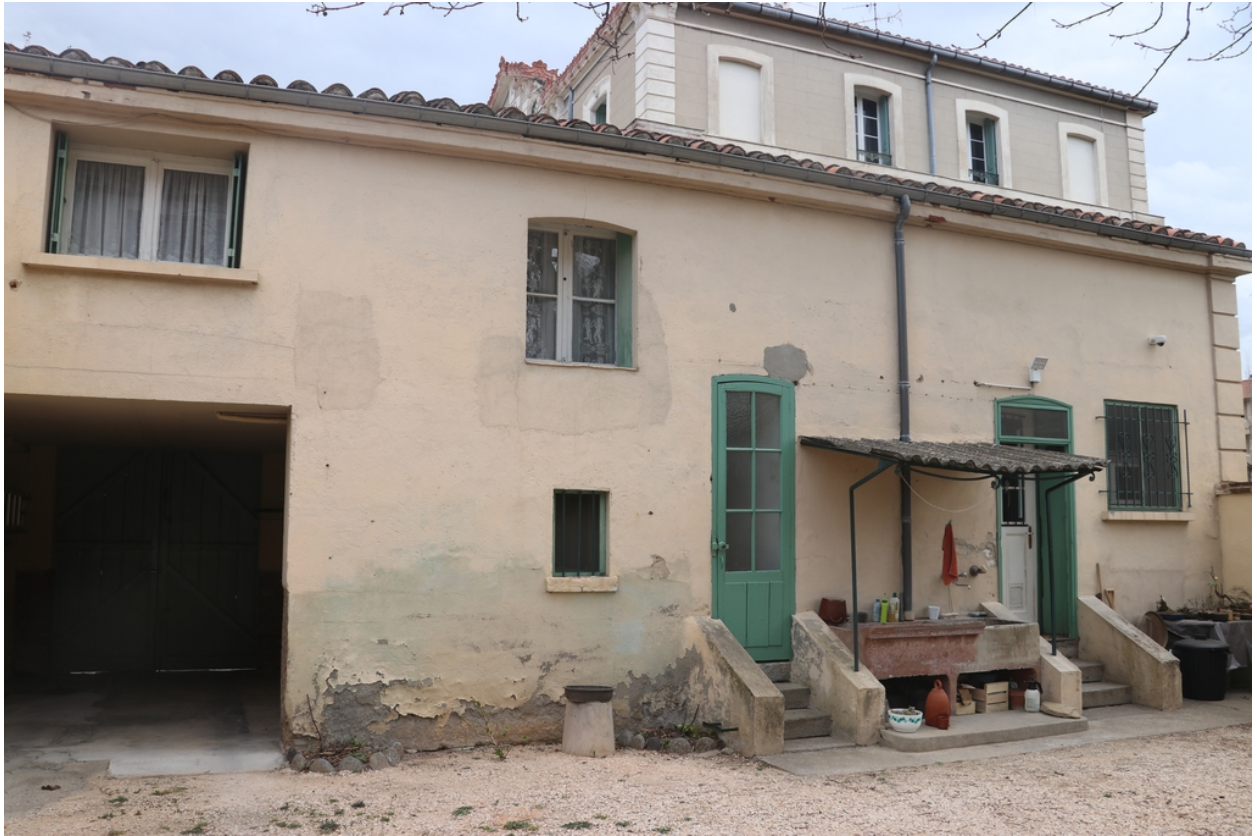
Sous-préfecture - Façade occidentale du bâtiment latéral Ouest avec logement du concierge.
