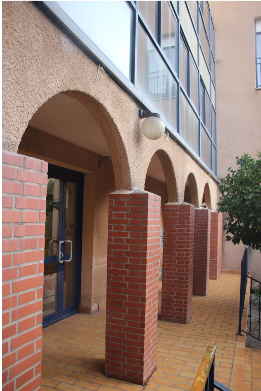
Hôpital-Hospice puis maison de retraite Guy Malé - Galerie intérieure Ouest.
