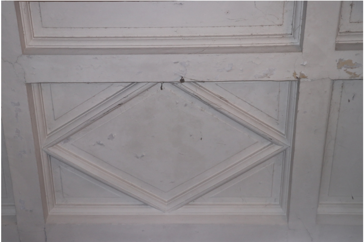
Palais de justice-Tribunal - Plafond à caissons de l'entrée monumentale.
