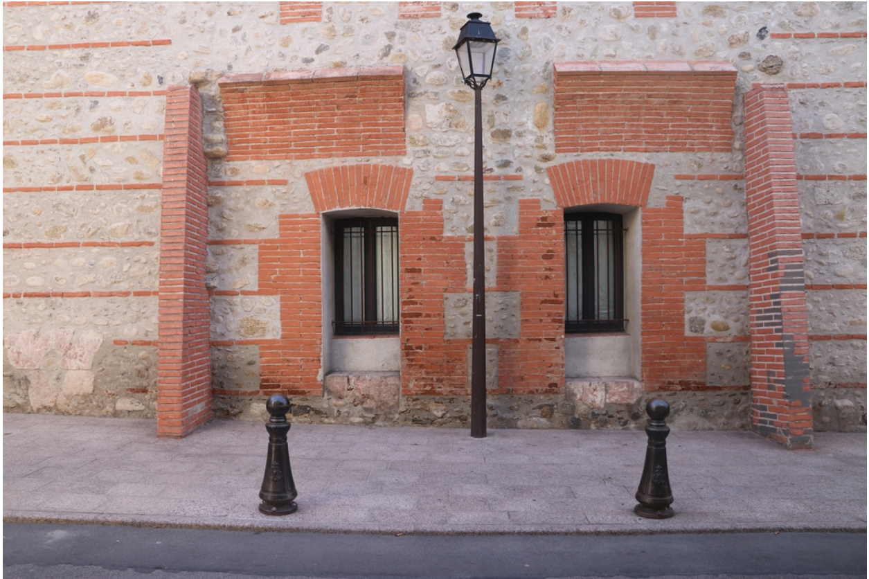
Prison puis Espace Martin Vivès - Baies du rez-de-chaussée en façade Est.
