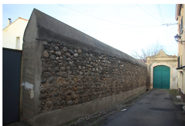
Presbytère 2° - Impasse Marceau avec portail d'accès. Phot. Léonie Deshayes IVR76_20226665410NUCA
