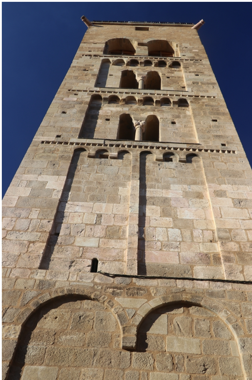
Église paroissiale Saint-Pierre - Face Sud du clocher-tour.
