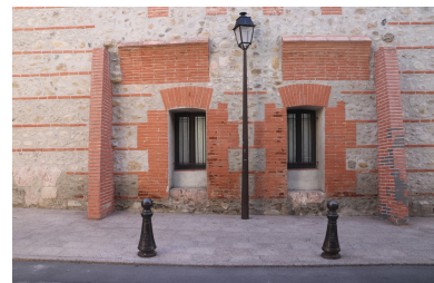
Prison puis Espace Martin Vivès - Baies du rez-de-chaussée en façade Est. Phot. Léonie Deshayes IVR76_20226665761NUCA
