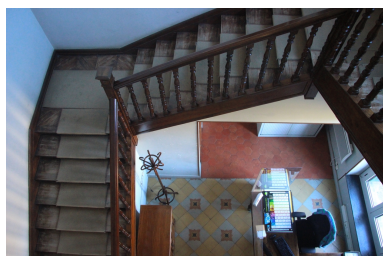
Château Pams puis Hôtel de ville - Volées de l'escalier de distribution intérieur. Phot. Léonie Deshayes IVR76_20226665462NUCA
