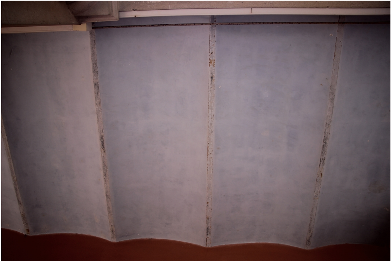
Château Pams puis Hôtel de ville - Plancher à voûtains de la loggia Sud.
