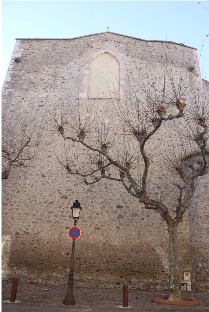
Église paroissiale Saint-Pierre - Chevet oriental.
