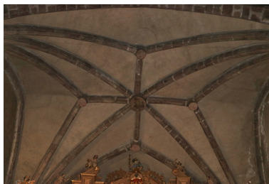
Église paroissiale Saint-Pierre - Voûte d'ogives à liernes et tiercerons du chœur. Phot. Léonie Deshayes IVR76_20226665512NUCA
