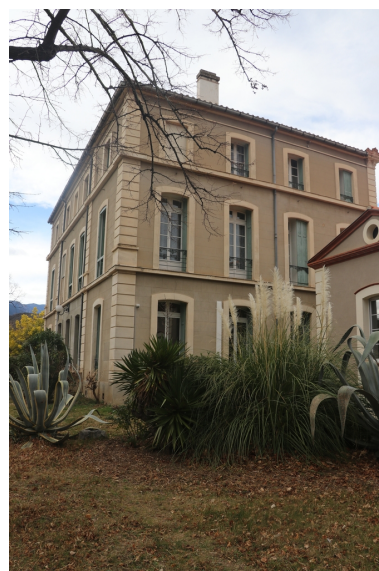
Sous-préfecture - Vue Sud-Est du corps de bâtiment principal. Phot. Léonie Deshayes IVR76_20226665738NUCA
