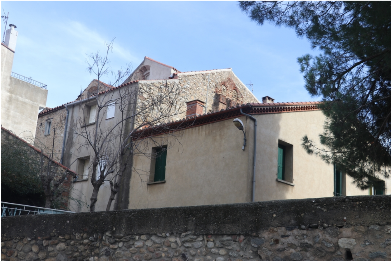
Église Saint-Côme et Saint-Damien puis maisons d'habitation - Vue Nord des vestiges de l'église conservés.
