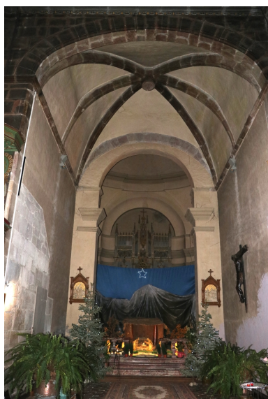
Église paroissiale Saint-Pierre - Chapelle de la Conception. Phot. Léonie Deshayes IVR76_20226665502NUCA
