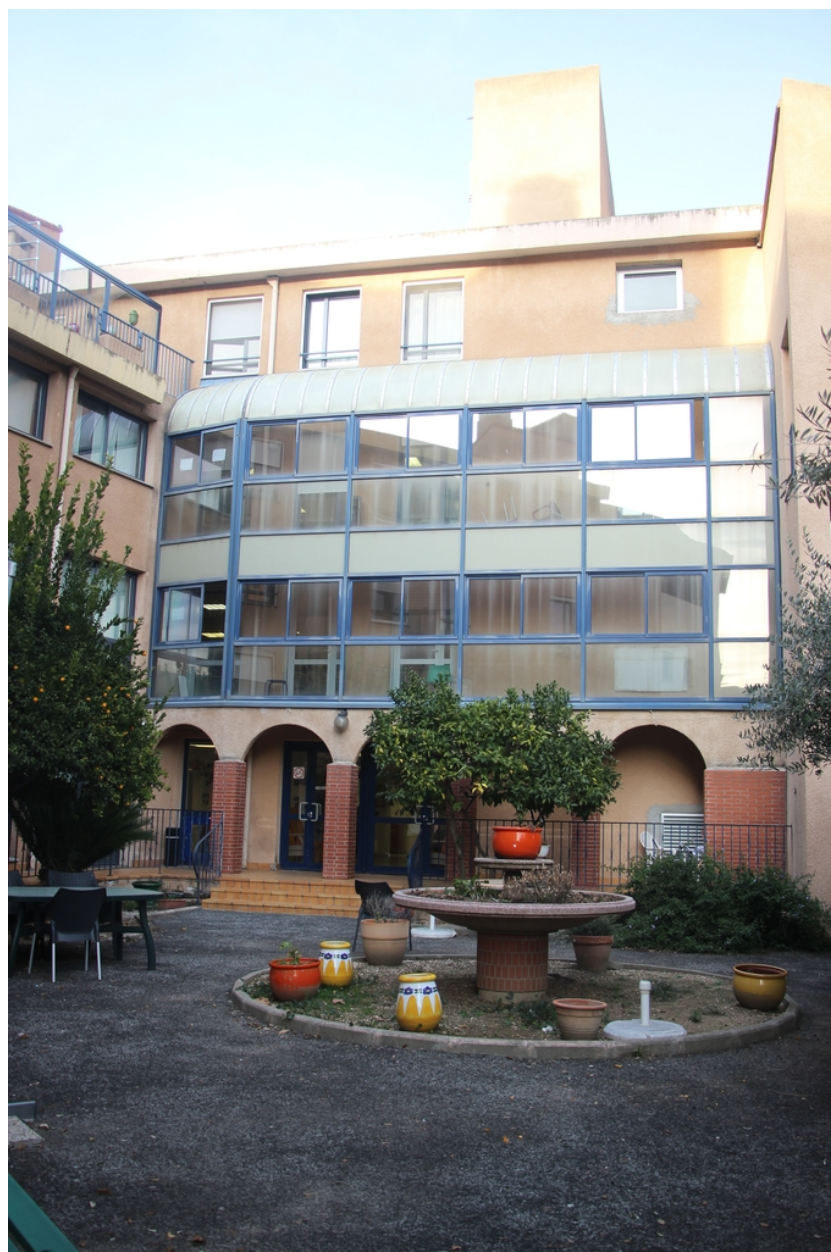
Hôpital-Hospice puis maison de retraite Guy Malé - Façade intérieure Ouest.
