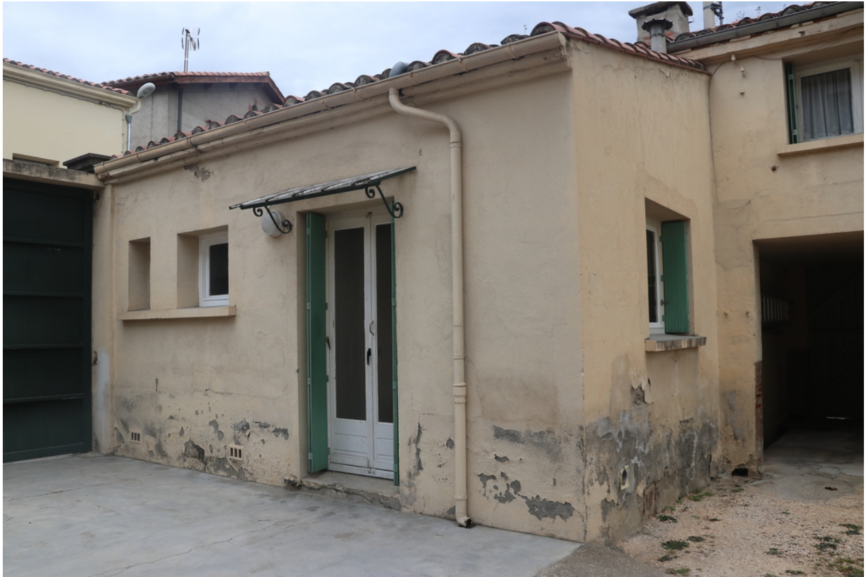
Sous-préfecture - Construction postérieure accolée à la façade occidentale du bâtiment latéral Ouest.
