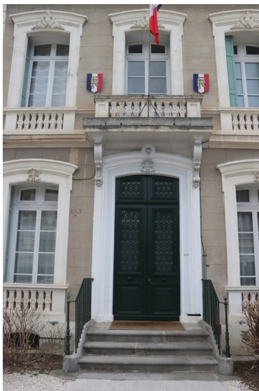
Sous-préfecture - Travée de baies axiale en façade Nord du corps de bâtiment principal. Phot. Léonie Deshayes IVR76_20226665734NUCA
