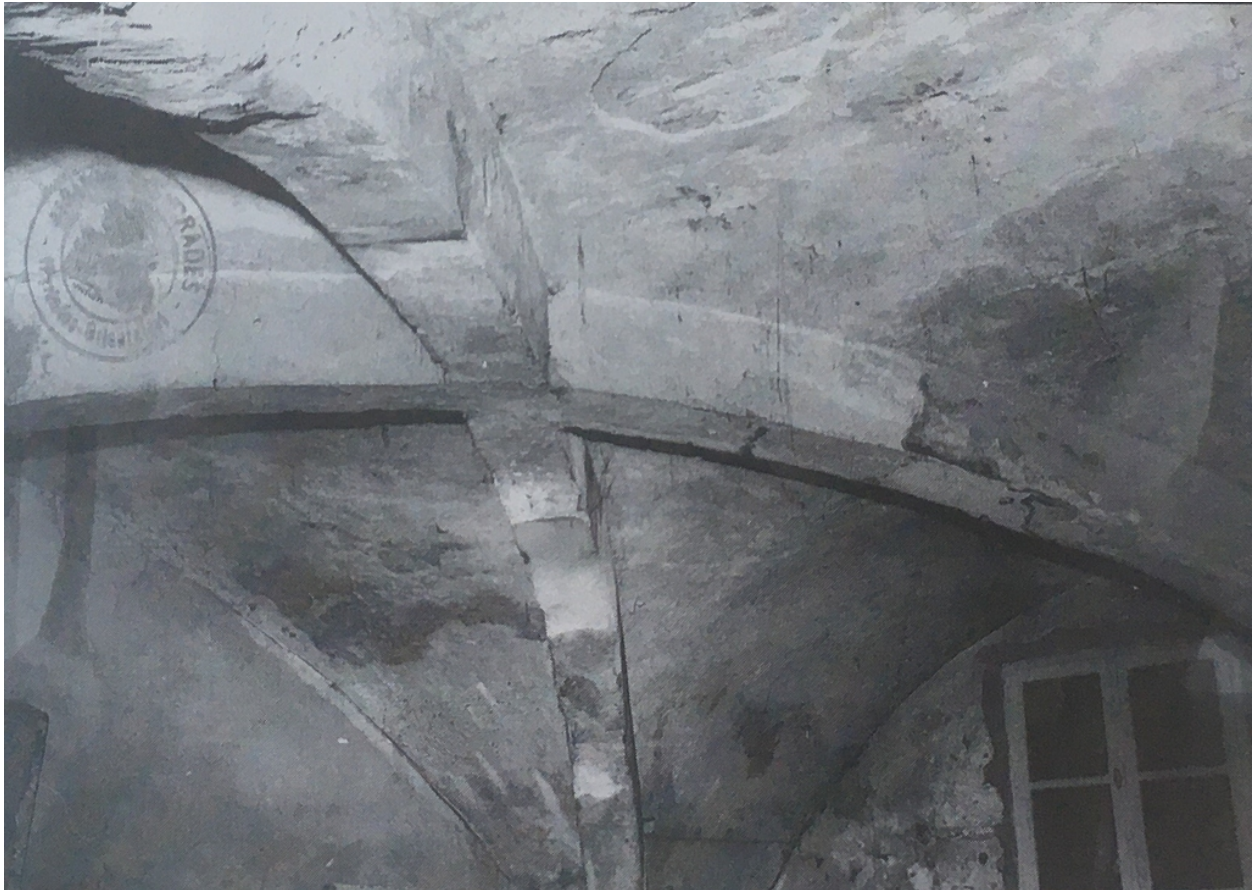
Église Saint-Côme et Saint-Damien puis maisons d'habitation - Intérieur de l'ancienne église avec voûte sur croisée d'ogives, p.73.
