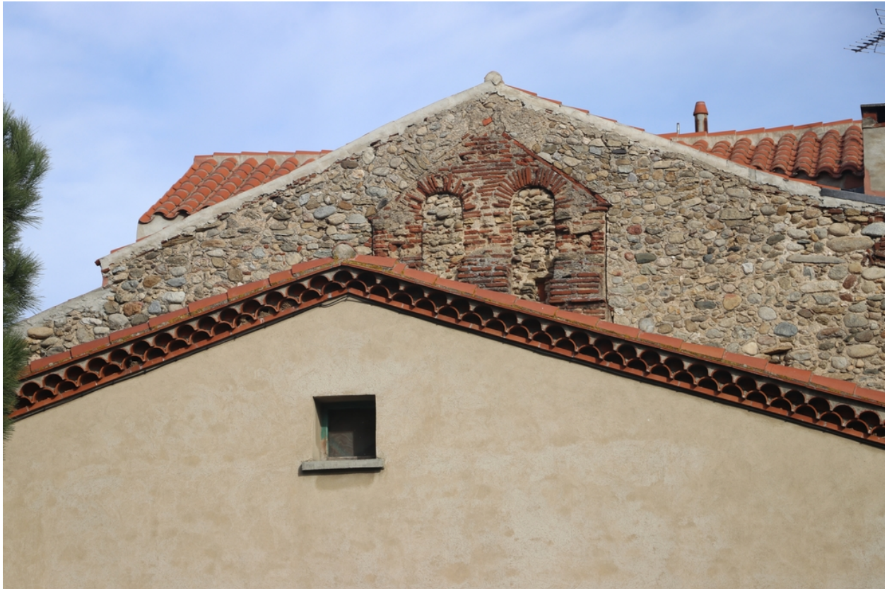
Église Saint-Côme et Saint-Damien puis maisons d'habitation - Détail du clocher-mur en façade Ouest de l'habitation n°55 rue du Pérou.
