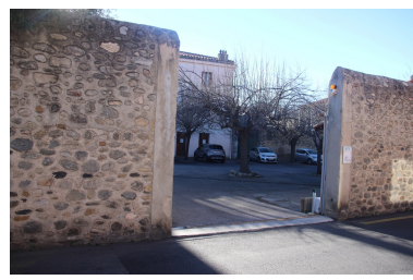
Presbytère 2° - Portail coulissant sur rue de l'Agriculture. Phot. Léonie Deshayes IVR76_20226665408NUCA
