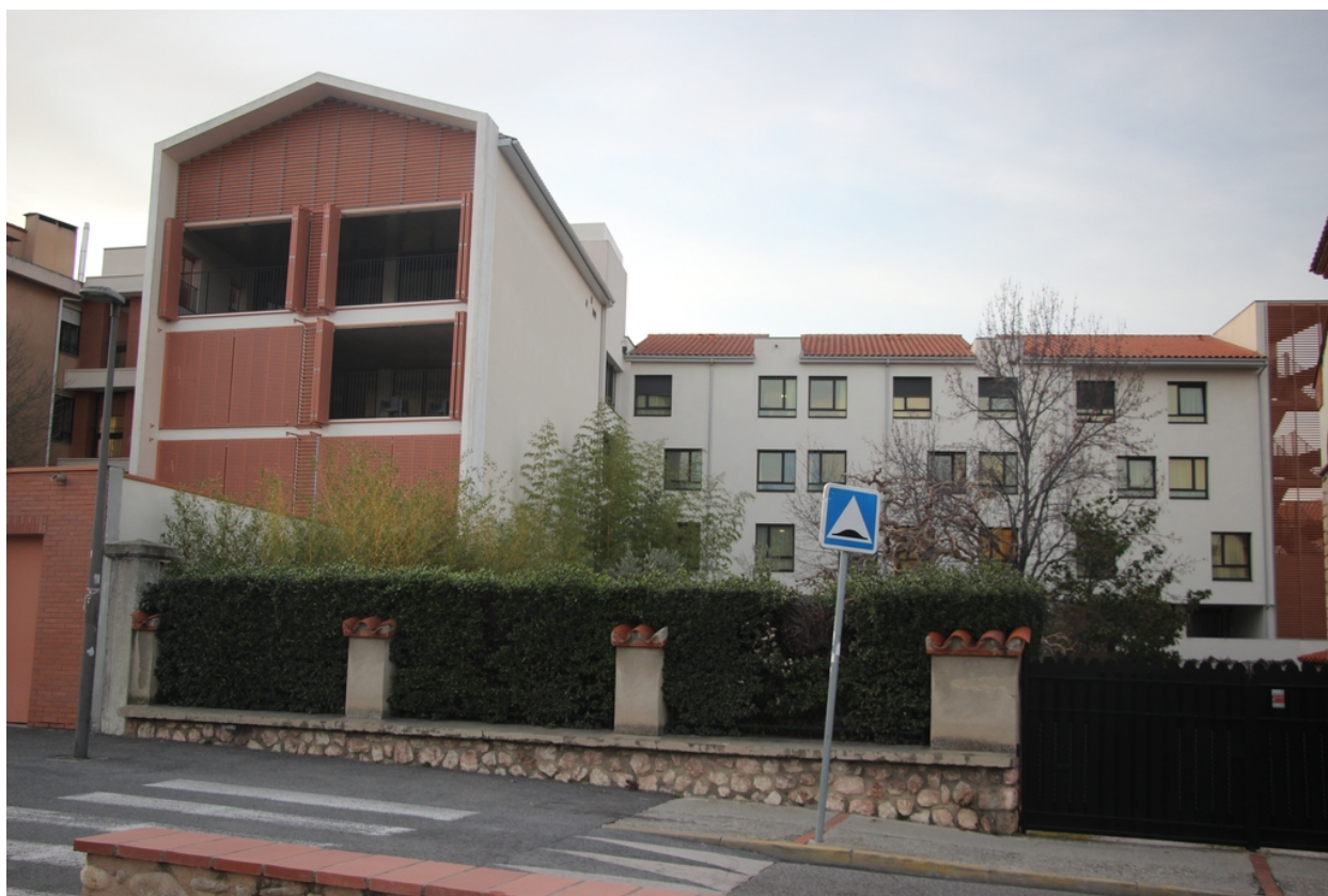
Hôpital-Hospice puis maison de retraite Guy Malé - Extension de 2017.
