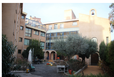
Hôpital-Hospice puis maison de retraite Guy Malé - Vue du complexe depuis la cour cadastrée BA 198. Phot. Léonie Deshayes IVR76_20226665392NUCA
