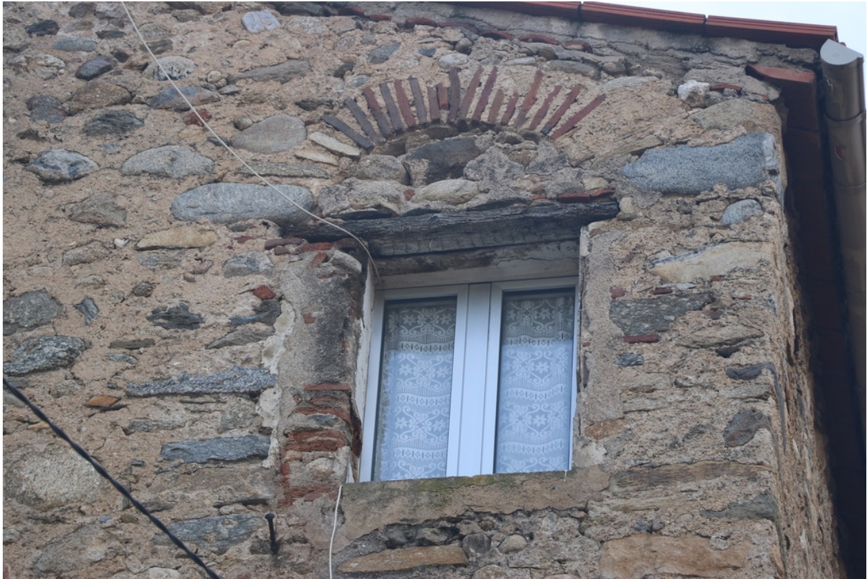
Église Saint-Côme et Saint-Damien puis maisons d'habitation - Baie remaniée avec encadrement d'origine en façade Est de l'habitation n°59 rue du Pérou.
