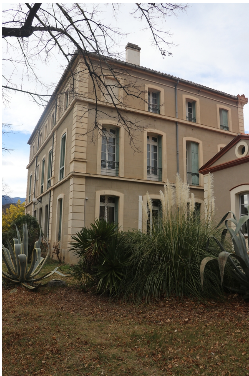
Sous-préfecture - Vue Sud-Est du corps de bâtiment principal.
