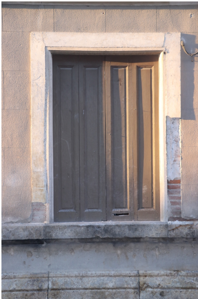
Palais de justice-Tribunal - Baie en rez-de-chaussée.
