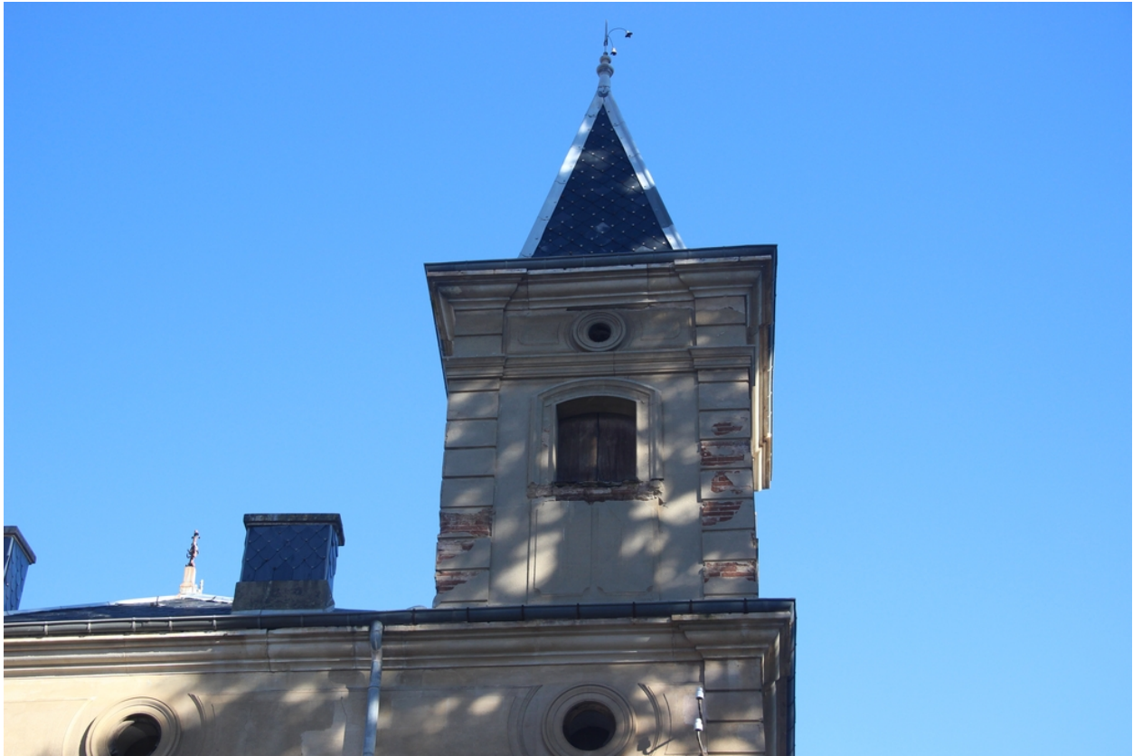
Château Pams puis Hôtel de ville - Tourelle d'angle Sud-Ouest.
