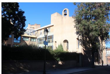
Hôpital-Hospice puis maison de retraite Guy Malé - Angle Sud-Ouest de la chapelle. Phot. Léonie Deshayes IVR76_20226665380NUCA
