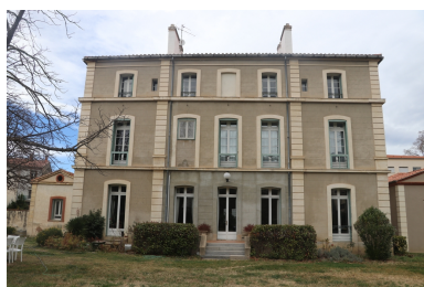
Sous-préfecture - Façade Sud du corps de bâtiment principal. Phot. Léonie Deshayes IVR76_20226665739NUCA
