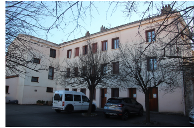
Presbytère 2° - Cour intérieure et angle Sud-Est des bâtiments cadastrés BA 35 et BA 223. Phot. Léonie Deshayes IVR76_20226665414NUCA
