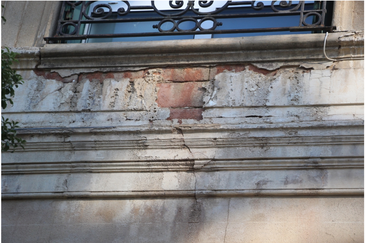
Château Pams puis Hôtel de ville - Détail de la maçonnerie en cayrous recouverts par un enduit.
