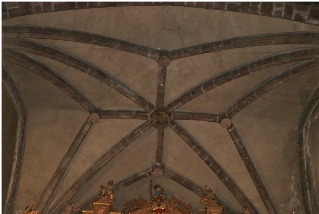
Église paroissiale Saint-Pierre - Voûte d'ogives à liernes et tiercerons du chœur.
