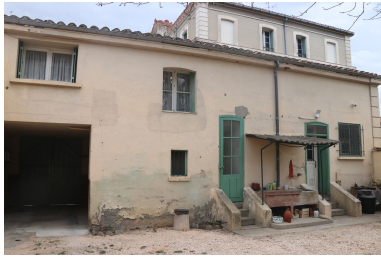
Sous-préfecture - Façade occidentale du bâtiment latéral Ouest avec logement du concierge. Phot. Léonie Deshayes IVR76_20226665748NUCA
