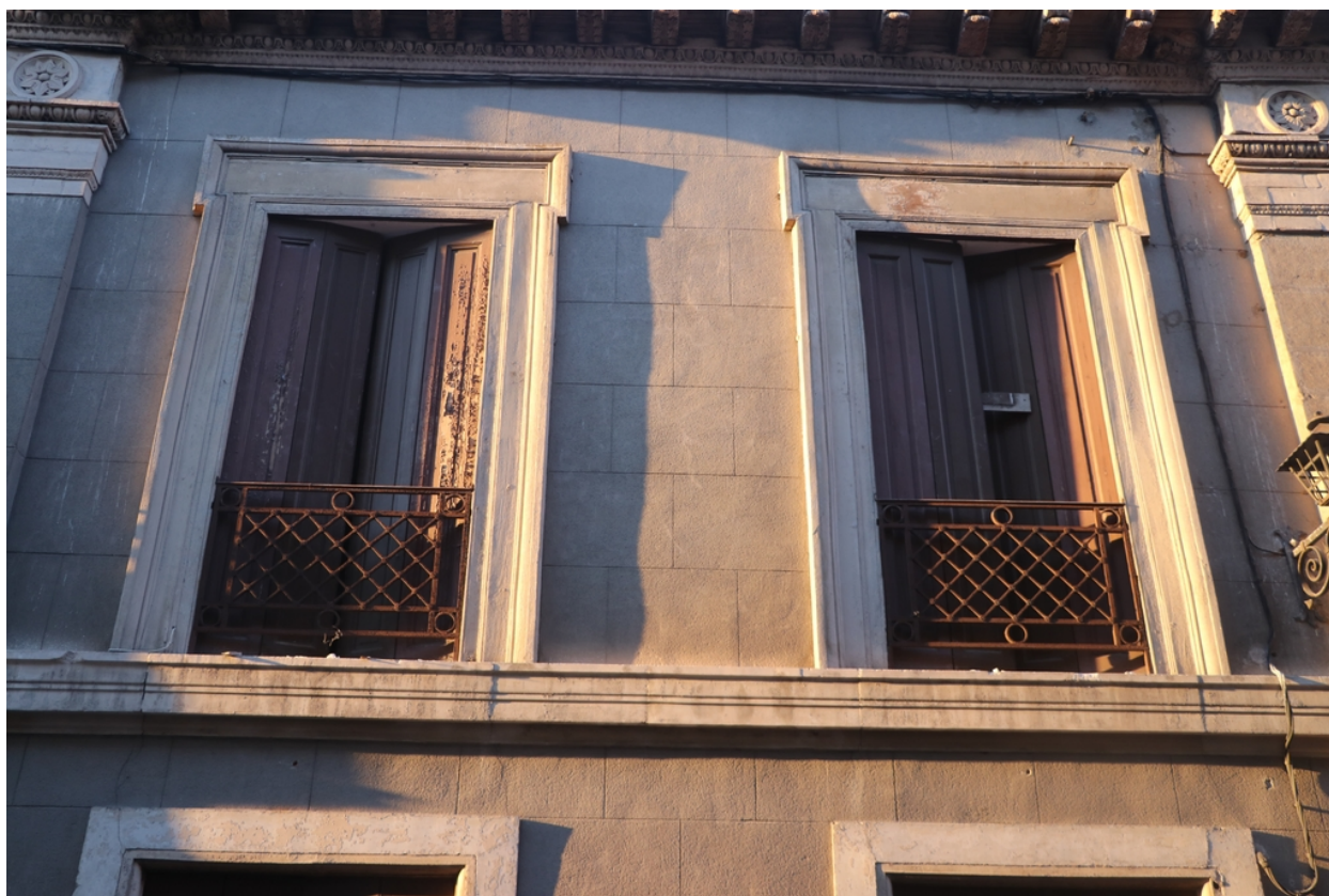
Palais de justice-Tribunal - Baies au premier étage.
