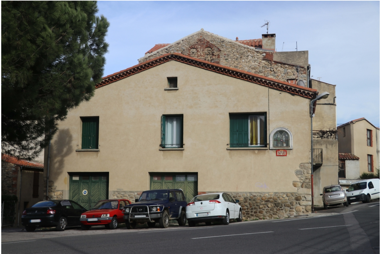
Église Saint-Côme et Saint-Damien puis maisons d'habitation - Façade Ouest de l'habitation n°53 bis rue du Pérou.
