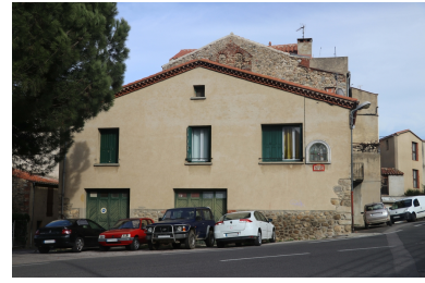
Église Saint-Côme et Saint-Damien puis maisons d'habitation - Façade Ouest de l'habitation n°53 bis rue du Pérou. Phot. Léonie Deshayes IVR76_20226665528NUCA
