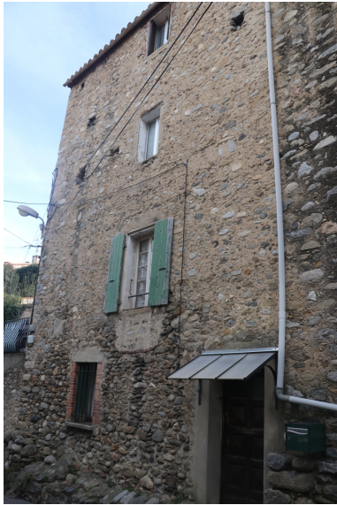
Église Saint-Côme et Saint-Damien puis maisons d'habitation - Façade Nord de l'habitation n°8 rue de l'Abattoir. Phot. Léonie Deshayes IVR76_20226665535NUCA
