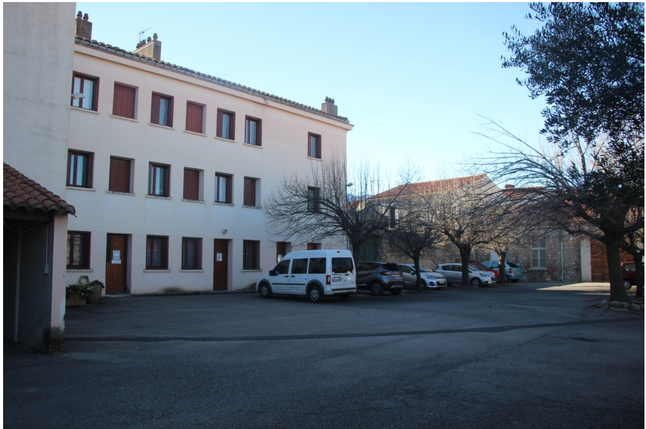
Presbytère 2° - Vue d'ensemble de la cour intérieure et bâtiment cadastré BA 35 en arrière-plan.
