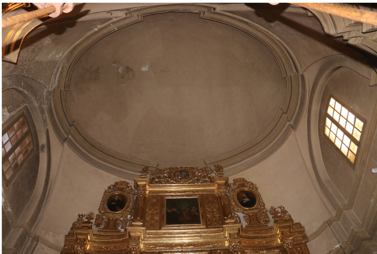
Église paroissiale Saint-Pierre - Voûte de la chapelle Saint-Benoît.
