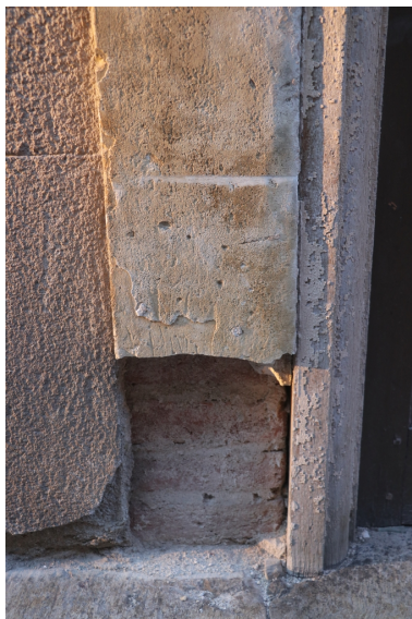
Palais de justice-Tribunal - Palais de justice-Tribunal - Détail de la menuiserie et de la maçonnerie au rez-de-chaussée. Phot. Léonie Deshayes IVR76_20226665729NUCA
