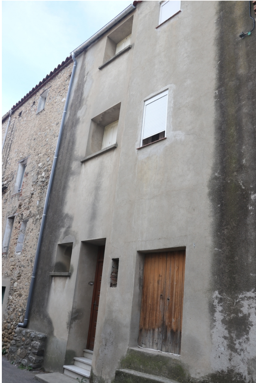
Église Saint-Côme et Saint-Damien puis maisons d'habitation - Façade Nord de l'habitation n°57 rue du Pérou.
