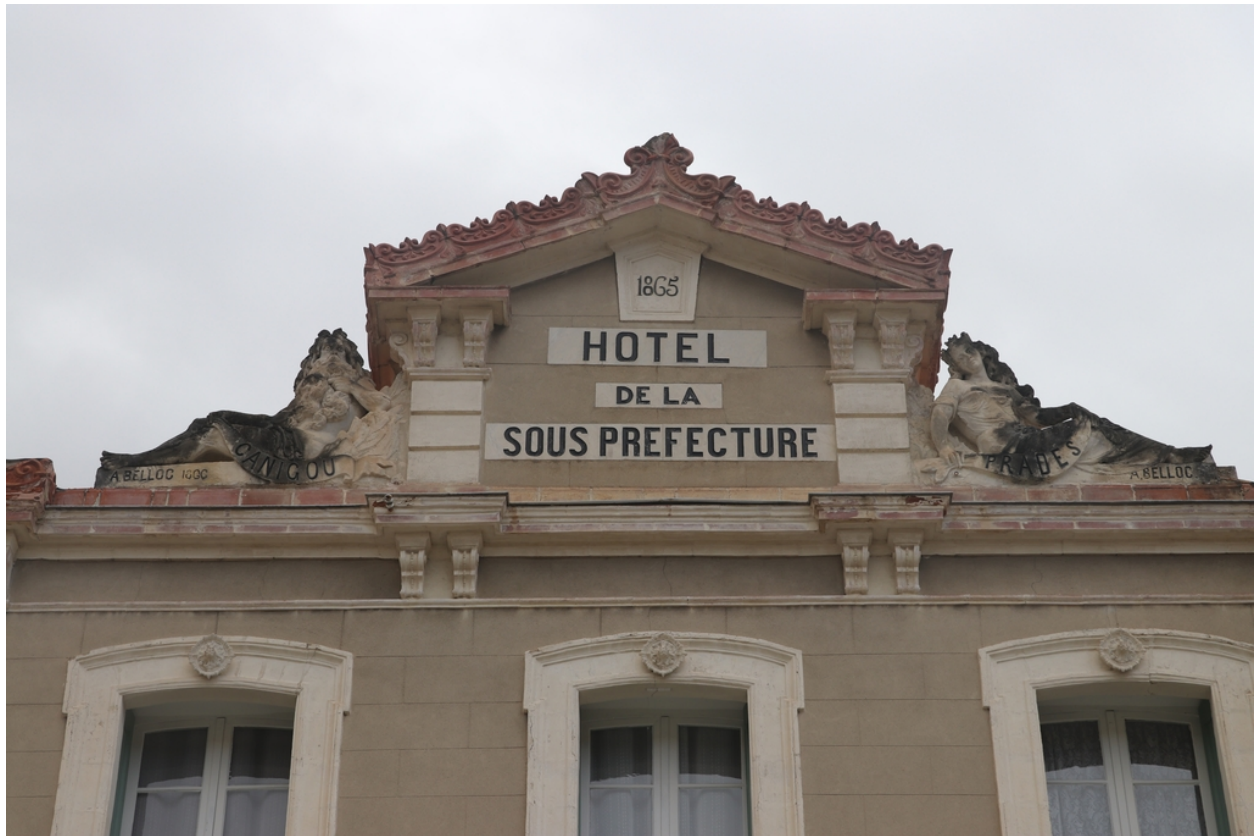
Sous-préfecture - Détail du fronton en façade Nord du corps de bâtiment principal.
