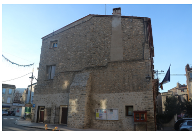
Chapelle Notre-Dame-du-Rosaire puis Halle et Mairie - Façade Est. Phot. Léonie Deshayes IVR76_20226665521NUCA
