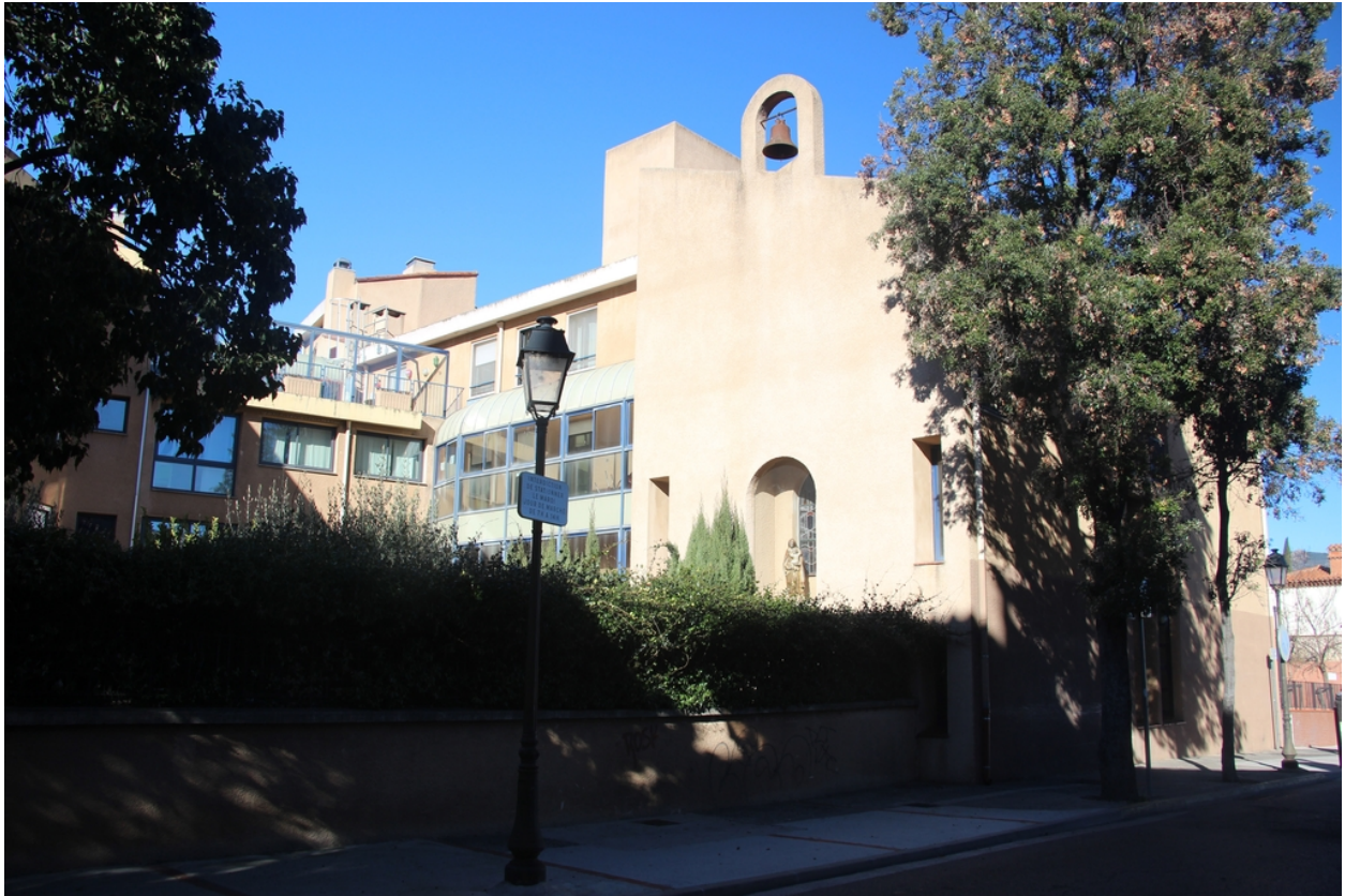
Hôpital-Hospice puis maison de retraite Guy Malé - Angle Sud-Ouest de la chapelle.
