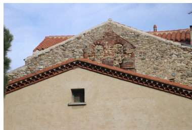
Église Saint-Côme et Saint-Damien puis maisons d'habitation - Détail du clocher-mur en façade Ouest de l'habitation n°55 rue du Pérou. Phot. Léonie Deshayes IVR76_20226665530NUCA
