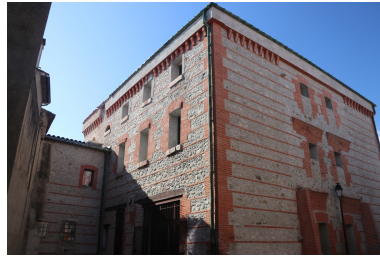
Prison puis Espace Martin Vivès - Vue générale Sud-Est. Phot. Léonie Deshayes IVR76_20226665763NUCA
