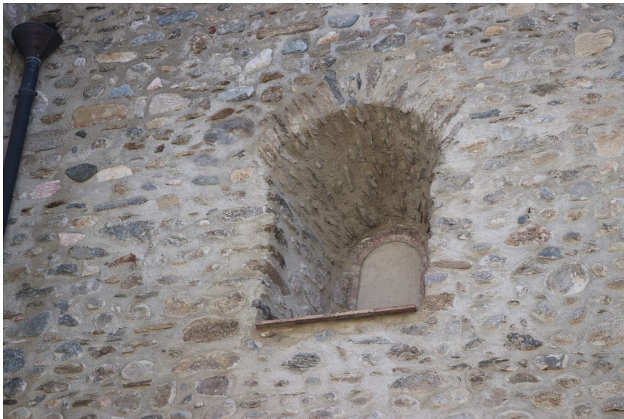
Église paroissiale Saint-Pierre - Baie de style roman au premier niveau de la façade Nord.
