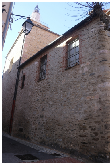
Église paroissiale Saint-Pierre - Façade Sud du Trésor. Phot. Léonie Deshayes IVR76_20226665490NUCA
