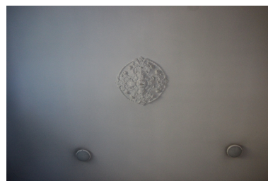
Château Pams puis Hôtel de ville - Moulure en staff de la cage d'escalier. Phot. Léonie Deshayes IVR76_20226665464NUCA
