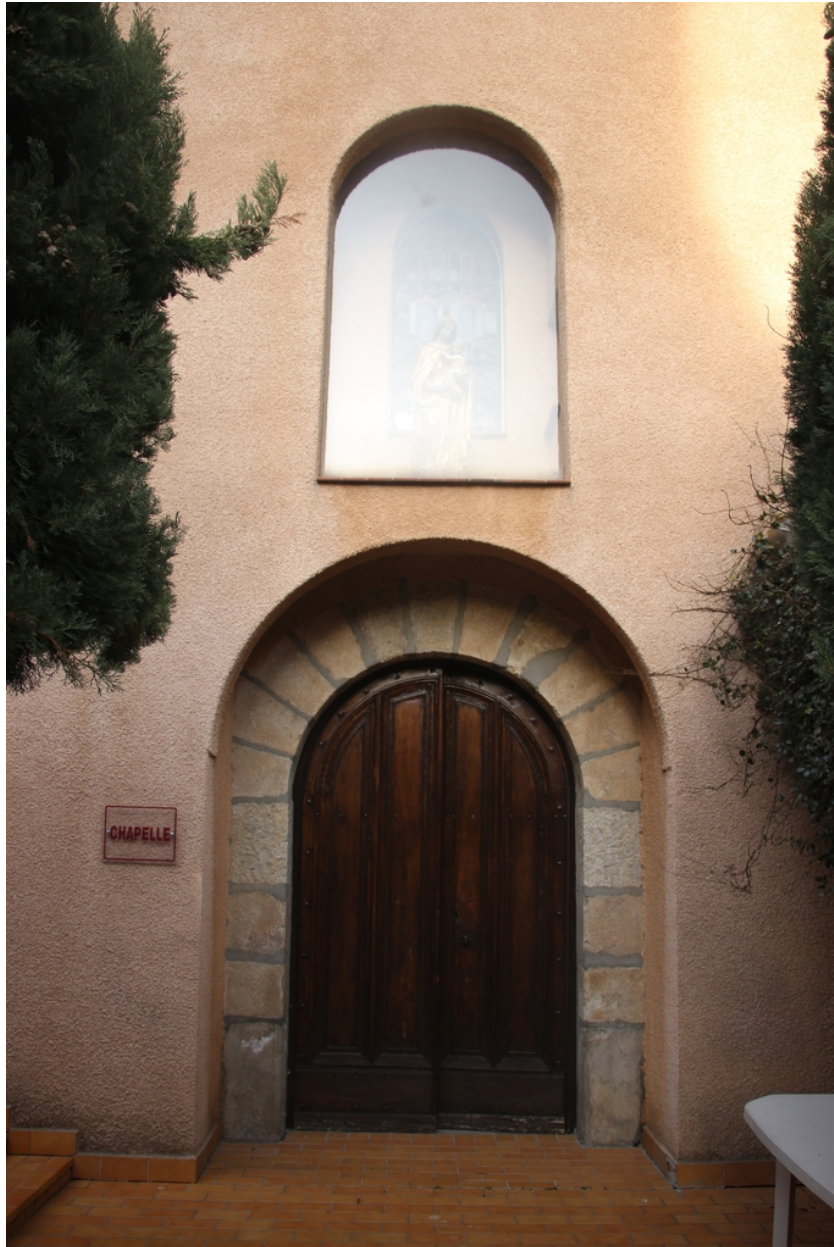
Hôpital-Hospice puis maison de retraite Guy Malé - Entrée principale de la chapelle surmontée d'une baie cintrée vitrée abritant une statue de la Sainte Vierge avec l'Enfant Jésus.
