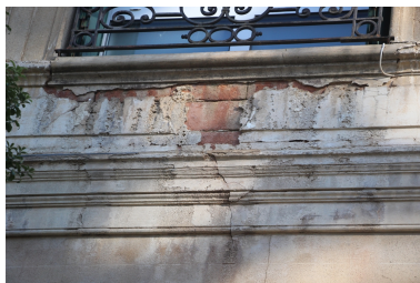
Château Pams puis Hôtel de ville - Détail de la maçonnerie en cayrous recouverts par un enduit. Phot. Léonie Deshayes IVR76_20226665448NUCA
