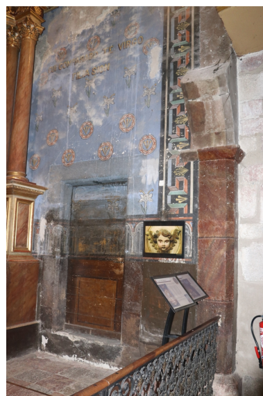
Église paroissiale Saint-Pierre - Peinture murale et départ d'un arc au niveau de la chapelle Saint-Sébastien. Phot. Léonie Deshayes IVR76_20226665504NUCA
