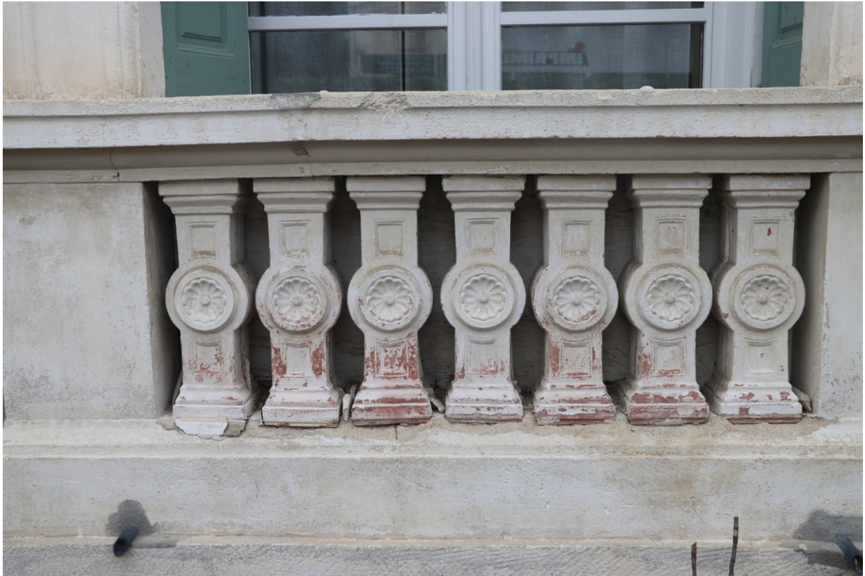
Sous-préfecture - Détail d'un garde-corps à balustres en terre cuite enduite en soubassement.
