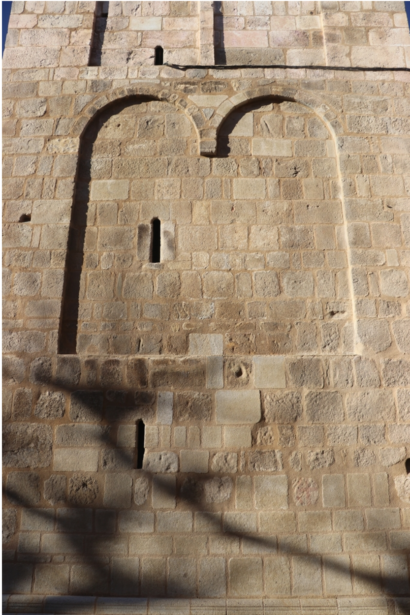
Église paroissiale Saint-Pierre - Arcatures aveugles et fenêtres d'archer en soubassement Sud du clocher-tour.
