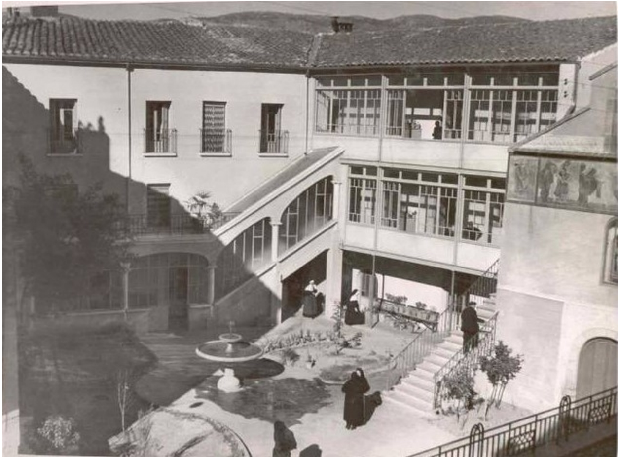
Hôpital-Hospice puis maison de retraite Guy Malé - Vue générale de l'établissement, photographie prise avant 1968.
