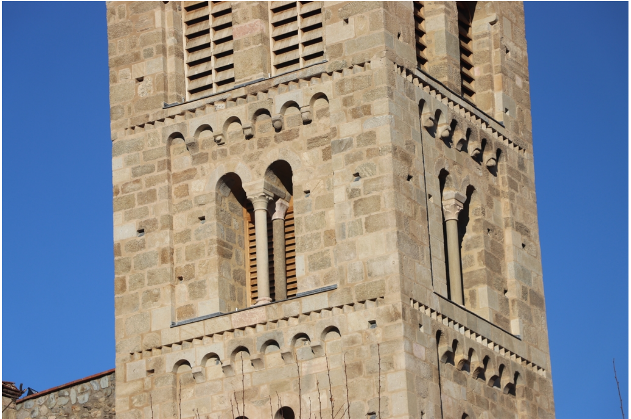
Église paroissiale Saint-Pierre - Niveau 3 du clocher-tour.
