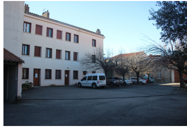
Presbytère 2° - Vue d'ensemble de la cour intérieure et bâtiment cadastré BA 35 en arrière-plan. Phot. Léonie Deshayes IVR76_20226665413NUCA
