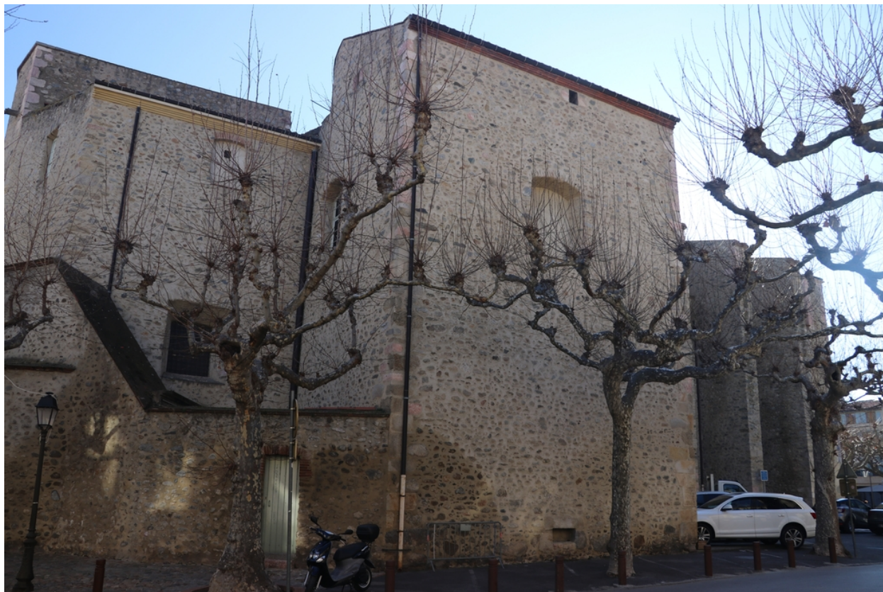
Église paroissiale Saint-Pierre - Vue d'ensemble Nord.
