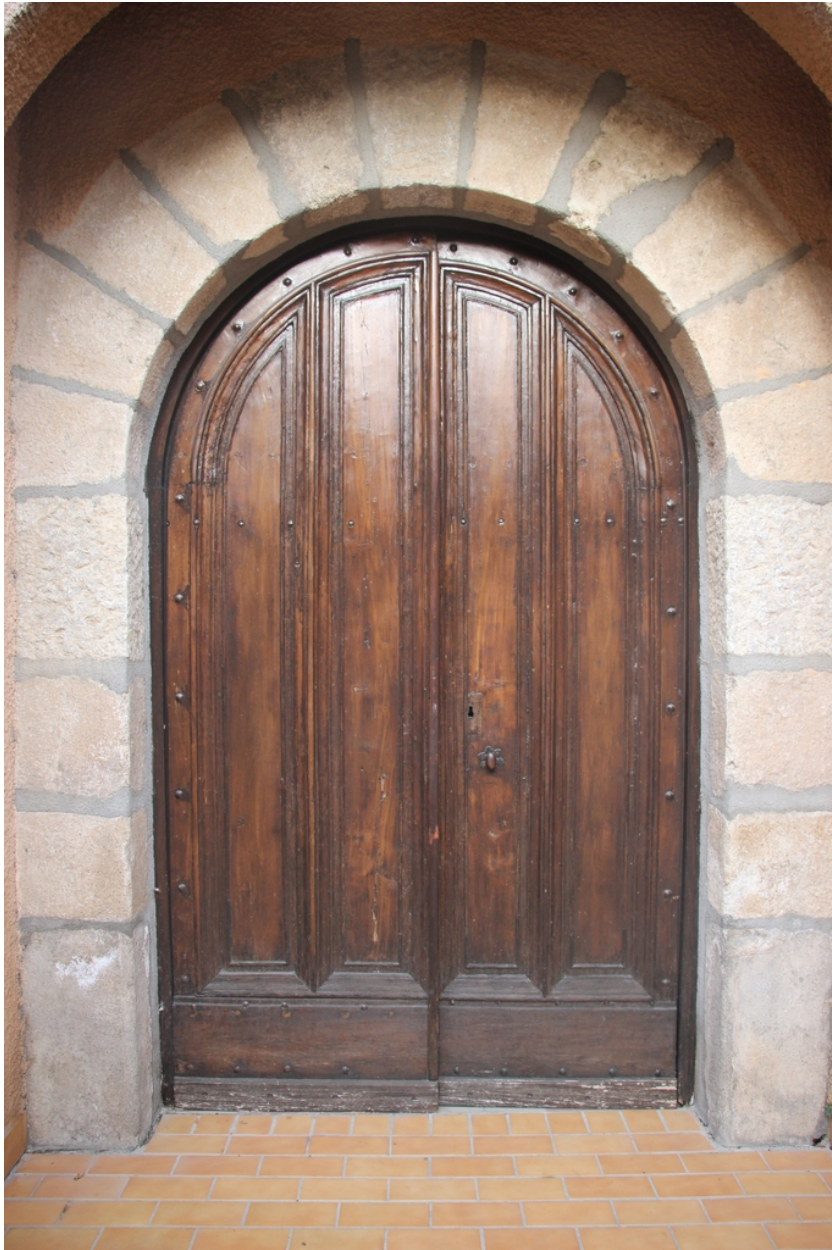
Hôpital-Hospice puis maison de retraite Guy Malé - Détail de la porte principale d'accès à la chapelle.
