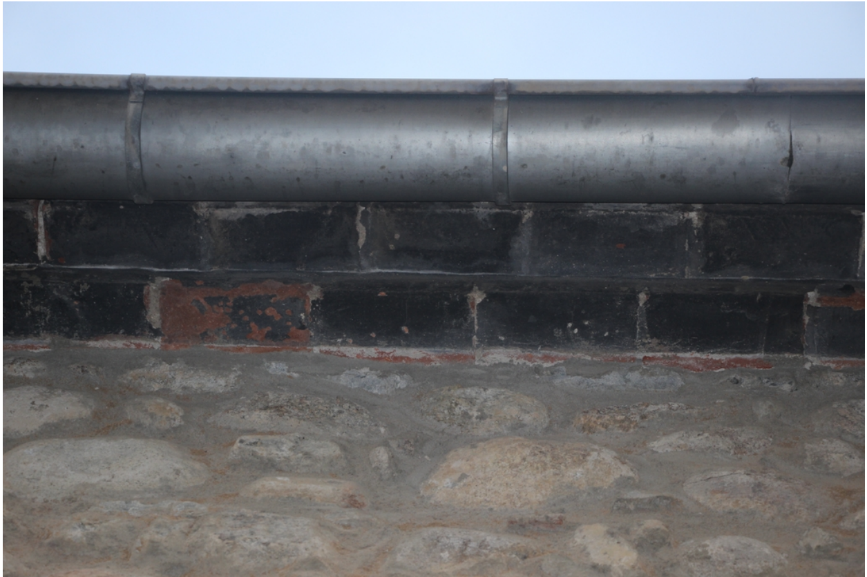
Presbytère 2° - Détail de la corniche en terre cuite peinte de la dépendance Ouest.
