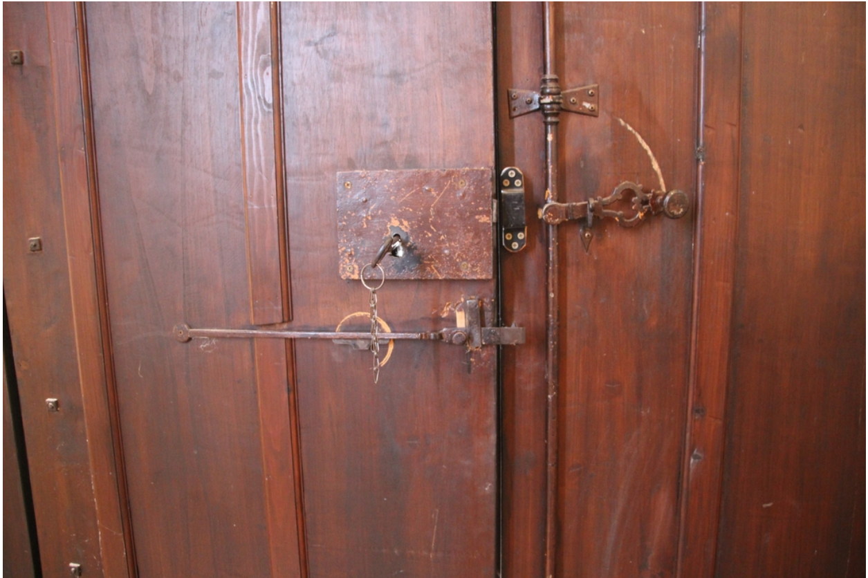
Hôpital-Hospice puis maison de retraite Guy Malé - Serrurerie intérieure de la porte principale d'accès à la chapelle.
