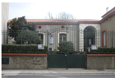
Sous-préfecture - Face Nord de l'extension orientale. Phot. Léonie Deshayes IVR76_20226665743NUCA
