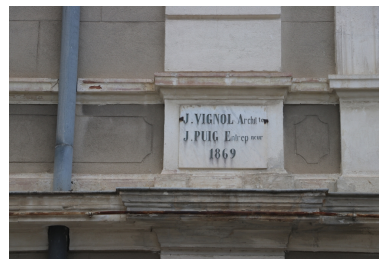
Sous-préfecture - Plaque en marbre mentionnant le nom des maîtres d'œuvre sur un piédroit au premier niveau de la façade Nord. Phot. Léonie Deshayes IVR76_20226665735NUCA
