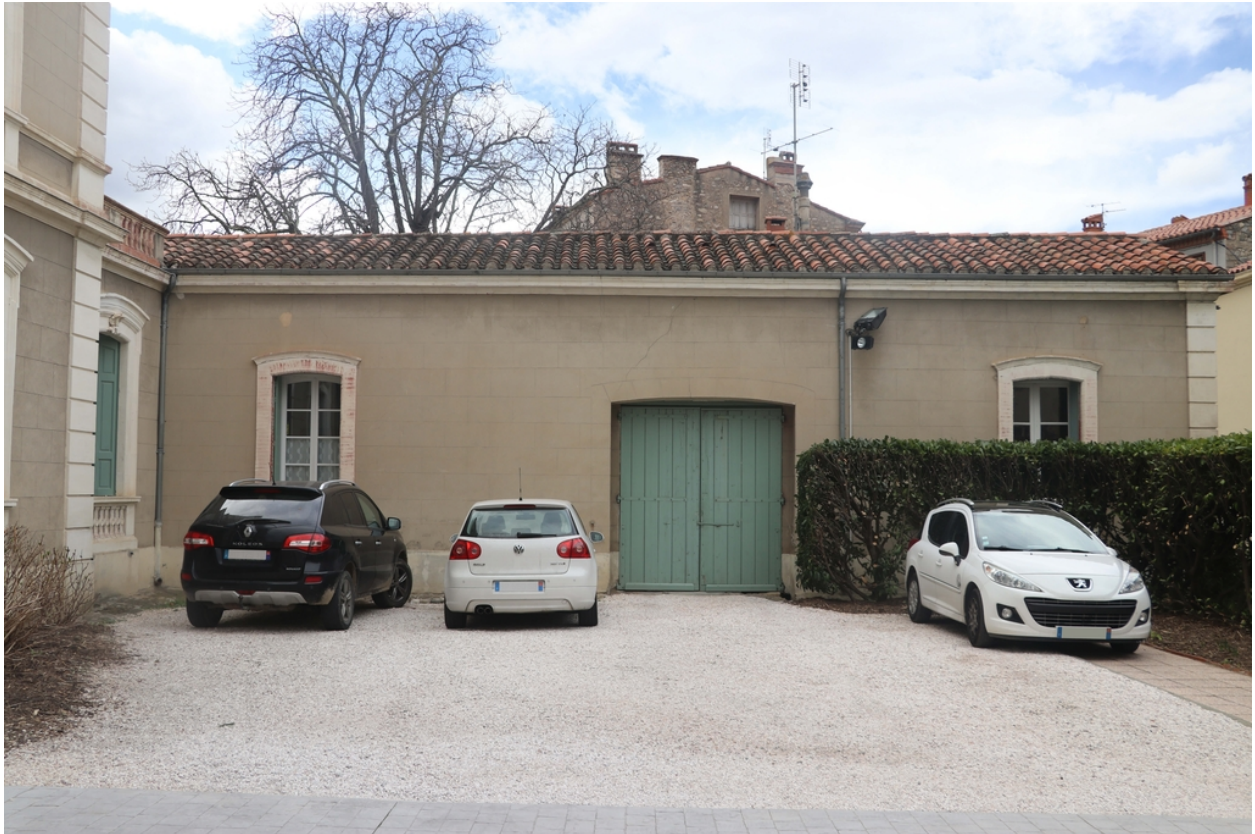
Sous-préfecture - Façade orientale du bâtiment latéral Ouest.
