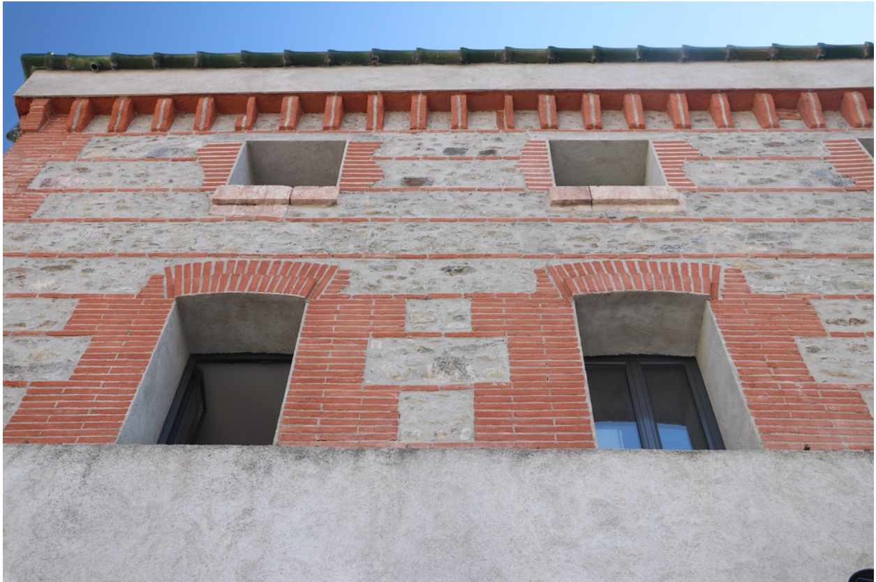
Prison puis Espace Martin Vivès - Détail de baies supérieures en façade Nord.
