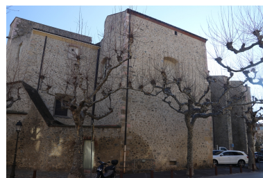
Église paroissiale Saint- Pierre - Vue d'ensemble Nord. Phot. Léonie Deshayes IVR76_20226665486NUCA
