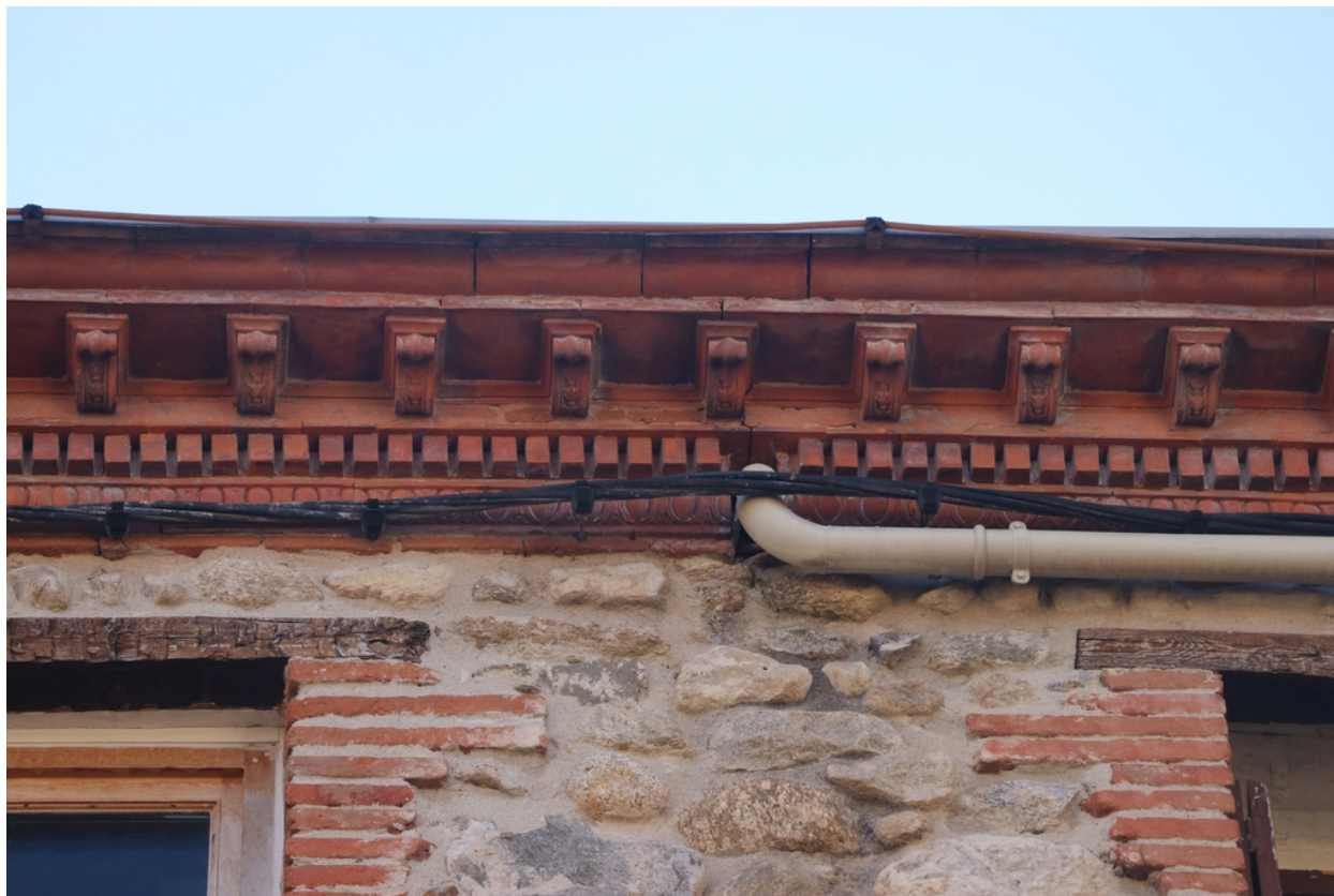
Chapelle Notre-Dame-du-Rosaire puis Halle et Mairie - Corniche décorative en terre cuite, façade Nord.
