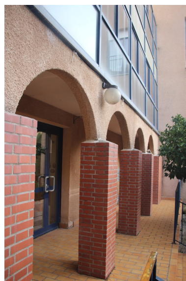
Hôpital-Hospice puis maison de retraite Guy Malé - Galerie intérieure Ouest. Phot. Léonie Deshayes IVR76_20226665394NUCA
