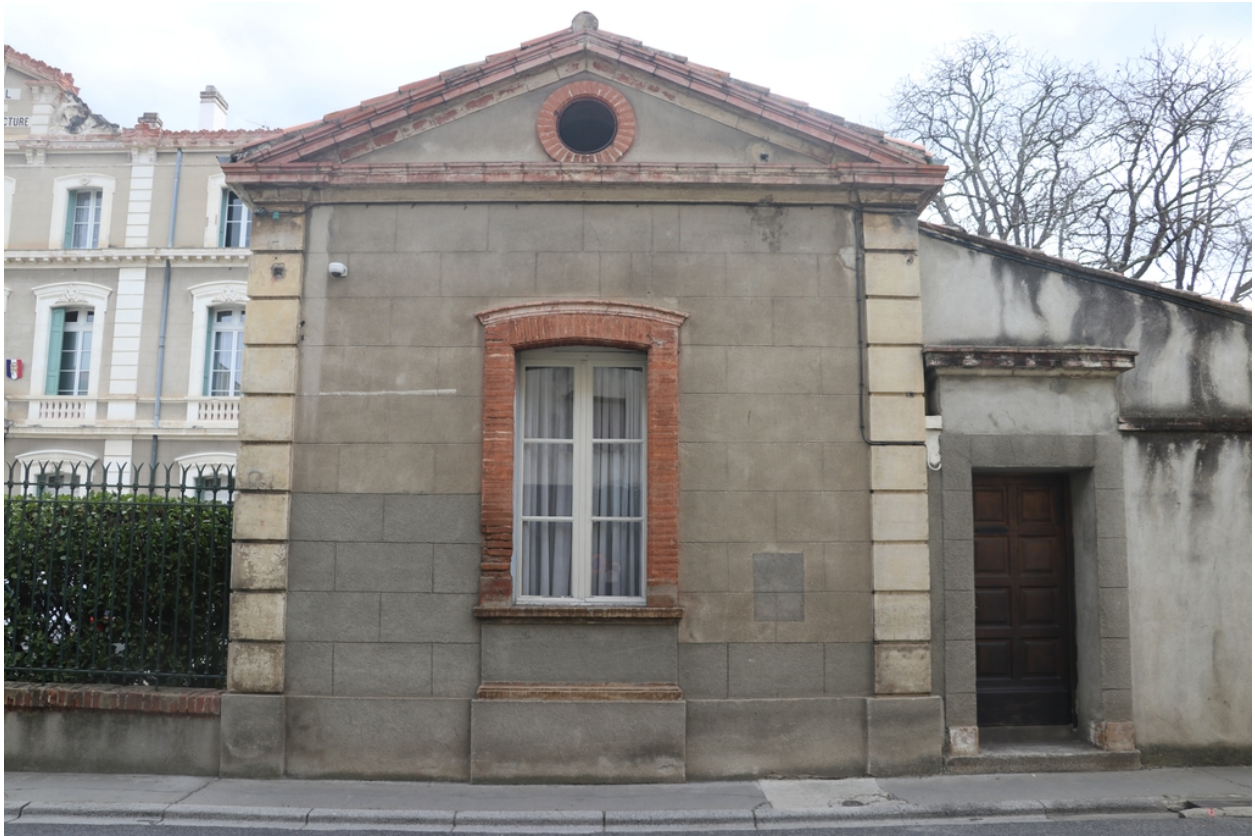
Sous-préfecture - Face Nord du pavillon latéral Ouest.
