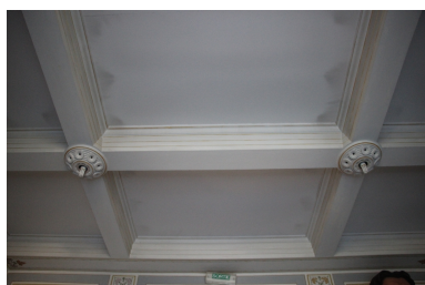
Château Pams puis Hôtel de ville - Plafond à caissons du vestibule. Phot. Léonie Deshayes IVR76_20226665459NUCA
