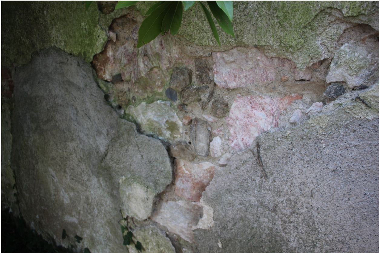
Château Pams puis Hôtel de ville - Détail de la maçonnerie des dépendances.
