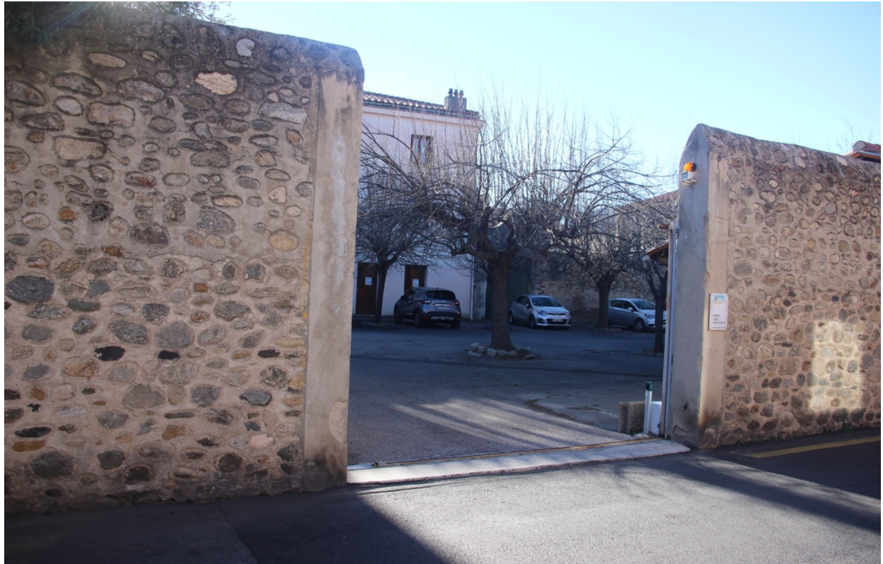
Presbytère 2° - Portail coulissant sur rue de l'Agriculture.
