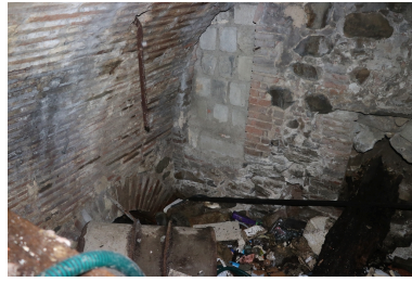
Ancien moulin à huile du sieur Tixedor, puis chocolaterie, puis usine électrique - Axe horizontal et barre de transmission conservés dans la chambre hydraulique du moulin à huile 2). Phot. Léonie Deshayes IVR76_20216665056NUCA
