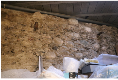
Ancien martinet à cuivre du sieur Comte et actuelle habitation n°5 bis rue Saint-Martin - Sous-sol avec maçonnerie intérieure et éléments en fer forgé. Phot. Léonie Deshayes IVR76_20216665019NUCA
