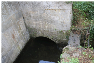
Canal Union - Décharge vers le fleuve Têt. Phot. Léonie Deshayes IVR76_20216665001NUCA
