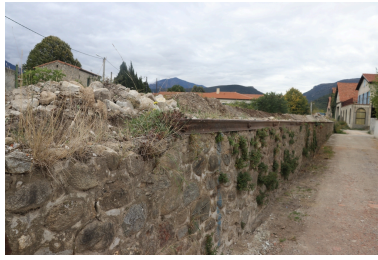
Site industriel de Gibraltar - Mur de soutènement du quai de chargement utilisé par l'ancienne usine Chefdebien. Phot. Léonie Deshayes IVR76_20216665146NUCA
