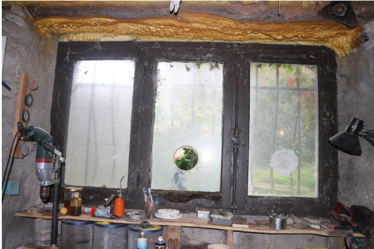
Moulin à farine Neuf puis Bès - Ancienne porte à cadre en bois redécoupée en fenêtre située dans la cave.
