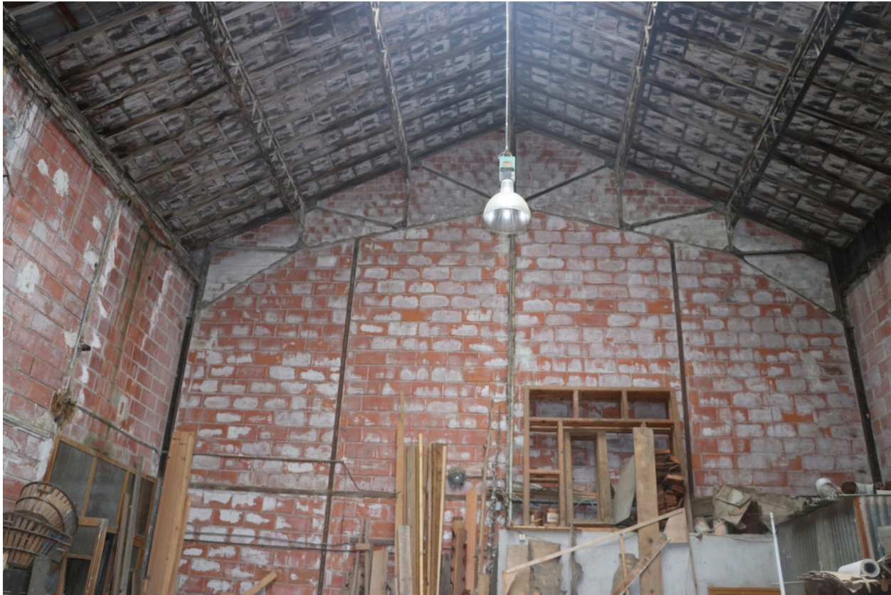
Site industriel de Gibraltar - Structure de charpente au premier niveau d'un bâtiment industriel de l'usine Chefdebien.
