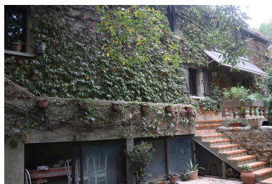
Moulin à farine Neuf puis Bès - Partie latérale droite de la façade Sud. Phot. Léonie Deshayes IVR76_20216665109NUCA
