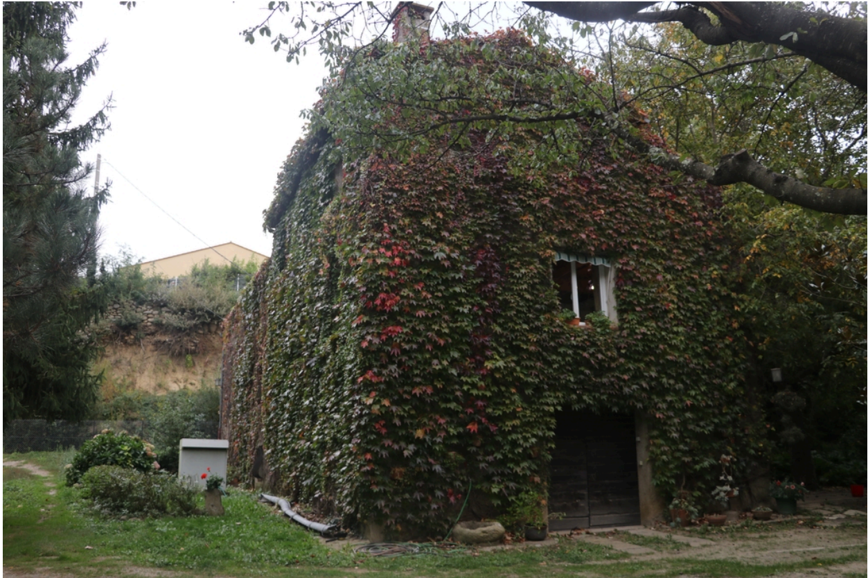
Moulin à farine Neuf puis Bès - Angle Nord-Ouest.
