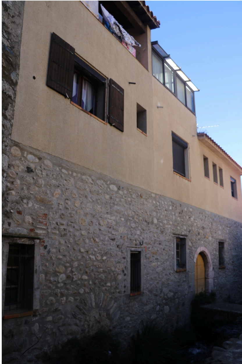
Ancien moulin à huile du sieur Tixedor, puis chocolaterie, puis usine électrique - Vue Est.
