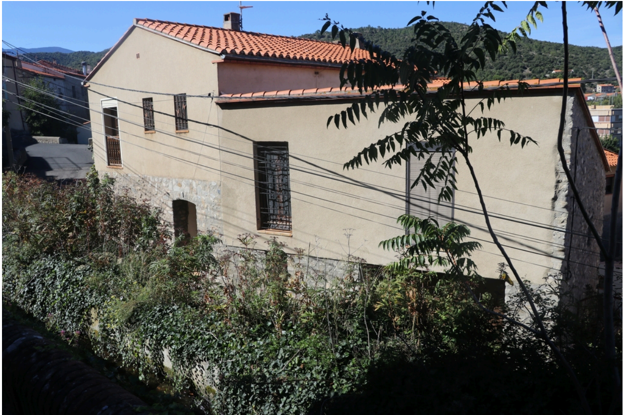
Moulin à farine communal - Façade Sud.
