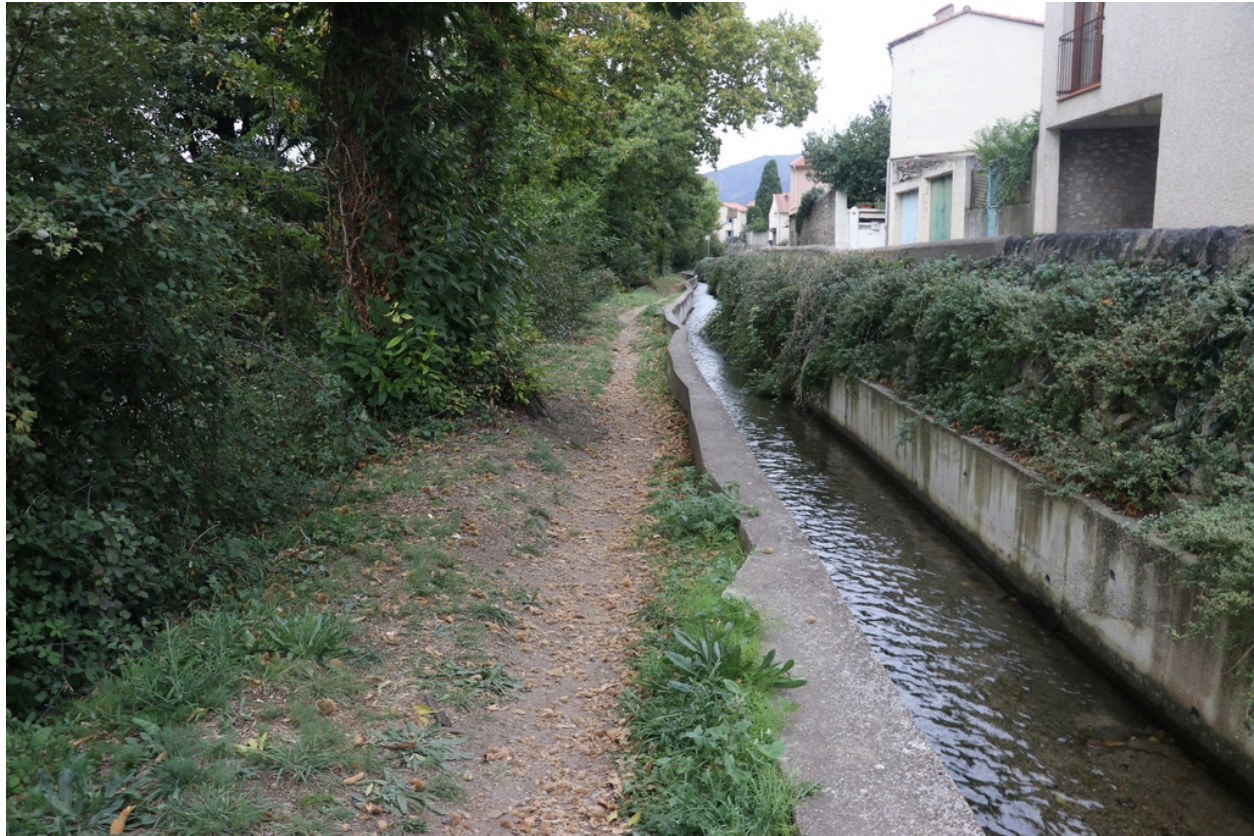
Canal Union - Franc-bord aménagé 2).
