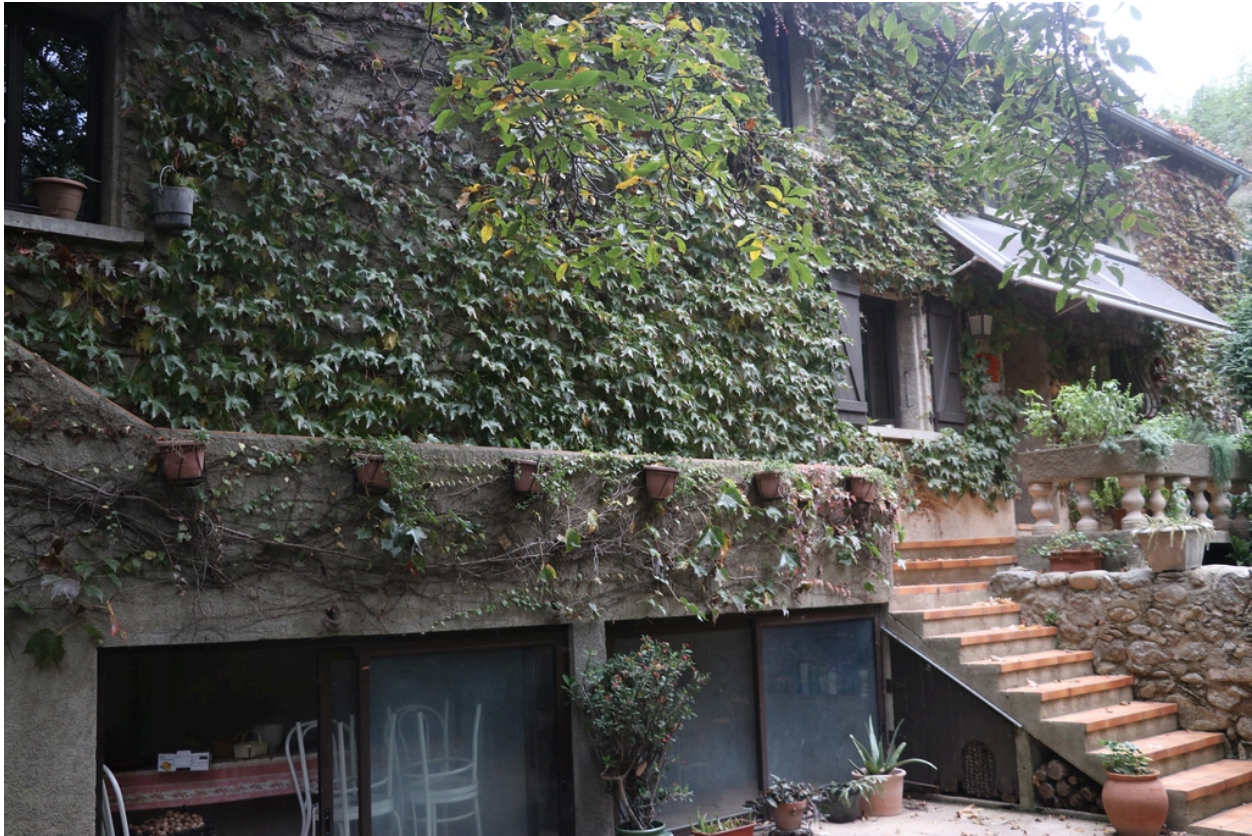
Moulin à farine Neuf puis Bès - Partie latérale droite de la façade Sud.
