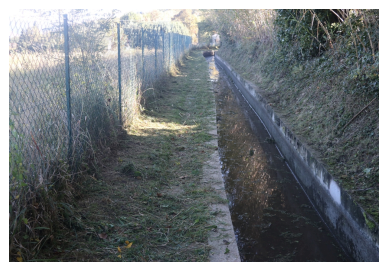
Canal de Dalt - Branche nouvelle. Phot. Léonie Deshayes IVR76_20216661979NUCA
