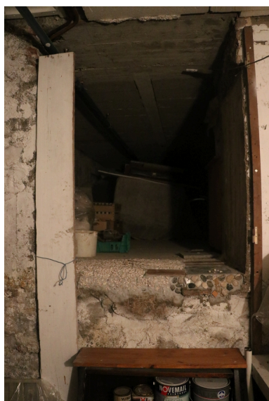
Moulin à farine communal - Accès intérieur à la cave située en sous-sol.
