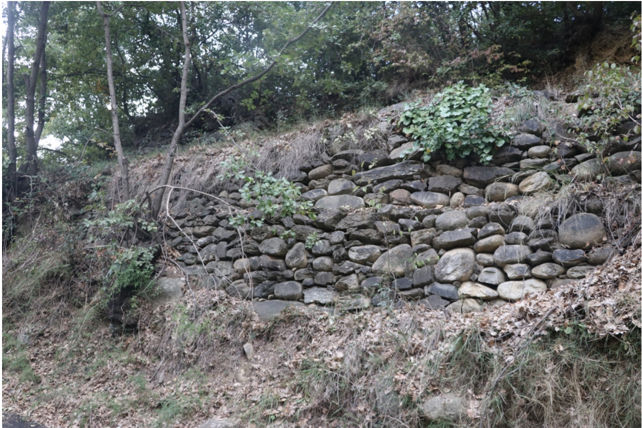
Canal de Canoha - Mur de soutènement inférieur.
