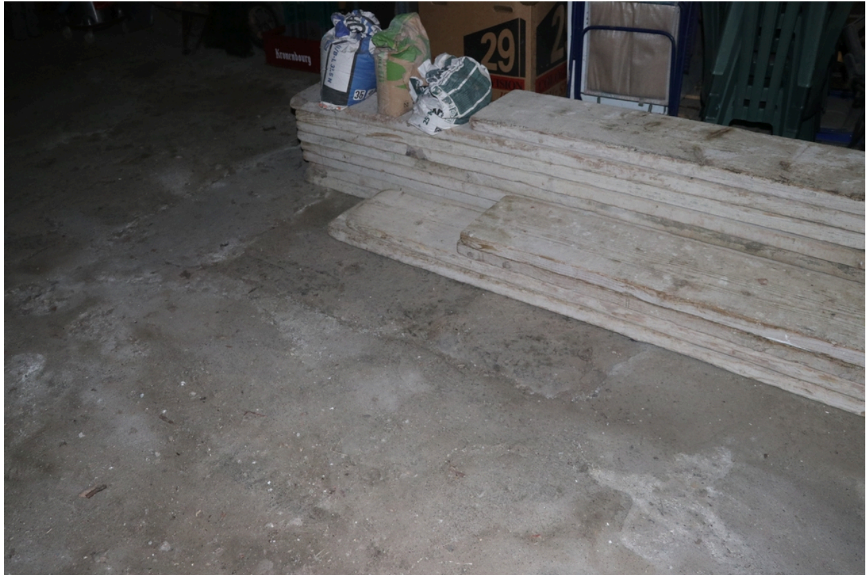
Site industriel de Gibraltar - Emprunte de socle à maintien d'une turbine à l'intérieur du bâtiment à chaudière.
