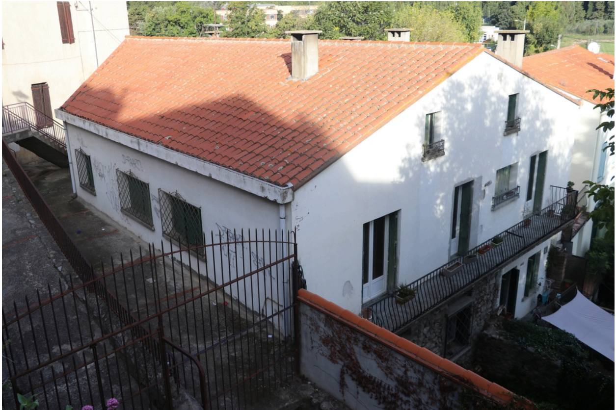
Moulin à huile de Jean Boher, puis martinet, puis usine, puis forge - Vue Sud-Est.
