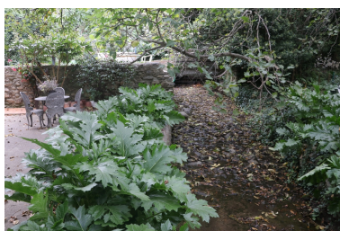
Moulin à farine Neuf puis Bès - Canal d'amenée. Phot. Léonie Deshayes IVR76_20216665122NUCA
