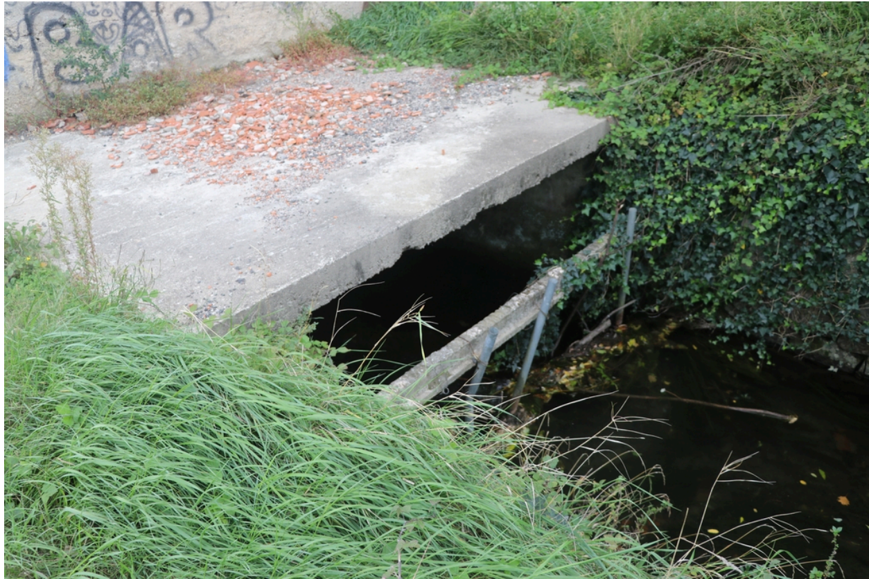
Canal Eus Marquixanes - Galerie sous bâtiment industriel du site de Gibraltar (AE 137).
