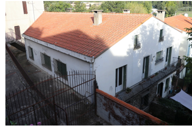
Moulin à huile de Jean Boher, puis martinet, puis usine, puis forge - Vue Sud-Est. Phot. Léonie Deshayes IVR76_20216665066NUCA
