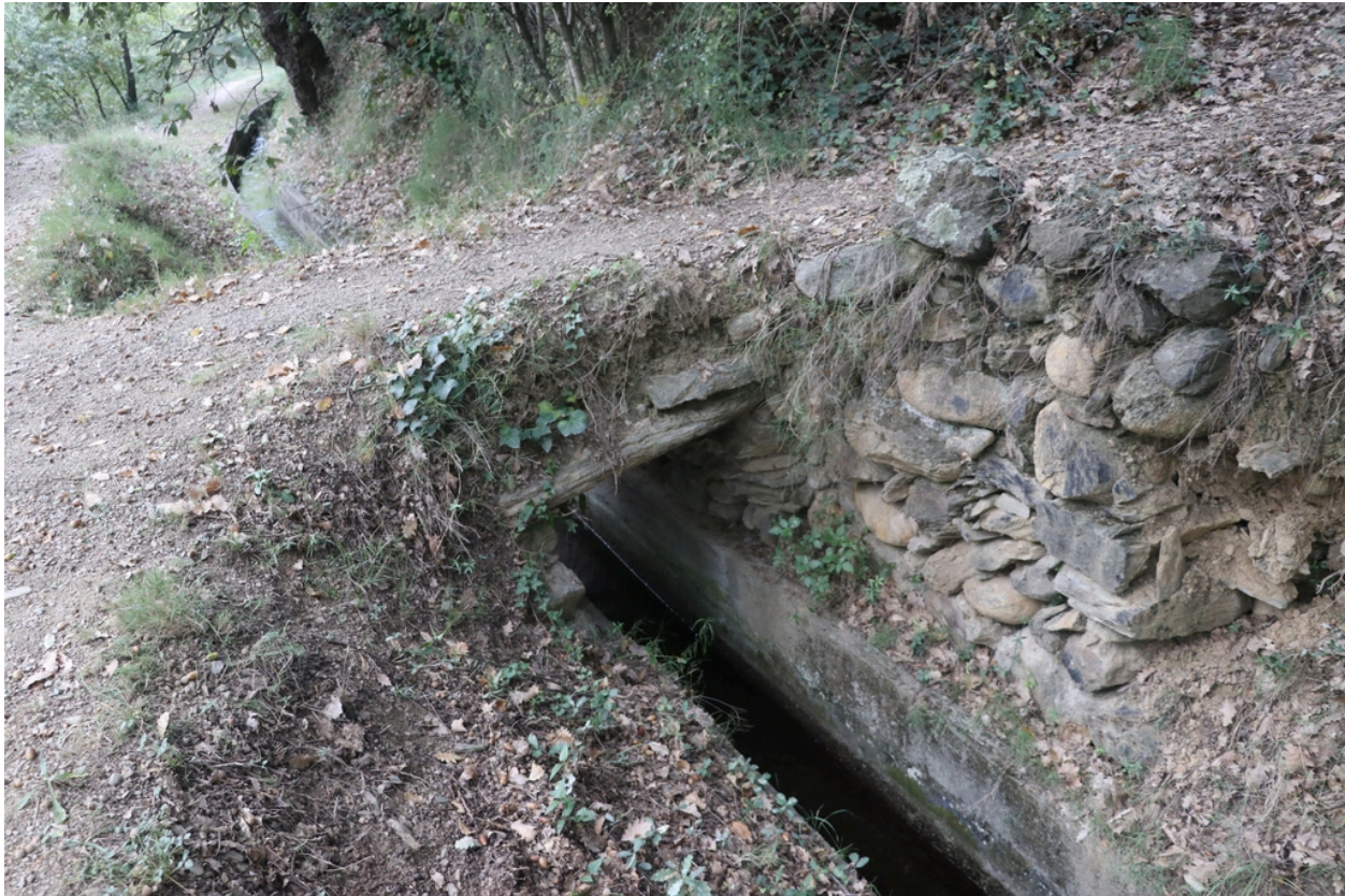
Canal de Canoha - Ponceau 1.
