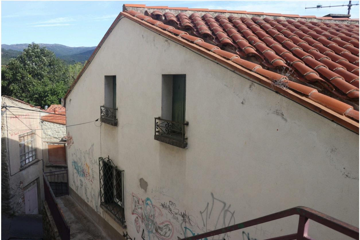
Moulin à huile de Jean Boher, puis martinet, puis usine, puis forge - Façade Ouest.
