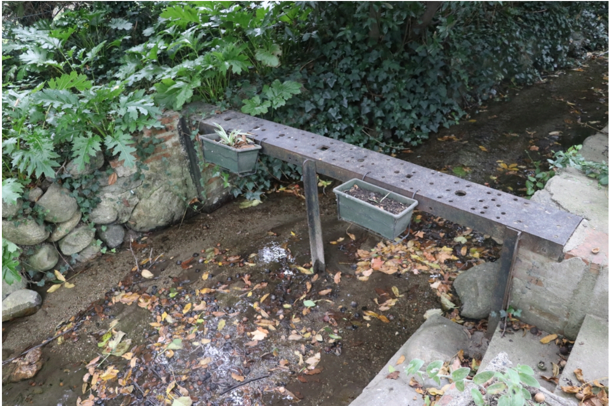
Moulin à farine Neuf puis Bès - Vanne martelière sur le canal Eus Marquixanes.
