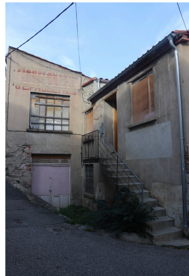
Moulin à huile de la dame Romeu, puis manufacture de textile - Vue d'ensemble des enduits sculptés au n°11 rue Saint-Martin. Phot. Léonie Deshayes IVR76_20216665078NUCA
