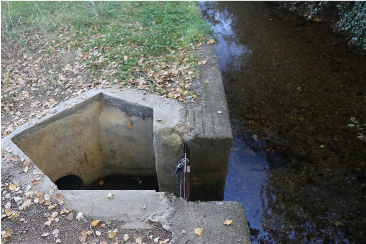
Canal de Bohère - Branche secondaire dite de Las Fourques.
