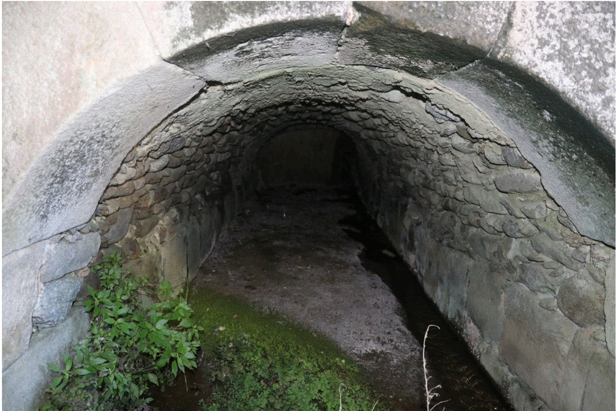
Moulin à farine communal - Chambre hydraulique avec maçonnerie apparente.
