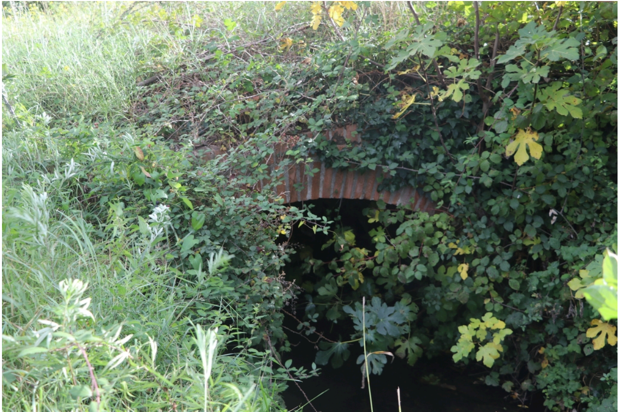
Canal Eus Marquixanes - Ponceau.
