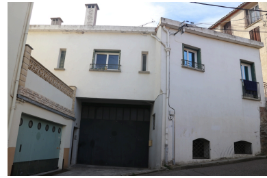
Moulin à huile de Jean Boher, puis martinet, puis usine, puis forge - Façade Nord. Phot. Léonie Deshayes IVR76_20216665069NUCA
