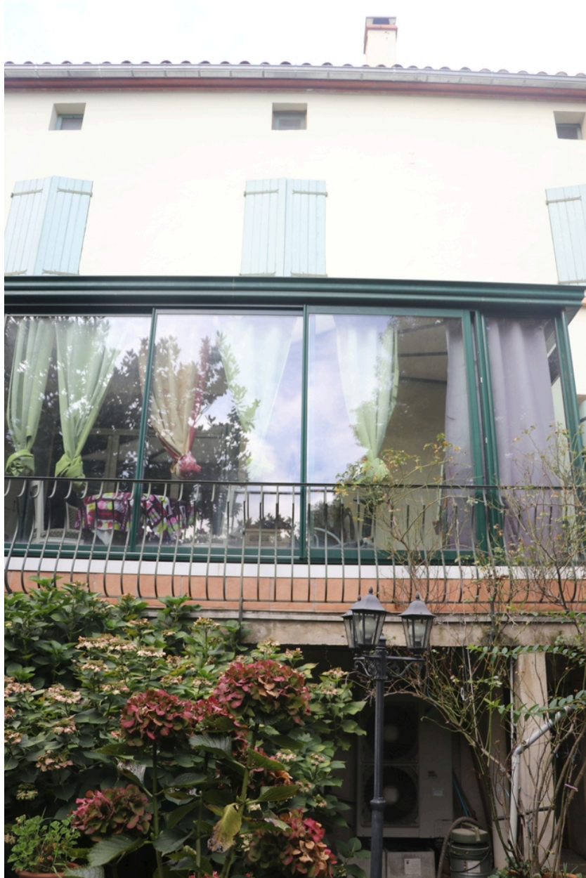
Usine Illes - Façade Est sur jardin arrière.
