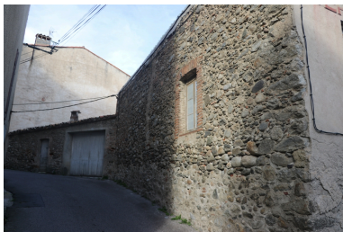
Moulin à huile de la dame Romeu, puis manufacture de textile - Façade Sud correspondant au n°11bis rue Saint-Martin. Phot. Léonie Deshayes IVR76_20216665076NUCA
