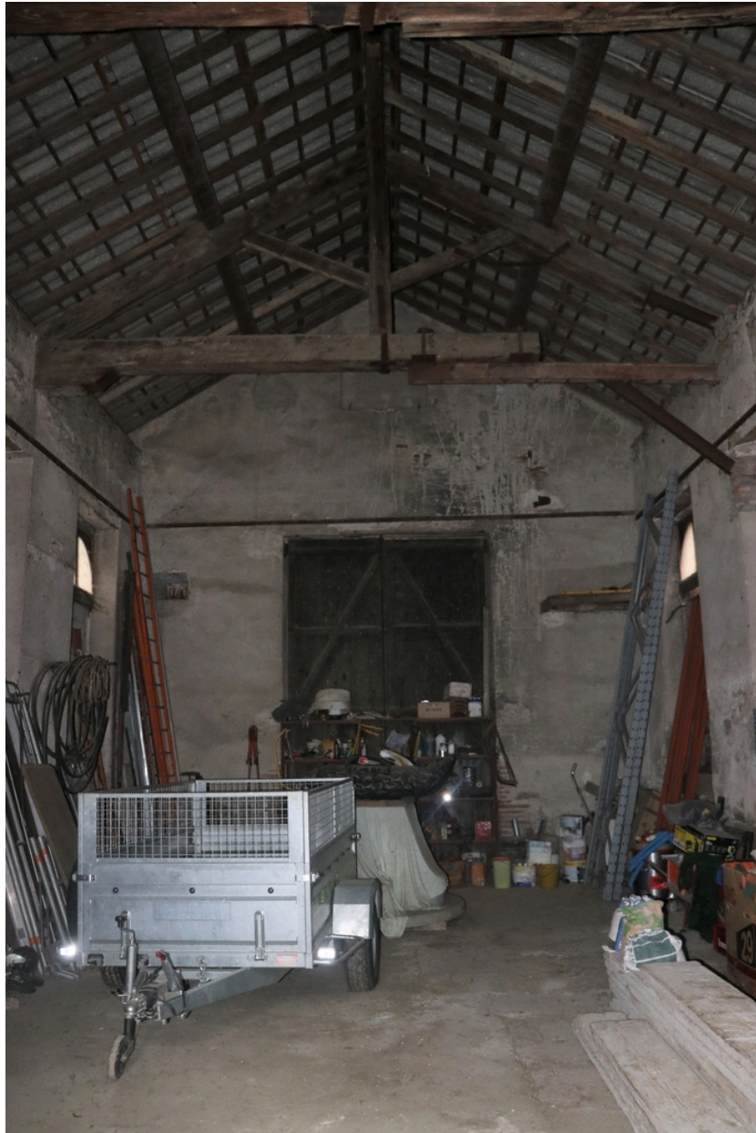
Site industriel de Gibraltar - Intérieur du bâtiment à chaudière et turbines.
