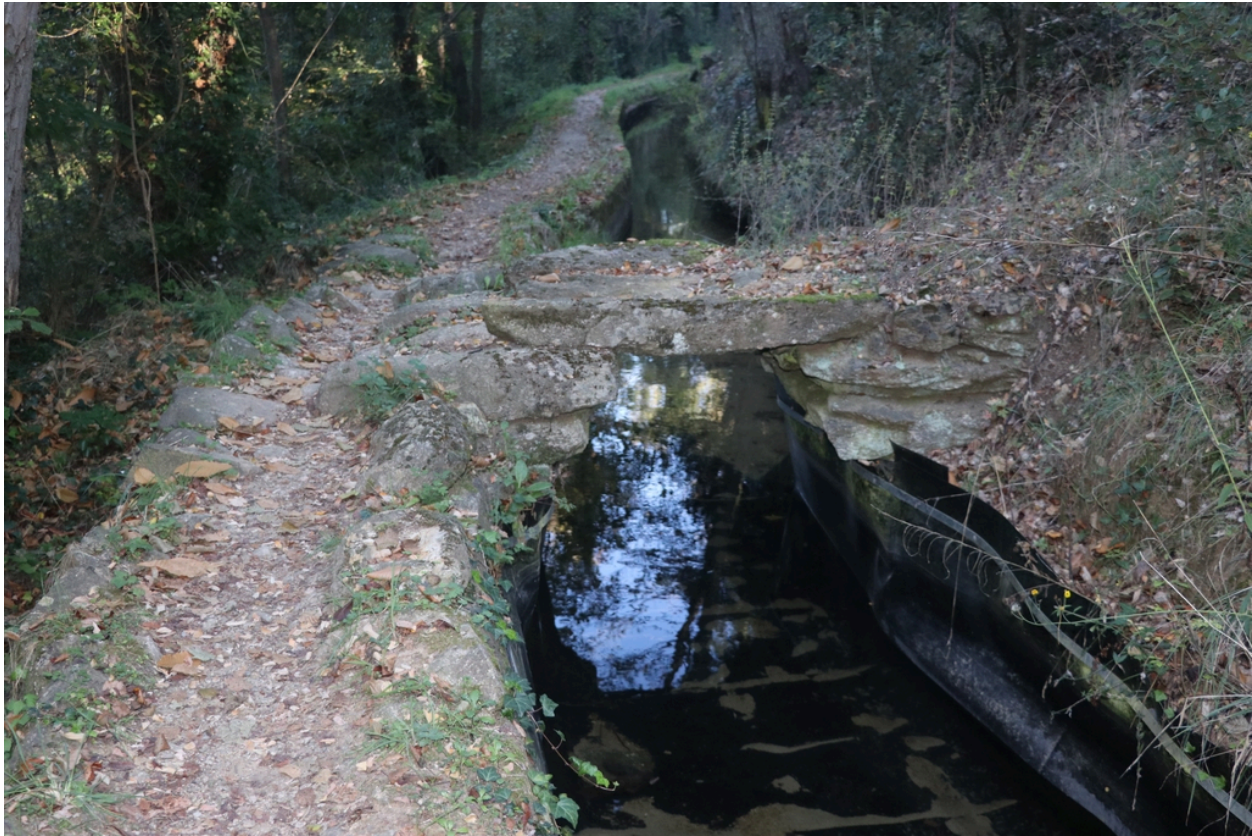
Canal de Bohère - Ponceau 3.
