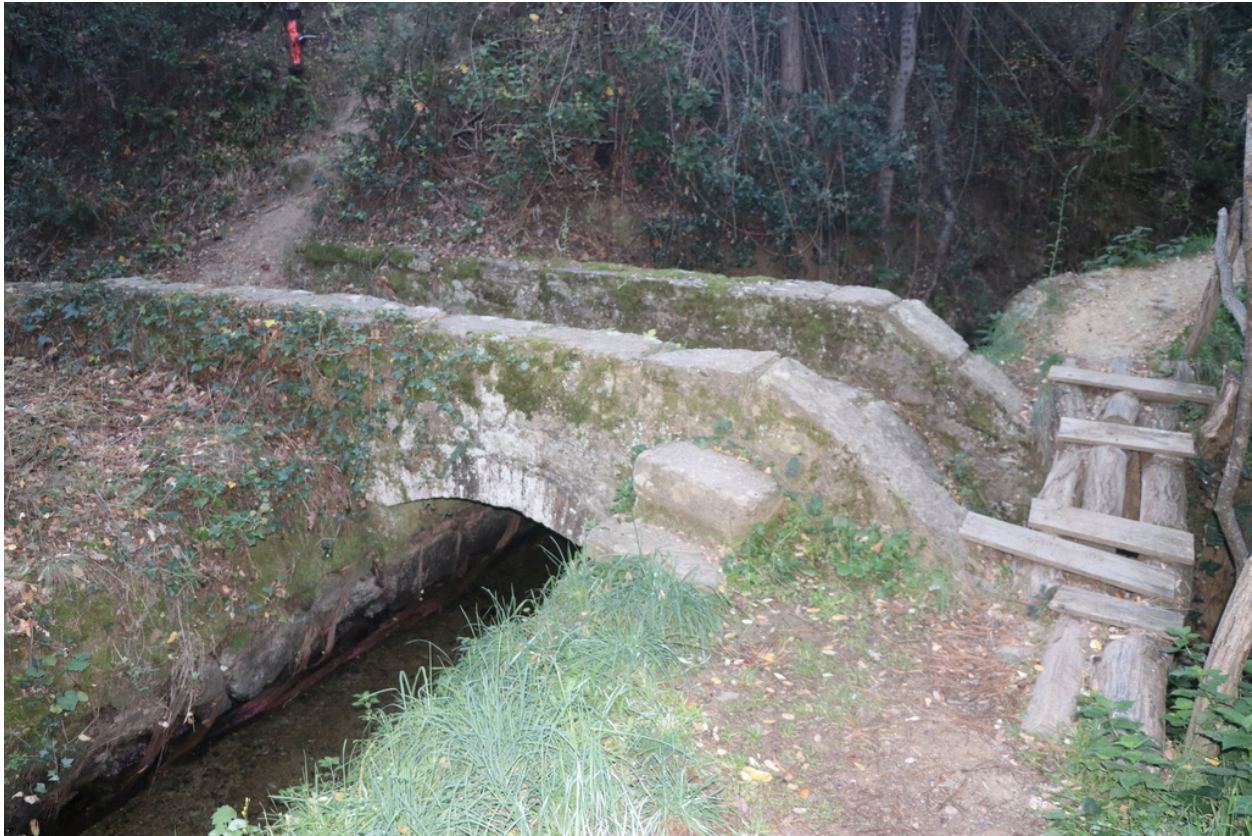
Canal de Bohère - Ponceau 2.
