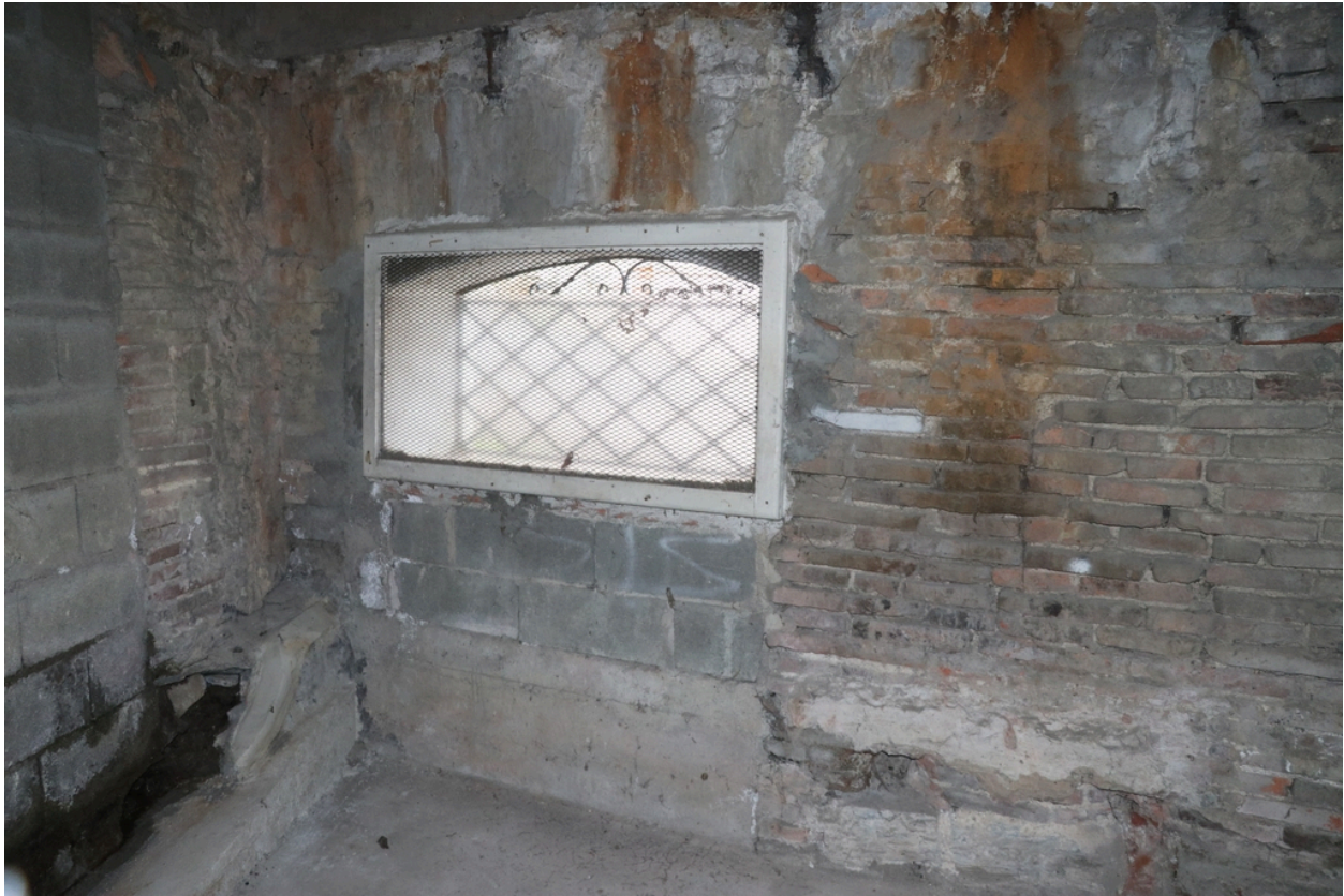
Moulin à huile de Jean Boher, puis martinet, puis usine, puis forge - Ouverture remaniée en soubassement 2).
