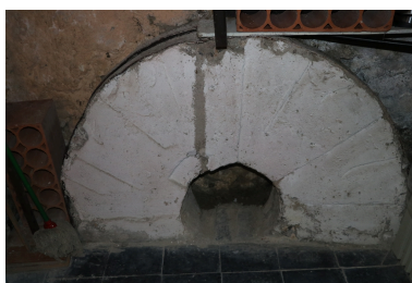
Moulin à farine communal - Meule en granit conservée au sous-sol.
