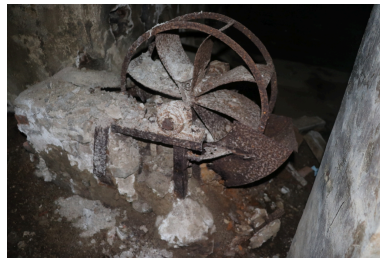
Ancien moulin à huile du sieur Tixedor, puis chocolaterie, puis usine électrique - Turbine conservée en sous-sol. Phot. Léonie Deshayes IVR76_20216665059NUCA
