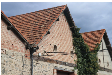
Site industriel de Gibraltar - Détail de la couverture en tuiles mécaniques des bâtiments anciennement utilisés pour la fabrication de la poudre Chefdebien. Phot. Léonie Deshayes IVR76_20216665151NUCA
