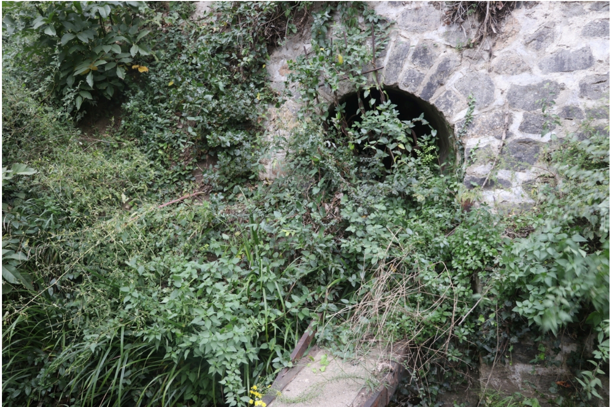
Moulin à farine Neuf puis Bès - Mur de soutènement Est avec voûte en plein cintre.
