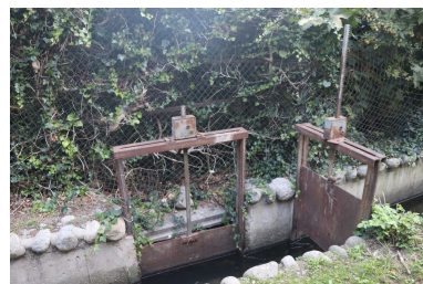
Canal Rec de Baix - Décharge vers canal Eus Marquixanes. Phot. Léonie Deshayes IVR76_20216665008NUCA
