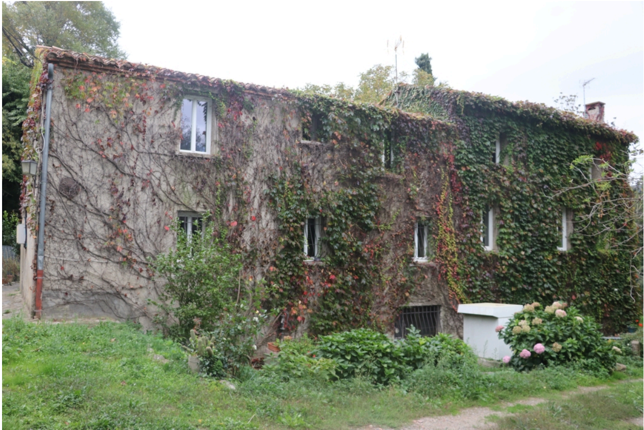
Moulin à farine Neuf puis Bès - Façades Nord.
