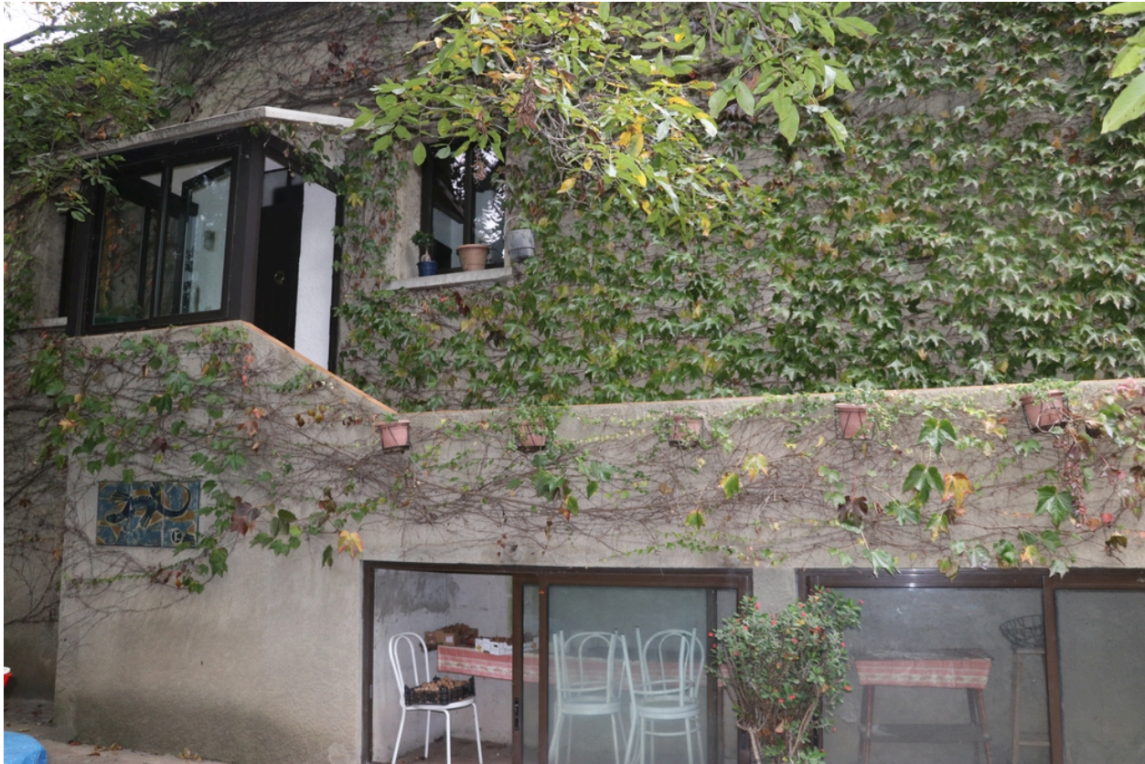
Moulin à farine Neuf puis Bès - Partie latérale gauche de la façade Sud.
