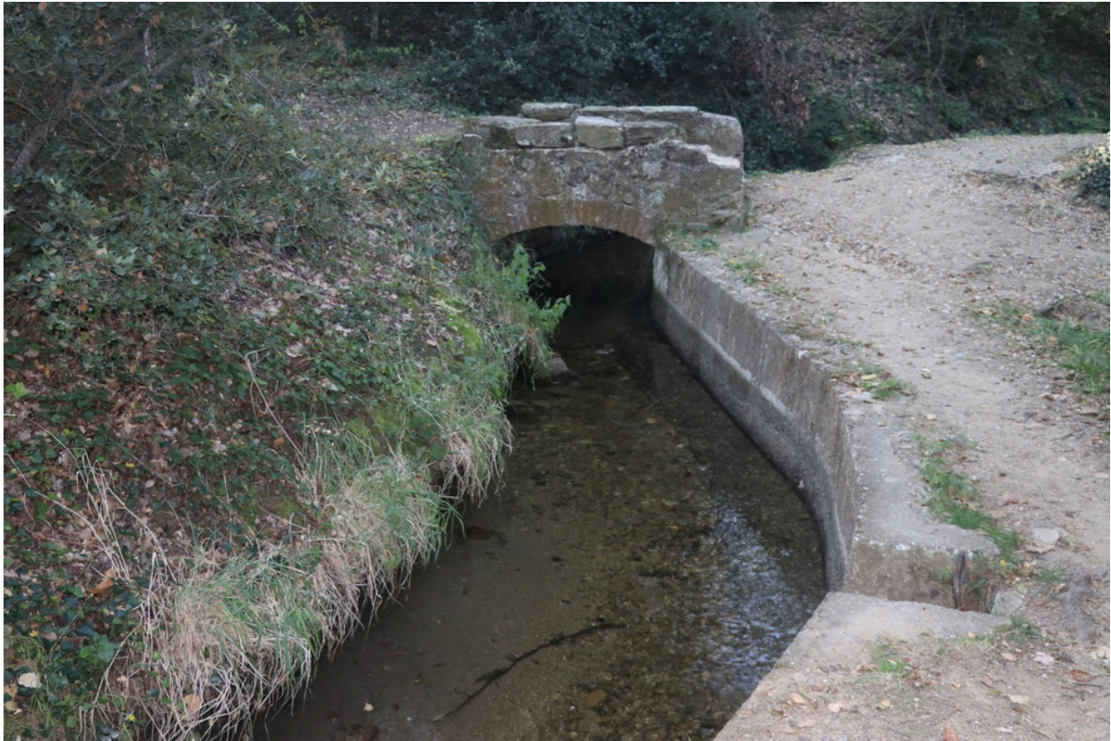
Canal de Bohère - Ponceau 6 (b).
