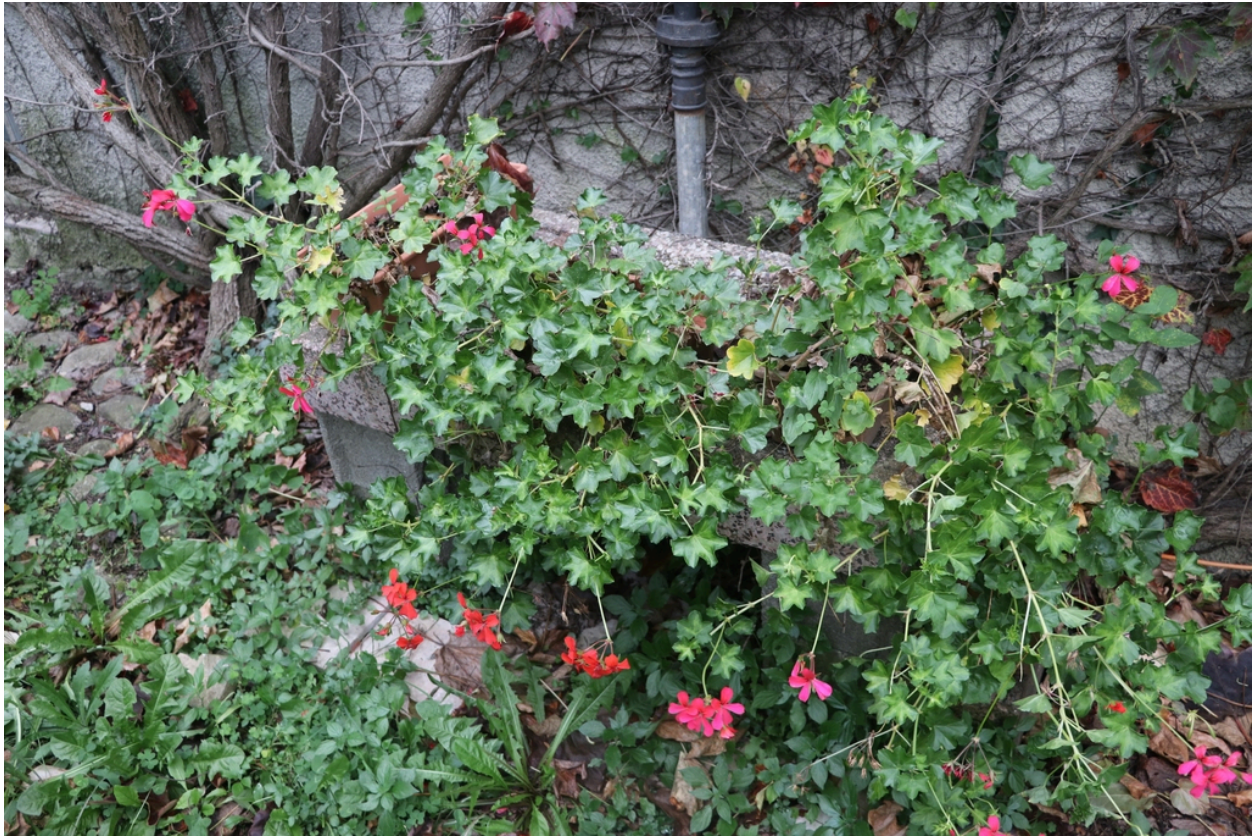
Moulin à farine Neuf puis Bès - Évier maçonné en granulats contre le soubassement Nord.
