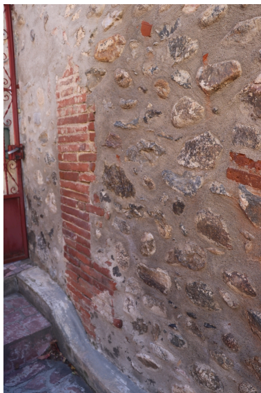
Moulin à farine communal - Piédroit en cayrou conservé de l'accès Est colmaté postérieurement. Phot. Léonie Deshayes IVR76_20216665026NUCA
