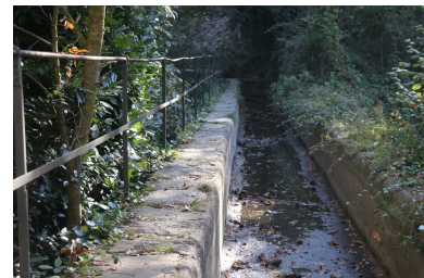
Canal de Dalt - Pont-canal du ravin de la Basse (Branche ancienne). Phot. Léonie Deshayes IVR76_20216661973NUCA
