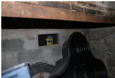
Usine Illes - Cheminée industriel en sous-sol. Phot. Léonie Deshayes IVR76_20216665091NUCA
