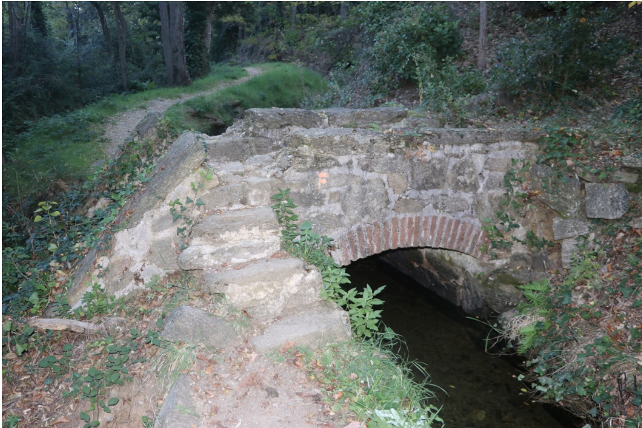
Canal de Bohère - Ponceau 4 (a).
