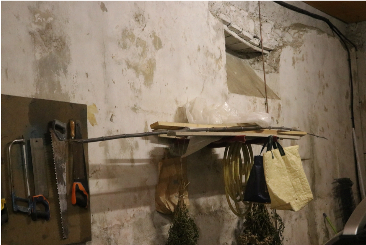
Ancien martinet à cuivre du sieur Comte et actuelle habitation n°5 bis rue Saint-Martin - ouverture inclinée en sous-sol.
