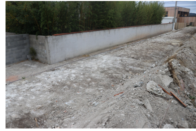
Site industriel de Gibraltar - Ancienne voie A de l'usine Chefdebien. Phot. Léonie Deshayes IVR76_20216665147NUCA
