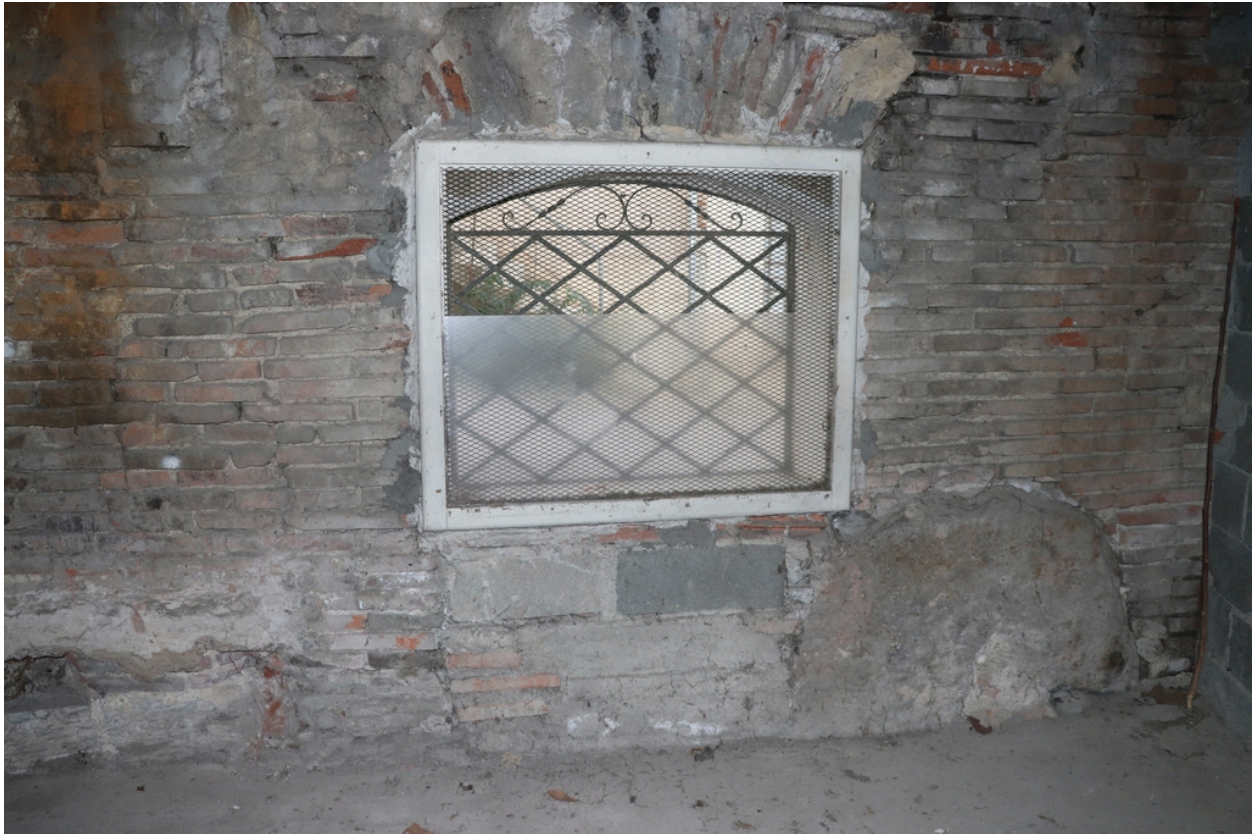
Moulin à huile de Jean Boher, puis martinet, puis usine, puis forge - Ouverture remaniée en soubassement 1).
