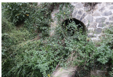
Moulin à farine Neuf puis Bès - Mur de soutènement Est avec voûte en plein cintre. Phot. Léonie Deshayes IVR76_20216665119NUCA
