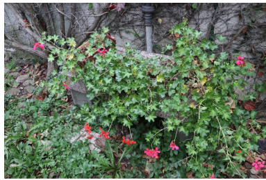
Moulin à farine Neuf puis Bès - - Évier maçonné en granulats contre le soubassement Nord. Phot. Léonie Deshayes IVR76_20216665127NUCA
