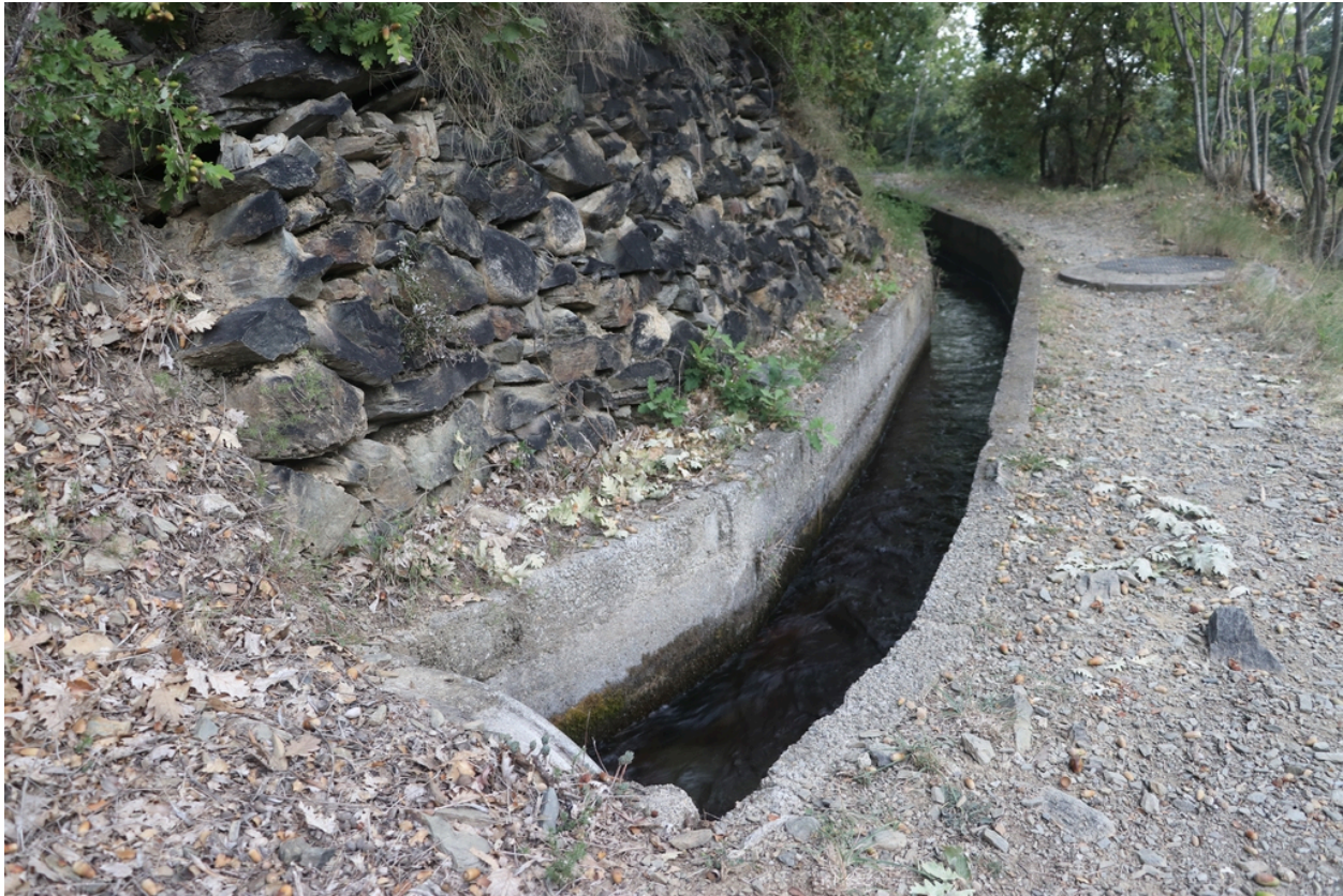
Canal de Canoha - Mur de soutènement supérieur.
