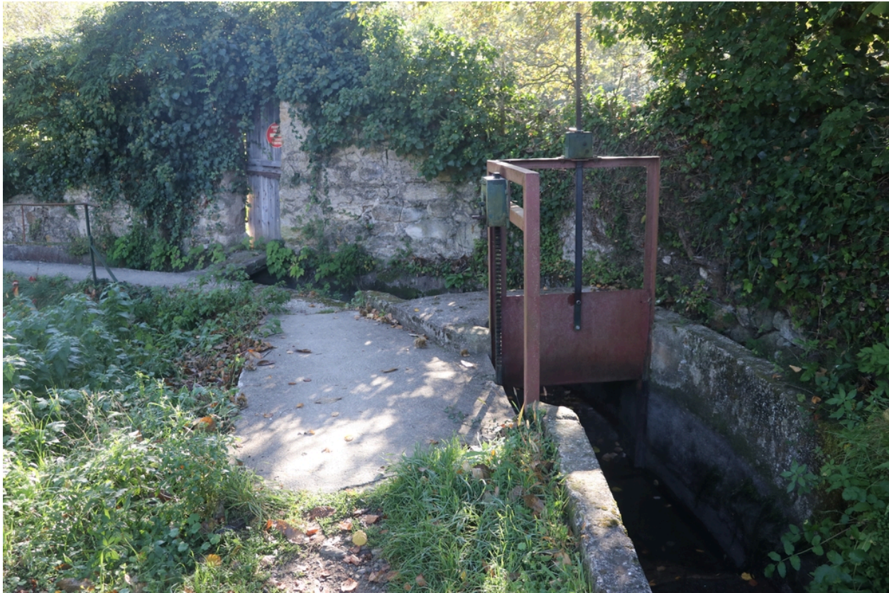
Canal de Dalt - Décharge ravin de la Calmeille (Branche ancienne).
