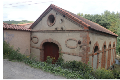
Site industriel de Gibraltar - Vue Sud-Est du bâtiment à chaudière et turbines. Phot. Léonie Deshayes IVR76_20216665138NUCA
