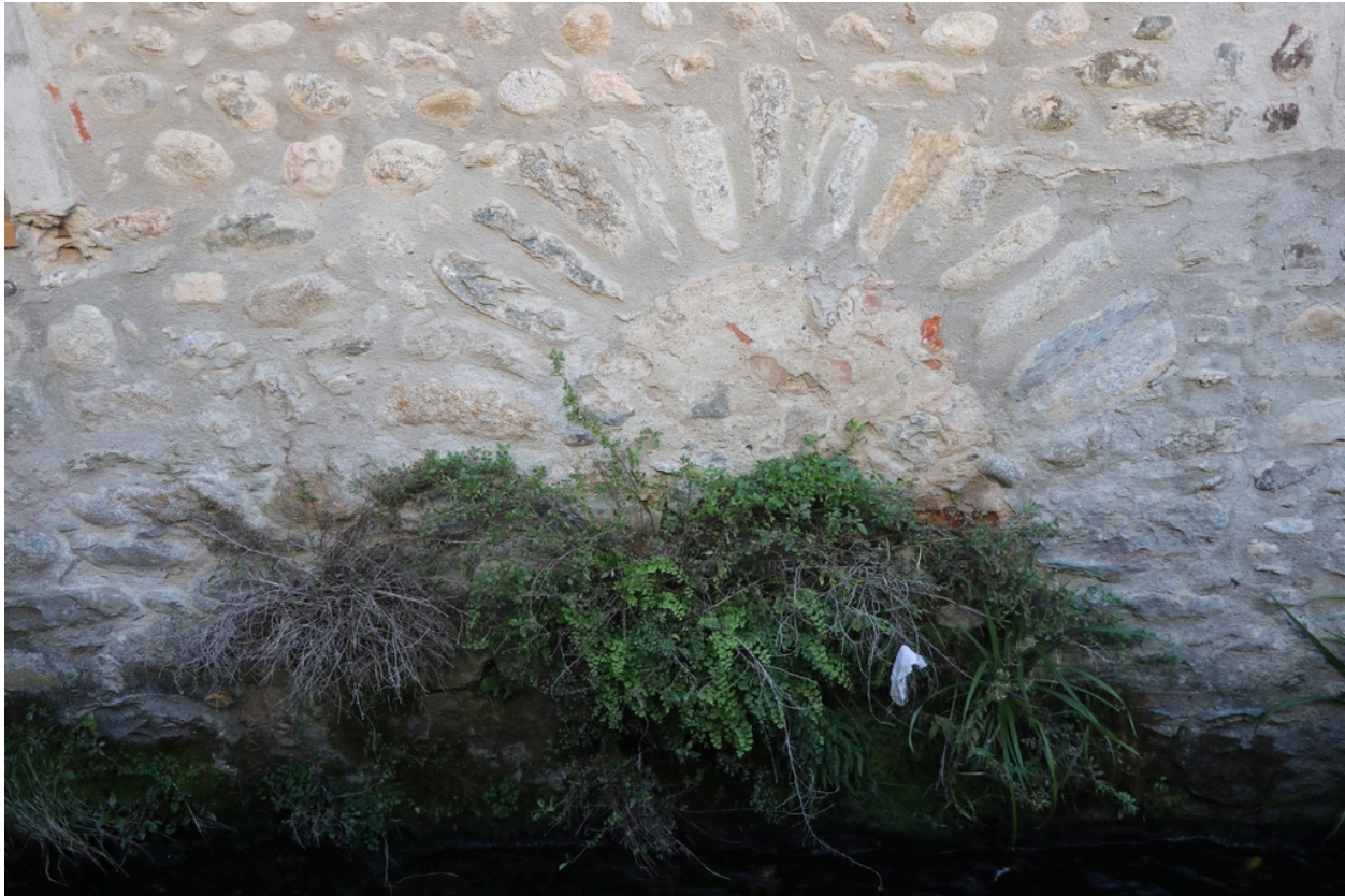
Moulin à farine communal - Voûte en plein cintre bouchée en soubassement Est.
