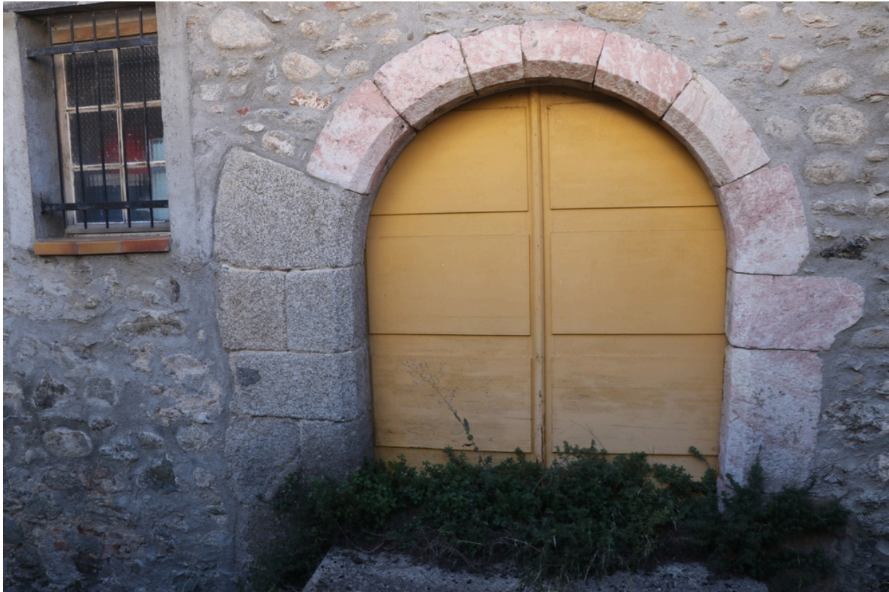
Ancien moulin à huile du sieur Tixedor, puis chocolaterie, puis usine électrique - Portail Est d'accès au moulin à huile.
