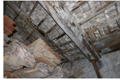
Site industriel de Gibraltar - Détail de charpente de couverture, bâtiment industriel de l'usine Chefdebien. Phot. Léonie Deshayes IVR76_20216665162NUCA
