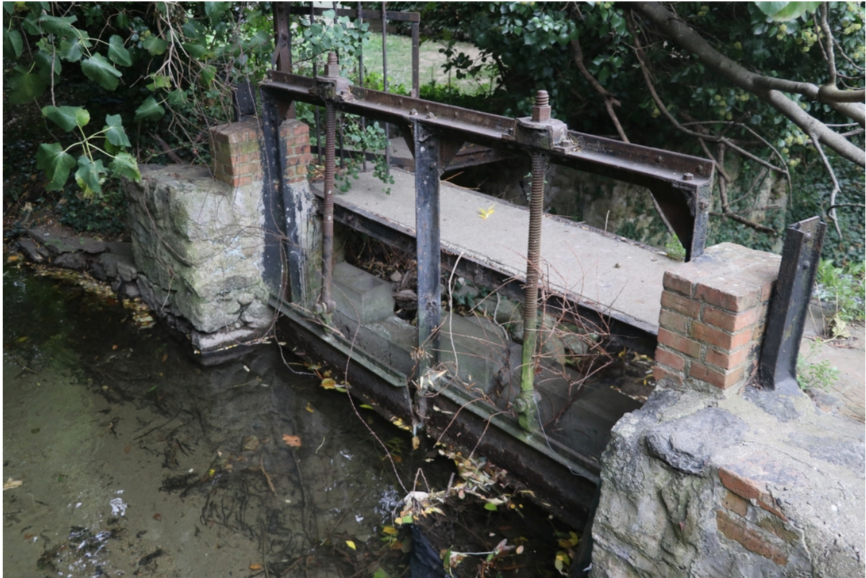
Moulin à farine Neuf puis Bès - Vanne de décharge vers le canal d'amenée du moulin.
