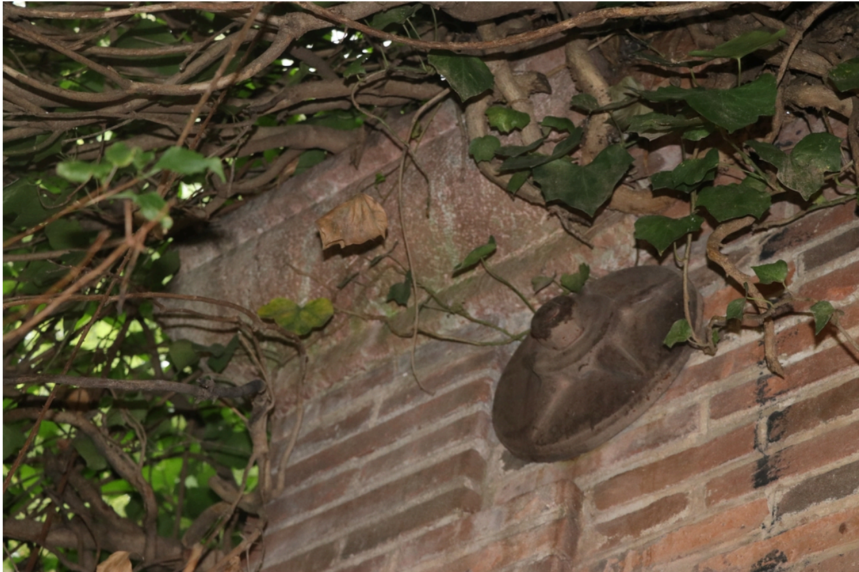
Site industriel de Gibraltar - Détail d'une croix de chaînage sur la cheminée.
