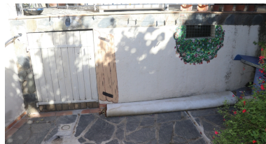
Moulin à farine communal - Accès Ouest du sous-sol. Phot. Léonie Deshayes IVR76_20216665035NUCA
