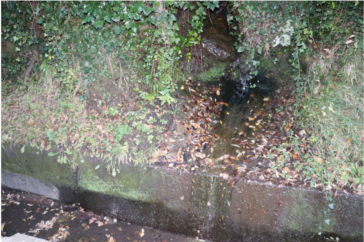
Canal de Dalt - Alimentation de la Branche ancienne par une eau de source.
