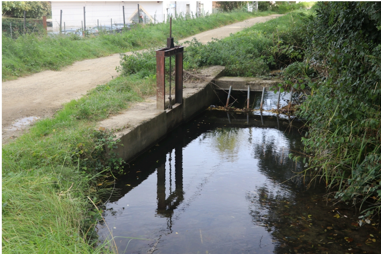
Canal Eus Marquixanes - Décharge vers la Têt.
