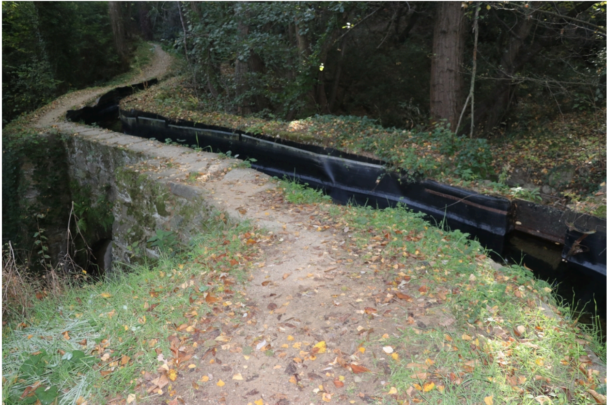
Canal de Bohère - Décharge dite de la Basse.
