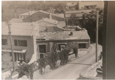
Photographie du moulin à farine communal - Vue Ouest - Vers 1981-1982. Phot. COLOM, Autr. Léonie Deshayes IVR76_20216665020NUCA
