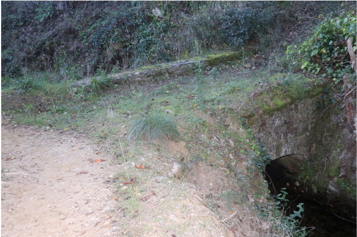
Canal de Bohère - Ponceau 1 (a).
