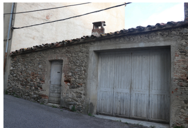
Moulin à huile de la dame Romeu, puis manufacture de textile - Façade Sud correspondant au n°11 rue Saint-Martin. Phot. Léonie Deshayes IVR76_20216665077NUCA
