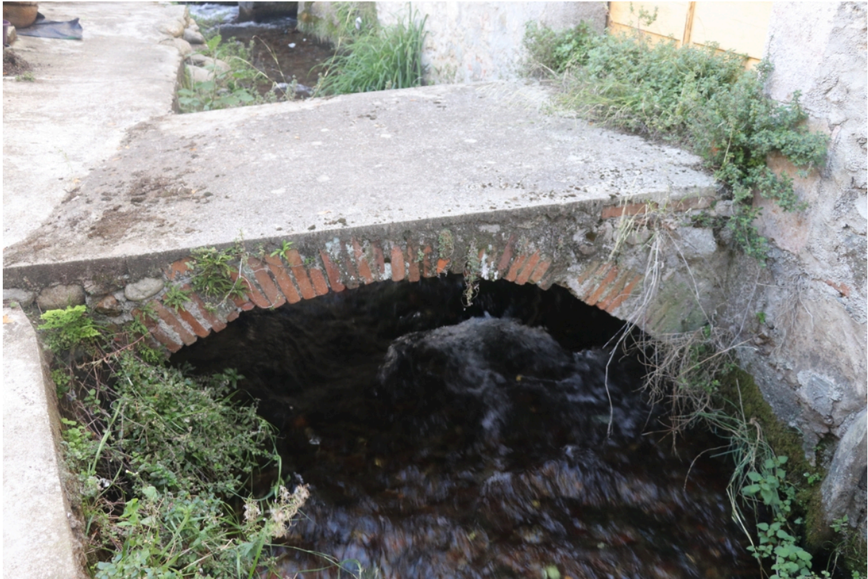
Ancien moulin à huile du sieur Tixedor, puis chocolaterie, puis usine électrique - Ponceau d'accès au portail Est.
