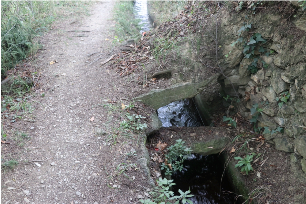
Canal de Canoha - Ponceau 2.
