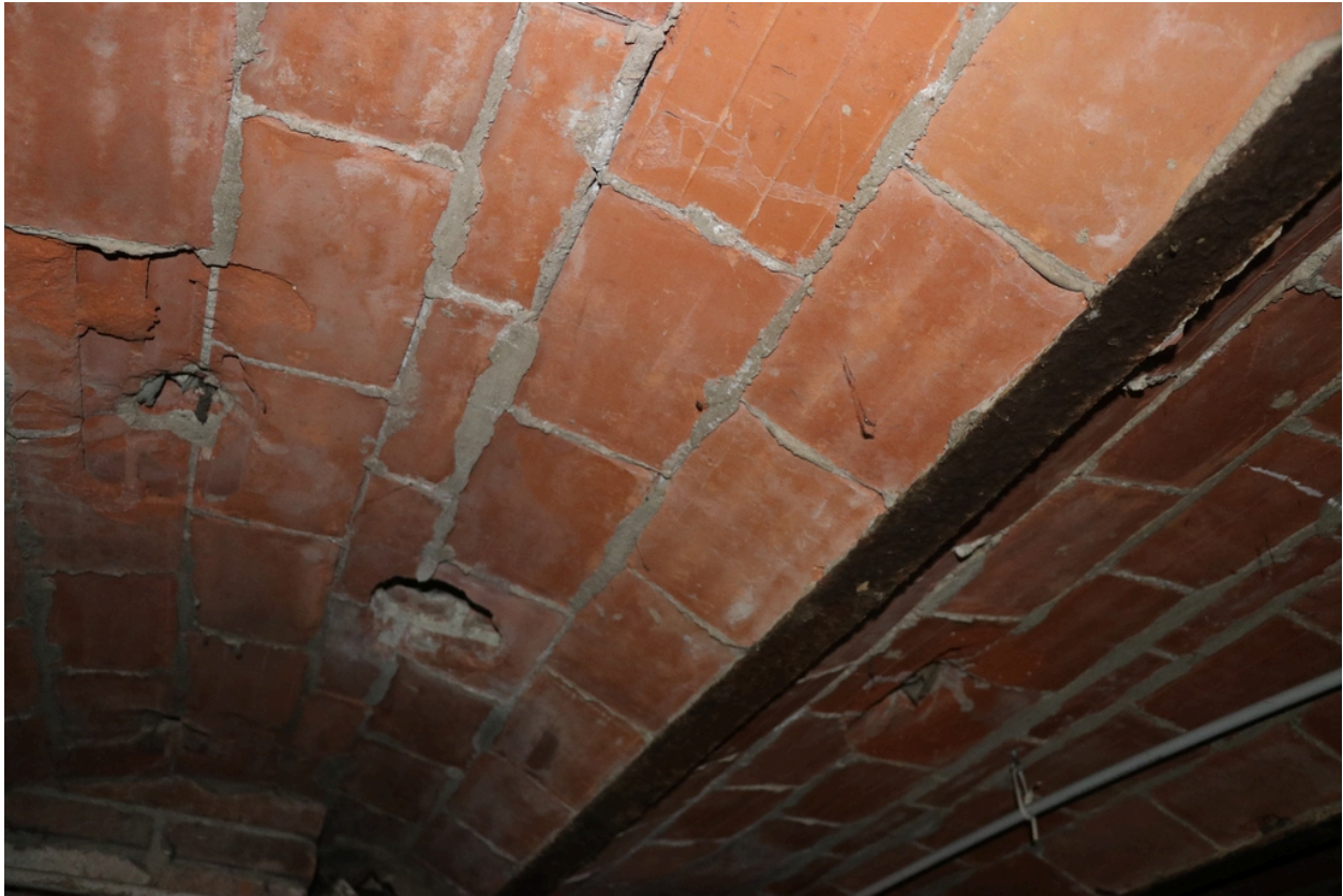
Usine Illes - Plancher à solives en fer et voûtain en briques pleines en sous-sol.
