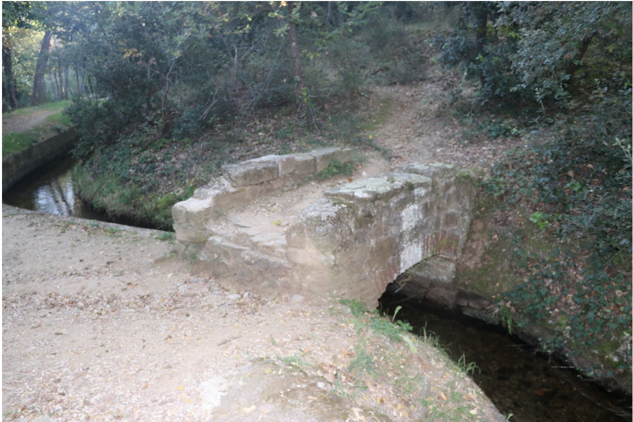
Canal de Bohère - Ponceau 6 (a).
