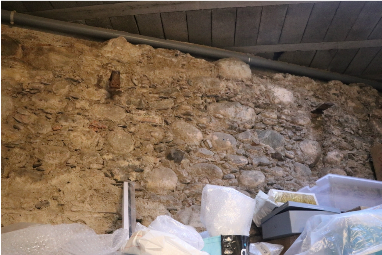
Ancien martinet à cuivre du sieur Comte et actuelle habitation n°5 bis rue Saint-Martin - Sous-sol avec maçonnerie intérieure et éléments en fer forgé.
