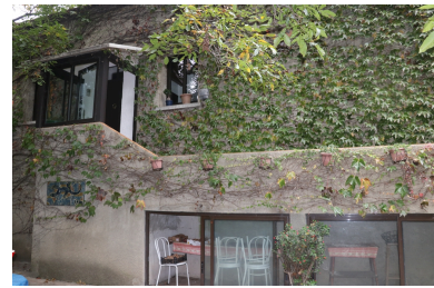
Moulin à farine Neuf puis Bès - Partie latérale gauche de la façade Sud. Phot. Léonie Deshayes IVR76_20216665108NUCA
