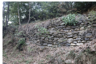
Canal de Canoha - Mur de soutènement inférieur. Phot. Léonie Deshayes IVR76_20216661951NUCA
