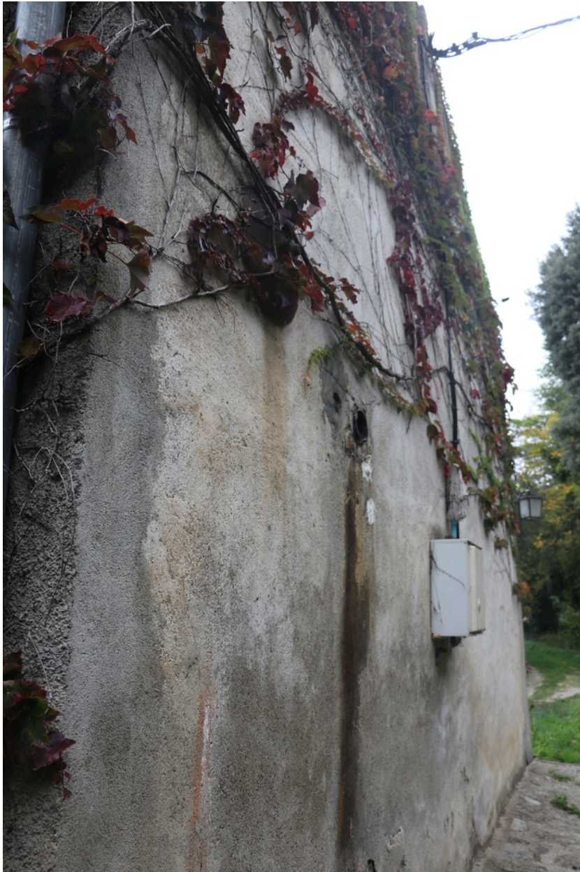
Moulin à farine Neuf puis Bès - Façade Est avec encrages en fer.
