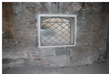
Moulin à huile de Jean Boher, puis martinet, puis usine, puis forge - Ouverture remaniée en soubassement 1). Phot. Léonie Deshayes IVR76_20216665071NUCA
