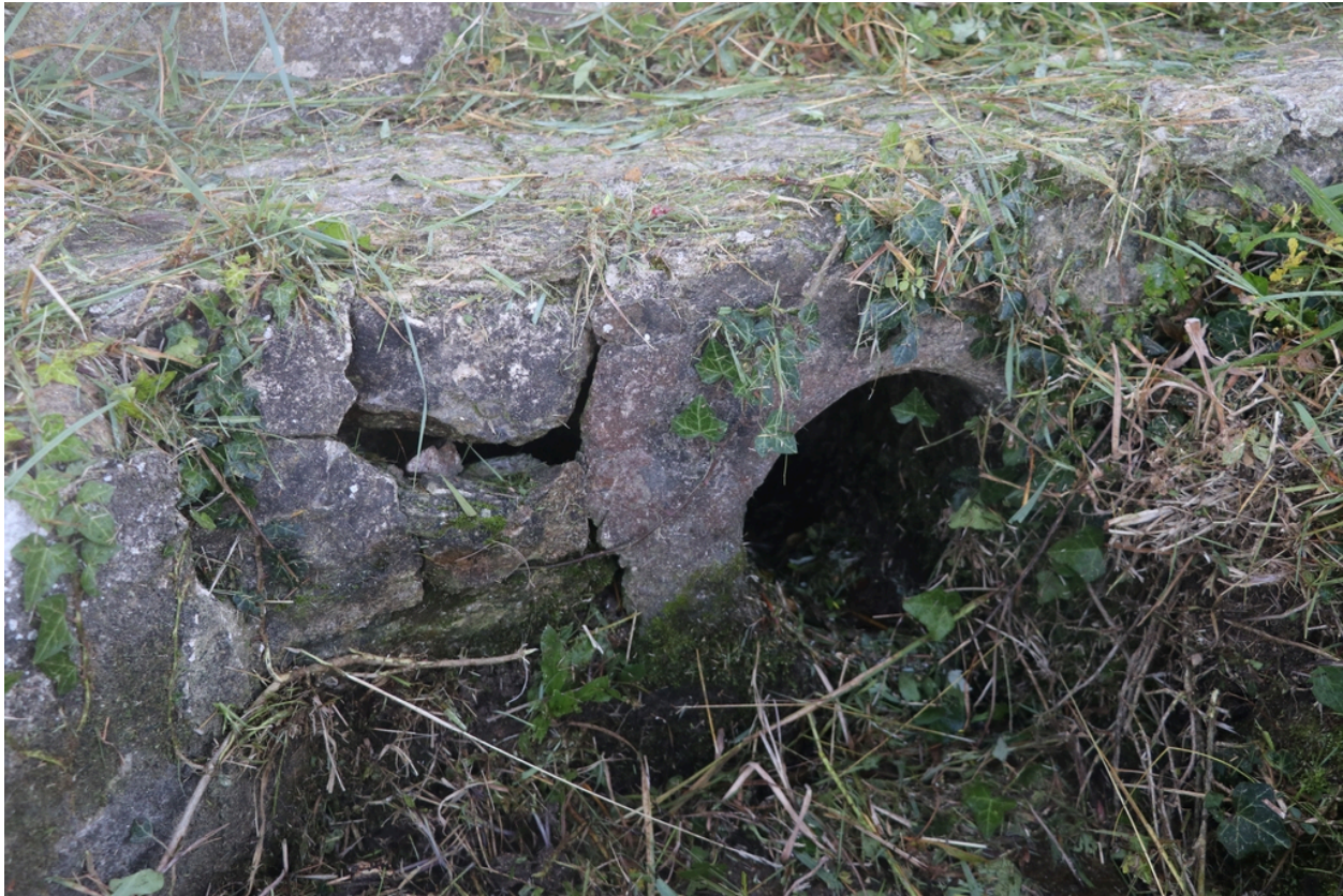
Canal de Dalt - Partition entre Branche ancienne et Branche nouvelle, bloc en pierre percé.
