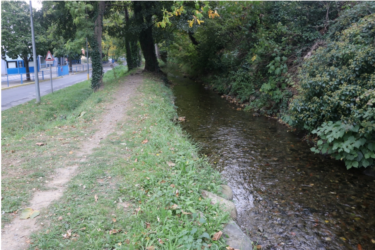
Canal Eus Marquixanes - Franc-bord aménagé.
