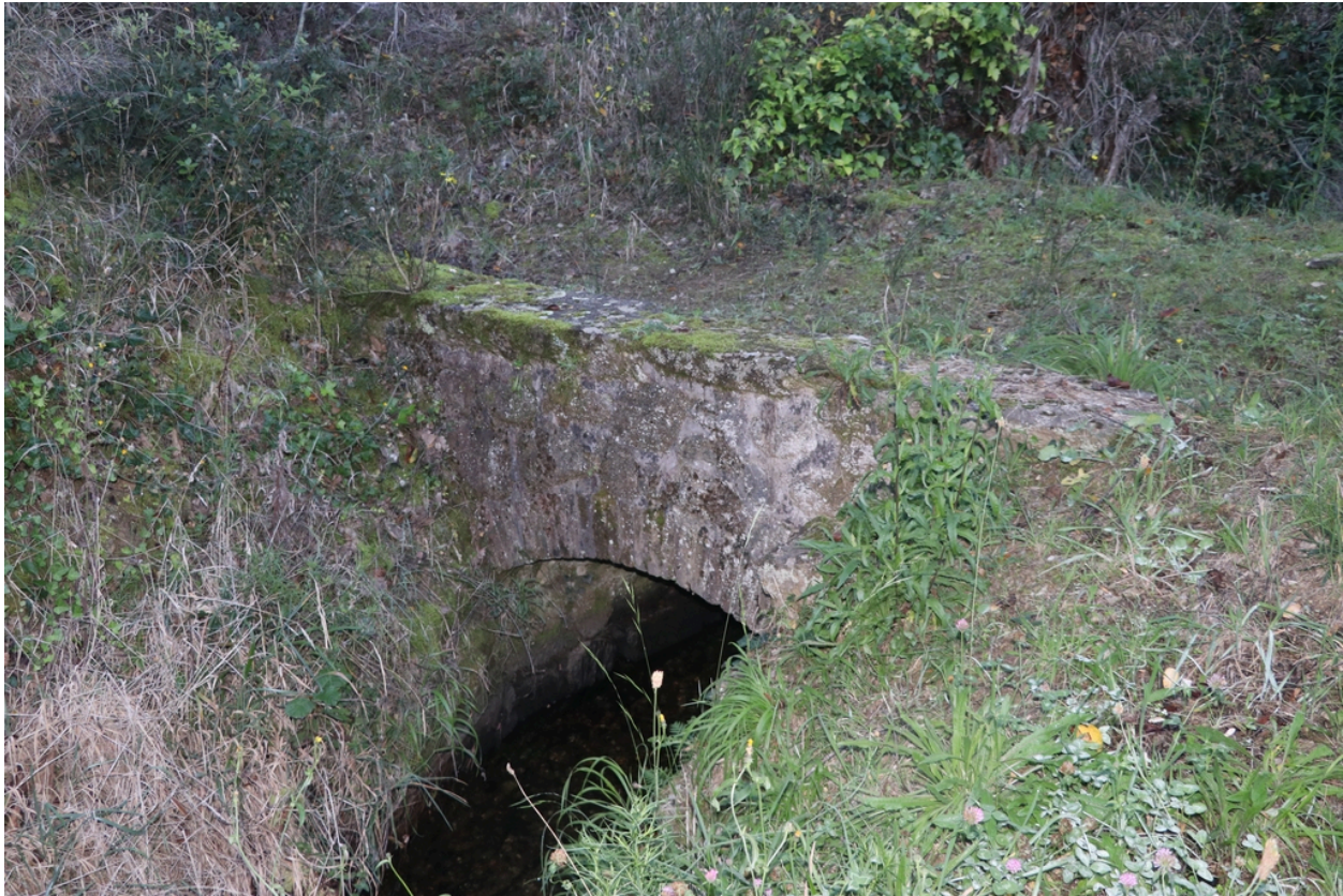
Canal de Bohère - Ponceau 1 (b).
