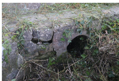
Canal de Dalt - Partition entre Branche ancienne et Branche nouvelle, bloc en pierre percé. Phot. Léonie Deshayes IVR76_20216661977NUCA
