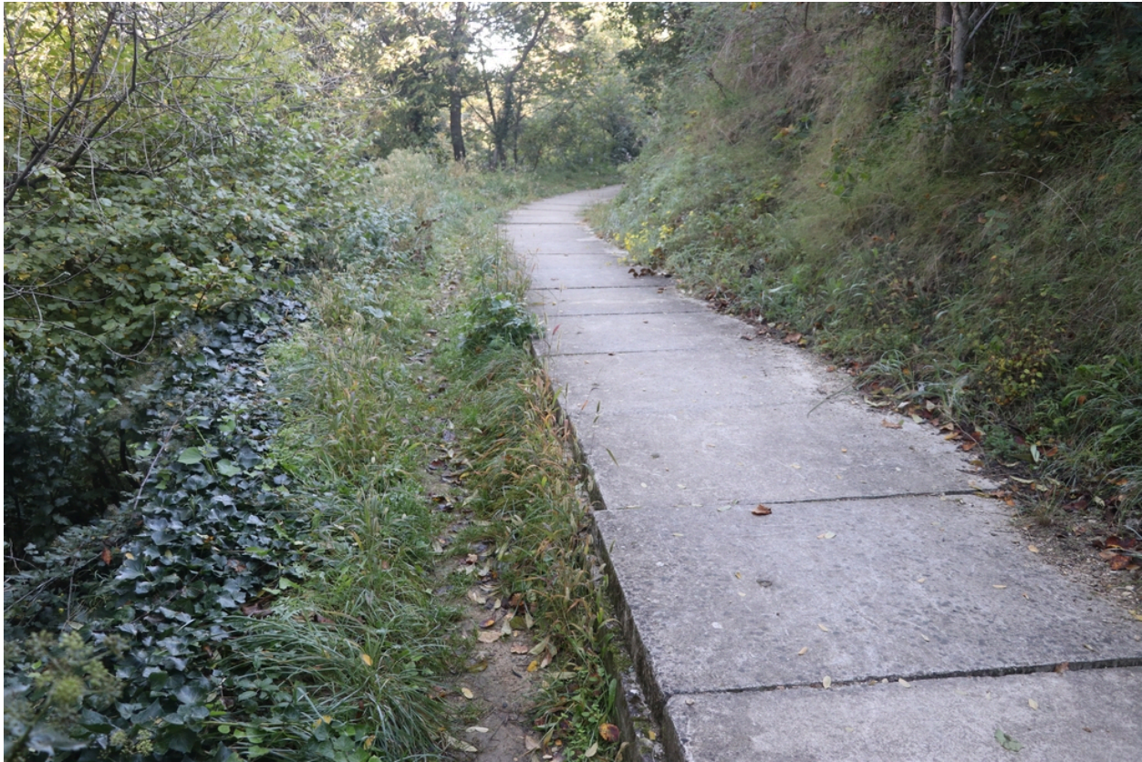
Canal de Dalt - Tronçon de la Branche ancienne recouvert de dalles.
