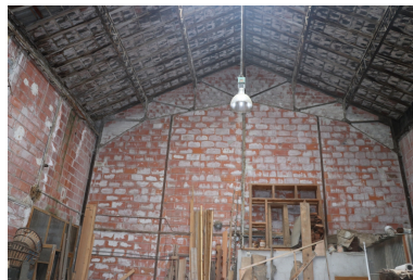
Site industriel de Gibraltar - Structure de charpente au premier niveau d'un bâtiment industriel de l'usine Chefdebien. Phot. Léonie Deshayes IVR76_20216665158NUCA
