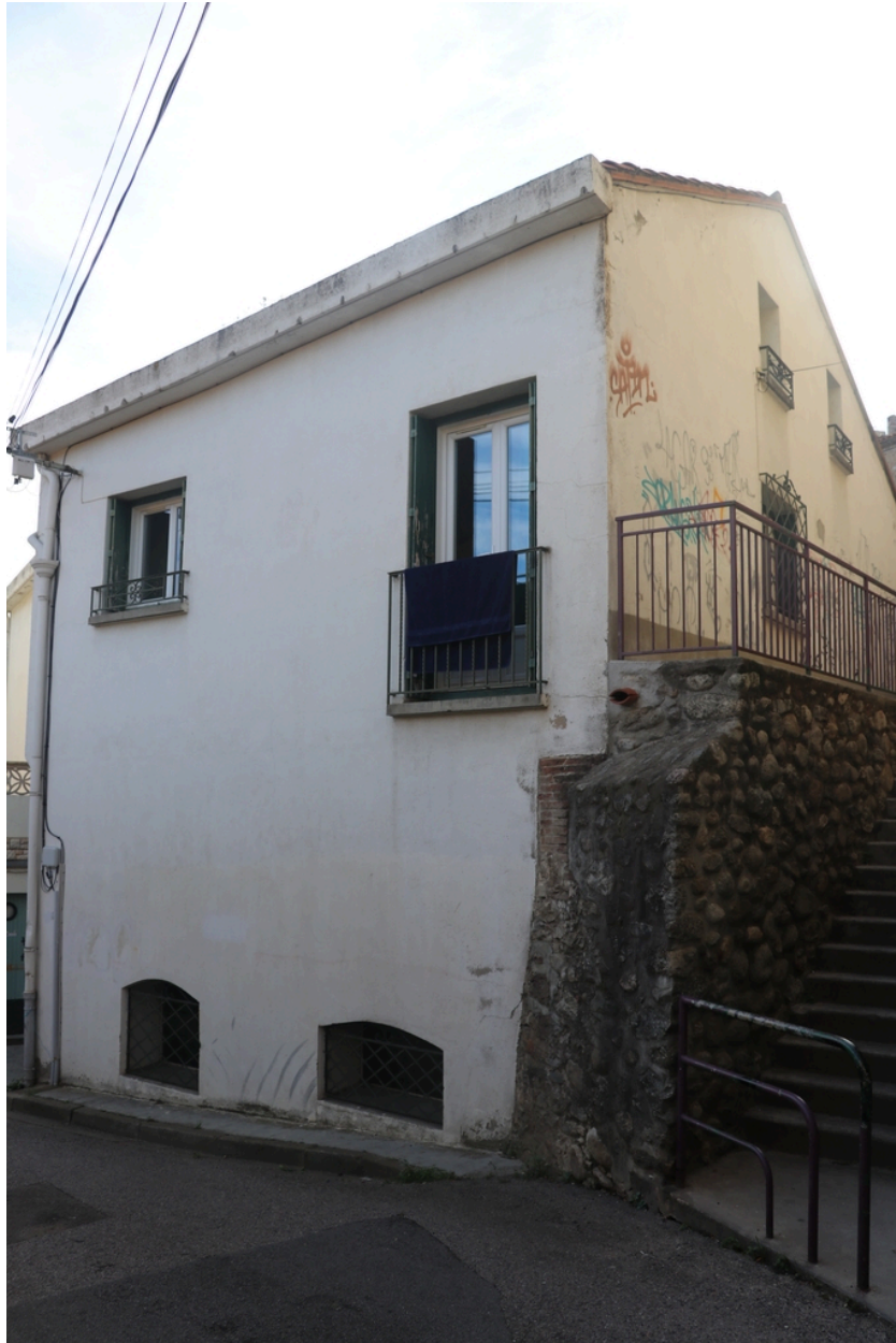
Moulin à huile de Jean Boher, puis martinet, puis usine, puis forge - Angle Nord-Ouest.
