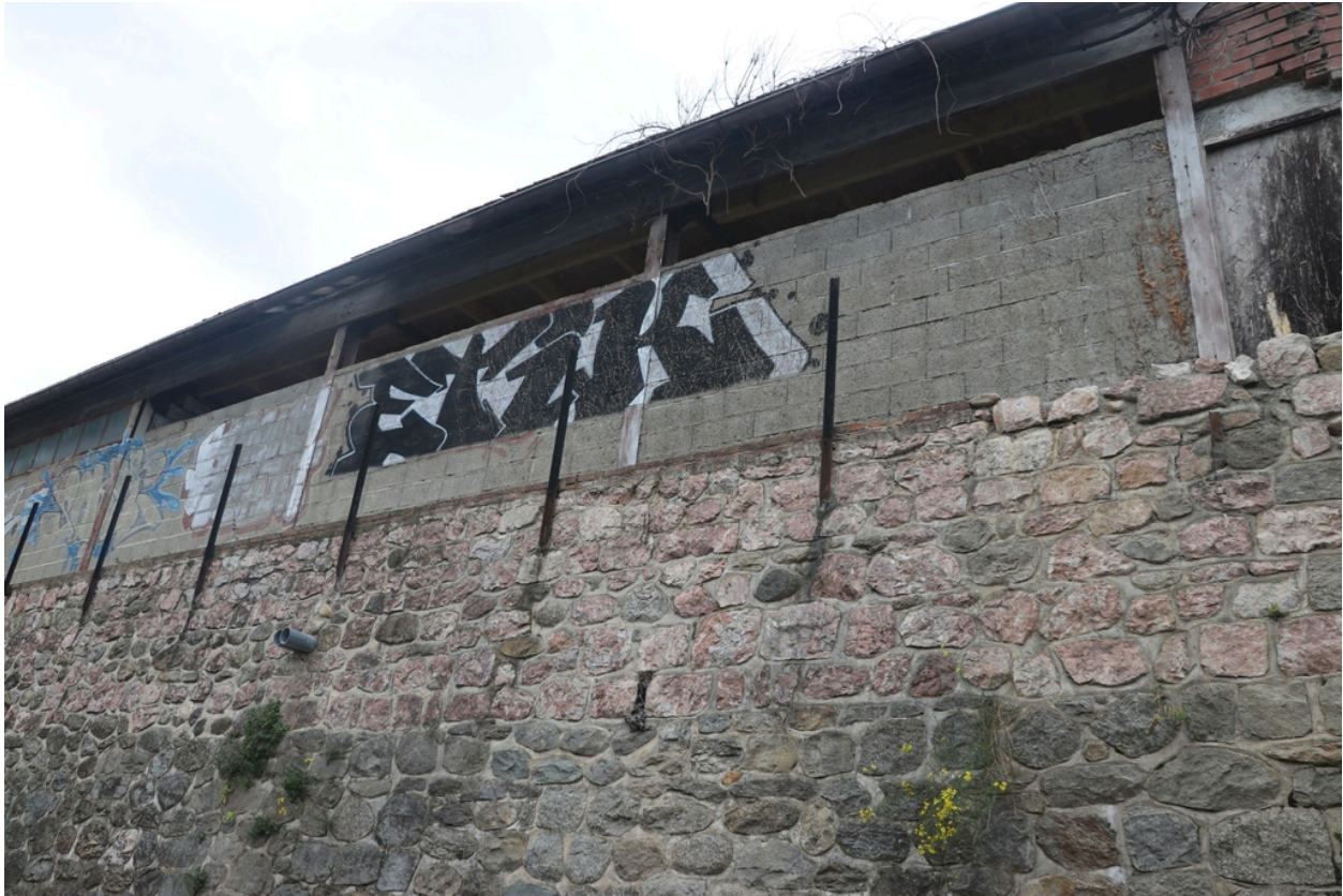
Site industriel de Gibraltar - Bâtiment industriel développé le long de l'Impasse Gibraltar.
