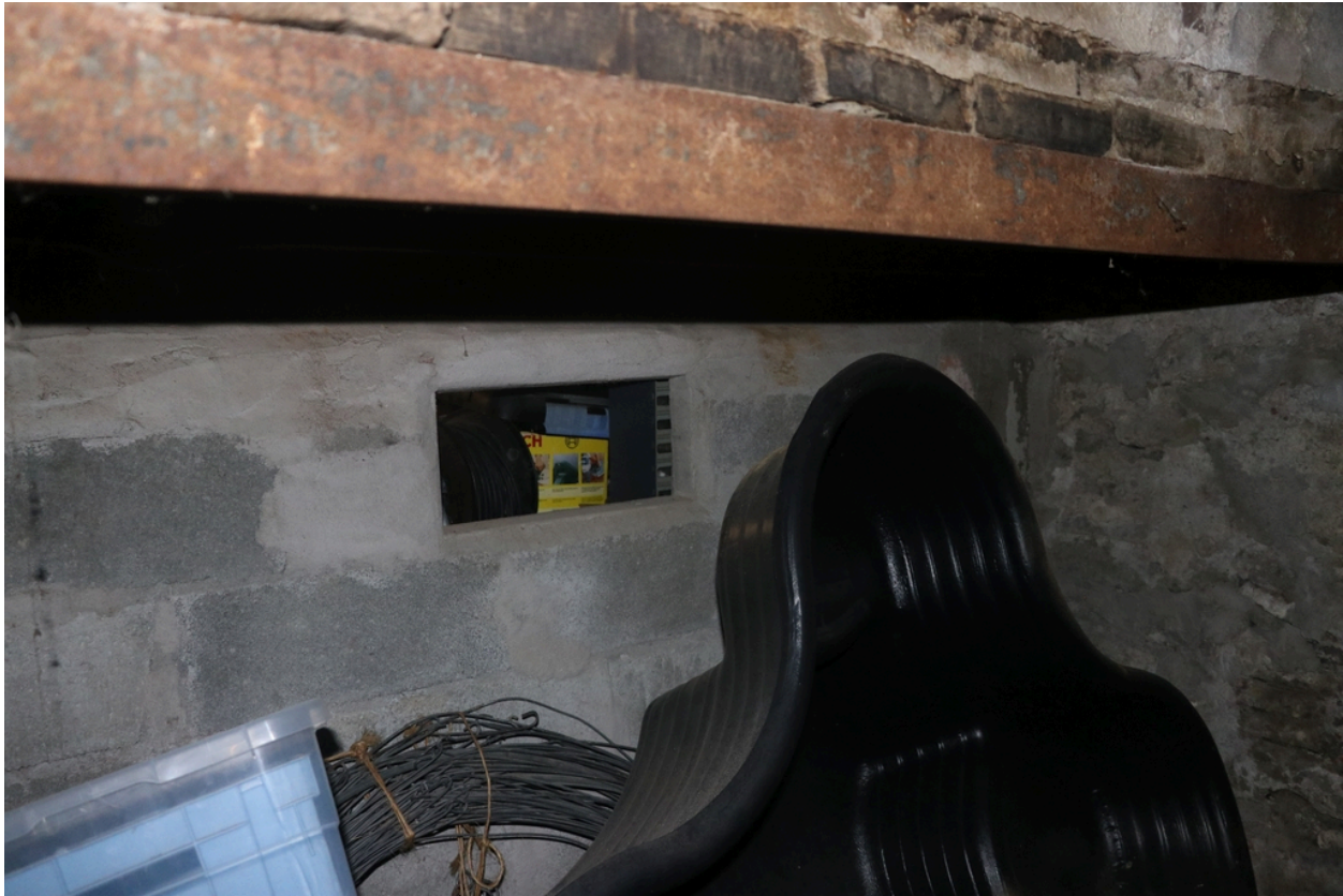
Usine Illes - Cheminée industriel en sous-sol.
