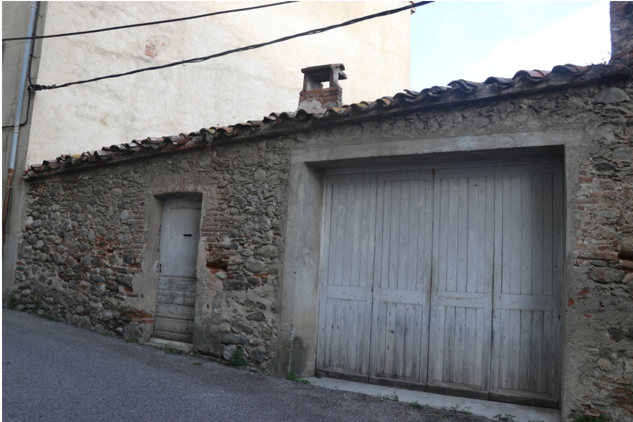
Moulin à huile de la dame Romeu, puis manufacture de textile - Façade Sud correspondant au n°11 rue Saint-Martin.
