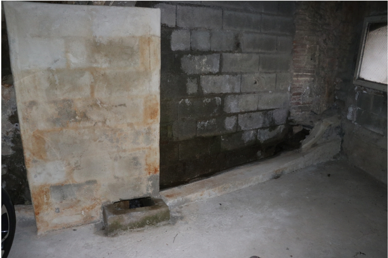
Moulin à huile de Jean Boher, puis martinet, puis usine, puis forge - Canal d'aménée du Rec de Baix en soubassement.
