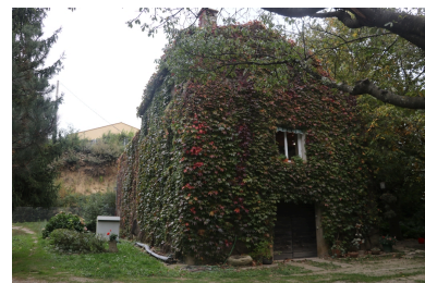
Moulin à farine Neuf puis Bès - Angle Nord-Ouest. Phot. Léonie Deshayes IVR76_20216665111NUCA
