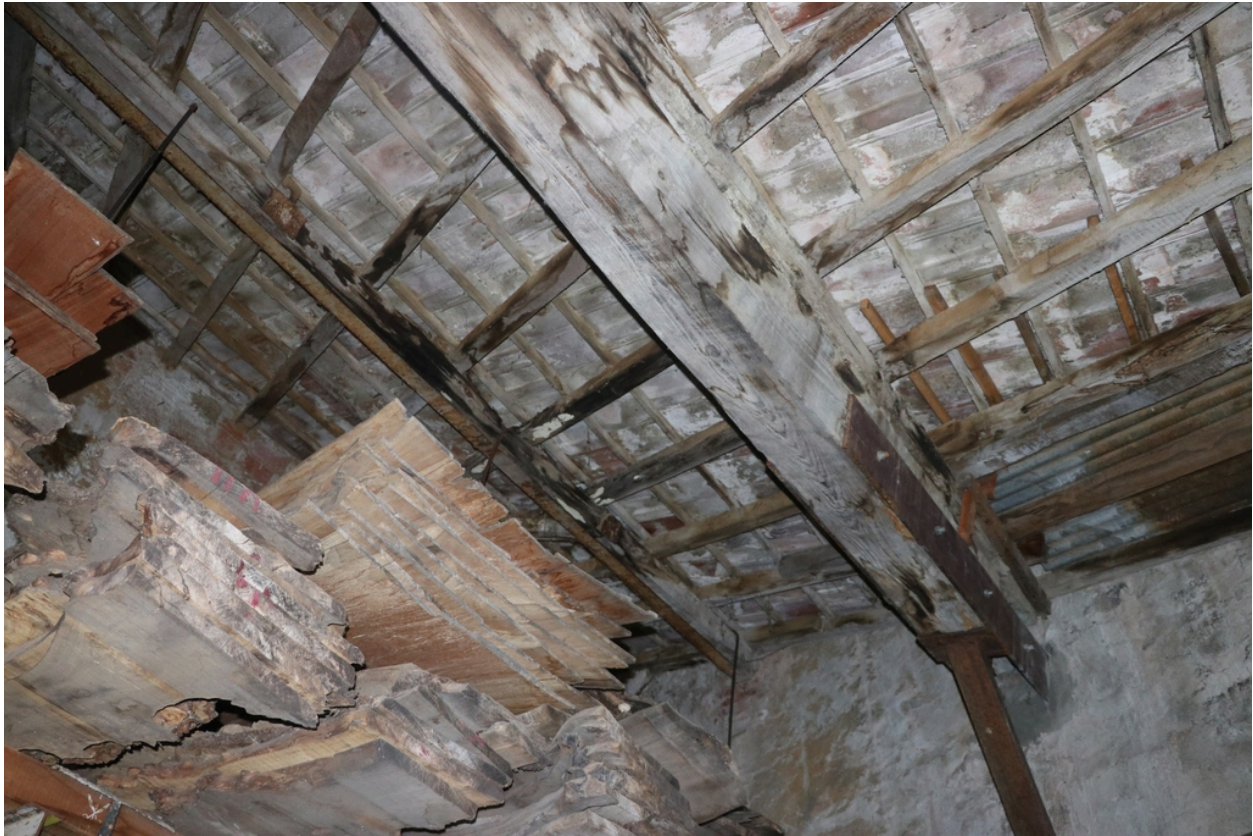
Site industriel de Gibraltar - Détail de charpente de couverture, bâtiment industriel de l'usine Chefdebien.
