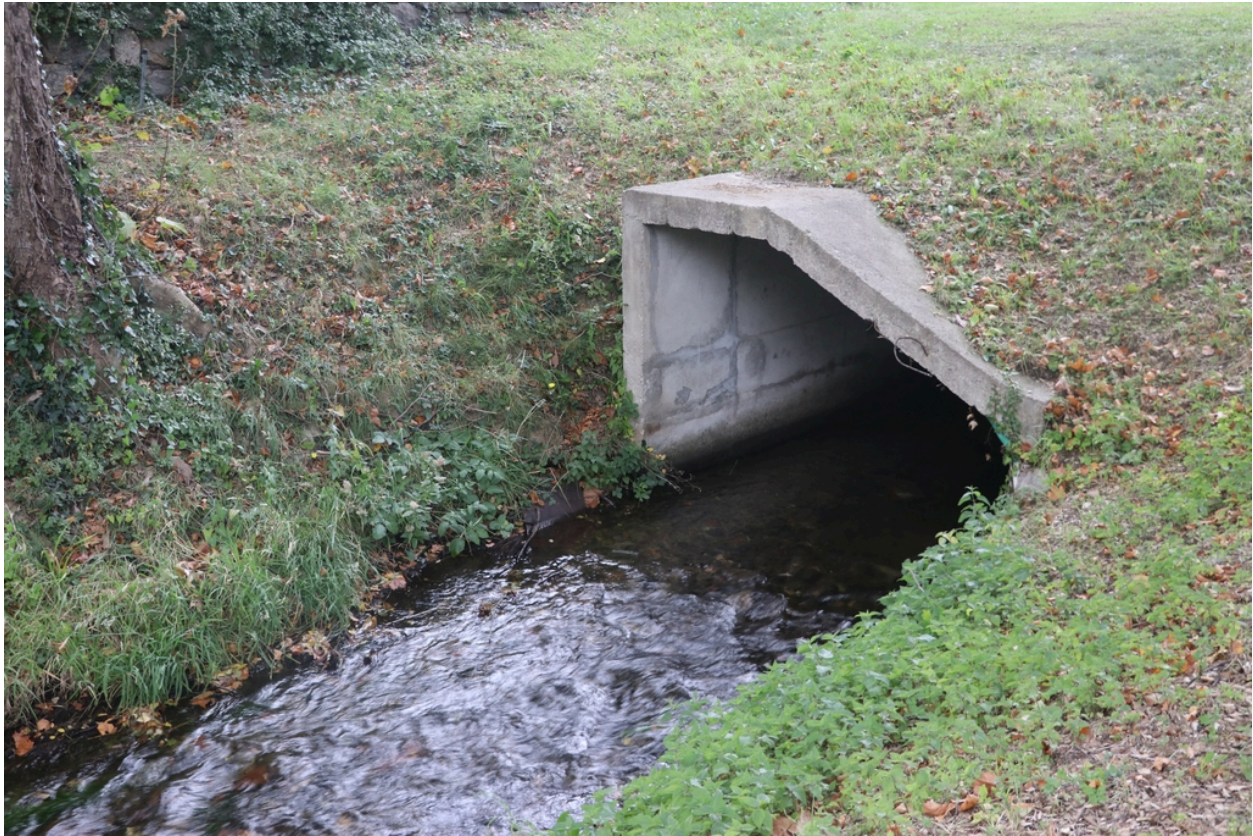
Canal Eus Marquixanes - Départ de la branche principale.
