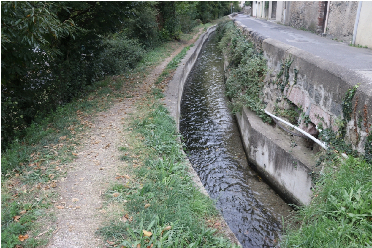
Canal Union - Franc-bord aménagé 1).
