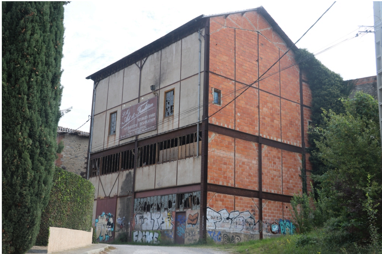
Site industriel de Gibraltar - Bâtiment industriel de l'usine Chefdebien réinvesti par des artisans locaux.
