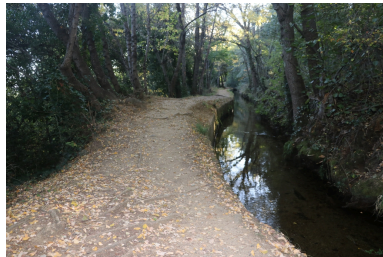
Canal de Bohère - Franc-bord aménagé. Phot. Léonie Deshayes IVR76_20216661935NUCA
