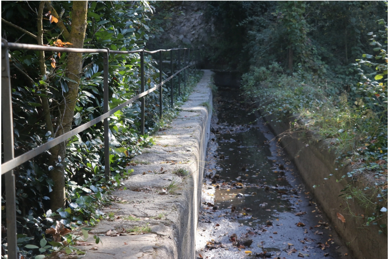
Canal de Dalt - Pont-canal du ravin de la Basse (Branche ancienne).
