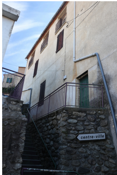
Moulin à farine, puis moulin à huile, puis moulin à farine Bonérich - Façade Est. Phot. Léonie Deshayes IVR76_20216665062NUCA
