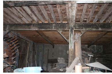
Site industriel de Gibraltar - Détail de plafond en rez-de-chaussée d'un bâtiment industriel de l'usine Chefdebien. Phot. Léonie Deshayes IVR76_20216665156NUCA
