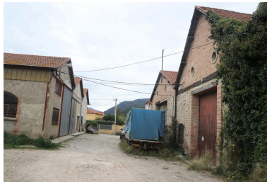
Site industriel de Gibraltar - Vue d'ensemble des bâtiments anciennement utilisés pour fabriquer la poudre Chefdebien. Phot. Léonie Deshayes IVR76_20216665149NUCA
