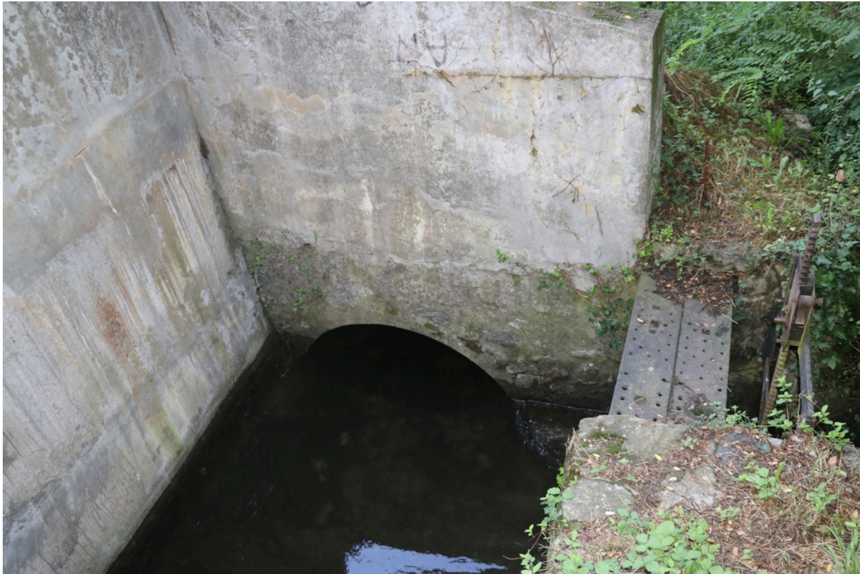
Canal Union - Décharge vers le fleuve Têt.
