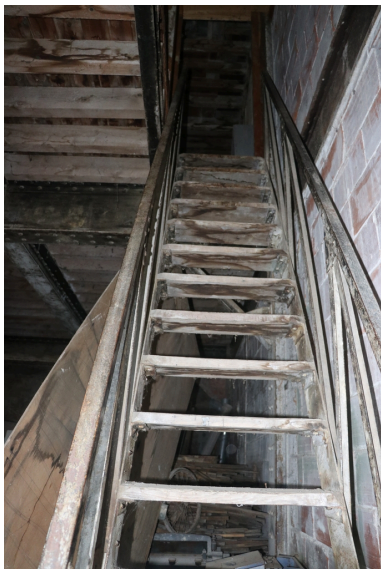
Site industriel de Gibraltar - Escalier de liaison entre le rez-de-chaussée et le premier étage d'un bâtiment industriel de l'usine Chefdebien. Phot. Léonie Deshayes IVR76_20216665157NUCA
