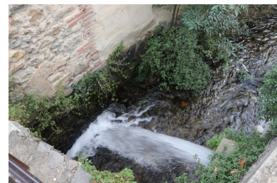
Canalisation du cours d'eau Eus Marquixanes entre l'ancienne usine Illes et la tannerie Guitard. Phot. Léonie Deshayes IVR76_20216665096NUCA
