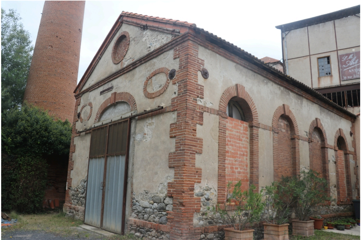
Site industriel de Gibraltar - Vue Nord-Ouest du bâtiment à chaudière et turbines.
