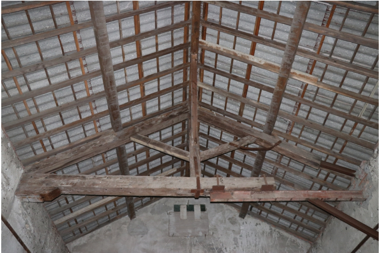
Site industriel de Gibraltar - Détail de la charpente du bâtiment à chaudière et turbines.
