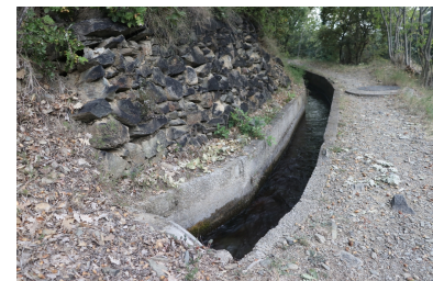
Canal de Canoha - Mur de soutènement supérieur. Phot. Léonie Deshayes IVR76_20216661952NUCA
