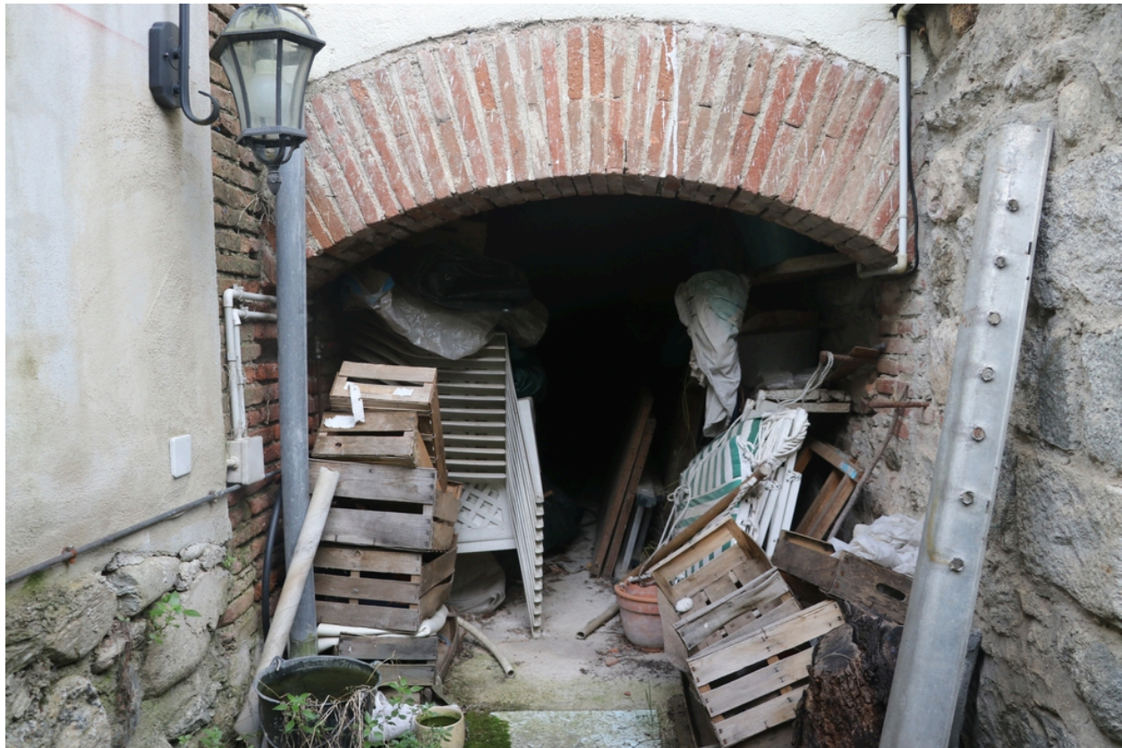
Usine Illes - Accès au sous-sol depuis le jardin.
