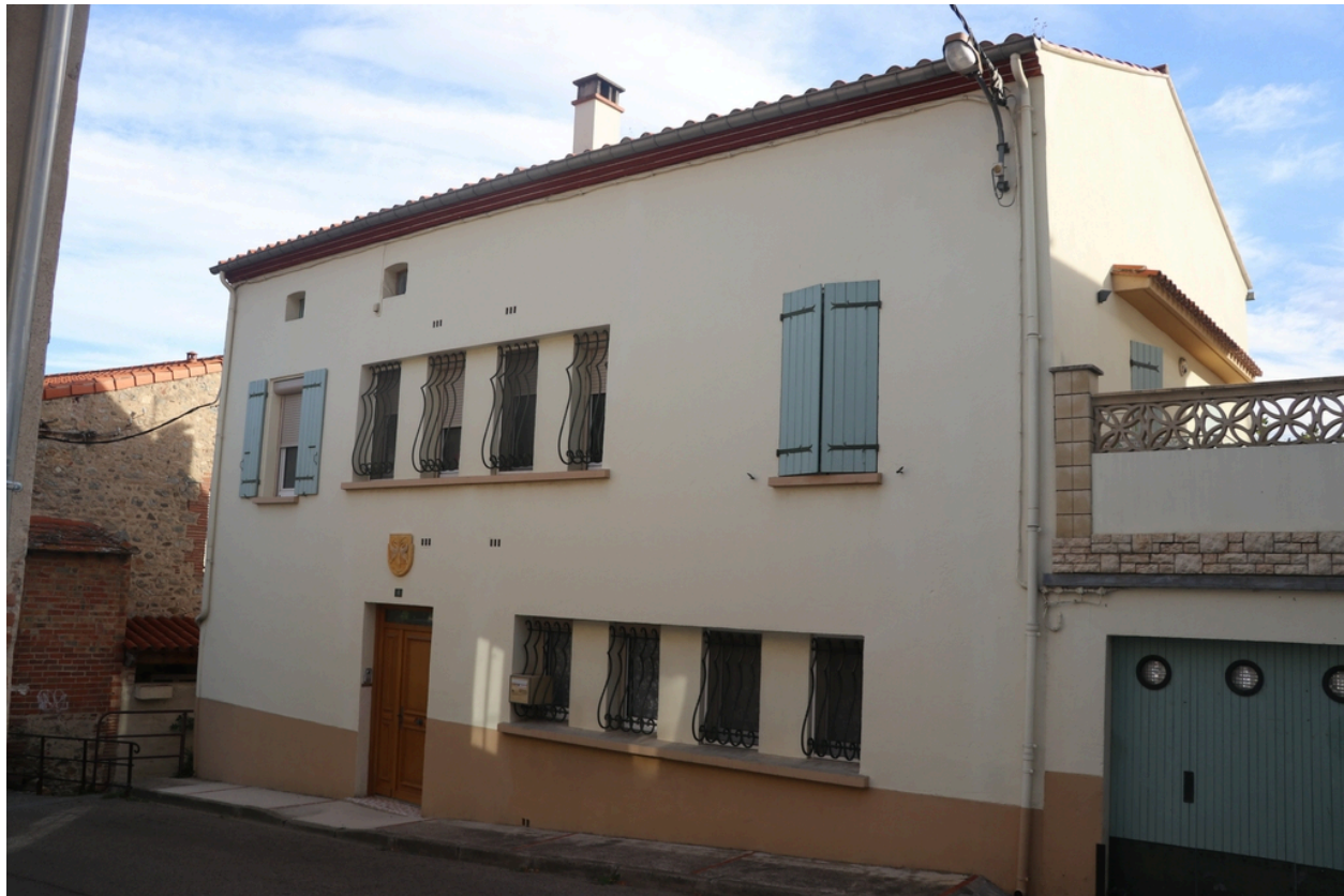
Usine Illes - Façade sur rue Saint-Martin.
