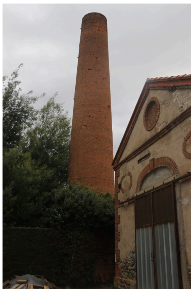
Site industriel de Gibraltar - Cheminée en cayrous. Phot. Léonie Deshayes IVR76_20216665143NUCA
