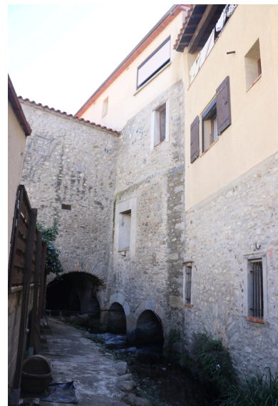
Moulin à farine communal - Façades Nord et Est avec arches voûtées. Phot. Léonie Deshayes IVR76_20216665027NUCA
