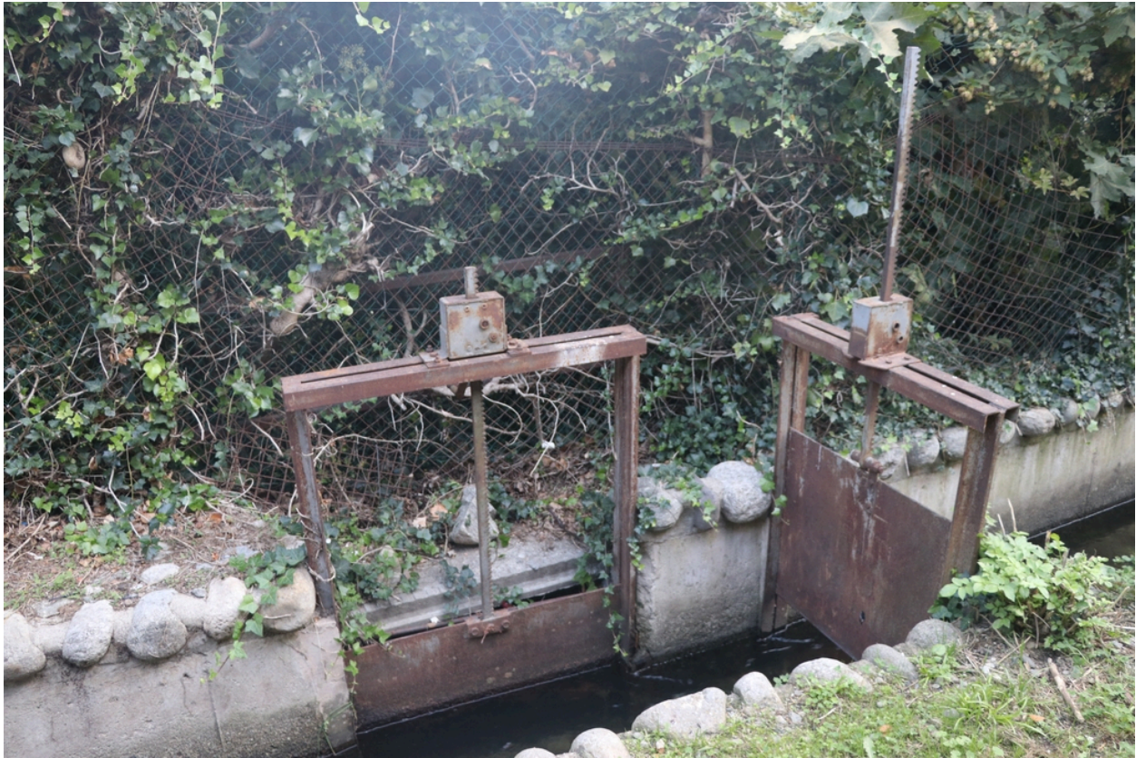
Canal Rec de Baix - Décharge vers canal Eus Marquixanes.
