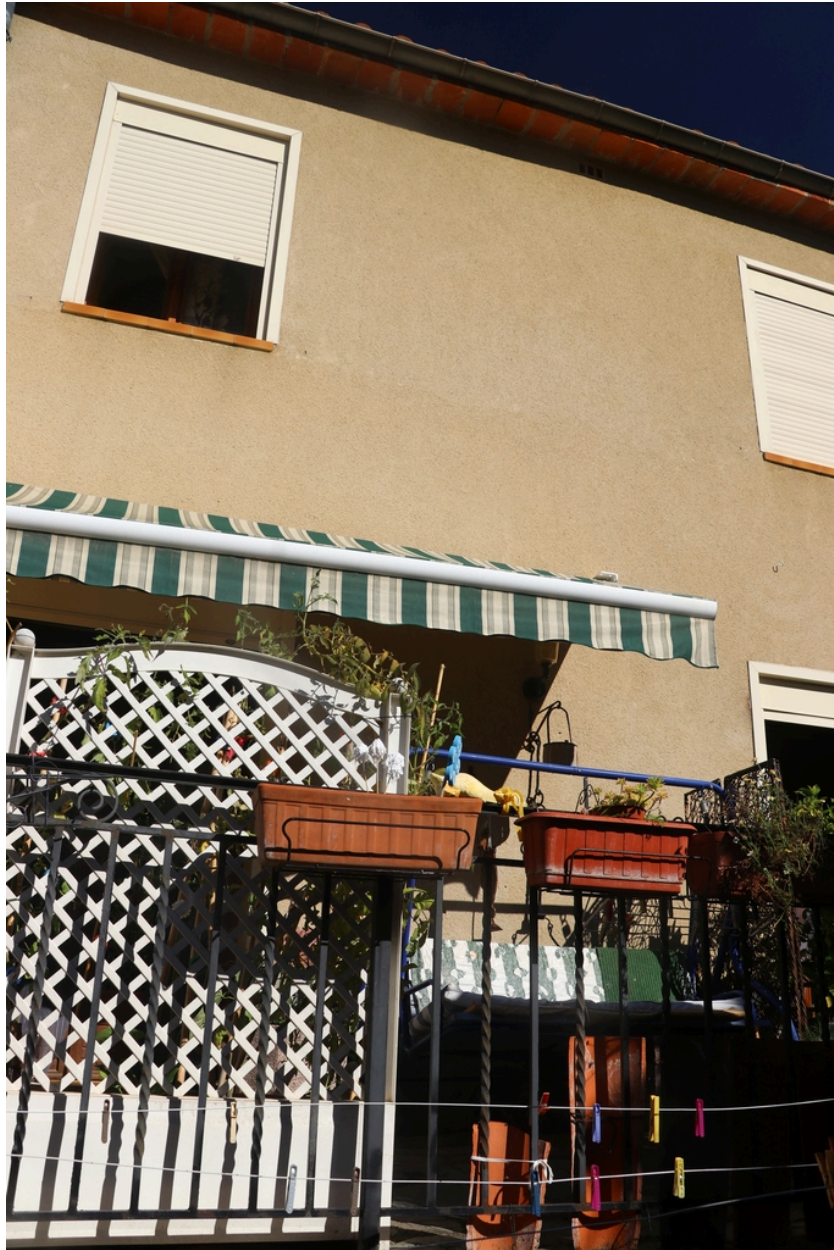
Moulin à farine communal - Façade Ouest.
