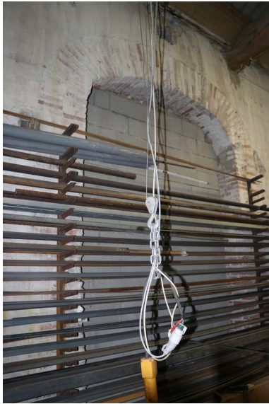
Site industriel de Gibraltar - Ouverture obturée à arc surbaissé en cayrous, bâtiment industriel de l'usine Chefdebien. Phot. Léonie Deshayes IVR76_20216665160NUCA
