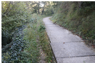
Canal de Dalt - Tronçon de la Branche ancienne recouvert de dalles. Phot. Léonie Deshayes IVR76_20216661971NUCA
