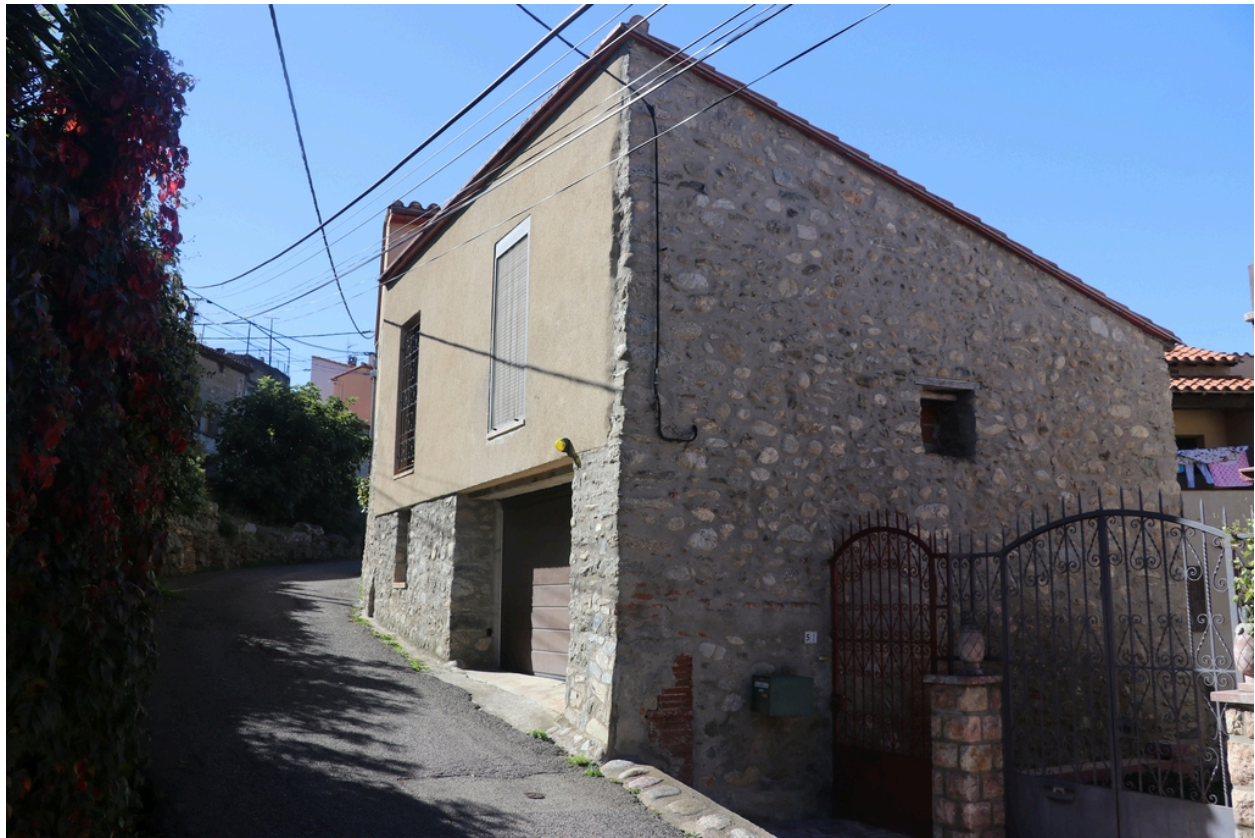
Moulin à farine communal - Façade Est.
