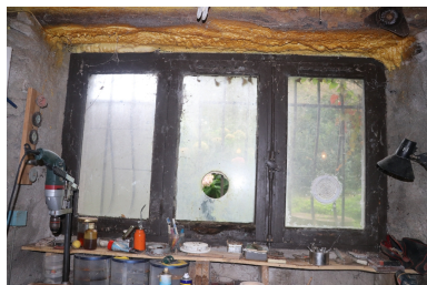
Moulin à farine Neuf puis Bès - Ancienne porte à cadre en bois redécoupée en fenêtre située dans la cave. Phot. Léonie Deshayes IVR76_20216665115NUCA
