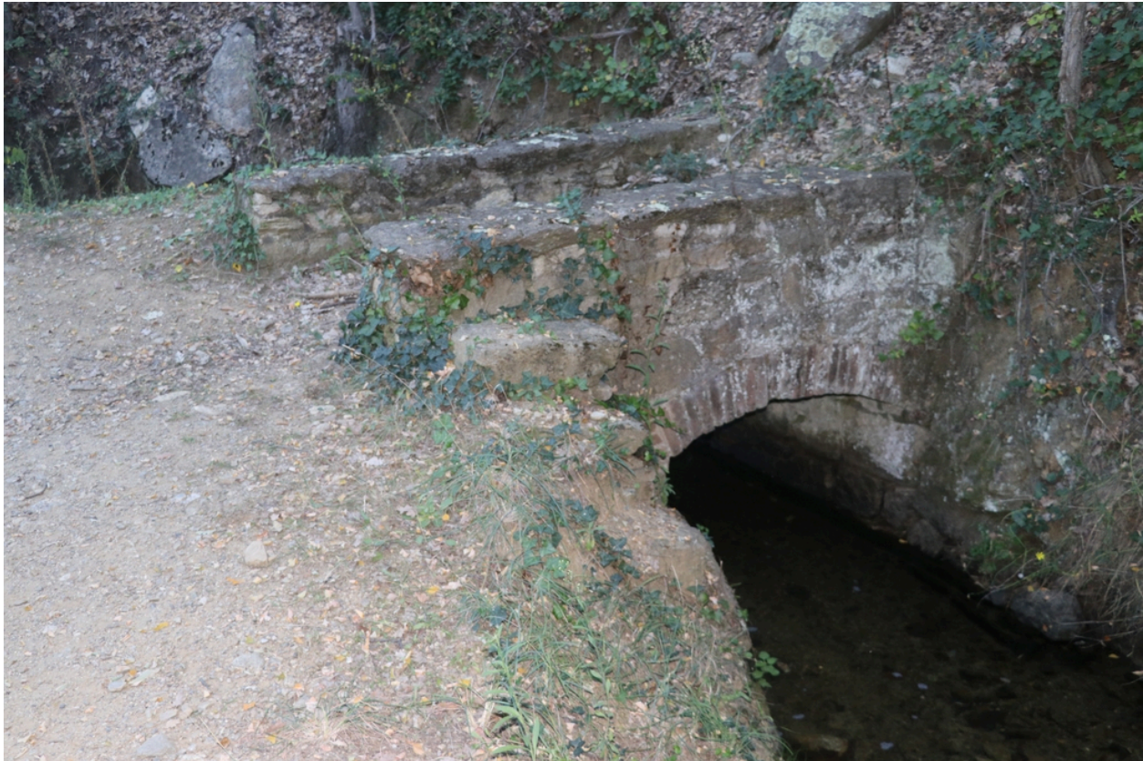
Canal de Bohère - Ponceau 5.
