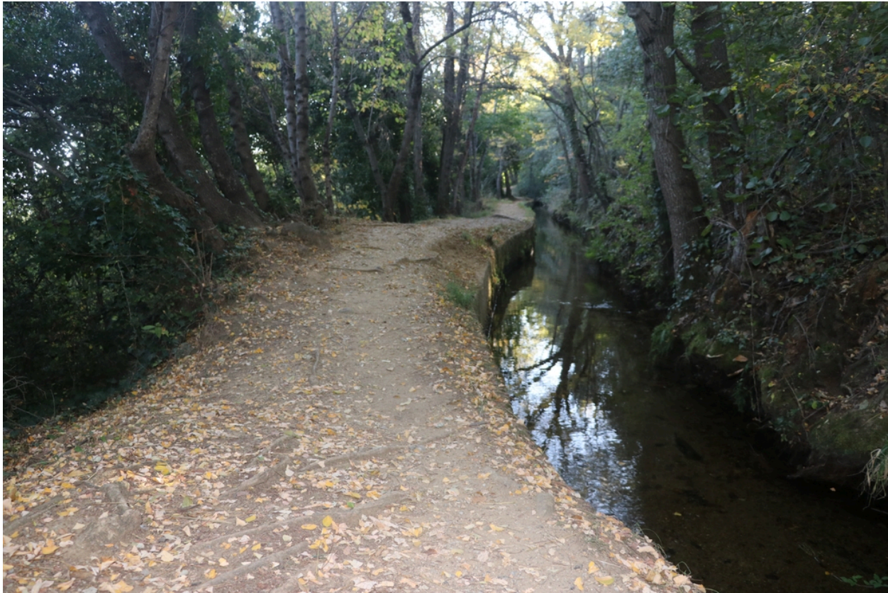
Canal de Bohère - Franc-bord aménagé.
