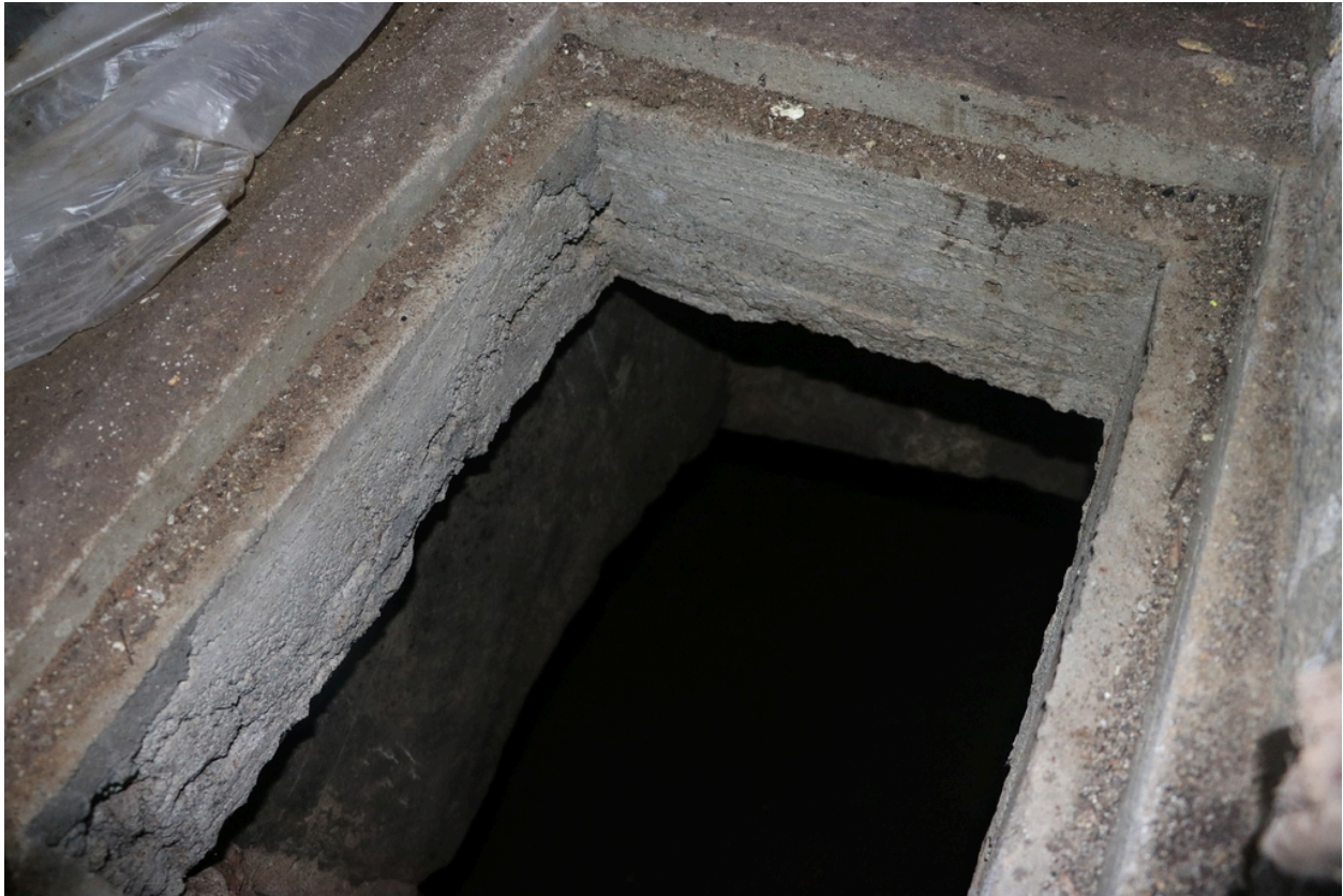
Moulin à farine Neuf puis Bès - Intérieur de la cave avec trappe d'accès à la chambre hydraulique.
