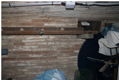
Ancien moulin à huile du sieur Tixedor, puis chocolaterie, puis usine électrique - Mécanisme de la chocolaterie conservé en sous-sol. Phot. Léonie Deshayes IVR76_20216665058NUCA
