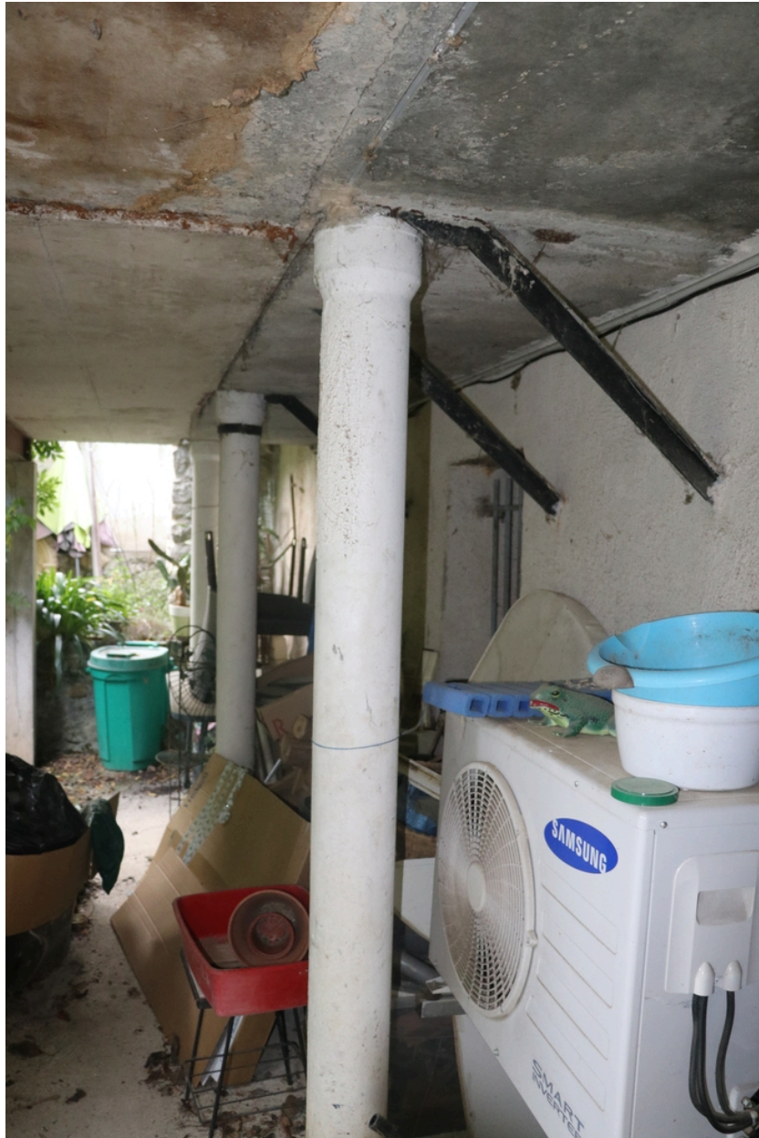
Usine Illes - Rez-de-chaussée Est avec pieds de force en fer forgé.
