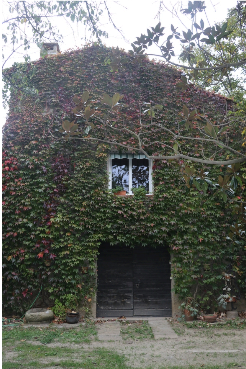
Moulin à farine Neuf puis Bès - Façade Ouest.
