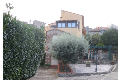
Ancien moulin à huile du sieur Tixedor, puis chocolaterie, puis usine électrique - Vue Nord.
