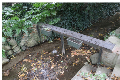
Moulin à farine Neuf puis Bès - Vanne martelière sur le canal Eus Marquixanes. Phot. Léonie Deshayes IVR76_20216665118NUCA
