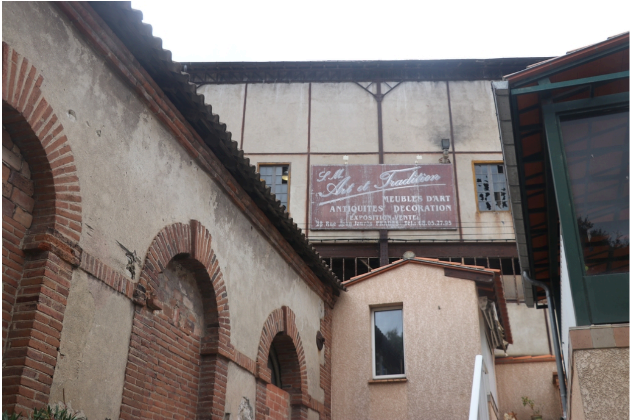
Site industriel de Gibraltar - Détail d'une enseigne du 20e siècle sur un des bâtiments industriels de l'usine Chefdebien.
