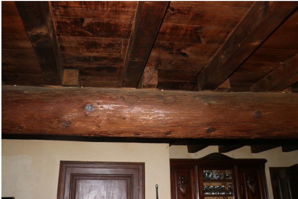
Moulin à farine Neuf puis Bès - Plancher avec poutre massive, solives et planches en bois au premier étage.
