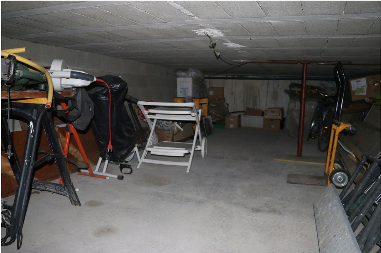
Moulin à farine communal - Sous-sol transformé en cave/débaras.
