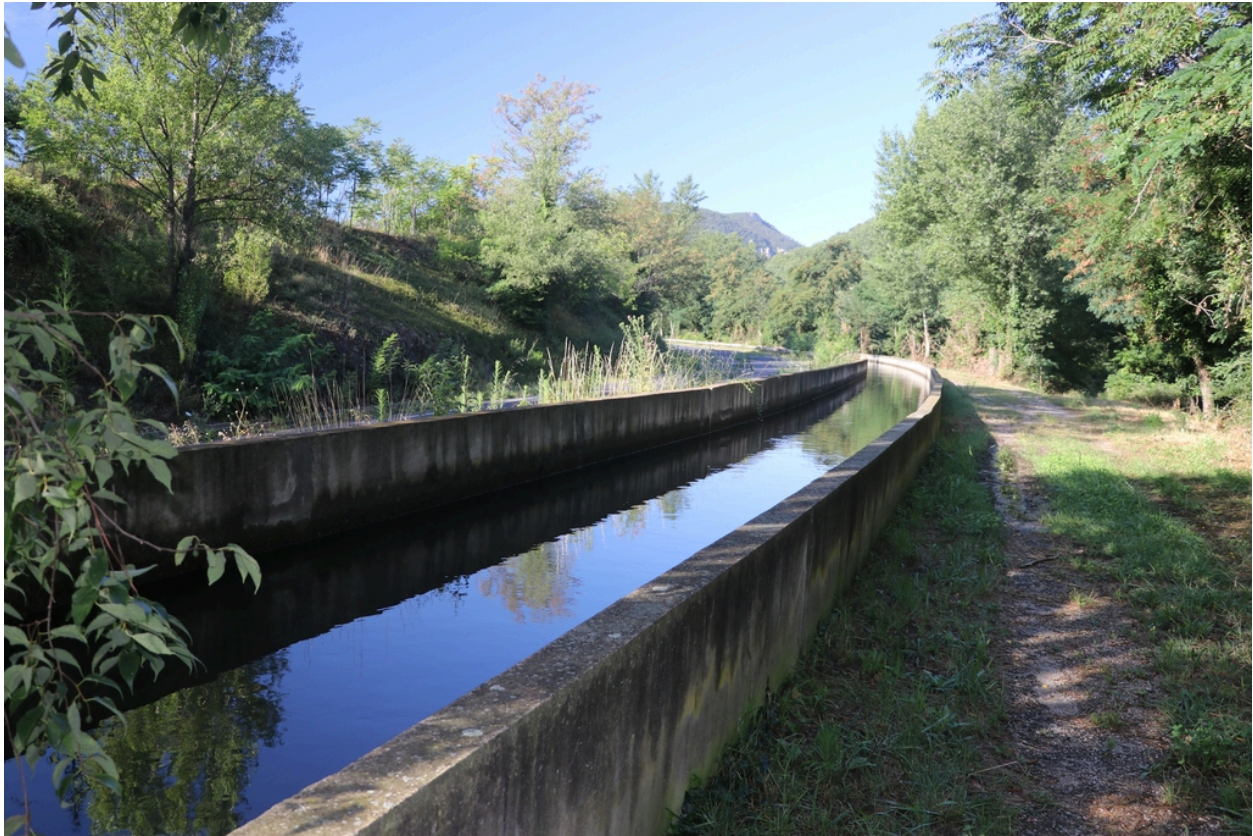
Canal Union - Tronçon développé en bordure de la Route nationale 116.
