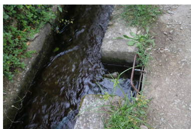
Canal de Canoha - Embegue avec vanne en fer. Phot. Léonie Deshayes IVR76_20216661953NUCA
