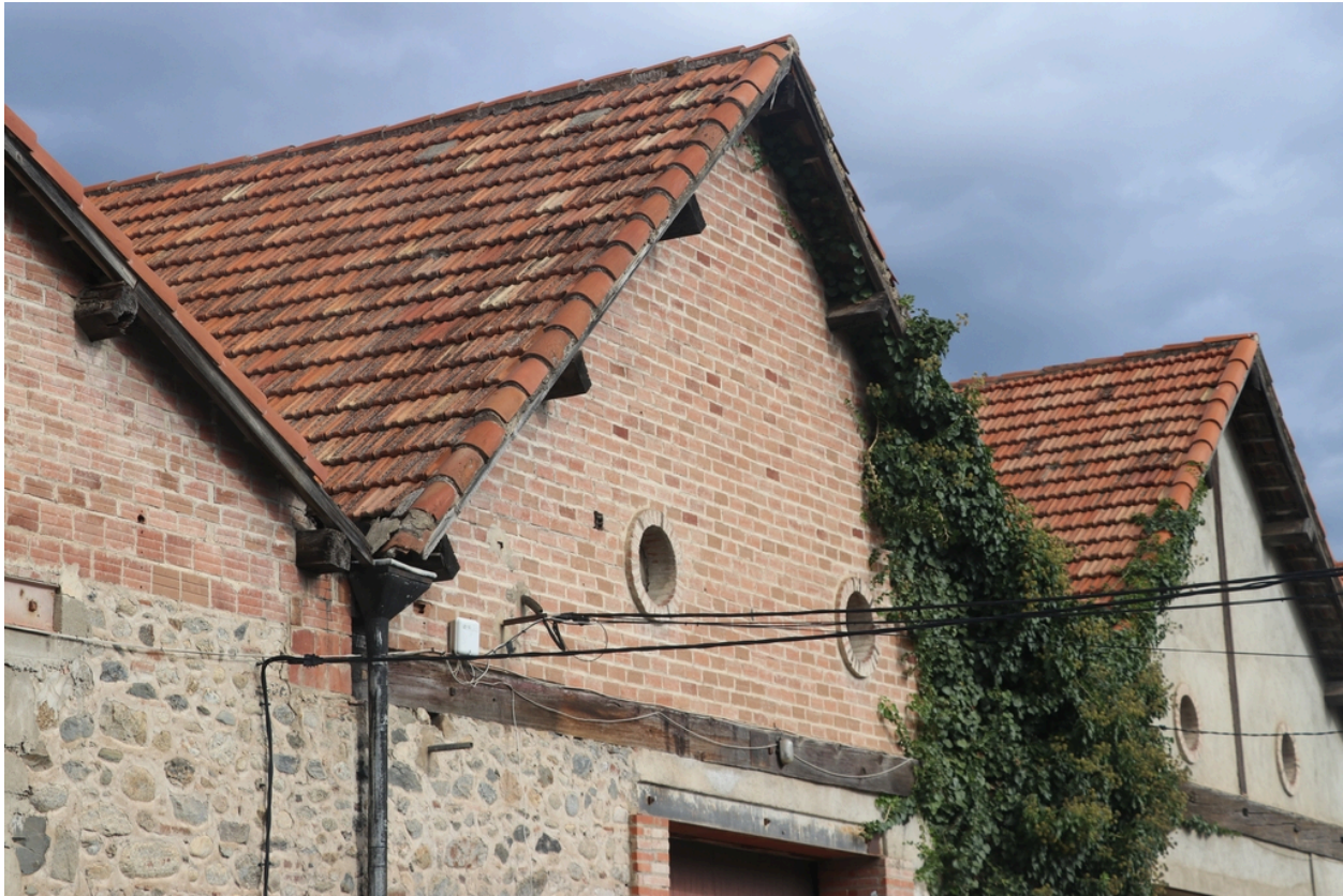
Site industriel de Gibraltar - Détail de la couverture en tuiles mécaniques des bâtiments anciennement utilisés pour la fabrication de la poudre Chefdebien.
