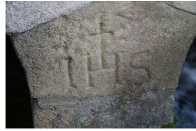
Moulin à farine communal - Date « 1775 » surmontée d'une croix gravée sur une pile. Phot. Léonie Deshayes IVR76_20216665030NUCA
