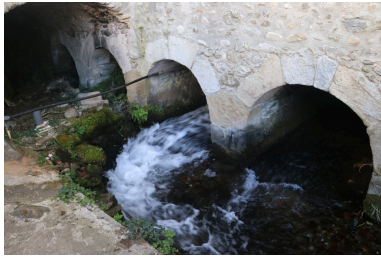
Moulin à farine communal - Passage du canal de fuite sous les arches voûtées. Phot. Léonie Deshayes IVR76_20216665028NUCA
