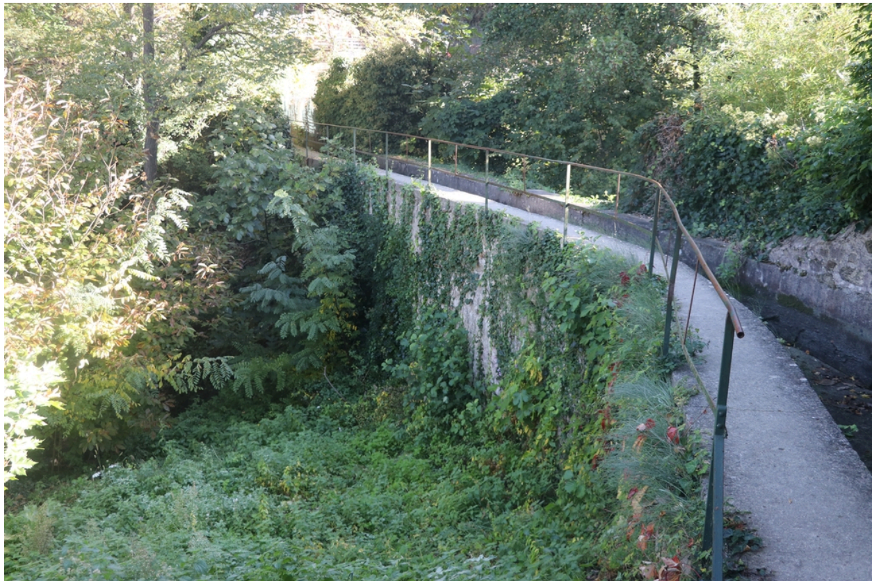
Canal de Dalt - Pont-canal du ravin de la Calmeille (Branche ancienne).
