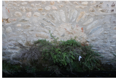
Moulin à farine communal - Voûte en plein cintre bouchée en soubassement Est. Phot. Léonie Deshayes IVR76_20216665032NUCA
