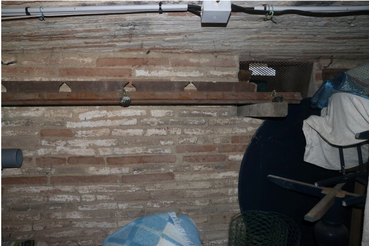
Ancien moulin à huile du sieur Tixedor, puis chocolaterie, puis usine électrique - Mécanisme de la chocolaterie conservé en sous-sol.
