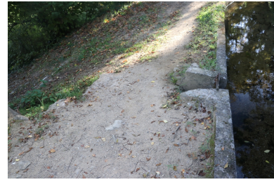
Canal de Bohère - Branche secondaire dite de Braquemart. Phot. Léonie Deshayes IVR76_20216661934NUCA
