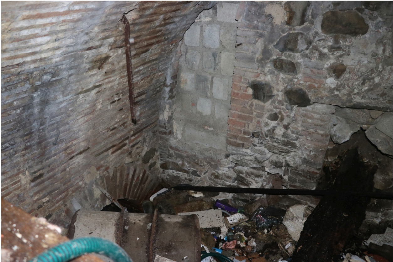
Ancien moulin à huile du sieur Tixedor, puis chocolaterie, puis usine électrique - Axe horizontal et barre de transmission conservés dans la chambre hydraulique du moulin à huile 2).
