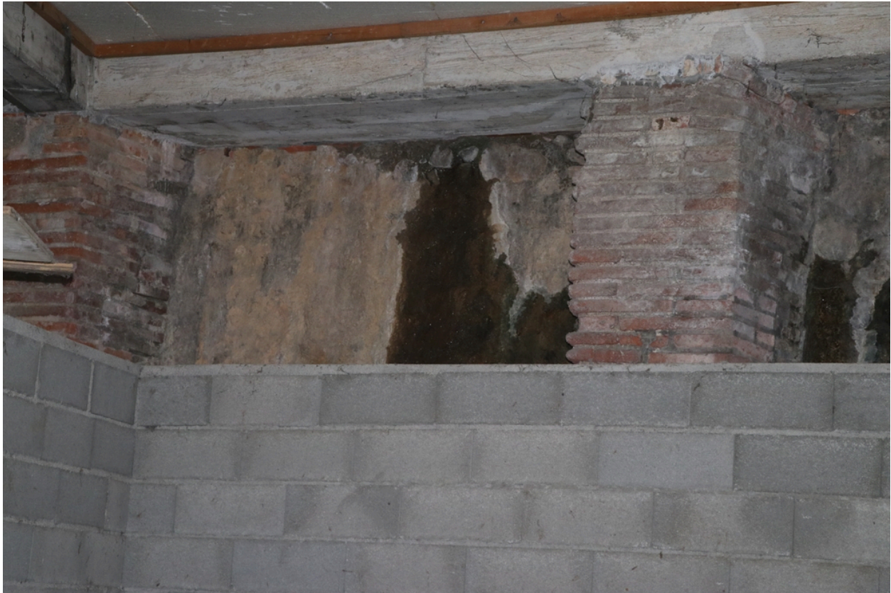
Moulin à huile de Jean Boher, puis martinet, puis usine, puis forge - Piliers massifs conservés en soubassement.
