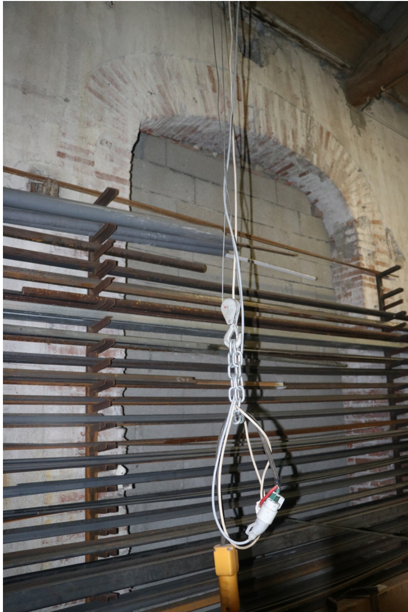
Site industriel de Gibraltar - Ouverture obturée à arc surbaissé en cayrous, bâtiment industriel de l'usine Chefdebien.
