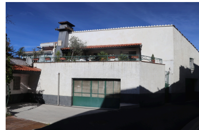
Moulin à farine, puis moulin à huile, puis moulin à farine Bonérich - Façade Sud-Ouest. Phot. Léonie Deshayes IVR76_20216665063NUCA
