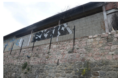
Site industriel de Gibraltar - Bâtiment industriel développé le long de l'Impasse Gibraltar. Phot. Léonie Deshayes IVR76_20216665153NUCA
