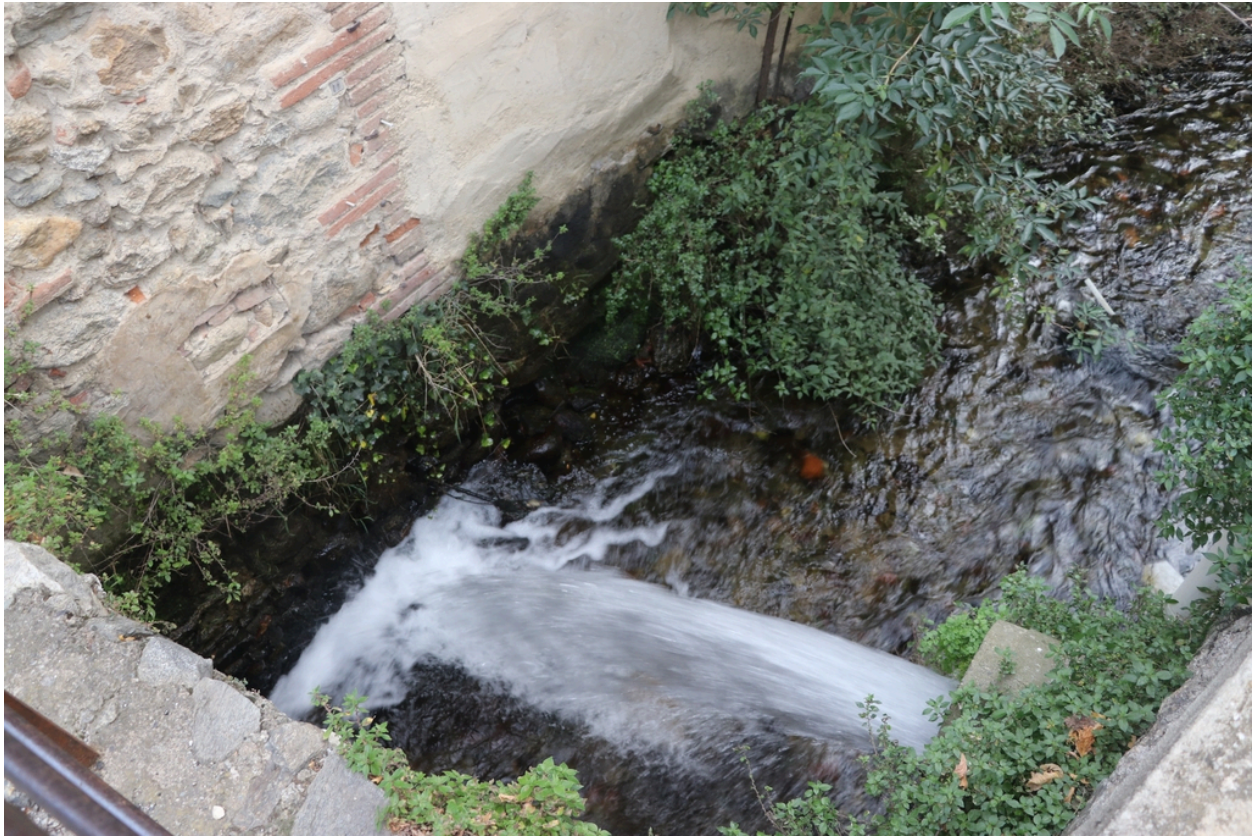
Canalisation du cours d'eau Eus Marquixanes entre l'ancienne usine Illes et la tannerie Guitard.
