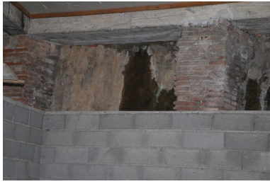
Moulin à huile de Jean Boher, puis martinet, puis usine, puis forge - Piliers massifs conservés en soubassement. Phot. Léonie Deshayes IVR76_20216665073NUCA
