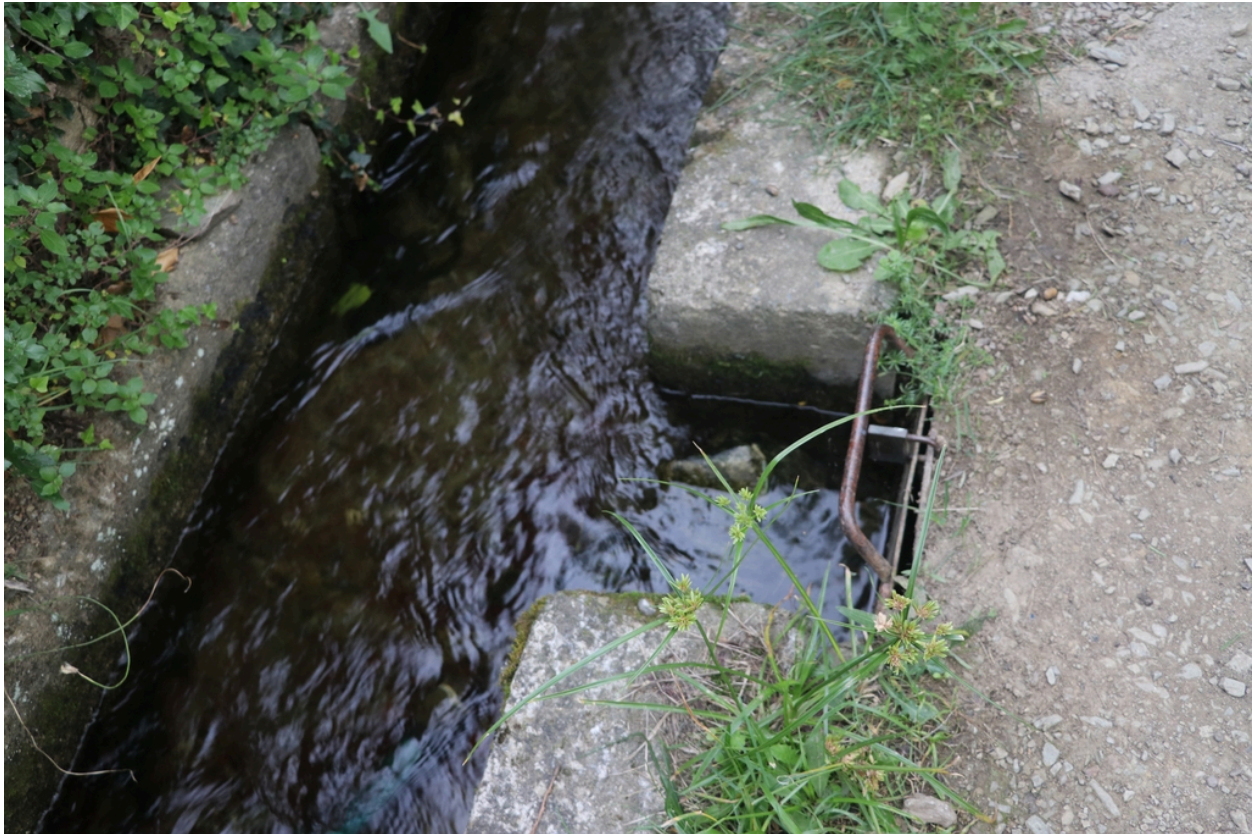
Canal de Canoha - Embegue avec vanne en fer.
