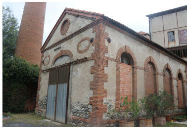
Site industriel de Gibraltar - Vue Nord-Ouest du bâtiment à chaudière et turbines. Phot. Léonie Deshayes IVR76_20216665137NUCA
