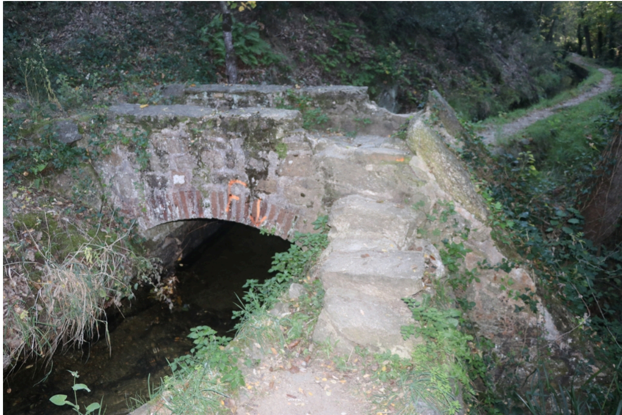
Canal de Bohère - Ponceau 4 (b).
