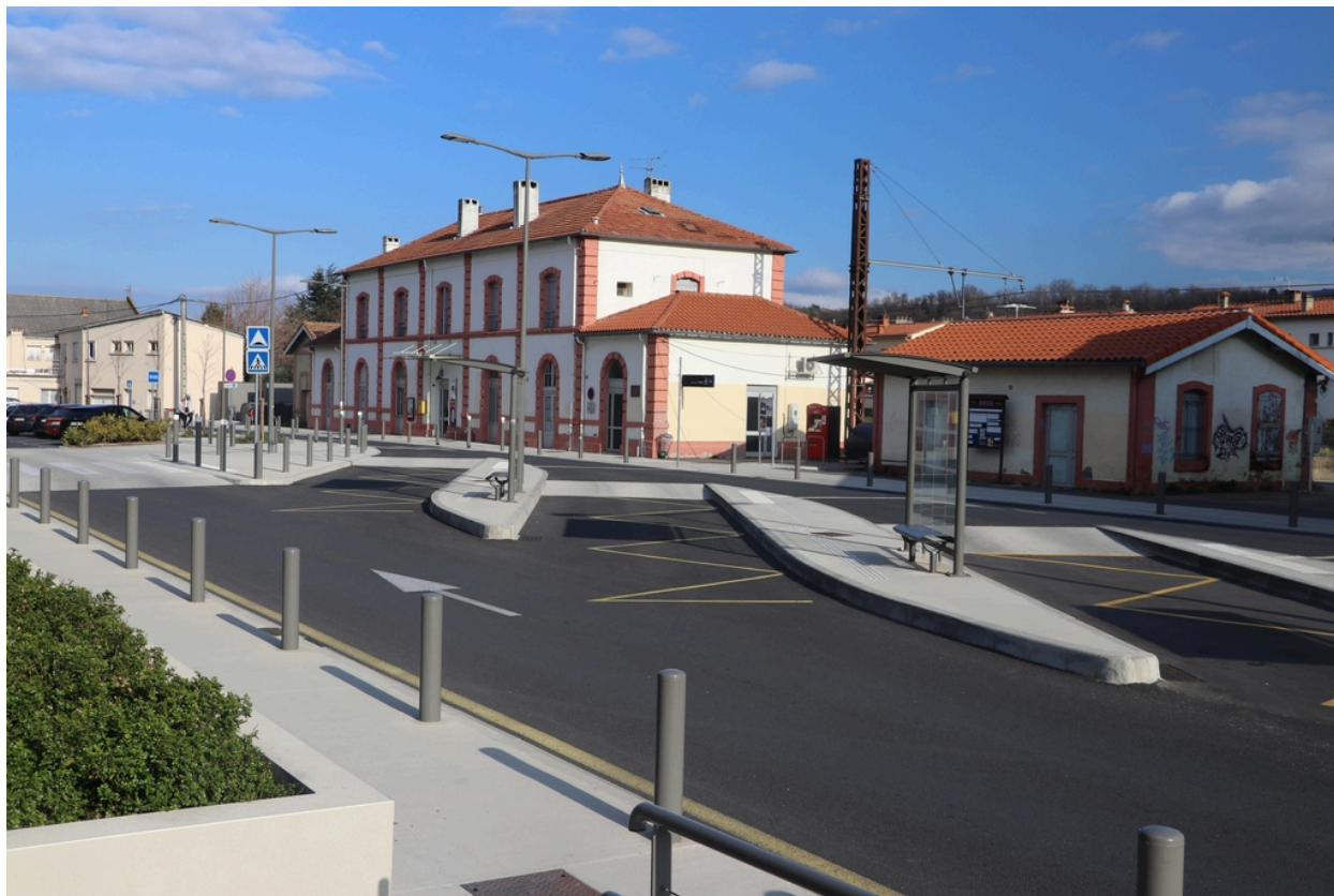
Vue d'ensemble de la gare depuis l'espace multimodal.
