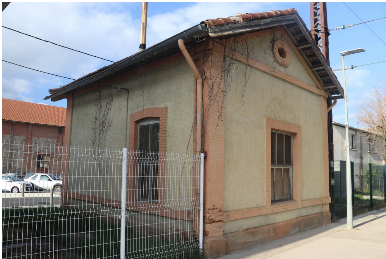
Vue Sud-Ouest du bâtiment annexe développé à l'Est.
