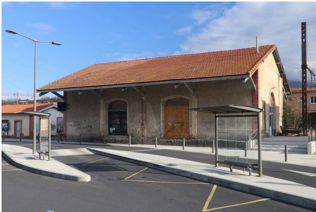
Vue d'ensemble de la halle à marchandise.
