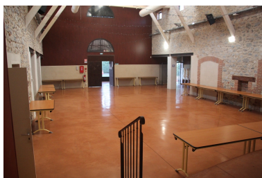
Abattoir puis Salle du Foirail - Intérieur depuis l'avant-scène. Phot. Léonie Deshayes IVR76_20226665430NUCA
