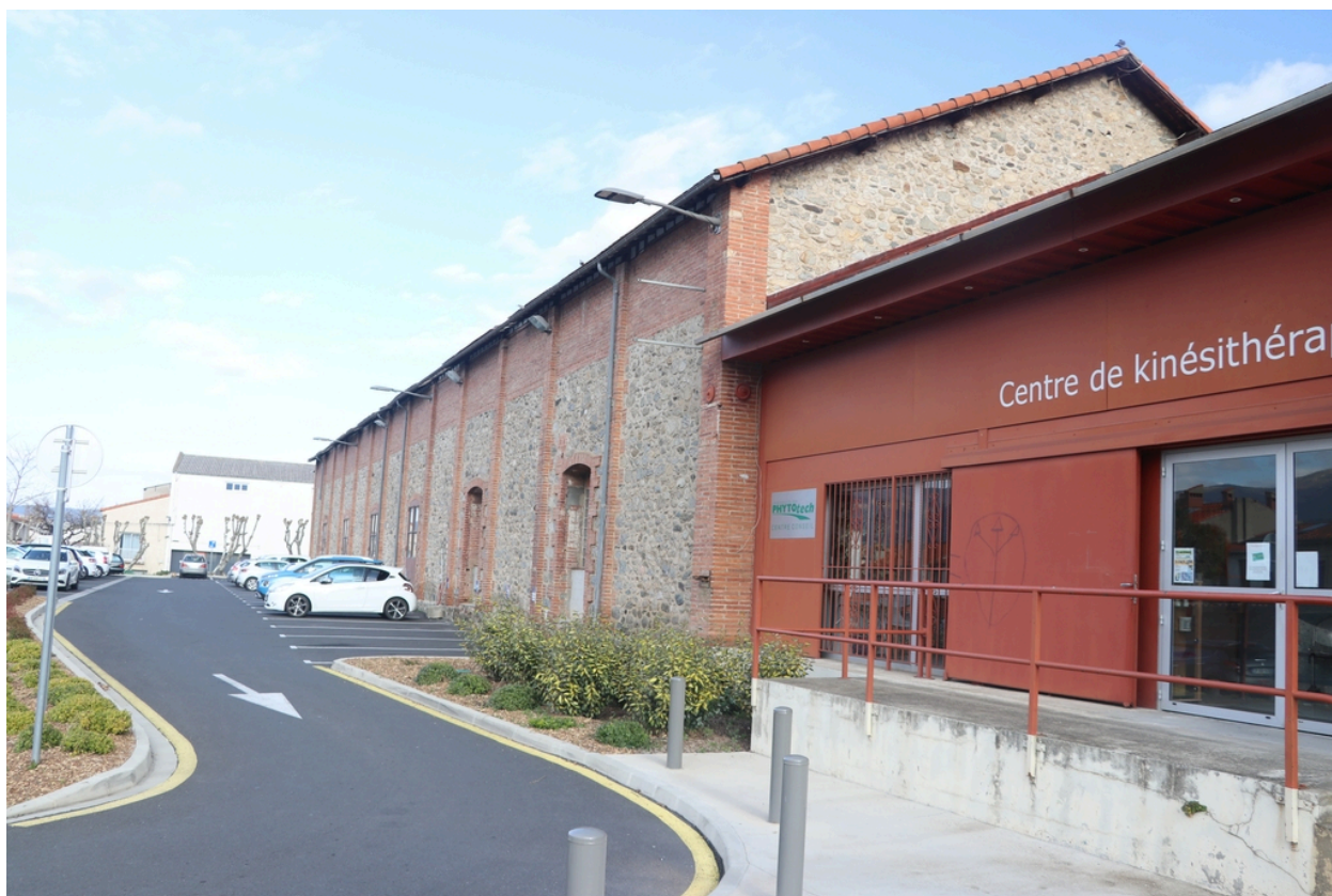
Façade Nord-Est des bâtiments de l'entreprise Chefdebien.
