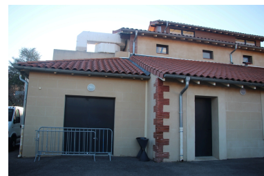
Abattoir puis Salle du Foirail - Face Nord-Est avec extension. Phot. Léonie Deshayes IVR76_20226665425NUCA
