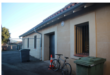
Abattoir puis Salle du Foirail - Façade Nord. Phot. Léonie Deshayes IVR76_20226665427NUCA
