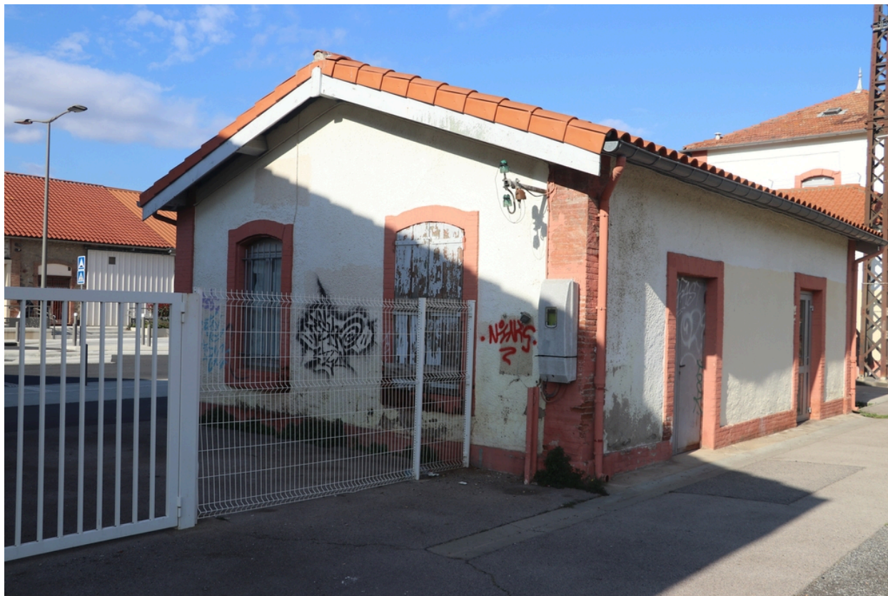
Bâtiment annexe à la gare développé à l'Ouest.
