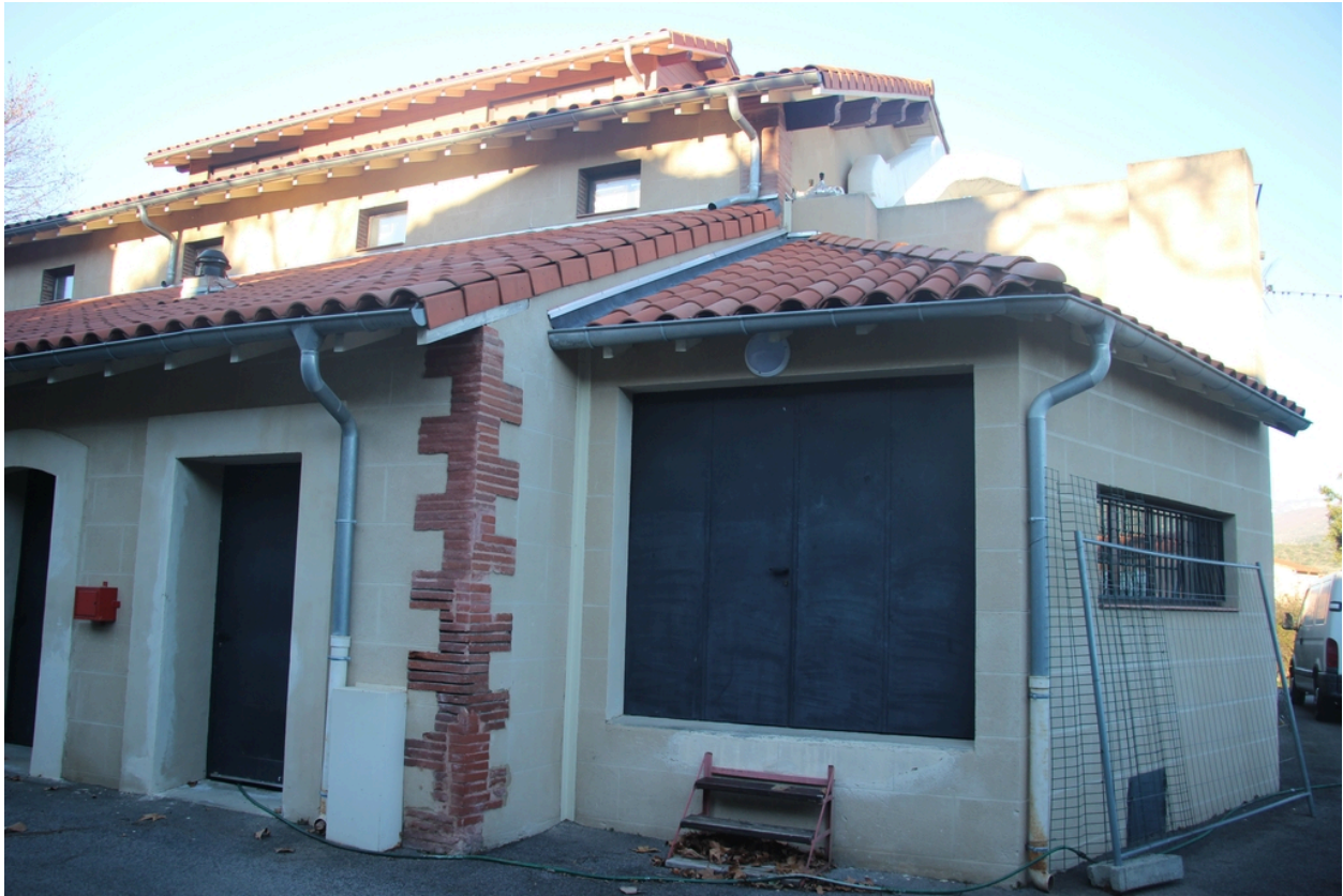
Abattoir puis Salle du Foirail - Face Sud-Est avec extension.
