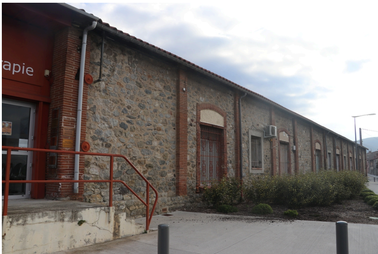
Façade Nord-Ouest des bâtiments de l'entreprise Chefdebien.
