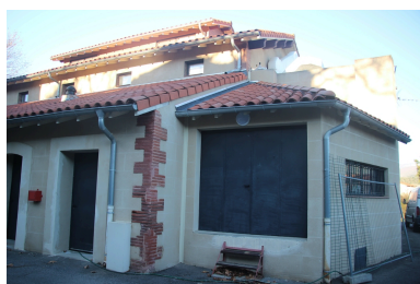
Abattoir puis Salle du Foirail - Face Sud-Est avec extension. Phot. Léonie Deshayes IVR76_20226665426NUCA
