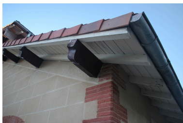
Abattoir puis Salle du Foirail - Détail du voligeage avec chevrons et pannes en bois, angle Sud. Phot. Léonie Deshayes IVR76_20226665424NUCA
