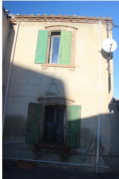
Abattoir puis Salle du Foirail - Travée de baies Sud-Est de l'habitation du concierge. Phot. Léonie Deshayes IVR76_20226665436NUCA
