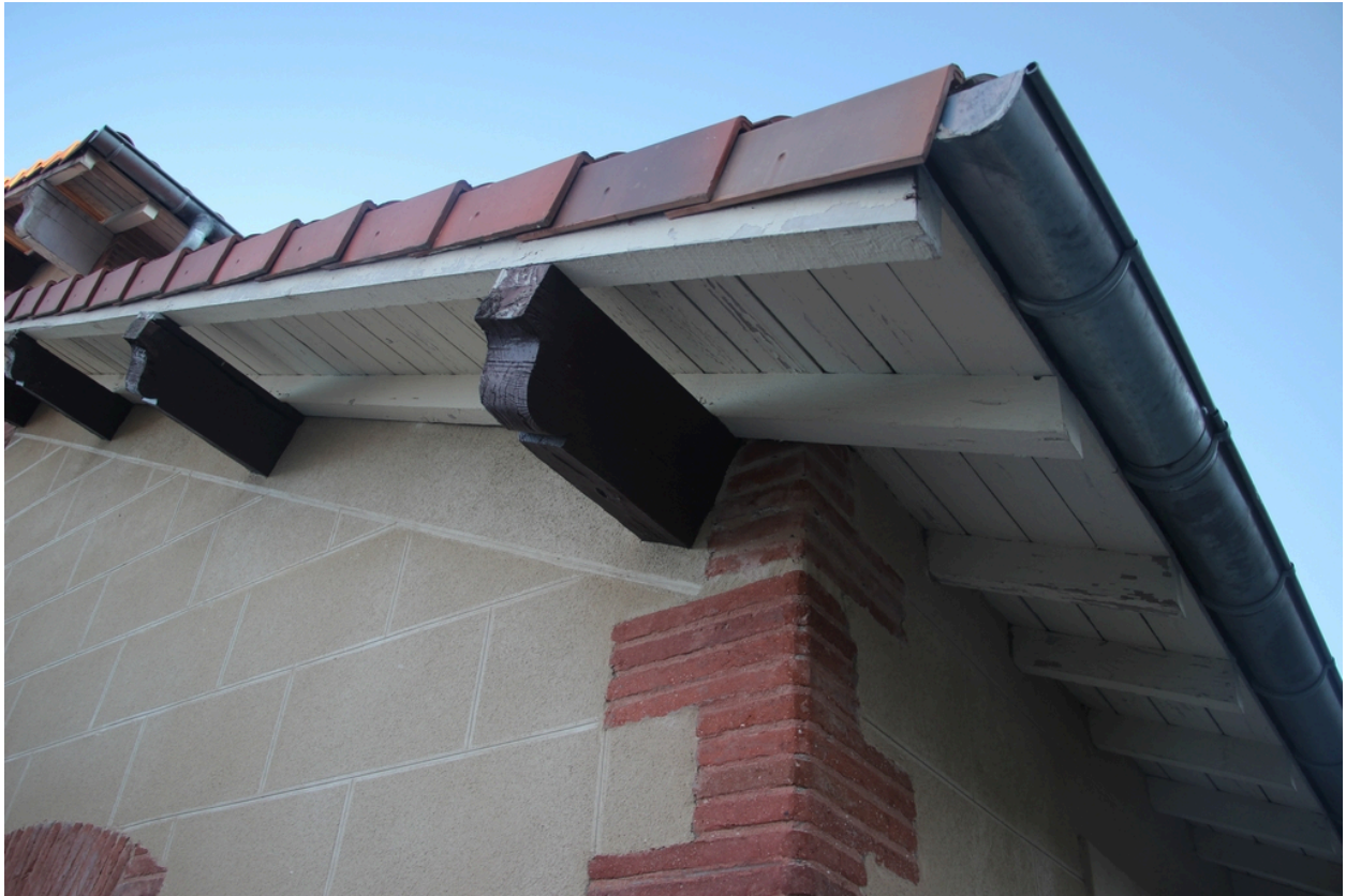
Abattoir puis Salle du Foirail - Détail du voligeage avec chevrons et pannes en bois, angle Sud.
