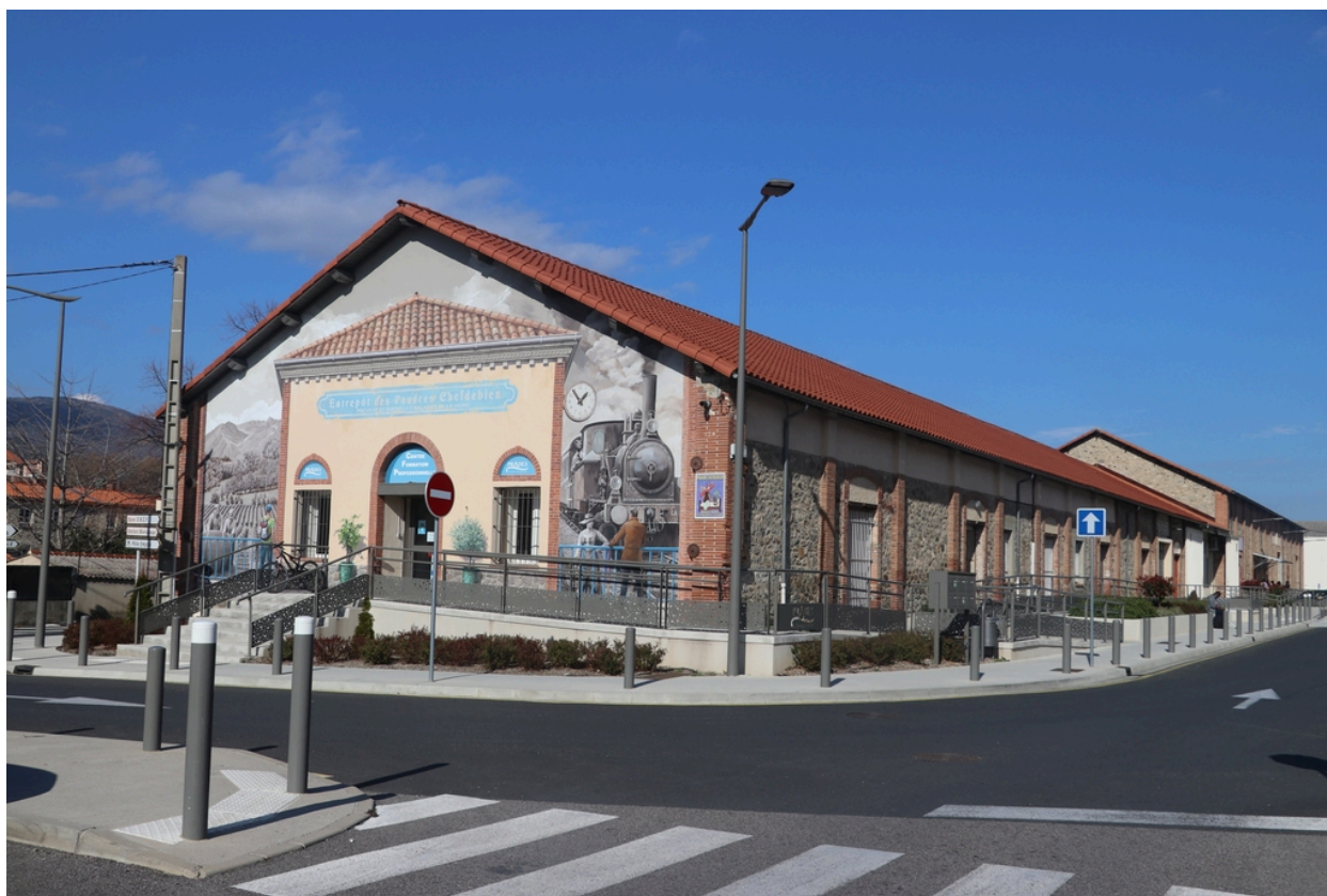
Vue d'ensemble des bâtiments de l'entreprise Chefdebien.
