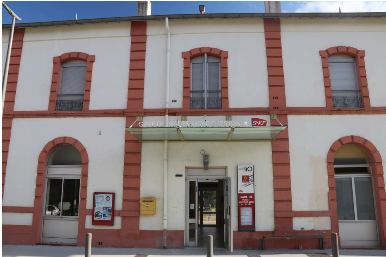
Entrée principale du bâtiment des voyageurs en façade Nord.
