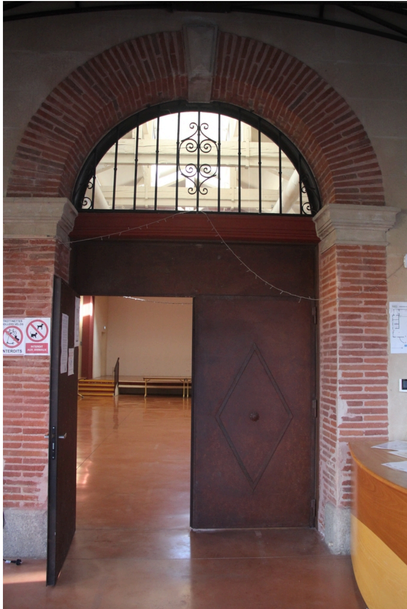
Abattoir puis Salle du Foirail - Portail d'entrée principal.
