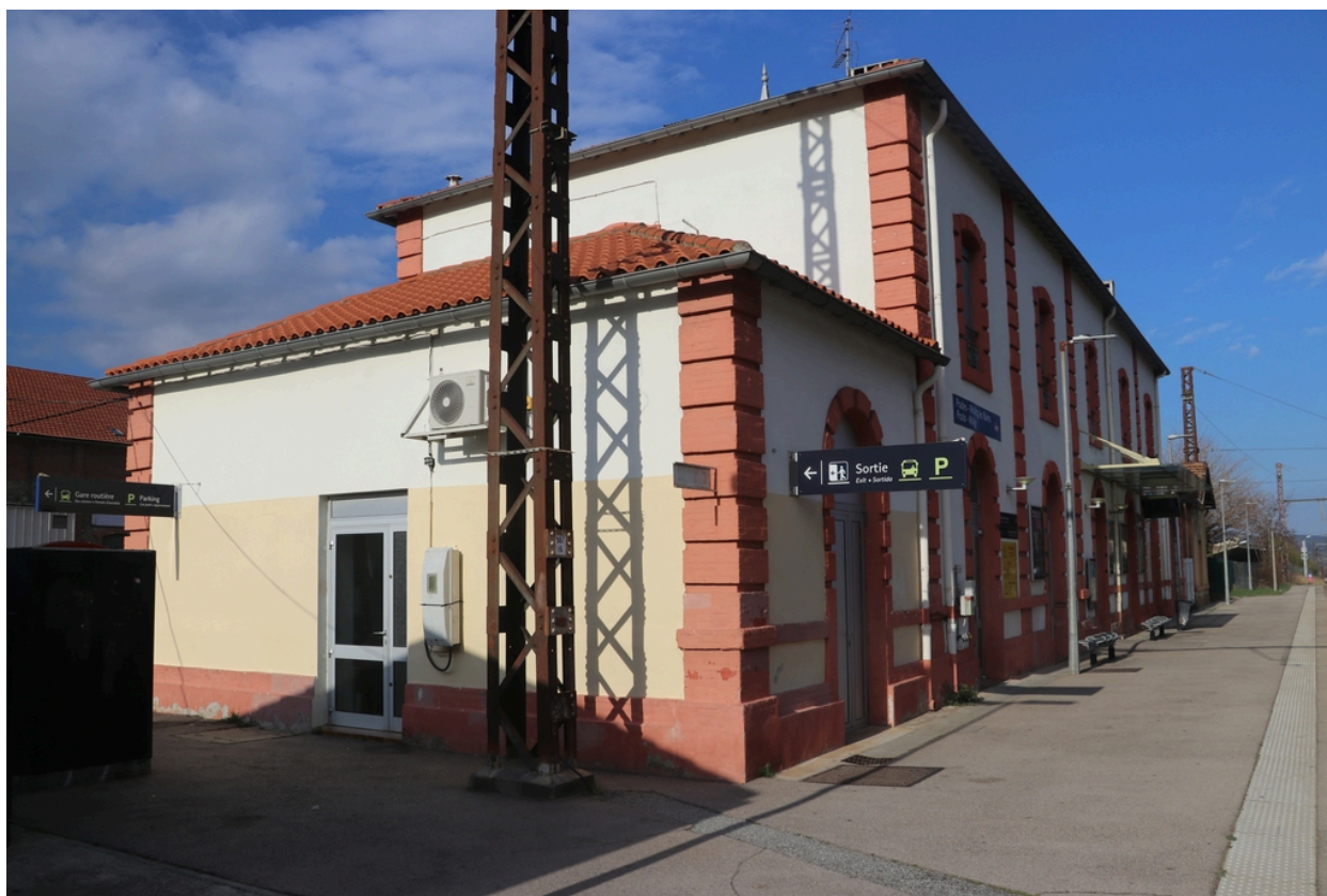
Vue d'ensemble du bâtiment des voyageurs depuis les quais au Sud-Ouest.
