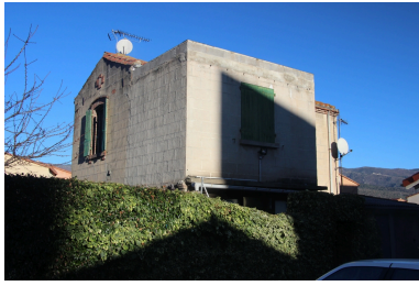
Abattoir puis Salle du Foirail - Vue Sud-Ouest de l'habitation du concierge. Phot. Léonie Deshayes IVR76_20226665435NUCA
