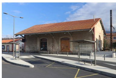
Vue d'ensemble de la halle à marchandise. Phot. Léonie Deshayes IVR76_20226665705NUCA
