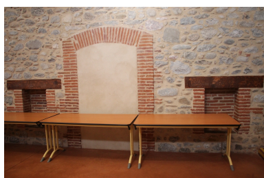
Abattoir puis Salle du Foirail - Niches en soubassement intérieur Nord. Phot. Léonie Deshayes IVR76_20226665432NUCA
