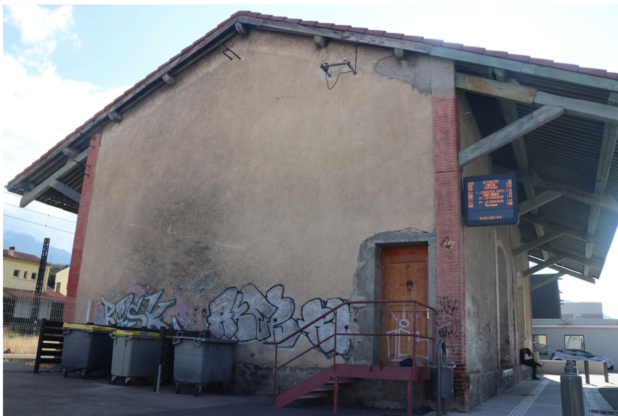
Face Est de la halle à marchandise.
