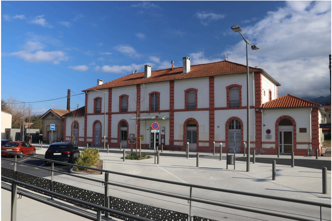
Vue Nord de la gare.
