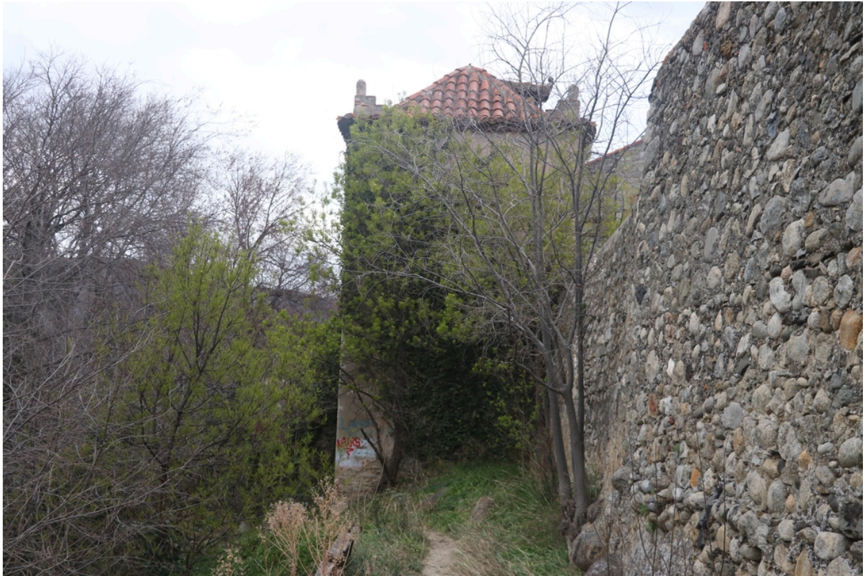
Pigeonnier (AL 1) dans la continuité du second rang de fortifications Nord.
