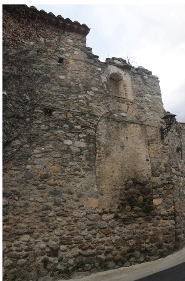
Encadrement de baie et niche- oratoire (porte fortifiée du Quintar ?) conservés au niveau de la rue des Fabriques. Phot. Léonie Deshayes IVR76_20226665668NUCA
