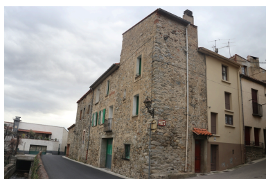
Habitation d'angle (ancienne tour du second rang de fortifications Nord ?) comprise entre la rue des Fabriques et la Rampe du Costa del Quintar. Phot. Léonie Deshayes IVR76_20226665667NUCA
