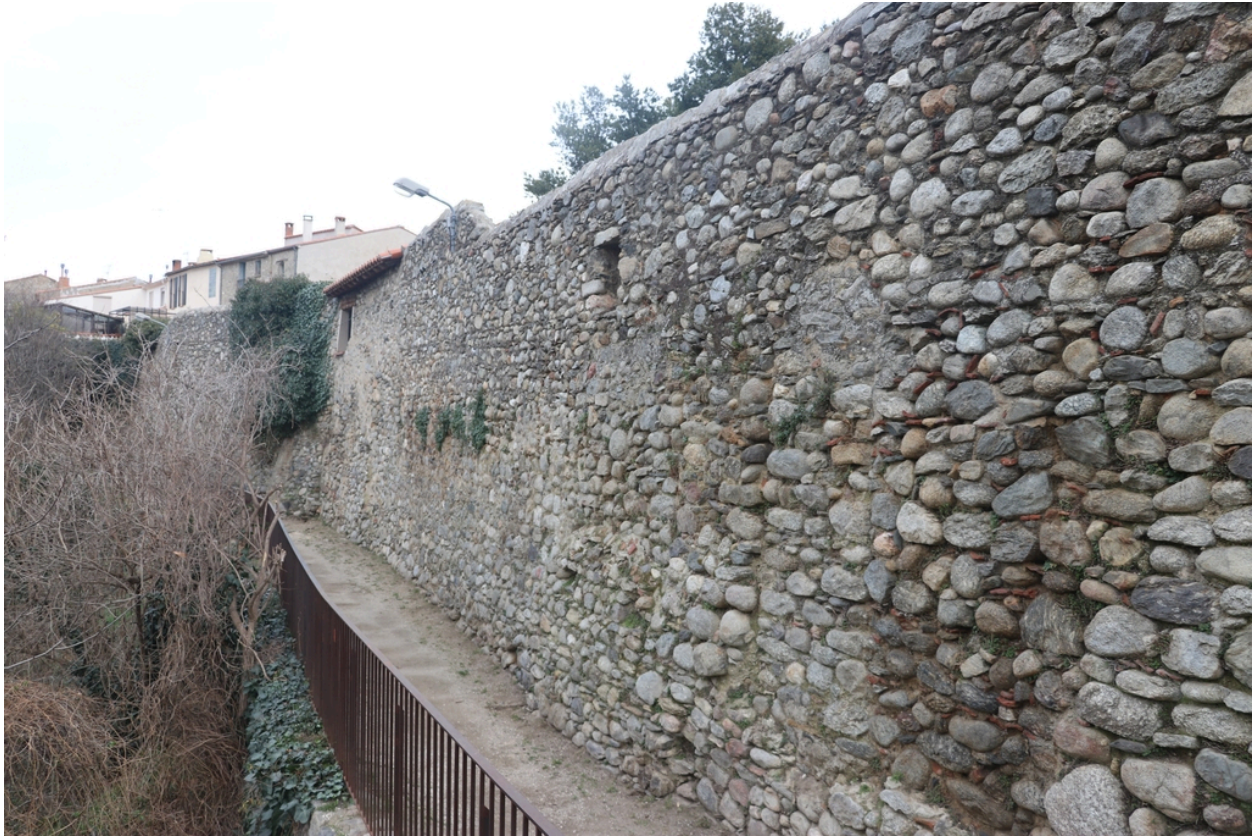
Détail de la maçonnerie du second rang de fortifications Nord.
