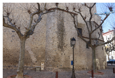
Vestige d'une tour arasée de la cellera à l'angle Nord-Est de l'église paroissiale Saint-Pierre. Phot. Léonie Deshayes IVR76_20226665663NUCA
