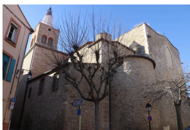
Vestige d'une tour de la cellera, angle Sud-Est de l'église paroissiale Saint-Pierre. Phot. Léonie Deshayes IVR76_20226665662NUCA
