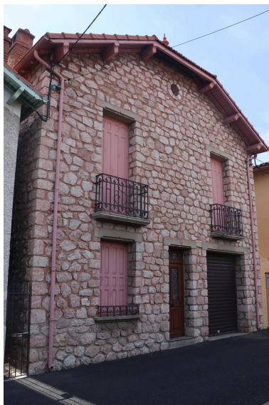
Modèle d'habitation développée au Sud et Sud-Ouest de la ville, n°3 rue Angélique Marie. Phot. Léonie Deshayes IVR76_20226665680NUCA
