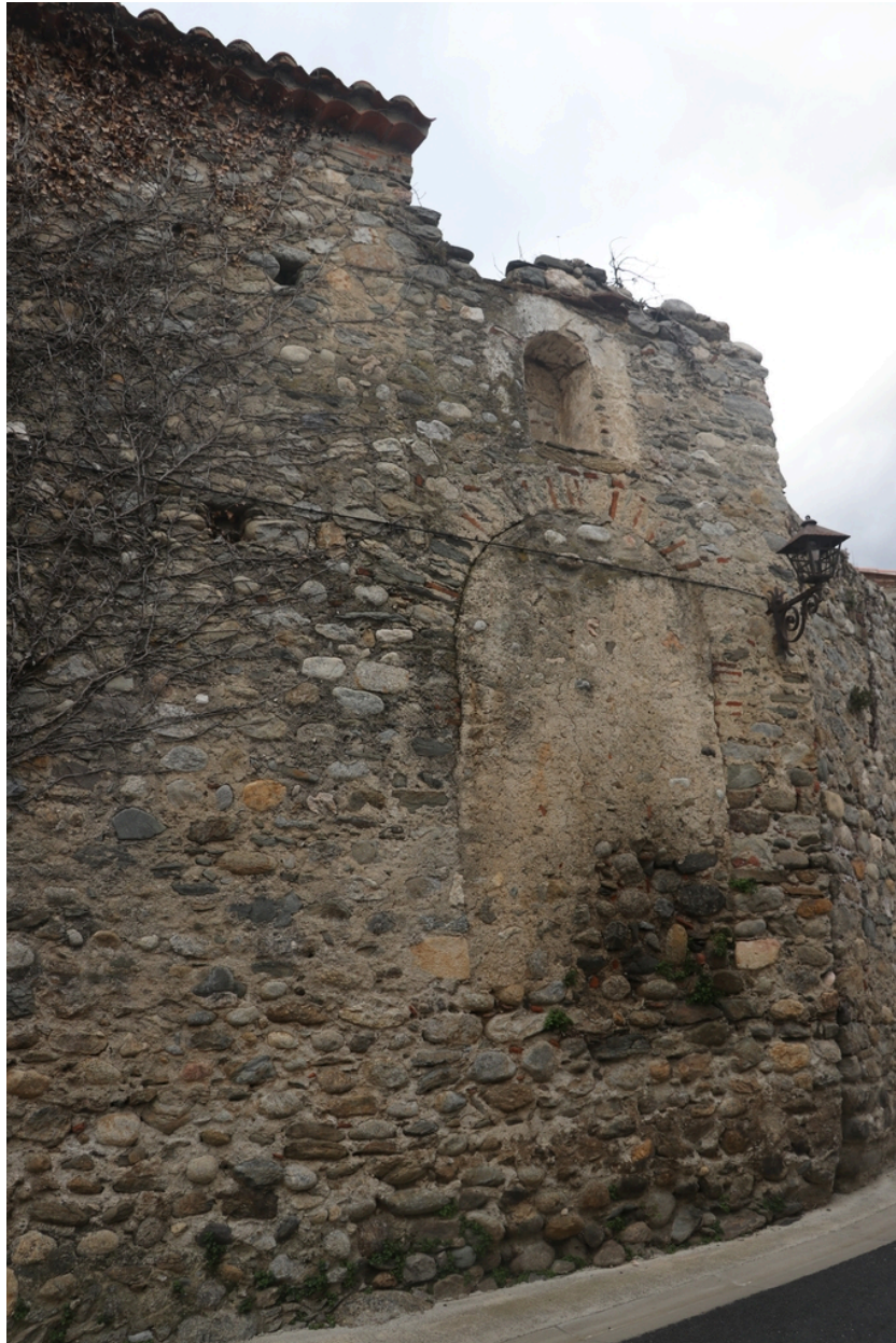
Encadrement de baie et niche-oratoire (porte fortifiée du Quintar ?) conservés au niveau de la rue des Fabriques.
