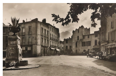
Carte postale représentant en arrière-plan le siège de la viguerie de Prades avant sa démolition, Août 1960. Autr. Léonie Deshayes IVR76_20226665648NUCA
